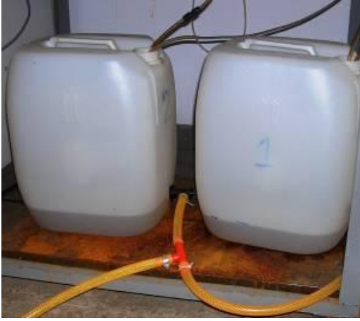
Şekil 3.19 : Çıkış suyu toplama ve geri yıkama suyu besleme tankları.
