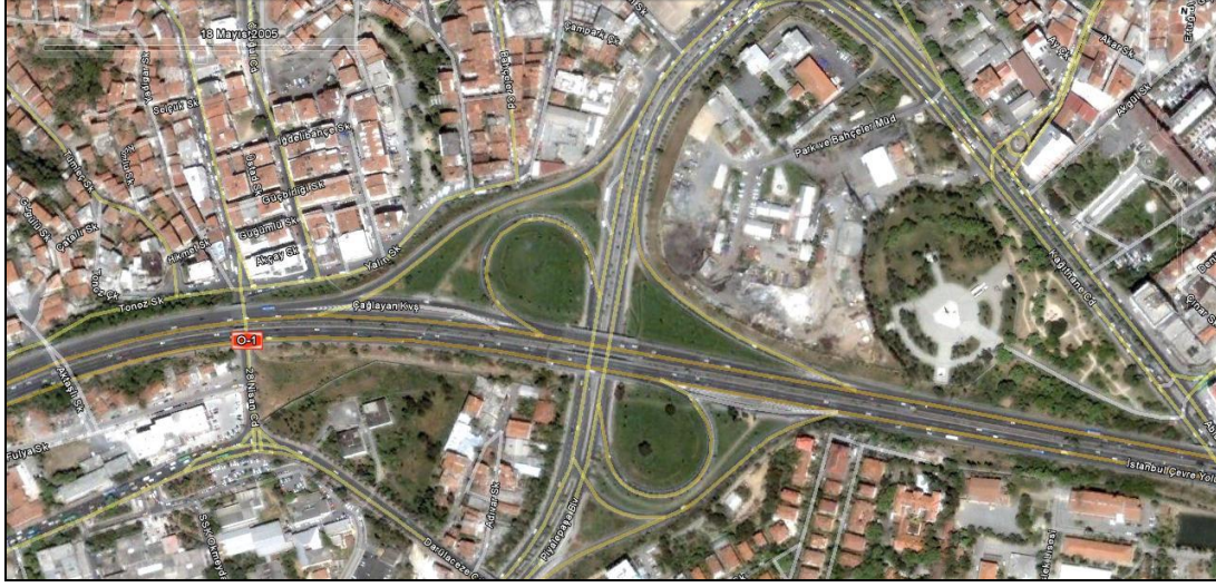
Şekil 5.24 : Çağlayan Kavşağı hava fotoğrafı, (Url 11), 2009 yılı.
