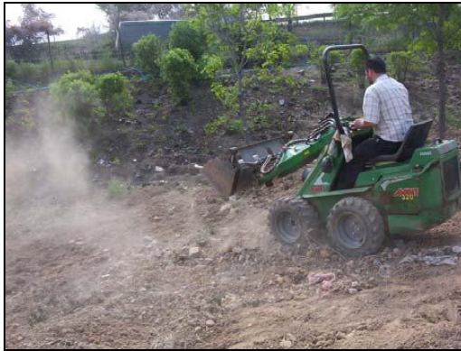
Şekil 4.1 : Yol kenarında arazi tesviyesi yapılırken (Url 6).
