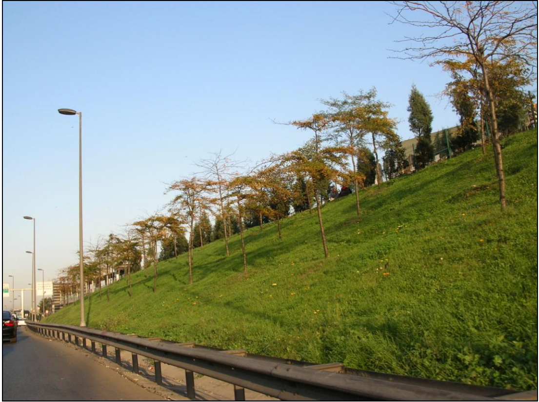
Şekil 2.9 : Okmeydanı Kavşağı'na gelmeden O-1 Çevre yolu üzerinde şevde kullanılan ince dokulu bitkiler yol işaretleri ve kavşağın görünmesine yardımcı etki sağlamıştır (Fotoğraf, kişisel çekim, 2009).
