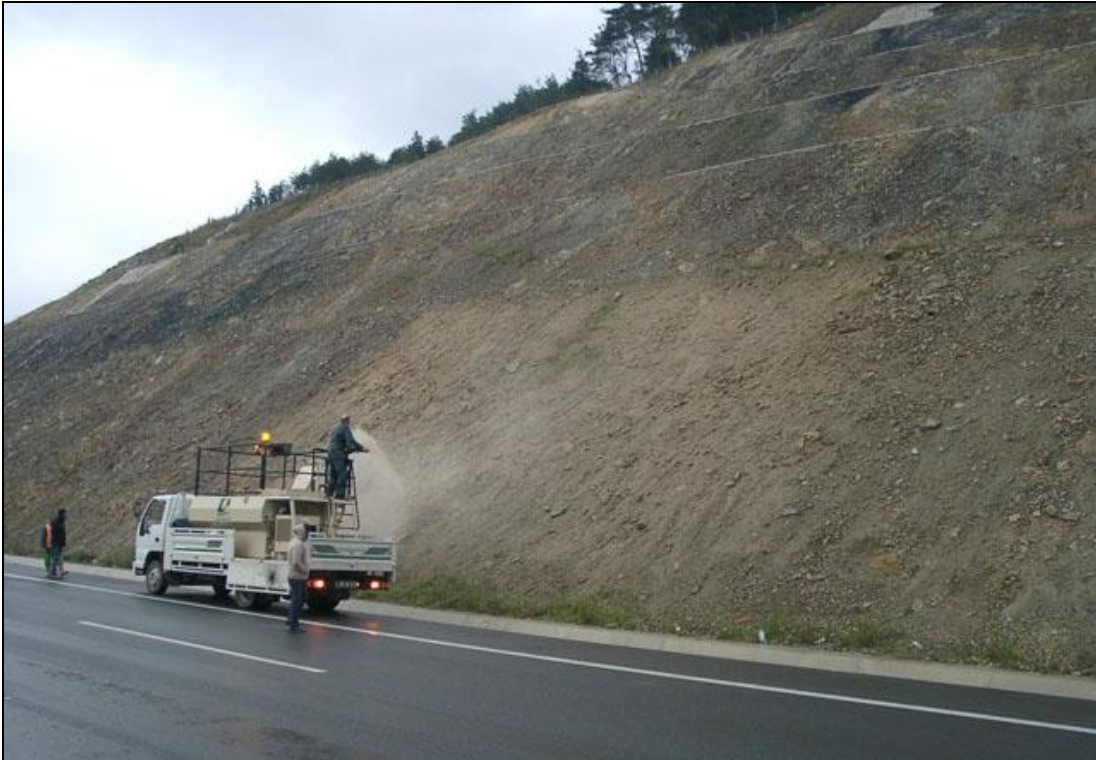
Şekil 3.41 : Şevli yol kenarında hydroseeding yöntemi ile çim uygulaması (Url 20).
