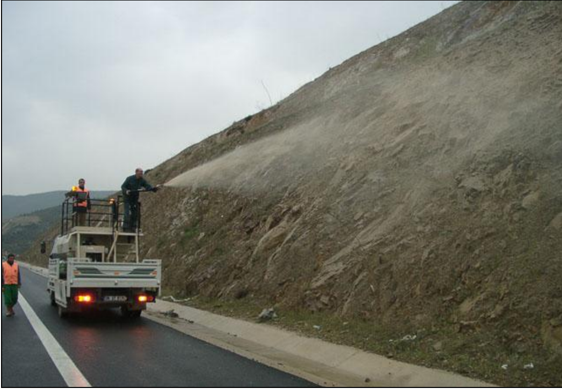
Şekil 3.40 : Şevli yol kenarında hydroseeding yöntemi ile çim uygulaması (Url 20).
