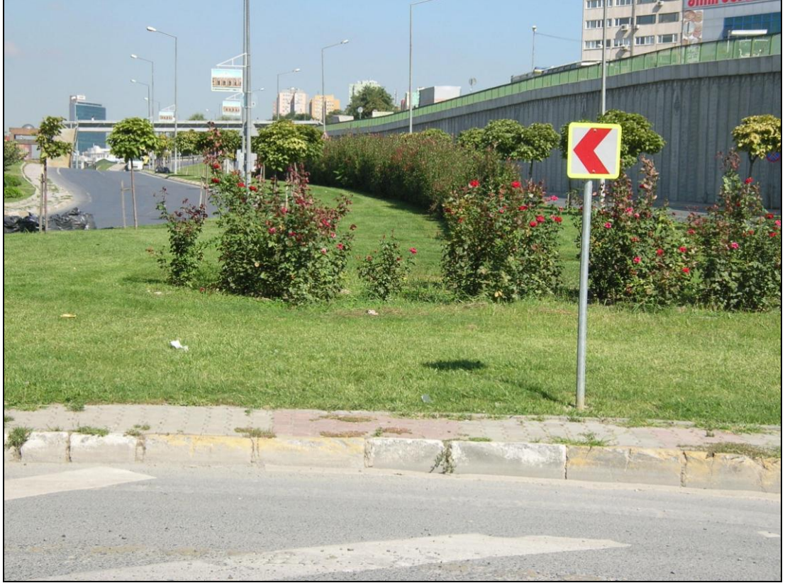
Şekil 5.8 : Orta refüjde kullanılan Photinia serrulata red robin ’lerle karşı yönden gelen far ışıklarının olumsuz etkisi azaltılarak optik yönlendirme sağlanmıştır (Fotoğraf, kişisel çekim, 2009).
