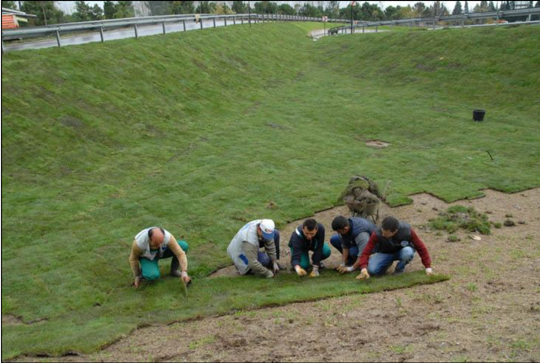
Şekil 3.39 : Karayolunda kilometrelerce genişlikteki alanlarda hazır çim kaplama çalışmaları (Url 22).
