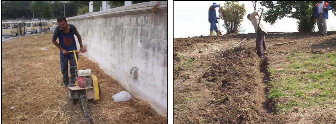
Şekil 4.2 : Sulama tesisatı döşenirken (Url 6).
