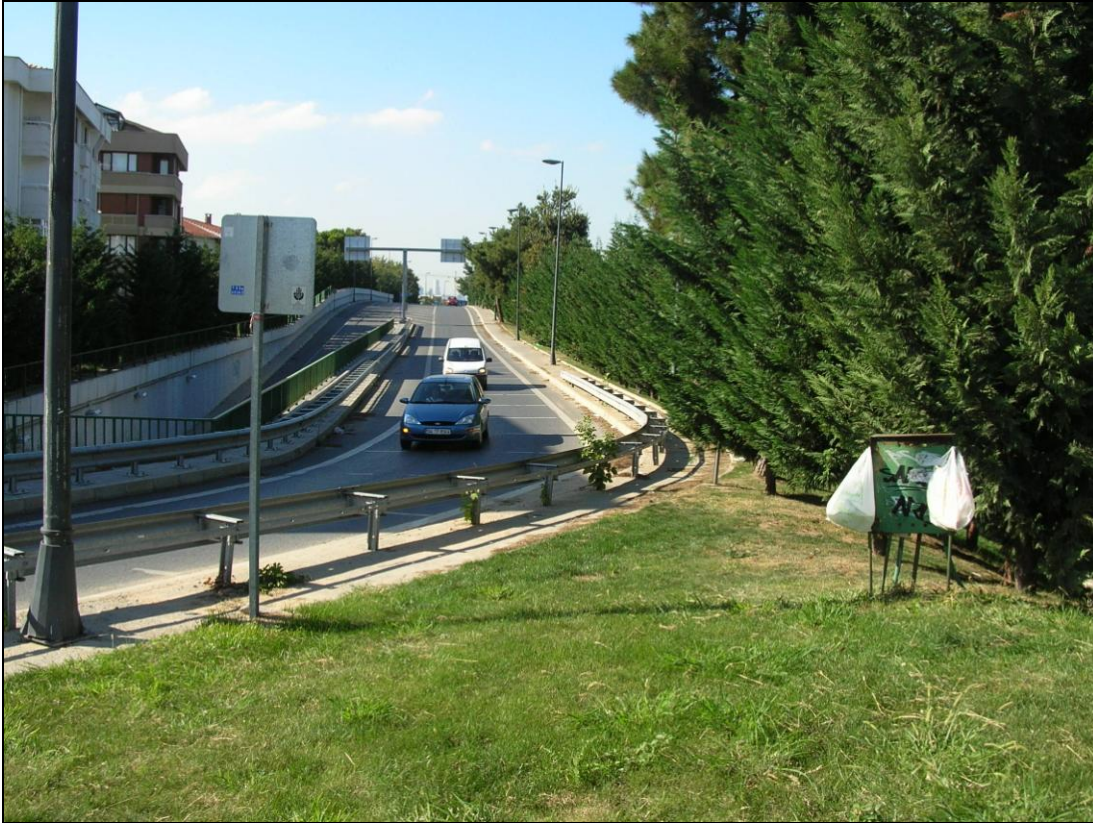
Şekil 2.8 : Acıbadem kavşağında kaba dokulu bitkilerin kullanımı ile karşı yönden gelen trafiğin far ışıklarının olumsuz etkisi azaltılmıştır (Fotoğraf, kişisel çekim, 2009).
