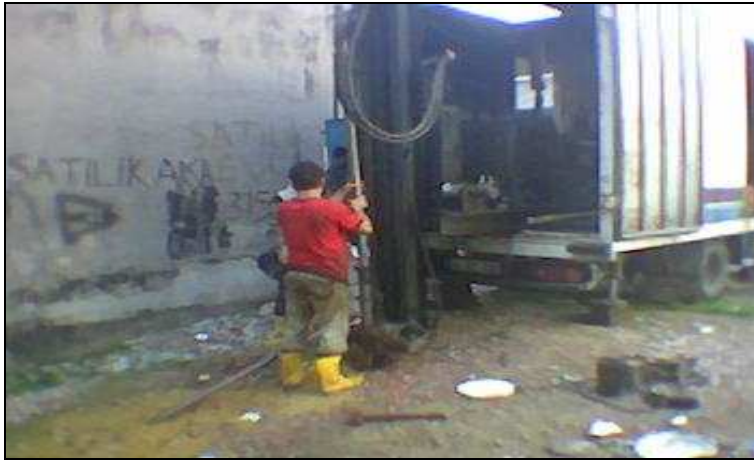
Şekil 7.13 : Parsel sondaj çalışması.
