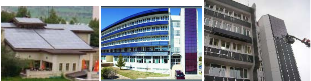
Şekil 2.2 : Muğla Üniversitesi’nde gerçekleştirilen fotovoltaik entegre edilmiş çatı ve cephe uygulamaları [18].
