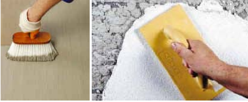
Şekil 3.80 : Çimento esaslı sürülerek uygulanan su yalıtımları.
