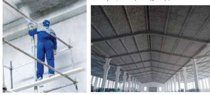
Şekil 3.72 : Selülozik ısı yalıtımı malzemesinin püskürtülerek uygulanması [95].
