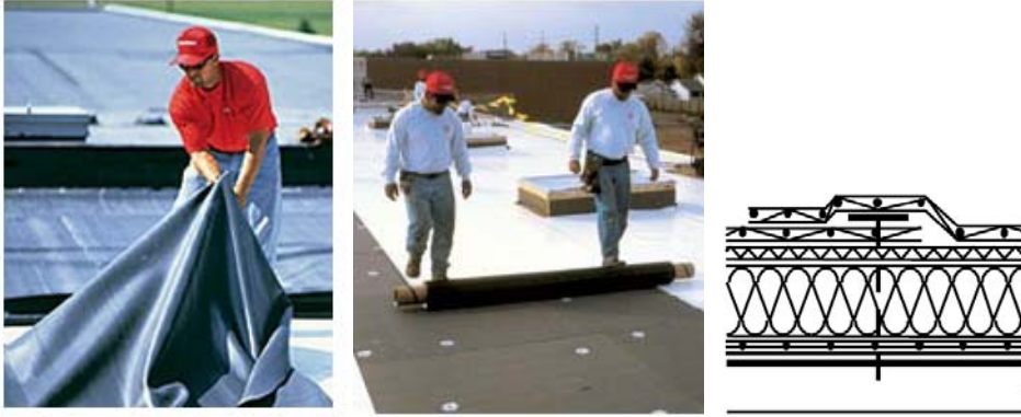
Şekil 3.78 : Polimer esaslı su yalıtımı örtüleri / mekanik tespit [102].
