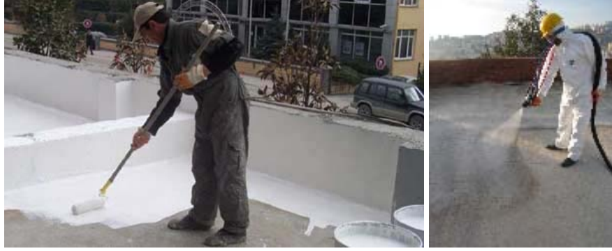
Şekil 3.79 : Sürülerek ve püskürtülerek uygulanan poliüretan su yalıtımı.
