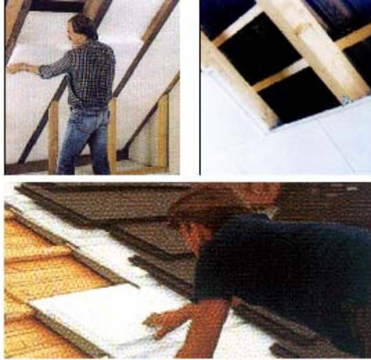
Şekil 3.75 : Eğimli çatıda mertek hizasında ısı yalıtımında polistren levha uygulamaları: mertekler arasına, altına veya üzerine [85].
