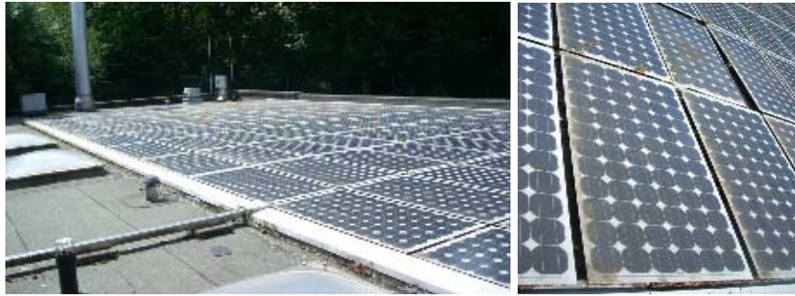
Şekil 2.10 : Den Haag'da teras çatı üzerine fotovoltaik panellerin yatay yerleştirildiği bir uygulama.
