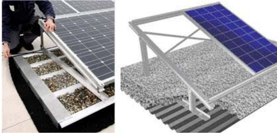
(a) (b) Şekil 4.6 : Ağırlıkla sabitleme seçenekleri: çakıl veya toprak [108, 109].
