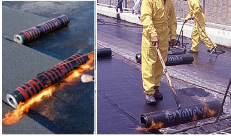
Şekil 3.77 : Bitümlü örtülerin şalümo alevi ile çatıya tespiti.
