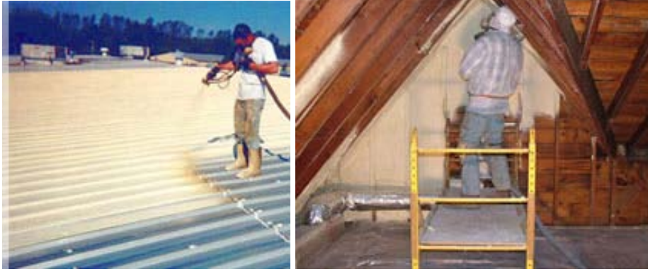
Şekil 3.76 : Poliüretan ısı yalıtımın uygulanması [92].
