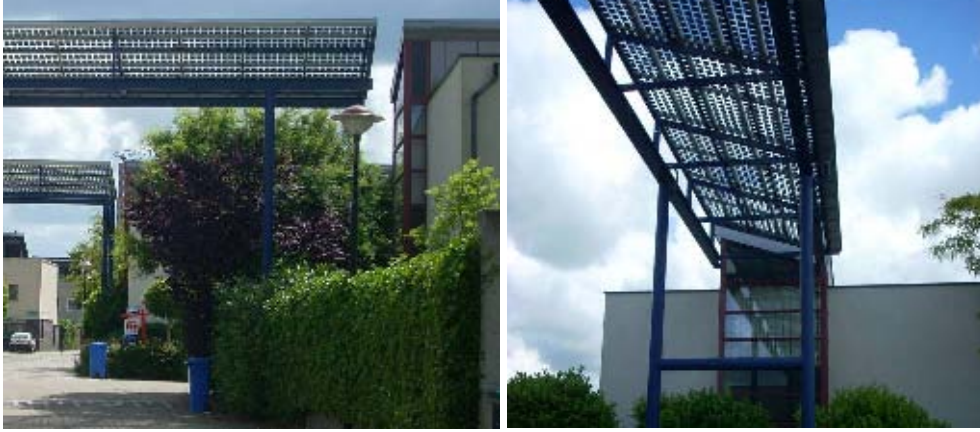
Şekil 2.11 : Nieuwland yerleşkesinde saçaklarda yarı geçirgen fotovoltaiik bileşenlerin kullanımı.
