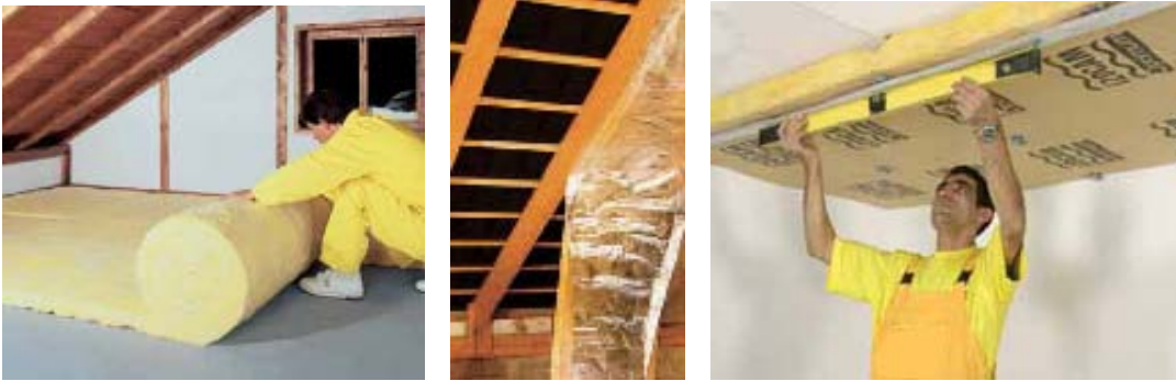
Şekil 3.69 : Cam yünü ısı yalıtımın çatıda uygulamaları [81].
