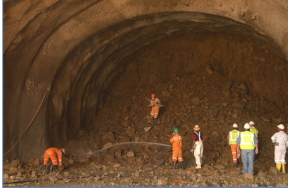
Şekil 2.3: Del – Patlat uygulamasında patlama sonrası tünel görünümü (URL – 2)
