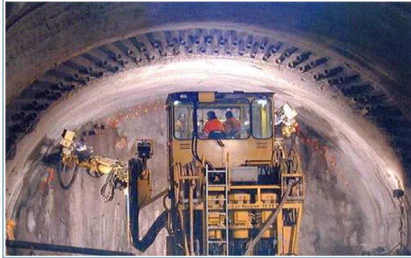
Şekil 2.4: NATM tüneline kazı çalışmaları (URL – 3)
