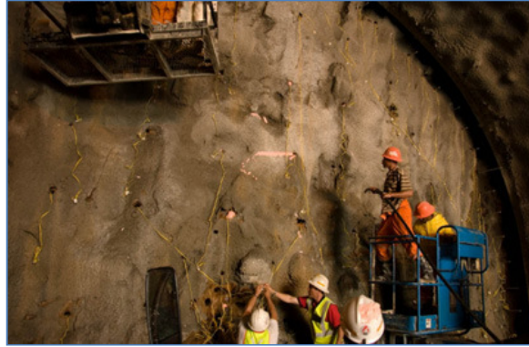
Şekil 2.2: Del – Patlat uygulamasında patlayıcıların yerleştirilmesi (URL – 2)
