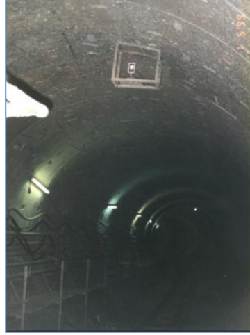
Şekil 2.10: Reflektör kurulu yönlendirme konsolu (Ünlütepe A., Messing M., 2005)
