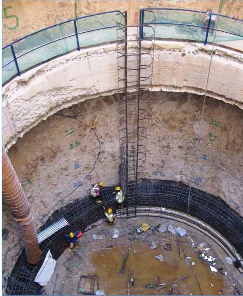
Şekil 3.3: Düşey şaft inşaatı (URL – 3)
