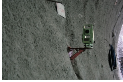
Şekil 5.1: Tünel içi yatay kontrol ağı nokta tesisi örneği (Ademoğlu Y., 2009)
