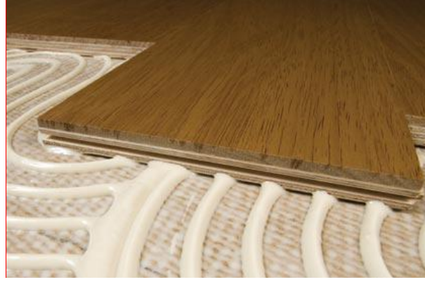
Şekil 2.20: Lamine Parke Uygulaması [39].
