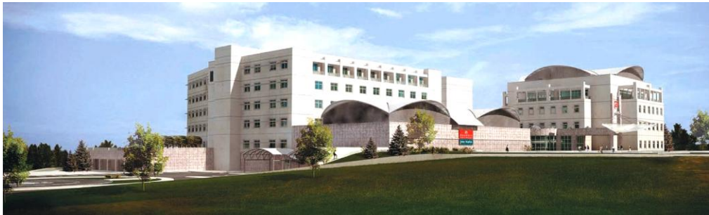
Şekil 4.8 : Anadolu Sağlık Merkezi (archrecord.construction.com).
