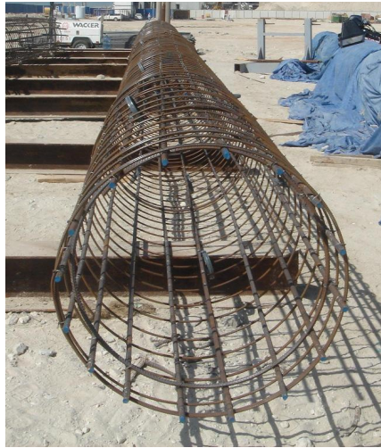
Şekil 3.5 : Hazırlanan donatı kafesi
