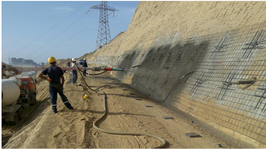
Şekil 3.17 : Çelik hasır ve püskürtme beton
