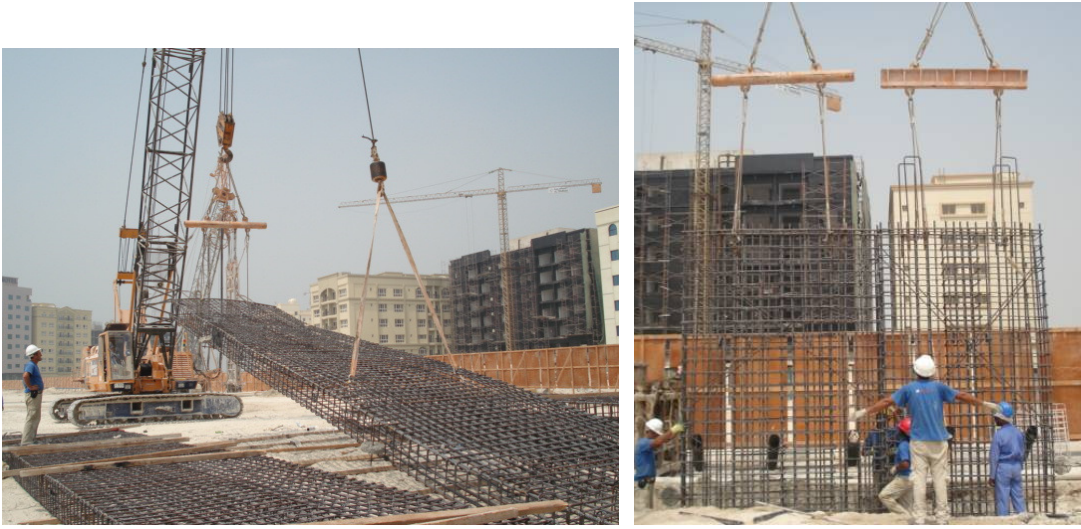
Şekil 3.13 : Donatı kafesi kaldırılması ve delgi kuyusuna indirilmesi
