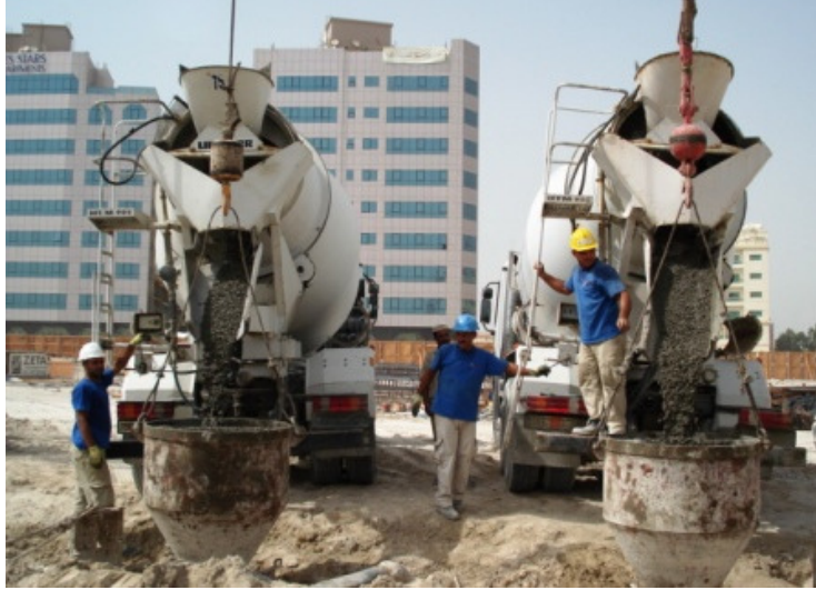
Şekil 3.6 : Betonlama işlemi
