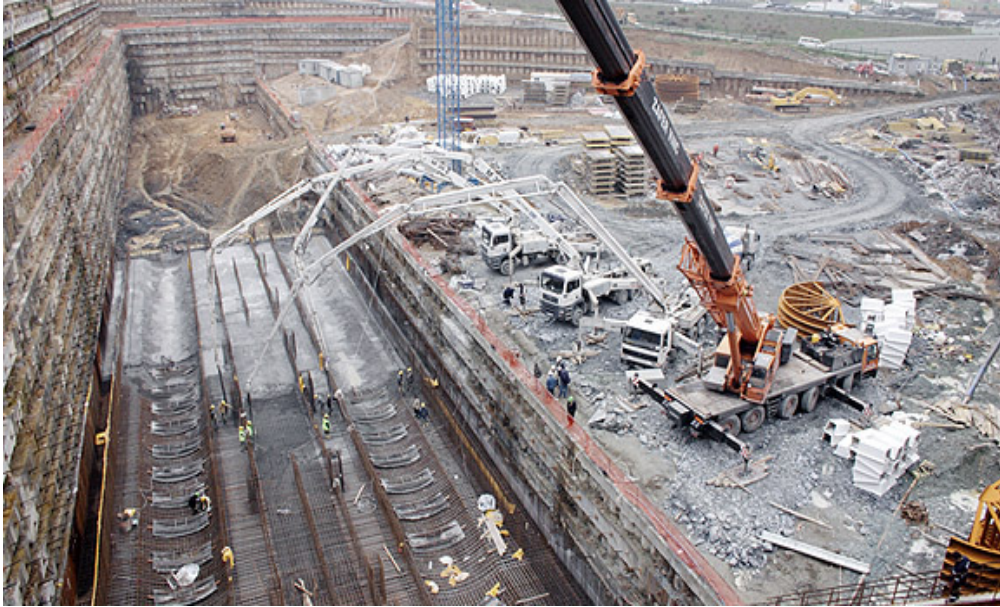
Şekil 5.3 : İstasyon inşaat çalışmalarından görünüm
