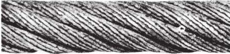
Şekil 5.3 : Korozyona uğramış halat [36].
