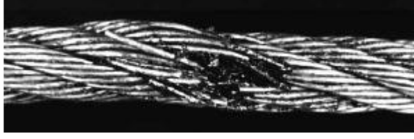
Şekil 5.16 : Dış etkiler nedeniyle halatta oluşan hasar [32].
