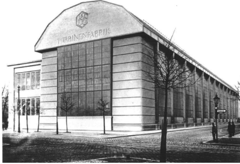
Şekil 3.3 : AEG Turbine Fabrikası, 1909, Mimarı: Peter Behrens (Schwartz, 1996:176)
