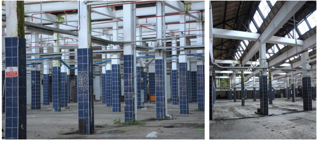
Şekil 5.20 : +0.00 Kotu - Rakı imla bölümü ve üzerini örten şed çatı. Fotoğraf: M. Gülcan Şahin, 2010.
