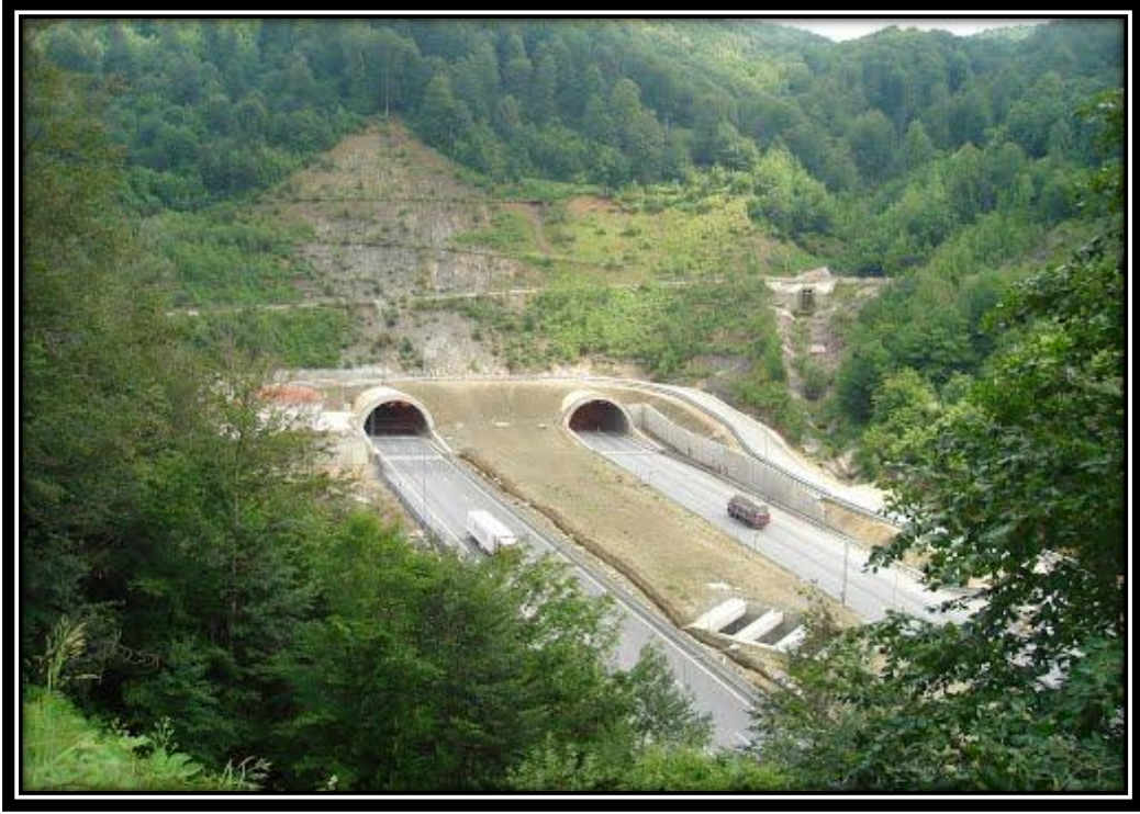
Fotoğraf 19. Bolu Dağı Tüneli'nden Bir Görünüm
