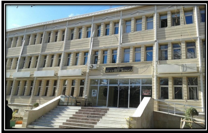
Fotoğraf 20: Pozantı Hükümet Konağı
