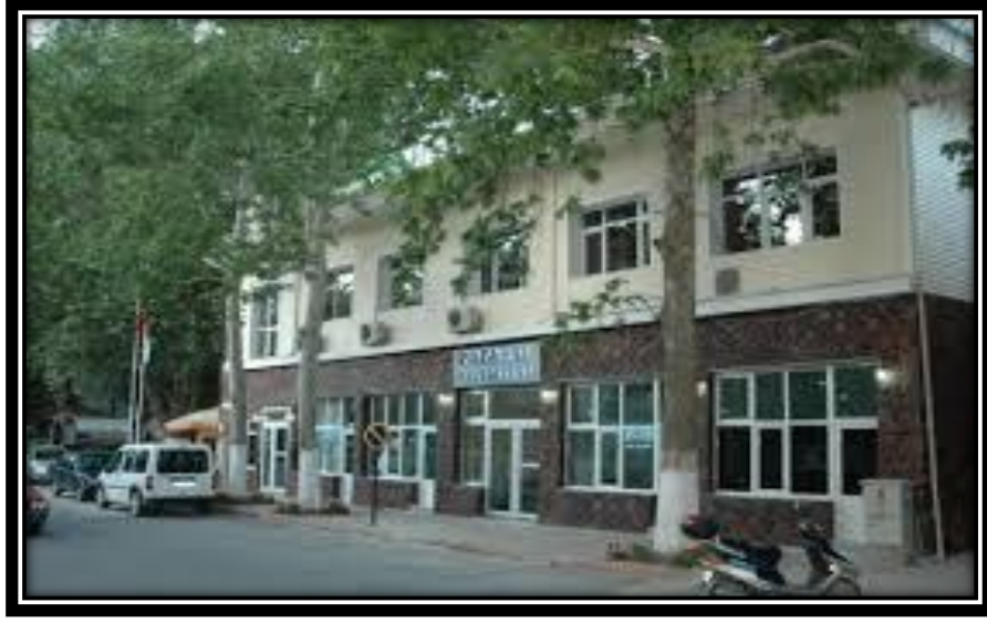
Fotoğraf 13: Pozantı Belediye Binası'nın Günümüzdeki Durumu
