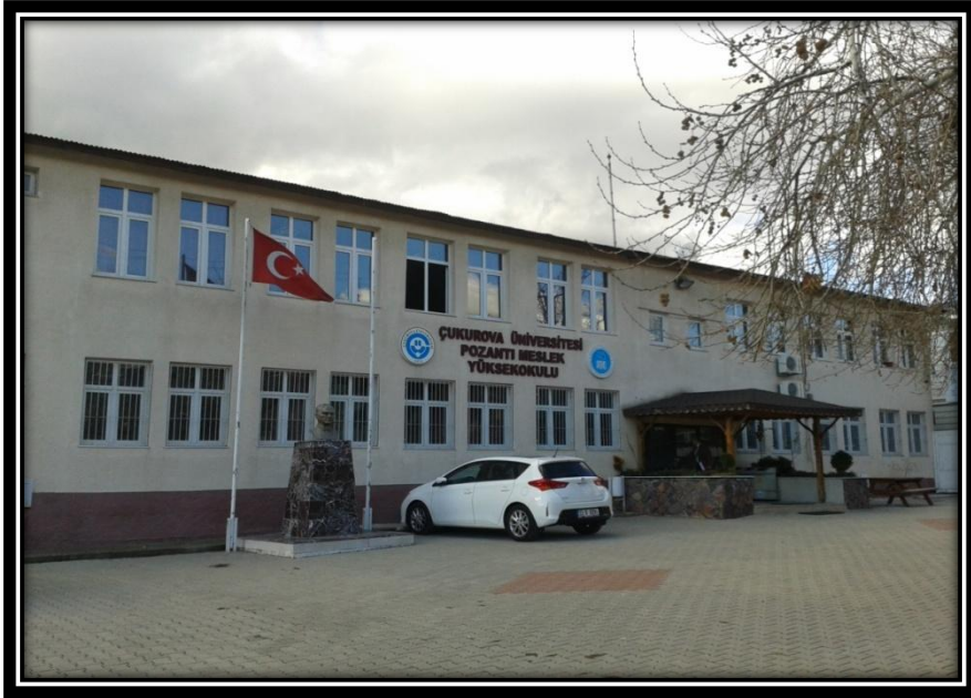
Fotoğraf 23: Pozantı Meslek Yüksek Okulu'nun İnönü Caddesi Üzerindeki Eğitim Binası
