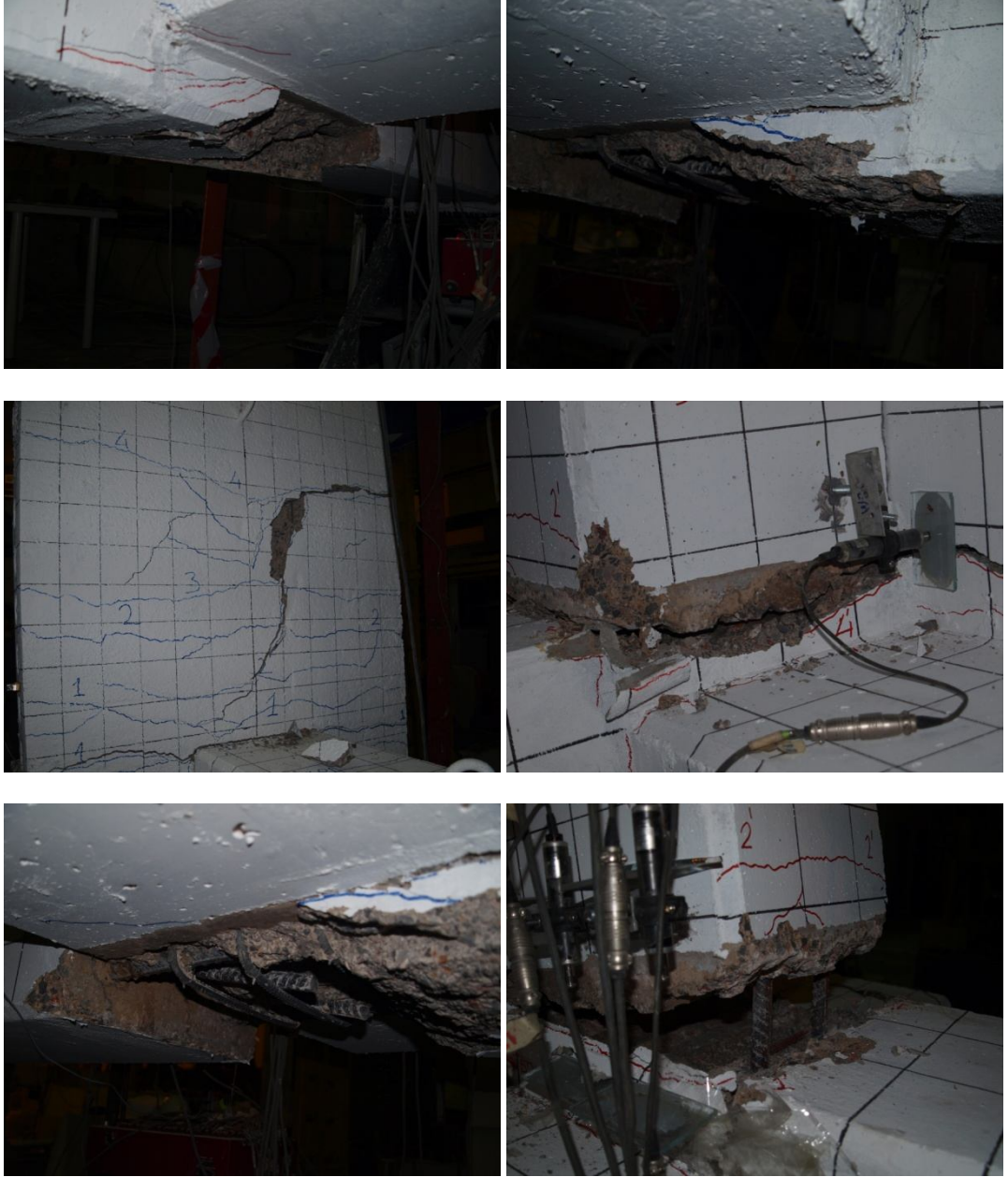
Şekil 2.51 : 5. çevrim grubundan deney sonuna kadar numunedeki hasar durumu Deney boyunca izlenen ve kaydedilen çatlaklar, Şekil 2.52 ve Şekil 2.53’teki çatlak krokilerinde ayrıntılı şekilde verilmiştir.
