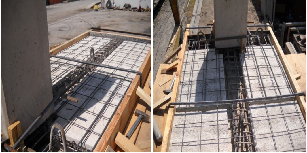
Şekil 2.18 : Döşeme elemanları ve hasır donatının yerleştirilerek kalıba alınması
