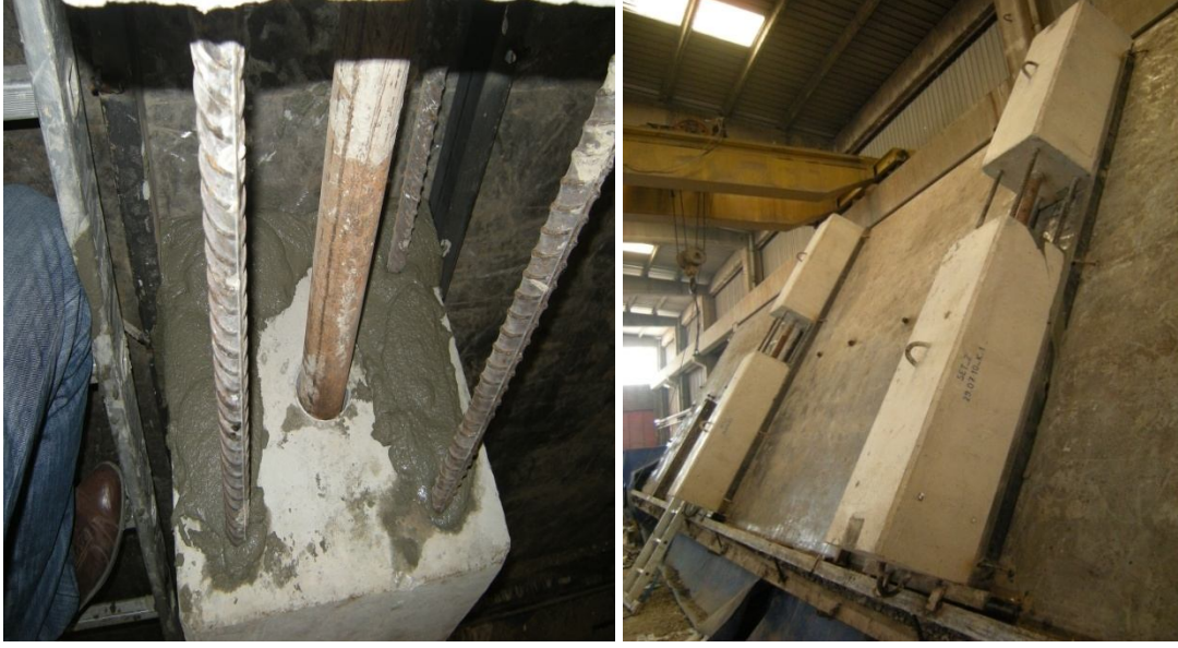
Şekil 2.16 : Alt ve üst kolonun birleştirilmesi
