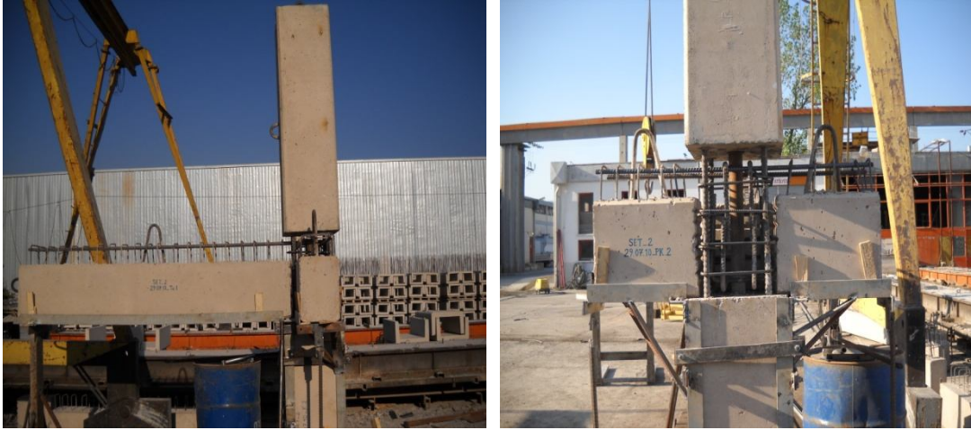
Şekil 2.17 : Kolon-kiriş birleşiminin oluşturulması
