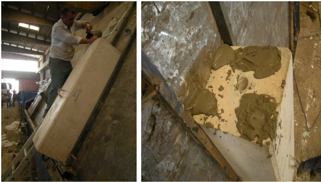
Şekil 2.15 : Yuvalara dolgu harcının ilave edilmesi işlemi
