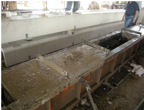
Şekil 2.13 : Kolonlara ait beton döküm işlemi
