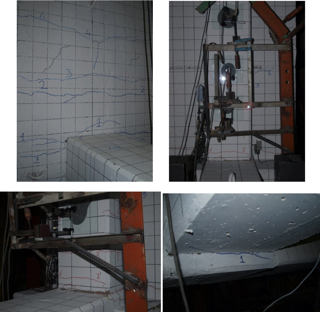
Şekil 2.50 : 4. çevrim grubu sonucu numunede oluşan hasar durumu
