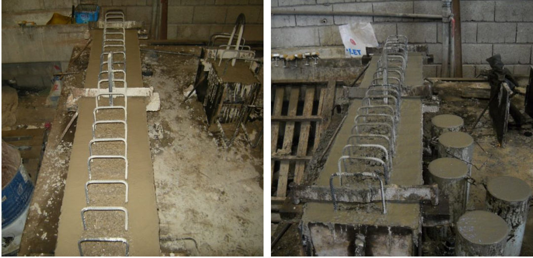
Şekil 2.14 : Kirişlere ait beton döküm işlemi
