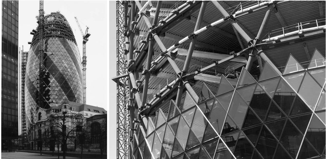
Şekil 3.2. : Swiss-Re Binasındaki tekrarsız çelik üzeri, cam kaplama elemanların cepheye uygulanışı. (Abel, 2004)
