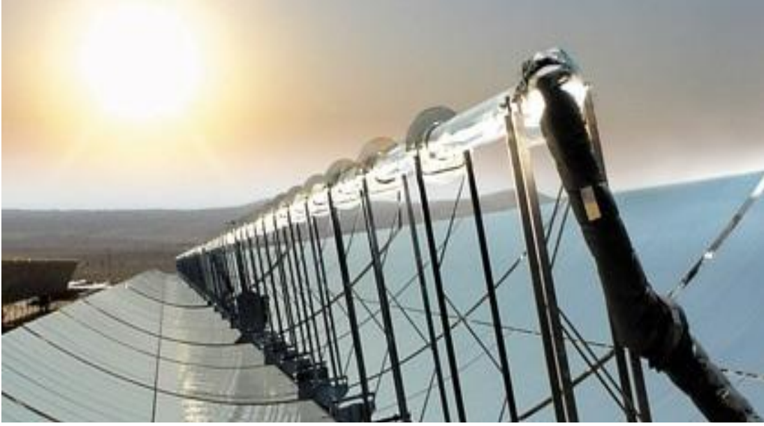
Şekil 18: Parabolik Enerji Santrali (Güneş Absorbe Sistemi)
