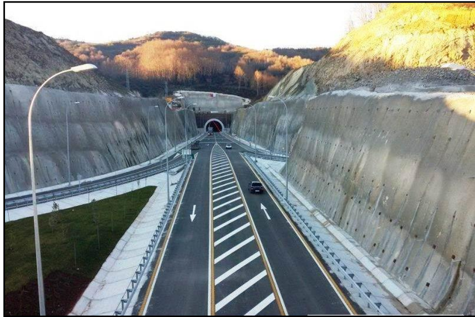
Fotoğraf 53: Yeni Yapılan Amasra Tünelinden Görünüm (www.bartınolay.com).
