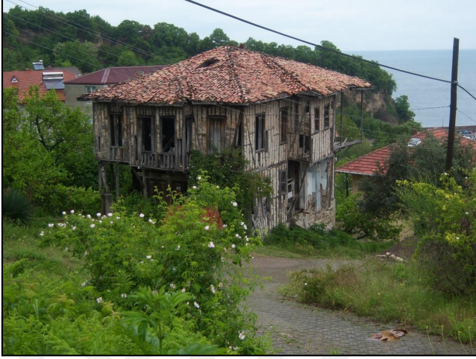
Fotoğraf 41: Curunlu Köyünde Tuğla İle Dolgu Sağlanan Karkas Sistem Mesken
