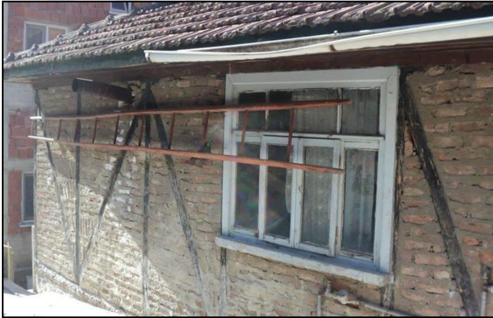
Fotoğraf 43: Akkonak Köyünde Karkas Sistemde Tuğla Kullanımı
