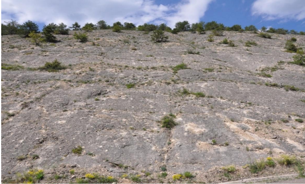
Fotoğraf 41. Tabakaların çatlakları arasındaki kısmen ayrılmış kuşaklarda gelişen ağaç ve çalılar. Trees and shrubs growing partly and/or semi weathered zones between layers and cracks.
