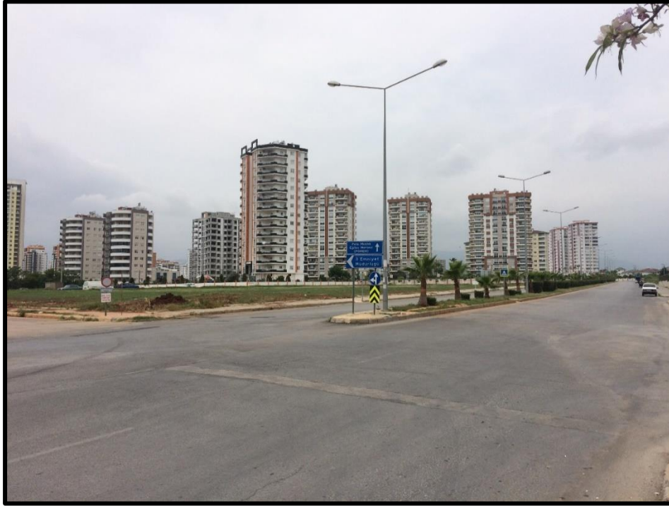
Foto 14. Belediye, Emniyet Müdürlüğü ve İhracatçılar Birliği Binalarının Civarında Yapılaşma
