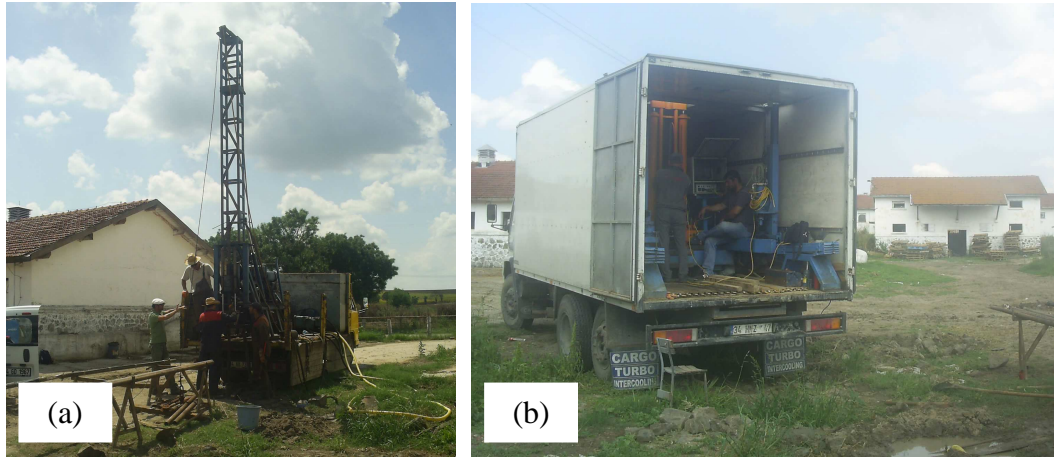
Şekil 4.2 : İnceleme alanında gerçekleştirilen (a) sondaj çalışması (b) CPT çalışması.
