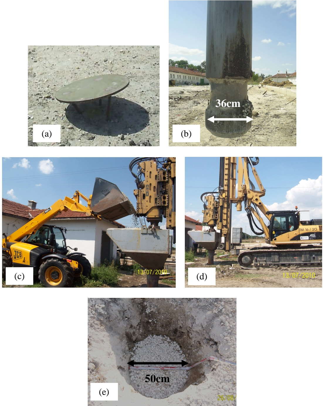
Şekil 4.8 : Impact yöntemi ile DKK elemanı imalat aşamaları.
