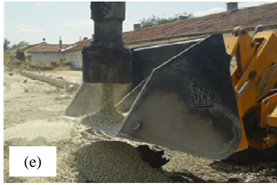
Şekil 4.9 : Öteleme yöntemi ile TK elemanı imalat aşamaları.
