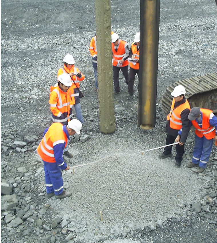
Şekil 3.16 : Artan kırmataş hacim ölçümü.
