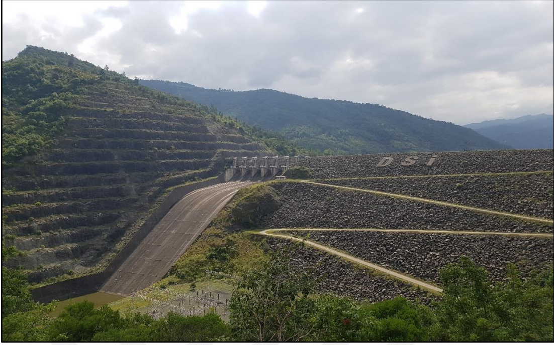
Fotoğraf 4. Hasan Uğurlu hidroelektrik santrali
