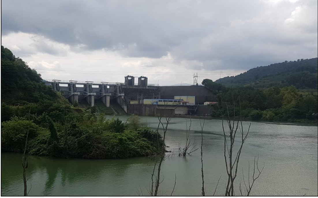
Fotoğraf 3. Suat Uğurlu Hidroelektrik Santrali
