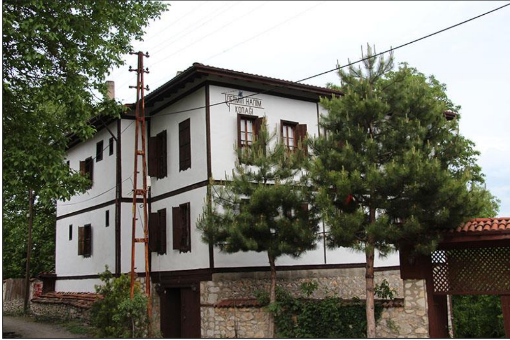
Ek Şekil 22 Nermin Hanım Konağı.
