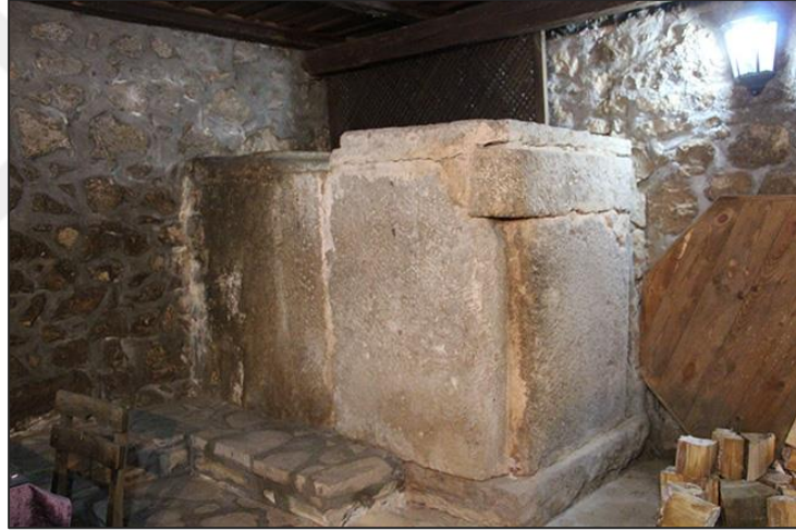
Şekil 41 Muratoğlu Konağı sarnıç
