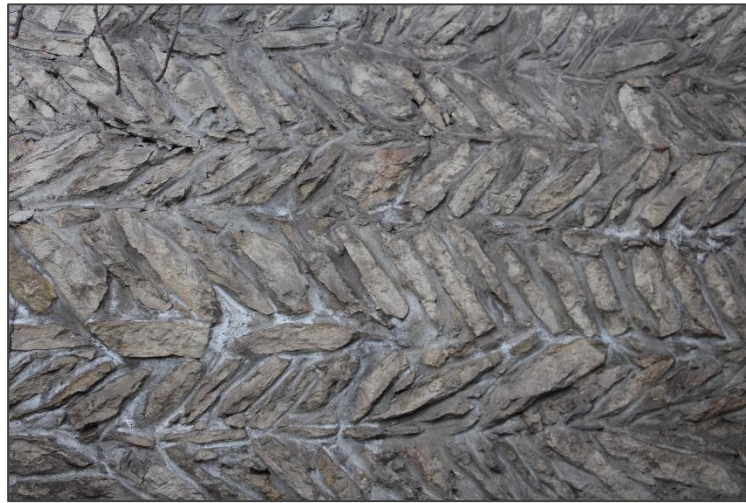
Şekil 11 Balıksırtı tekniği ile örülmüş bir taş duvar (Eski Çarşı)
