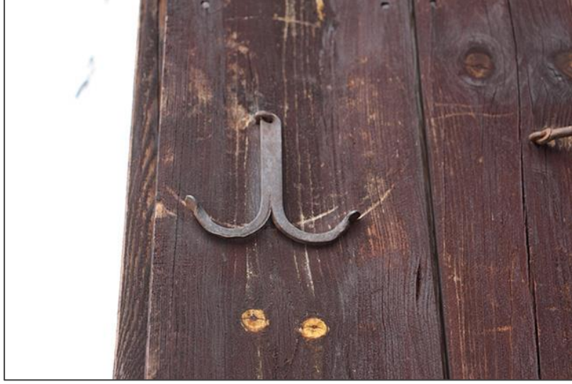
Şekil 26 Safranbolu Evlerinden bir kapak kancası detayı.
