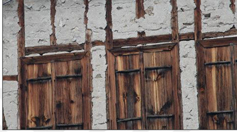
Şekil 34 Pencere kenarlarında omuzlar (Eski Çarşı).
