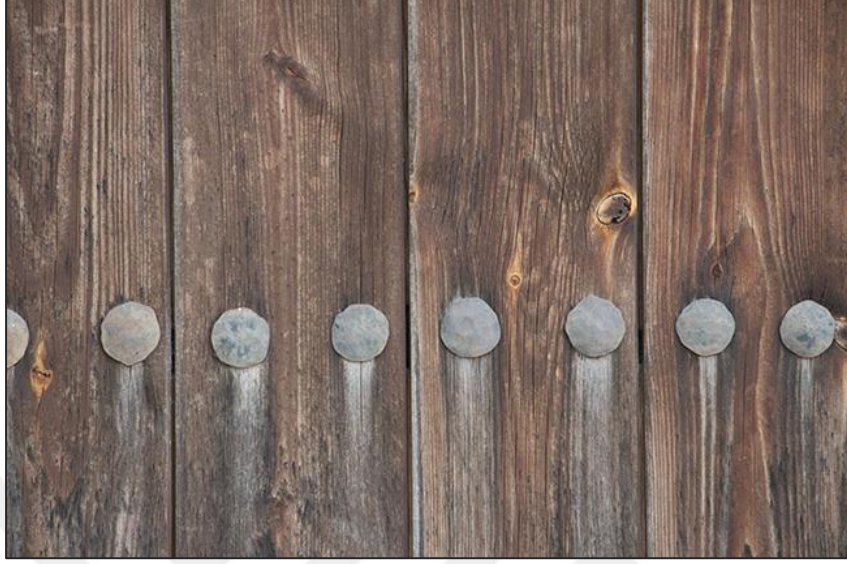
Şekil 25 Giriş kapısı üzerinde kalpaklı çiviler.
