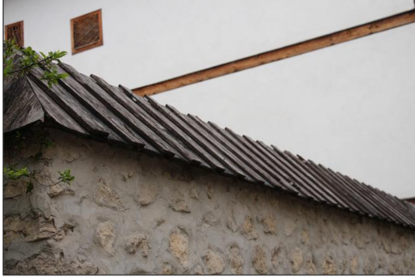
Şekil 48 Bahçe duvarı üzerindeki tora (Yörük Köyü)
