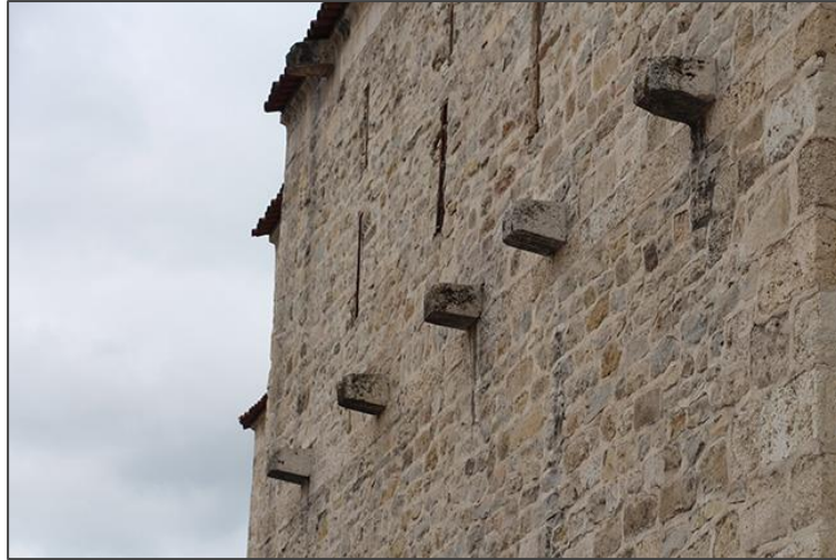
Şekil 16 Cinci Hamamda bulunan çörtlenler.
