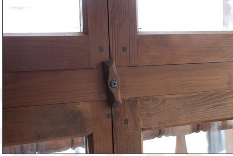
Şekil 17 Sipahioğlu Konağından çövürgeç detayı.
