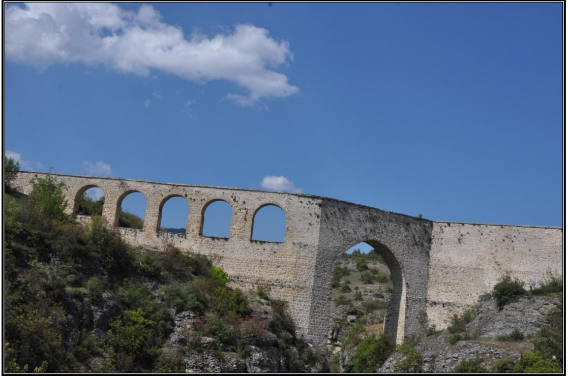
Fotođraf 9. Yerleşmenin kuzey kesimindeki dađlık alandan ıkan suyu şehre taşımak için Osmanlı tarafından Tokatlı Kanyonu üzerinde inşa edilmiş İnce Su Kemerleri
