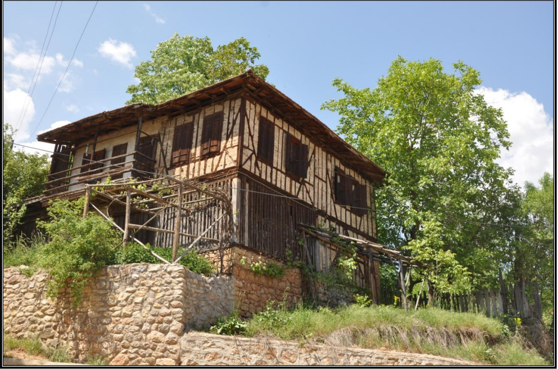
Fotoğraf 40. Safranbolu İncekaya köyünde ahşap, taş ve kerpiç malzemesinin bir arada kullanıldığı konuttan bir görünüm
