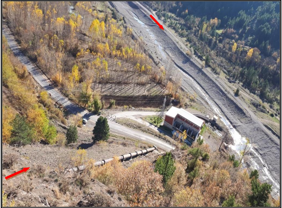
Fotoğraf 53. İsalan Mahallesi mevkiinde kurulu olan Kızılcım HES'inden bir görünüm
