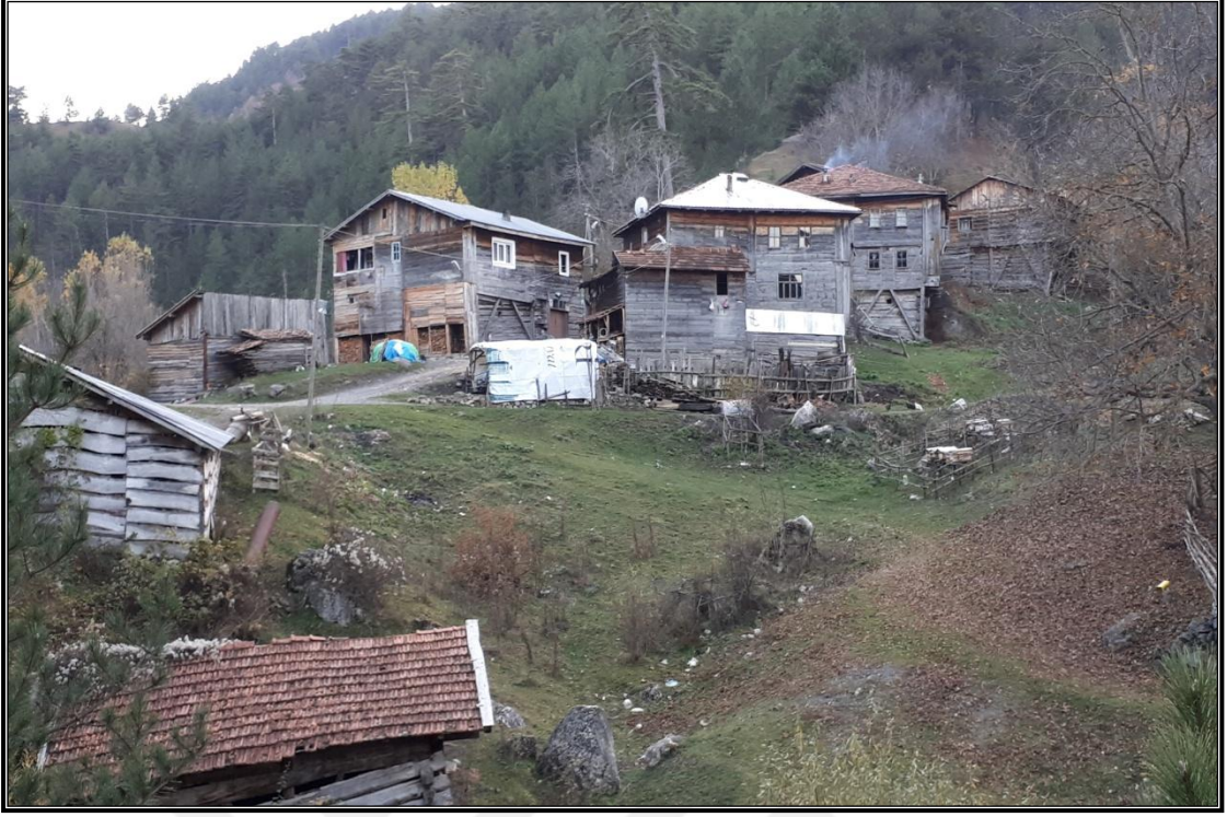
Fotoğraf 41. Çatıları marsilya kiremit ve sac ile kaplı olup diğer kesimleri tamamen ahşaptan inşa edilmiş Kızıleller'e bağlı Gamit Mahallesi
