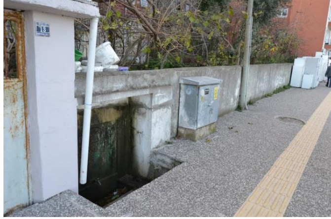
Fotoğraf 172. Boyran Mahallesi Sokak eşmesi I, Genel Görünüm
