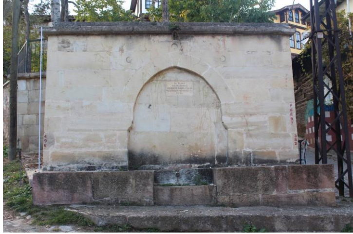
Fotoğraf 12. Server Çeşmesi, Doğu Cephe
