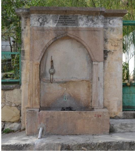
Fotoğraf 74. Hacı Hamza Efendi Çeşmesi, Doğu Cephe ve Örtü Sistemi
