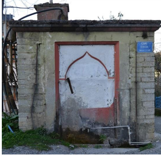
Fotoğraf 186. Çinili Camii Çeşmesi, Kuzeydoğu Cephe
