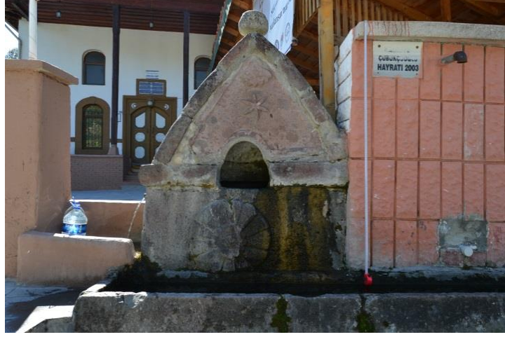
Fotoğraf 153. Haraçoğlu Camii Çeşmesi, Kuzey Cephe Genel Görünüm
