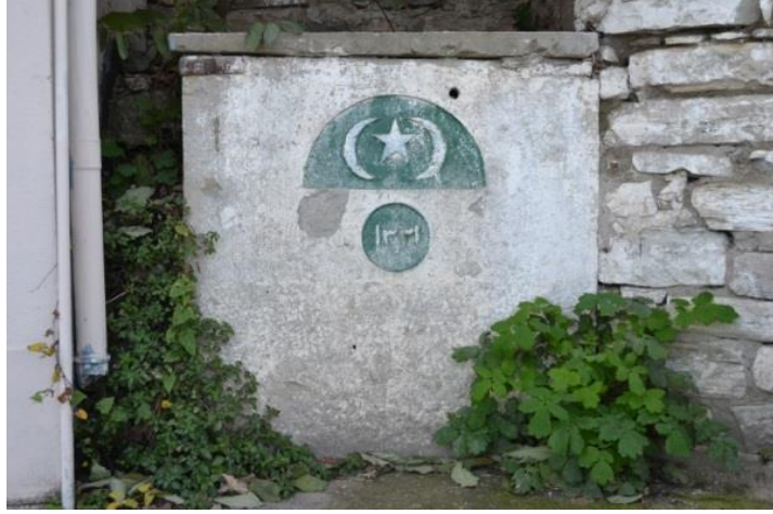
Fotoğraf 217. Boyran Mahallesi Sokak eşmesi III, Kuzeybatı Cephe
