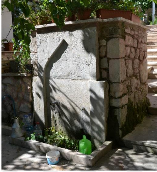
Fotoğraf 145. Gideros Camii Çeşmesi, Kuzey ve Batı Cepheler
