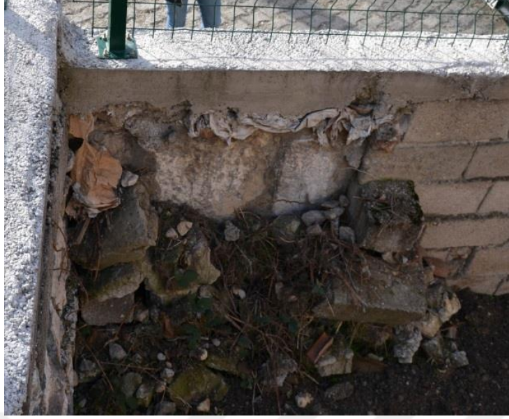
Fotoğraf 143. Eflaniliođlu eşmesi, Kuzey Cephe
