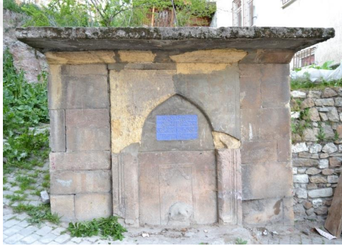
Fotoğraf 43. Çukur Çeşme, Güney Cephe
