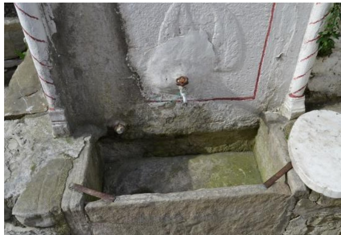
Fotoğraf 197. Mehmet Sabri Caddesi Sokak eşmesi, Güneydoğu Cephe, Detay
