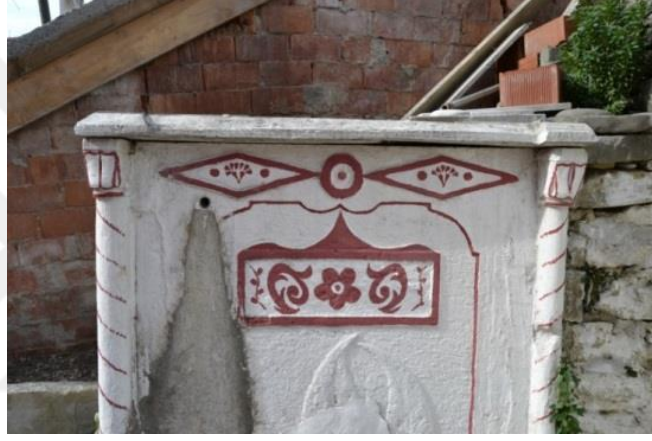
Fotoğraf 196. Mehmet Sabri Caddesi Sokak eşmesi, Güneydoğu Cephe, Detay
