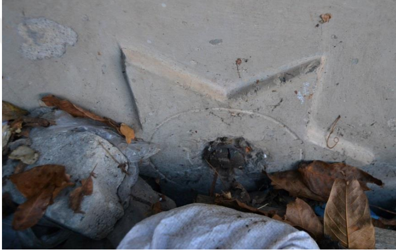
Fotoğraf 116. Nuri Fırtına Çeşmesi, Kuzey Cephe, Ayna Taşı
