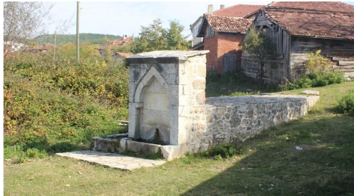
Fotoğraf 124. Akıncılar Köyü Çeşmesi, Batı ve Güney Cepheler
