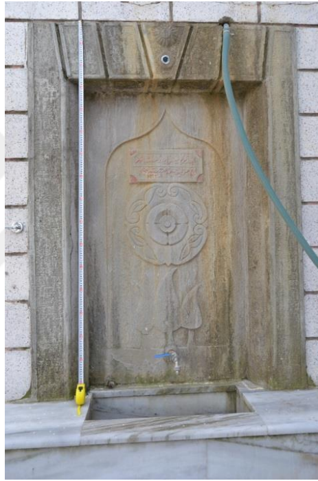
Fotoğraf 208. Su Yolu Sokak Çeşmesi, Batı Cephe
