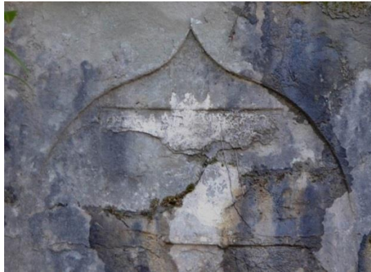
Fotoğraf 188. Çinili Camii Çeşmesi, Güneybatı Cephe, Kitabe
