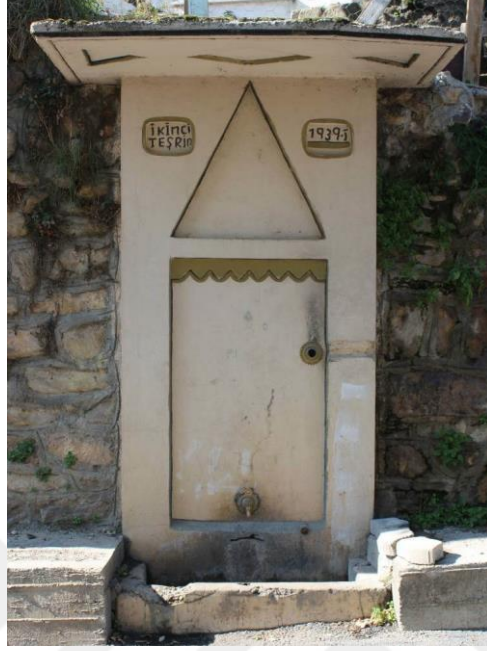
Fotoğraf 108. İbrikli Sokak Çeşmesi, Kuzeydoğu Cephe, Genel Görünüm
