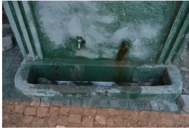
Fotoğraf 107. Hacıkadın Çeşmesi, Doğu Cephe, Yalak
