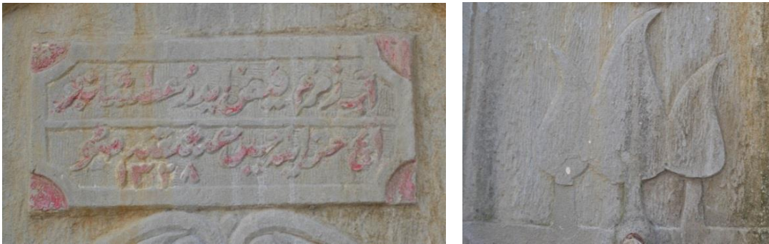
Fotoğraf 209. Su Yolu Sokak Çeşmesi, Batı Cephe, Kitabe ve Servi Ağaçları
