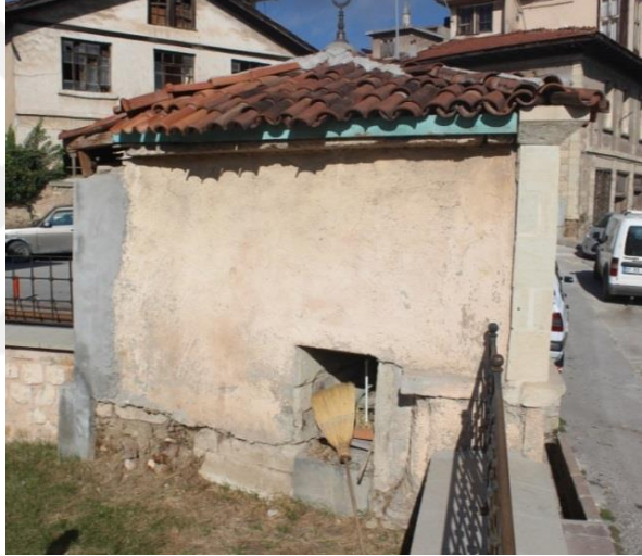
Fotoğraf 52. Hepkebirler Çeşmesi, Güney Cephe
