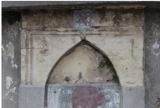
Fotoğraf 24. Taş Çeşme, Güneybatı Cephe, Detay
