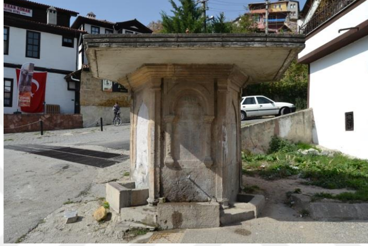
Fotoğraf 109. Aşağı İmaret Sokak Meydan Çeşmesi, Güneydoğu, Doğu ve Kuzeydoğu Cepheler
