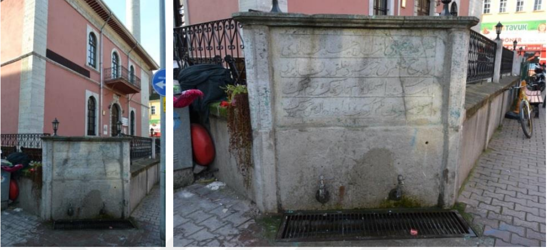
Fotoğraf 223. Tefikiye Camii Kuzeydoğu Köşesindeki Çeşme, Genel Görünüm
