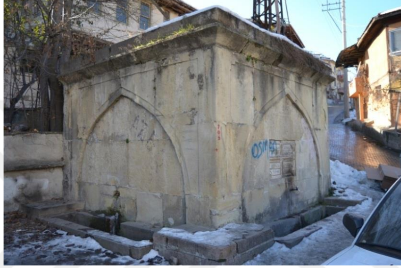
Fotoğraf 55. Arslanlı Çeşme Güneybatı ve Güneydoğu Cepheler
