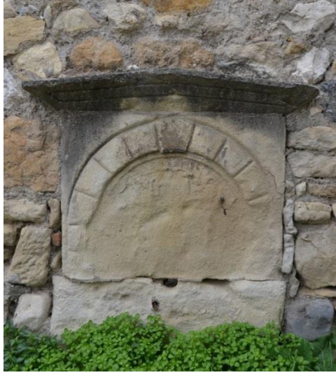
Fotoğraf 47. Yıldırım Sokak Çeşmesi, Güneybatı Cephe Genel Görünüm
