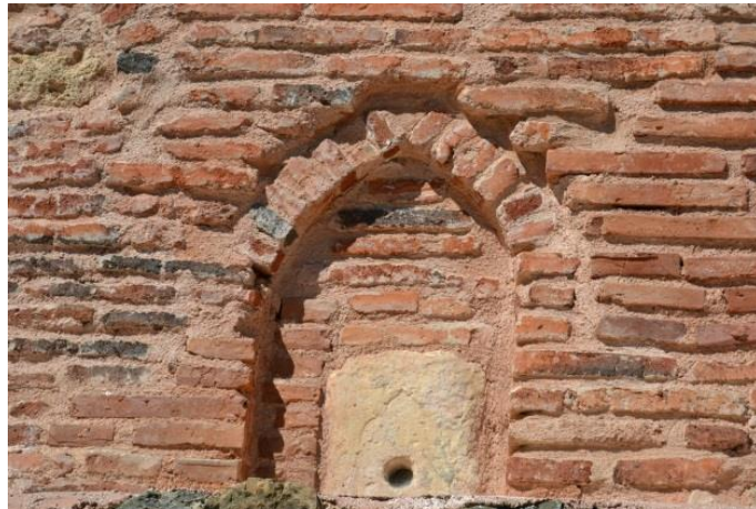
Fotoğraf 232. Aşağı Mescid Camii Çeşmesi, Doğu Cephe, Ayna Taşı
