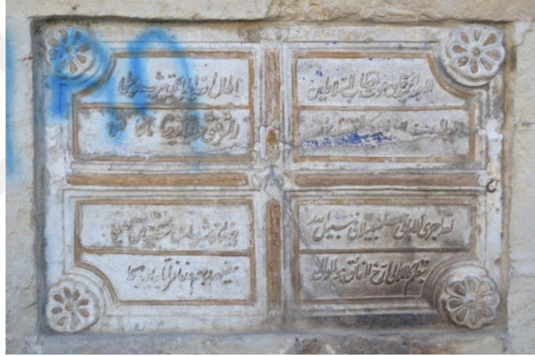
Fotoğraf 58. Arslanlı Çeşme, Güneydoğu Cephe, Kitabe
