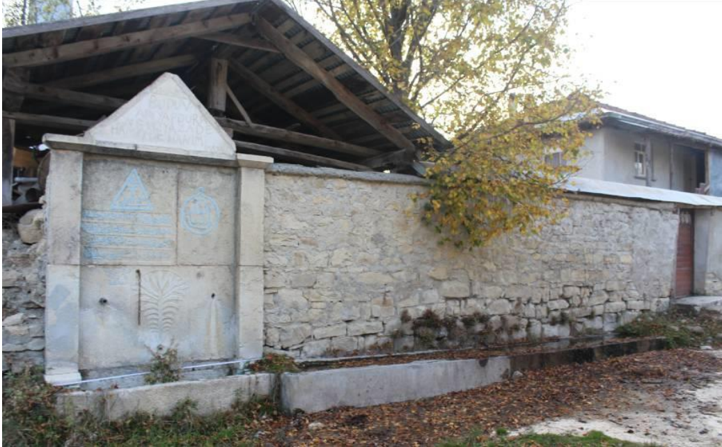
Fotoğraf 149. Karacaören Köyü Camii Çeşmesi, Genel Görünüm
