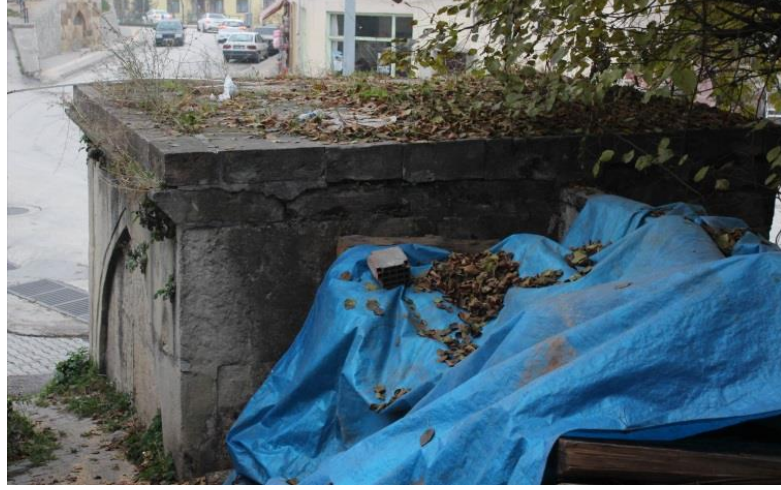
Fotoğraf 57. Arslanlı Çeşme, Kuzeydoğu ve Kuzeybatı Cepheler
