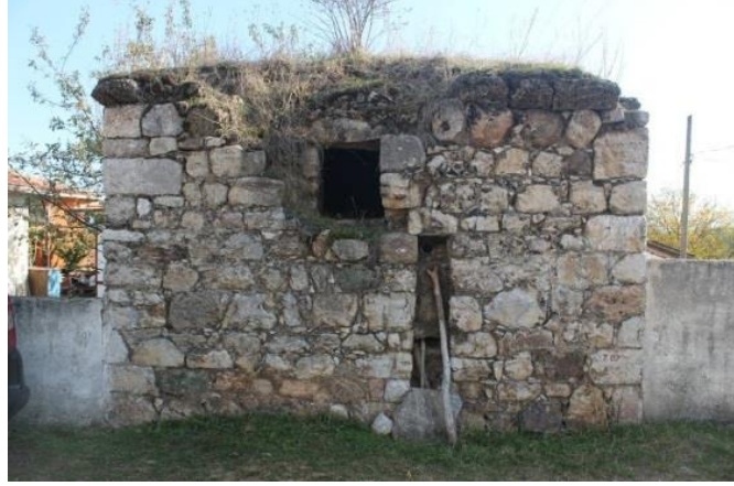
Fotoğraf 131. Acaroğlu Çeşmesi, Kuzey Cephe
