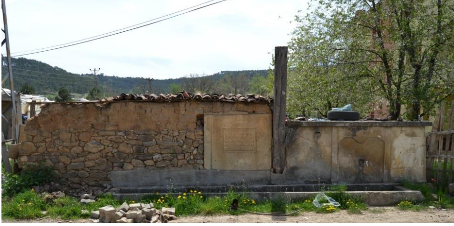
Fotoğraf 241. Bekdemirekşi Köyü Çeşmesi, Kuzey Cephe, Genel Görünüm
