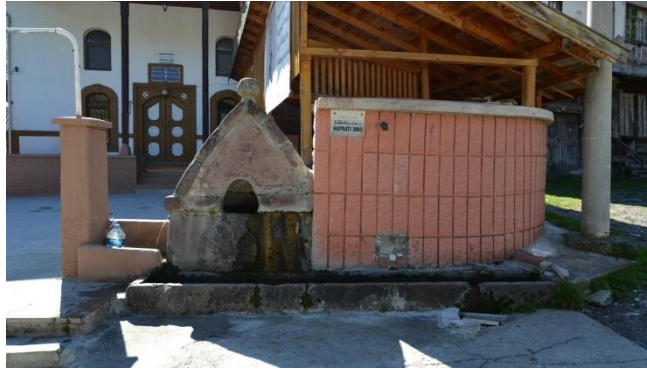
Fotoğraf 152. Haraçoğlu Camii Çeşmesi, Kuzey Cephe Genel Görünüm
