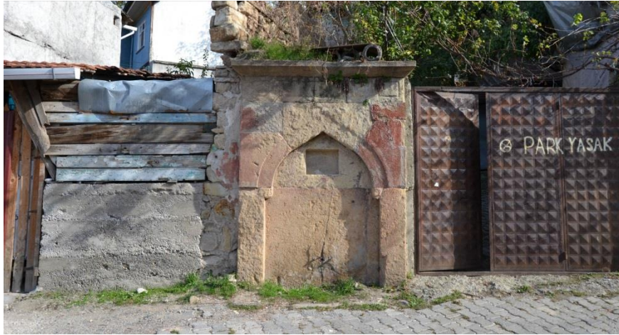
Fotoğraf 32. Kancı Çeşme, Batı Cephe Genel Görünüm
