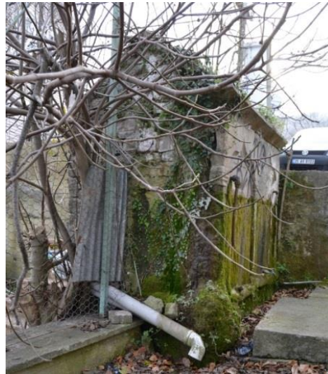
Fotoğraf 192. Karadeniz Mahallesi Sokak Çeşmesi, Kuzey Cephe
