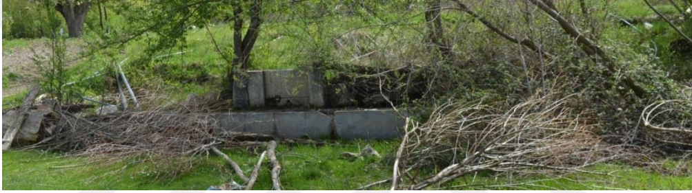
Fotoğraf 253. Duruca Köyü Çeşmesi, Kuzey Cephe, 2018
