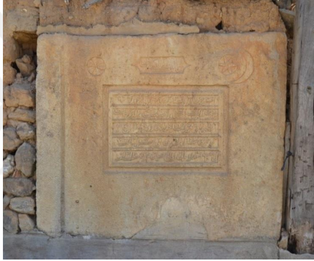
Fotoğraf 242. Bekdemirekşi Köyü Çeşmesi, Kuzey Cephe
