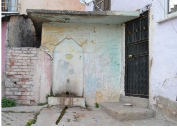
Fotoğraf 86. Çevkani Çeşmesi, Doğu Cephe Genel Görünüm
