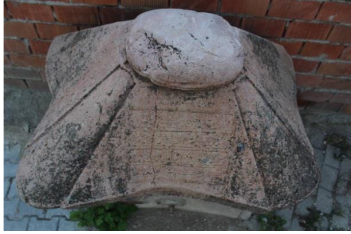
Fotoğraf 62. Abdülcebbar Çeşmesi, Örtü Sistemi
