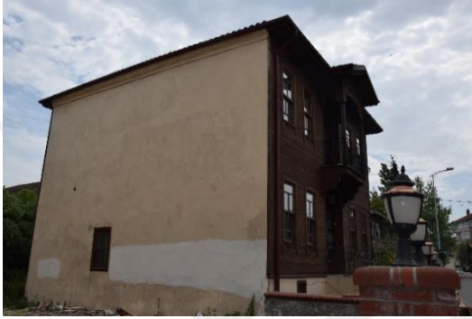
Fotoğraf 540. Kuzey Cephesi
