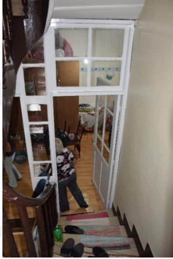
Fotoğraf 351. Merdiven Kapısı
