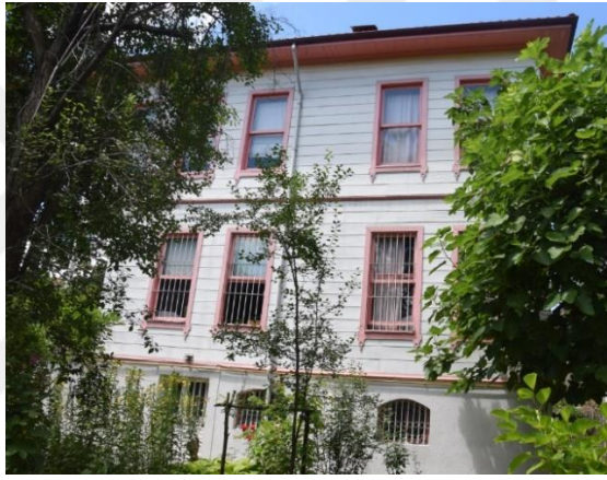
Fotoğraf 242. Doğu Cephesi
