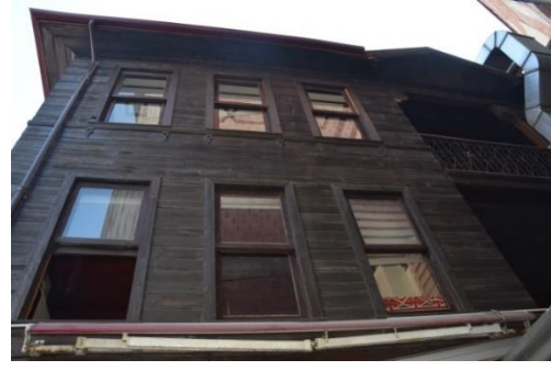
Fotoğraf 173. Kuzey Cephesi
