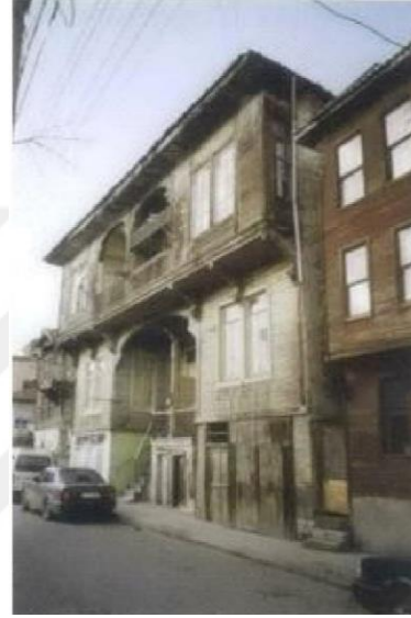
Fotoğraf 286. Kırtepe Mahallesi Köprü Caddesi 24 Numaralı Ev
