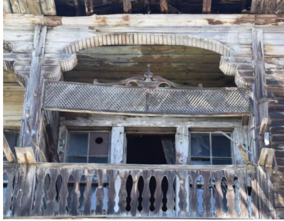
Fotoğraf 292. Ön Cephe Balkon
