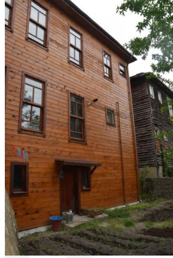
Fotoğraf 379. Kuzey Cephesi
