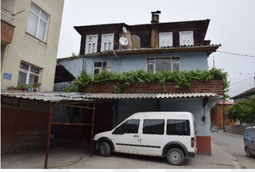
Fotoğraf 343. Güney Cephesi
