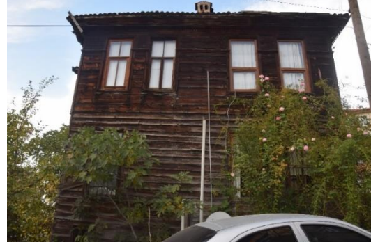
Fotoğraf 531. Doğu Cephesi
