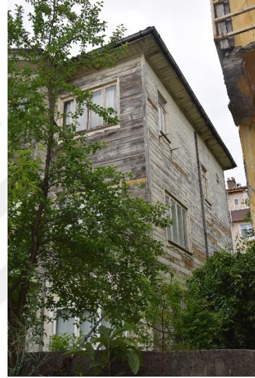
Fotoğraf 553. Güney Cephesi
