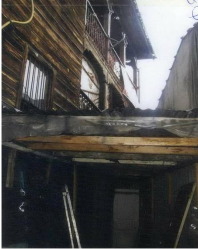
Fotoğraf 174. Kuzey Cephesi
