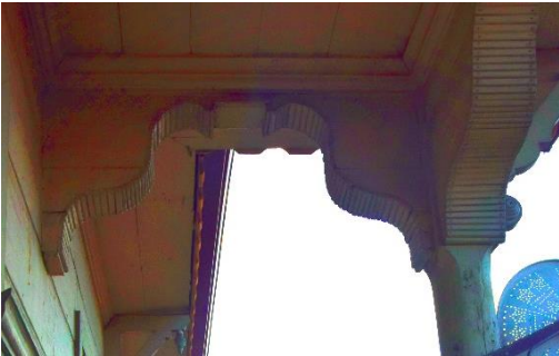
Fotoğraf 45. Balkon Taşıyıcı Bağlığı ve Kemer
