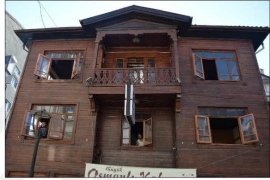
Fotoğraf 198. Kemerköprü Mahallesi Şadırvan Caddesi 12 Numaralı Ev
