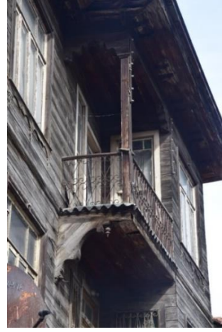
Fotoğraf 160. Kuzeydoğu Balkon
