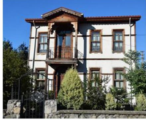
Fotoğraf 455. Gölbucağı Mahallesi 114. Cadde 40 Numaralı Ev
