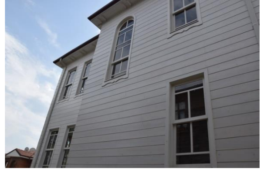
Fotoğraf 83. Kuzey Cephesi
