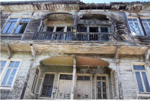
Fotoğraf 287. Doğu Cephesi
