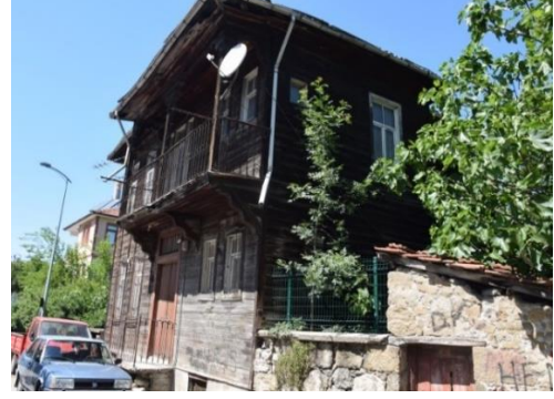
Fotoğraf 505. Güney Cephesi
