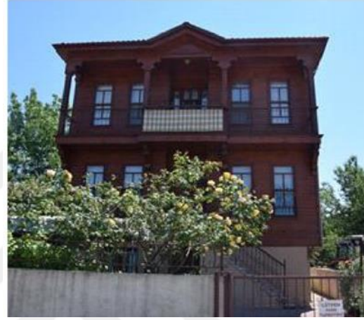
Fotoğraf 400. Köyortası Mahallesi Tersane Caddesi Kavaklı Sokak 56 Numaralı Ev
