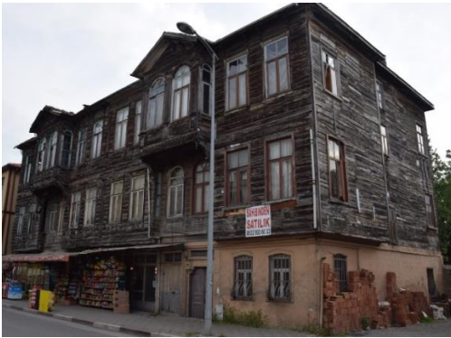
Fotoğraf 448. Güneybatı Cephesi
