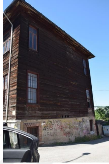
Fotoğraf 517. Güney Cephesi
