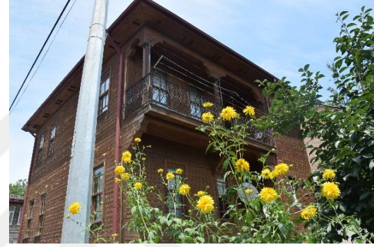
Fotoğraf 541. Doğu Cephesi
