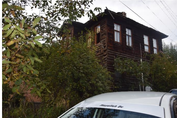
Fotoğraf 532. Güney Cephesi
