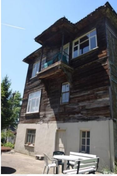
Fotoğraf 465. Doğu Cephesi
