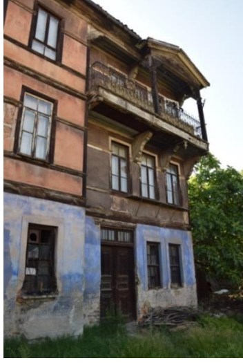
Fotoğraf 108. Doğu Cephesi
