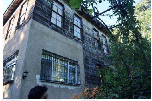
Fotoğraf 307. Kuzeydoğu Cephesi
