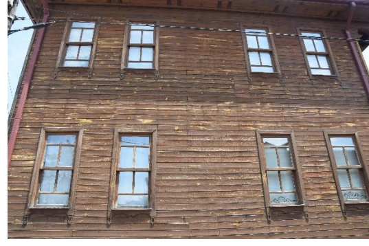
Fotoğraf 539. Güney Cephesi
