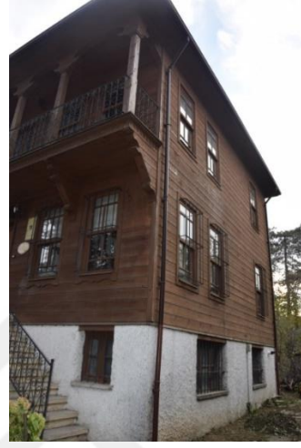
Fotoğraf 216. Güneybatı Cephesi
