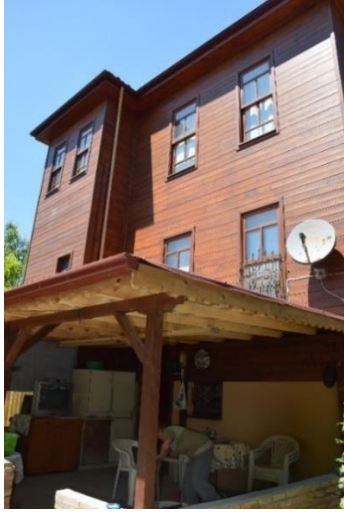
Fotoğraf 405. Ev Güneydoğu Cephesi
