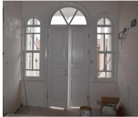
Fotoğraf 98. Zemin Kat Giriş Kapısı
