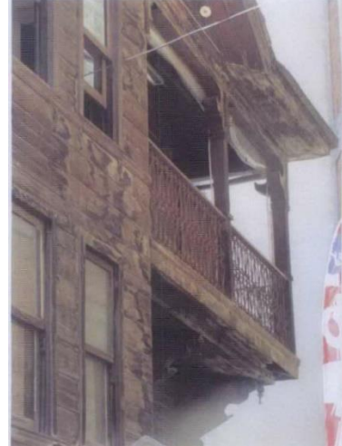
Fotoğraf 175. Kuzey Cephesi Balkon
