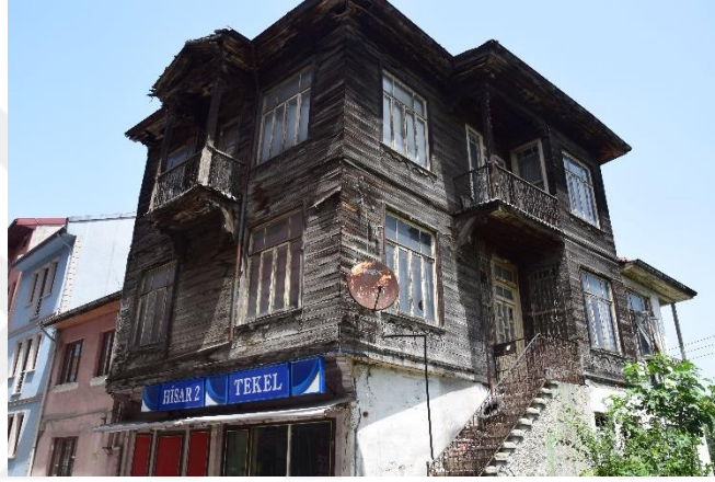
Fotoğraf 155. Kuzeydoğu Cephesi
