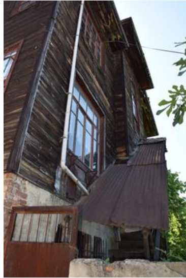
Fotoğraf 519. Doğu Cephesi
