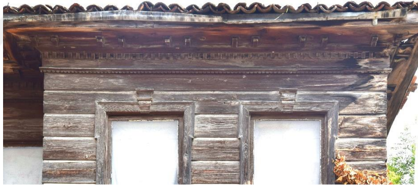
Fotoğraf 499. Çatı Silmeleri
