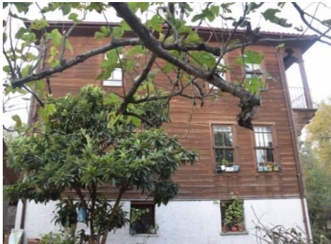
Fotoğraf 217. Kuzeydoğu Cephesi
