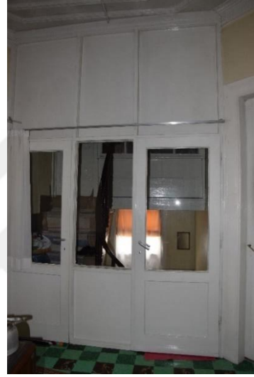
Fotoğraf 352. Merdiven Kapısı
