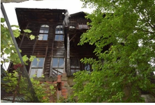
Fotoğraf 263. Güney Cephesi
