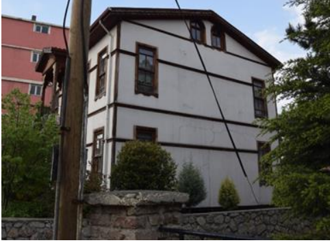
Fotoğraf 456. Güney Cephesi
