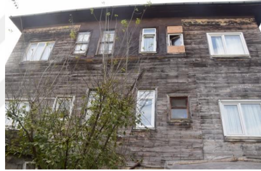
Fotoğraf 64. Kuzey Cephesi
