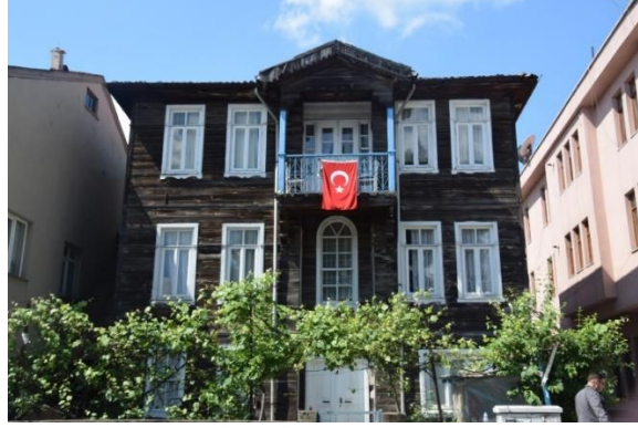
Fotoğraf 480. Kuzey Cephesi
