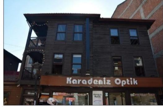
Fotoğraf 171. Kemerköprü Mahallesi Şadırvan Caddesi 8 Numaralı Ev
