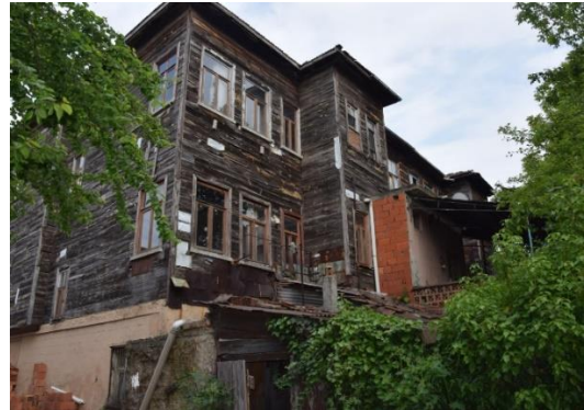
Fotoğraf 449. Güneydoğu Cephesi
