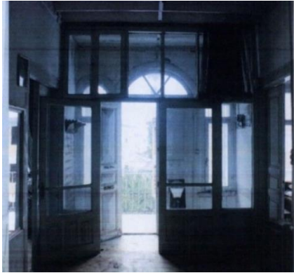
Fotoğraf 97. Zemin Kat Giriş Kapısı
