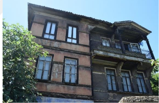
Fotoğraf 116. Doğu Cephe Balkon
