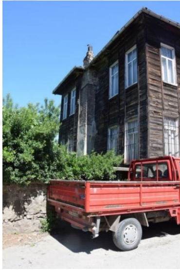
Fotoğraf 506. Kuzey Cephesi
