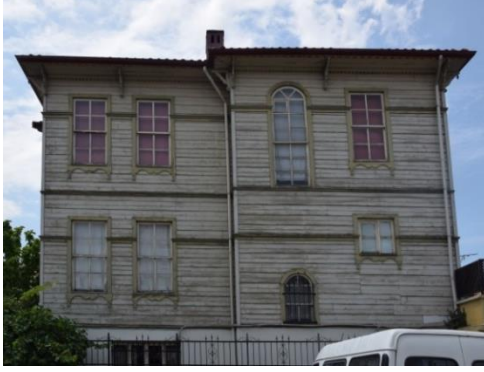
Fotoğraf 35. Doğu Cephesi
