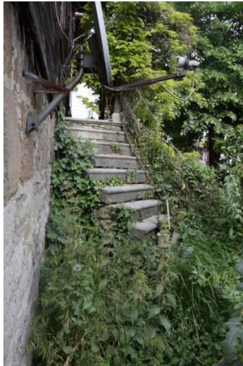
Fotoğraf 426. Ana Giriş Kapısı Merdivenleri
