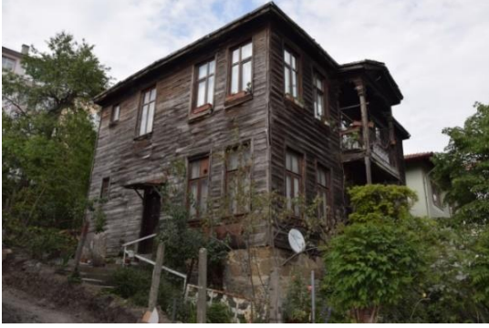
Fotoğraf 424. Güney Cephesi
