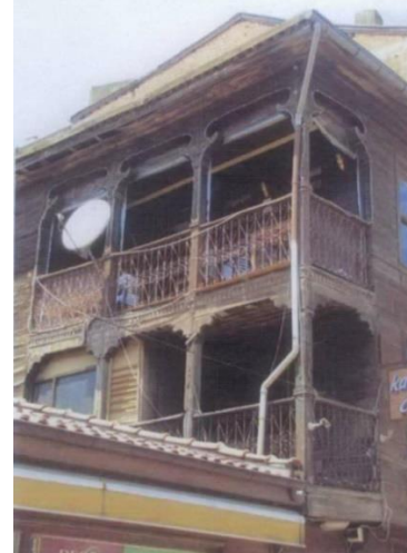
Çizim 38. Güney Cephe Balkonu
