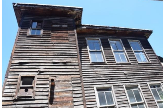
Fotoğraf 8. Güney Cephesi
