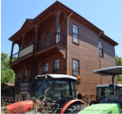
Fotoğraf 403. Güneybatı Cephesi
