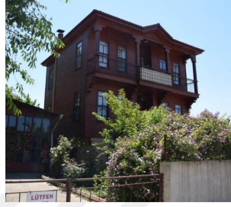
Fotoğraf 402. Kuzeydoğu Cephesi
