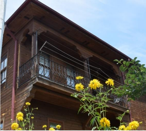
Fotoğraf 548. Doğu Cephe Balkon
