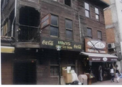
Fotoğraf 172. Doğu Cephesi
