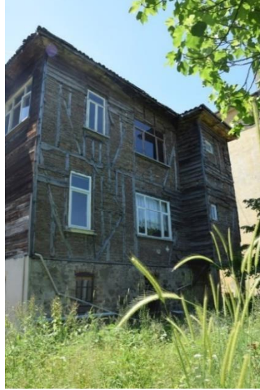
Fotoğraf 467. Kuzey Cephesi
