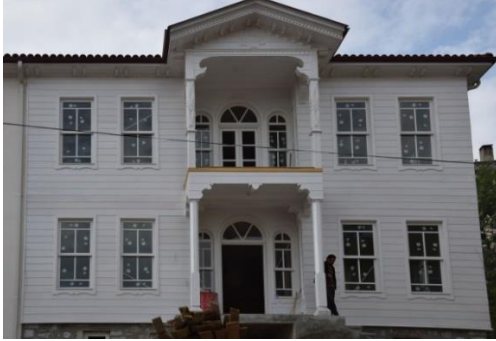
Fotoğraf 82. Doğu Cephesi
