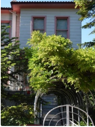
Fotoğraf 240. Güney Cephesi
