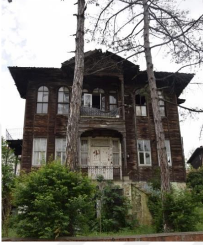
Fotoğraf 261. Doğu Cephesi
