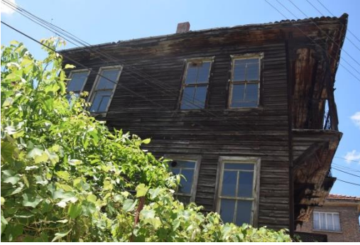
Fotoğraf 6. Doğu Cephesi
