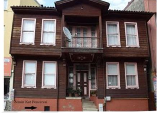
Fotoğraf 134. Gölbucağı Mahallesi 114. Cadde 6 Numaralı Ev
