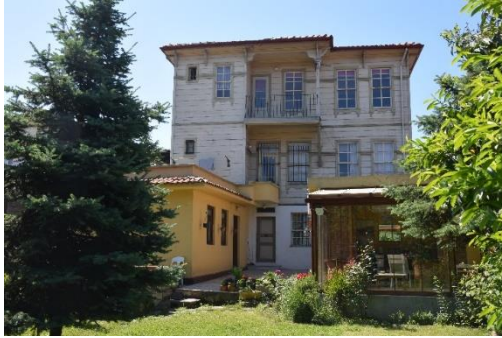
Fotoğraf 37. Kuzey Cephesi
