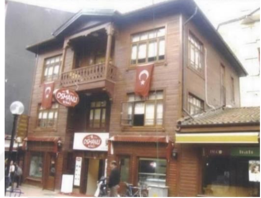
Fotoğraf 200. Kuzey Cephesi
