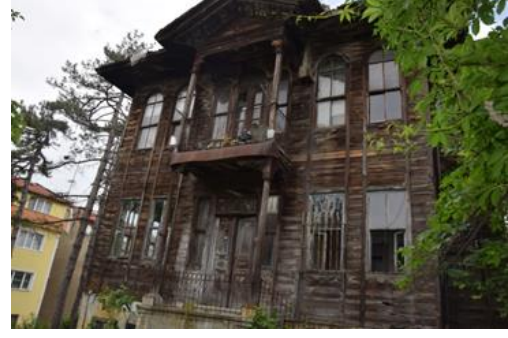
Fotoğraf 264. Kuzey Cephesi
