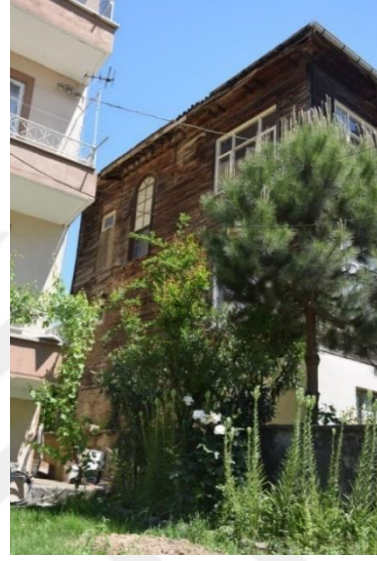
Fotoğraf 466. Doğu Cephesi
