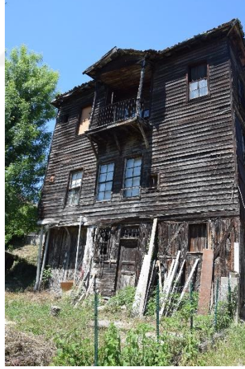
Fotoğraf 494. Güney Cephesi
