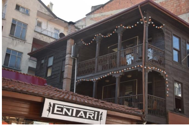
Fotoğraf 176. Güney Cephesi
