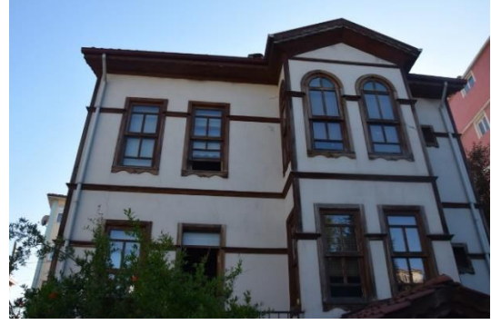
Fotoğraf 457. Doğu Cephesi
