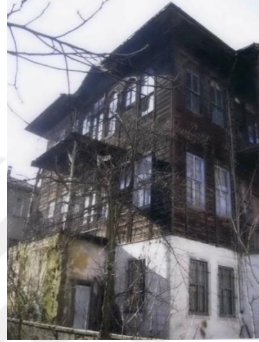
Fotoğraf 262. Güney Cephesi
