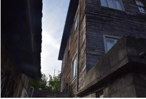
Fotoğraf 63. Doğu Cephesi
