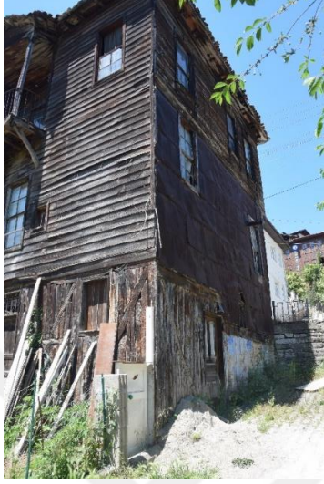
Fotoğraf 492. Doğu Cephesi
