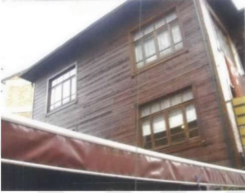
Fotoğraf 199. Güney Cephesi
