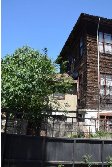
Fotoğraf 518. Kuzey Cephesi
