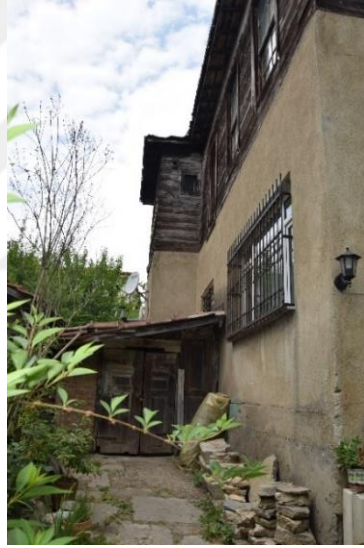
Fotoğraf 308. Güneydoğu Cephesi
