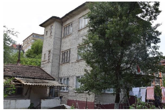
Fotoğraf 555. Doğu Cephesi
