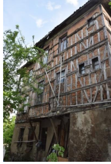
Fotoğraf 109. Kuzey Cephesi
