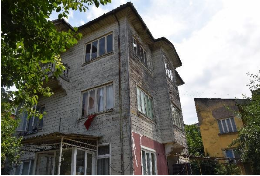
Fotoğraf 554. Kuzey Cephesi
