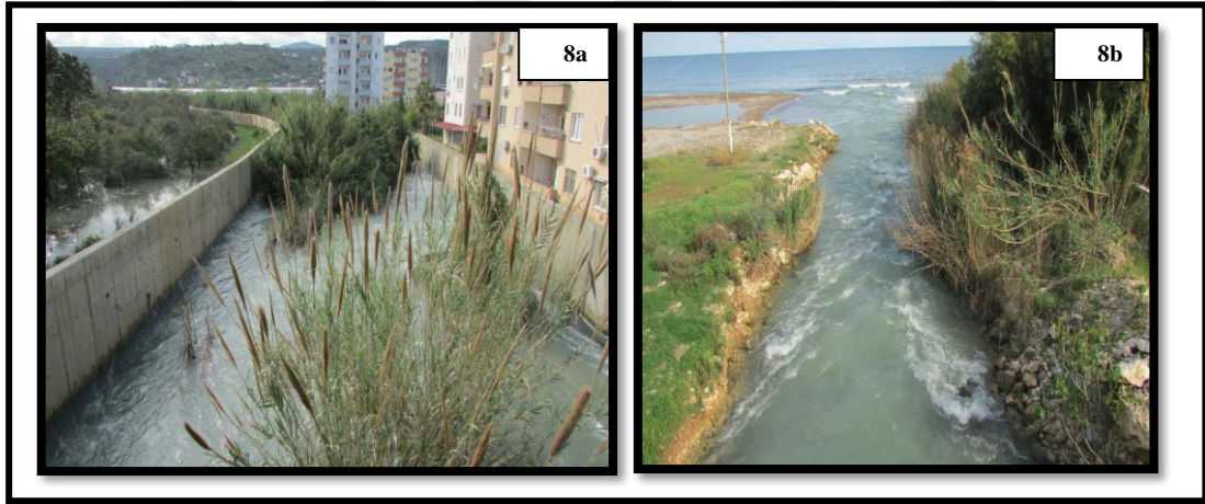
Fotoğraf 8. 8a- Limonlu (Lamas) Çayı üzerinde bulunan taşkın koruma duvarları 8b- Limonlu (Lamas) Çayı'nın Akdeniz ile buluştuğu nokta
