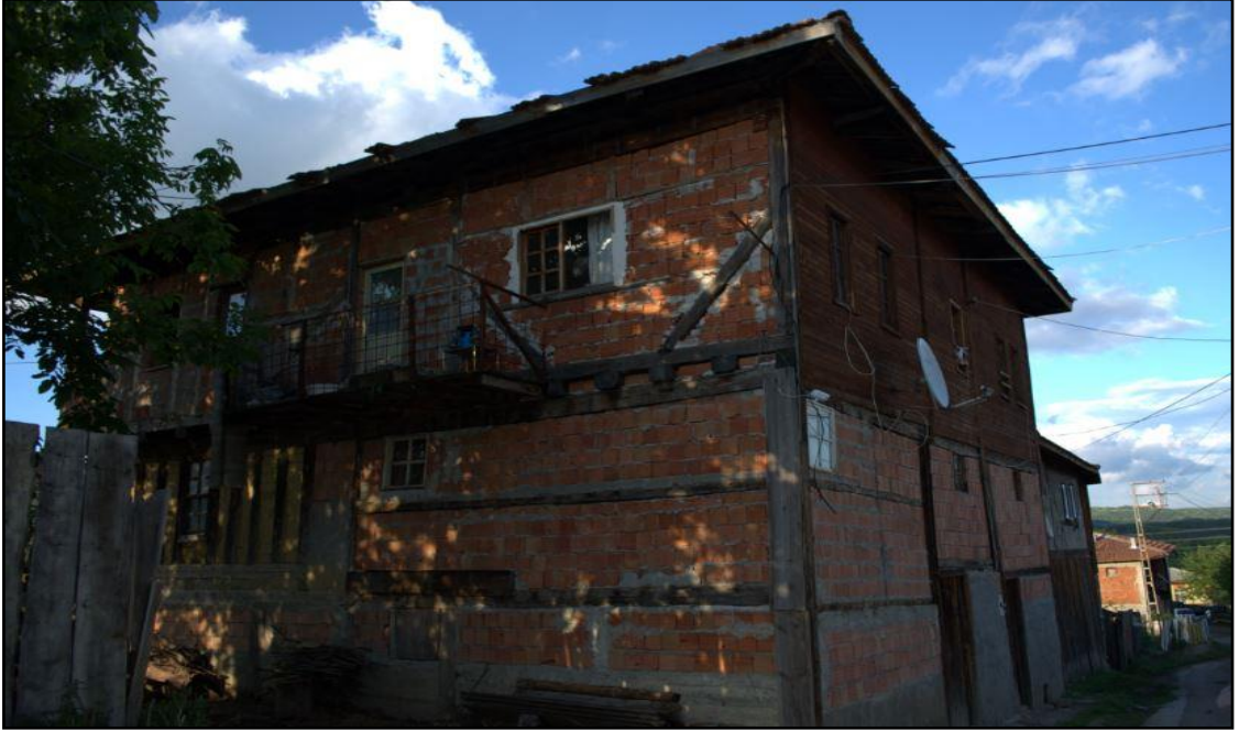
Fotoğraf 27. Tatlıca Köyü'nde tahribattan sonra modern malzeme ile onarılan geleneksel köy meskeni
