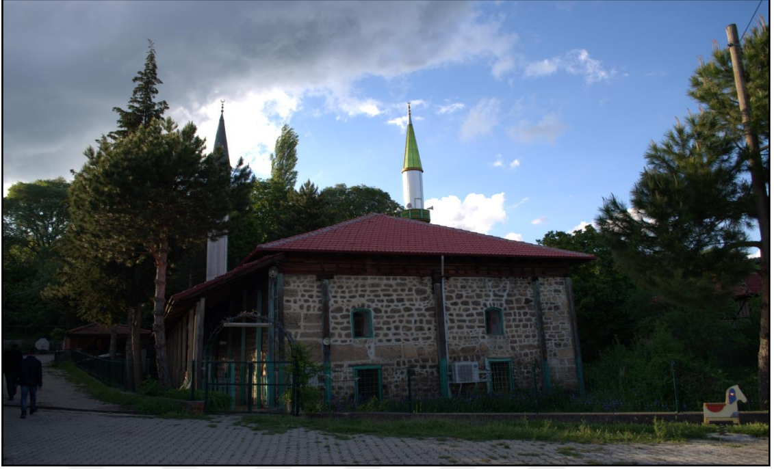
Fotoğraf 58. 1727 yılında İbrahim ağa tarafından onarımı yaptırılan Tatlıca Köyü Camii
