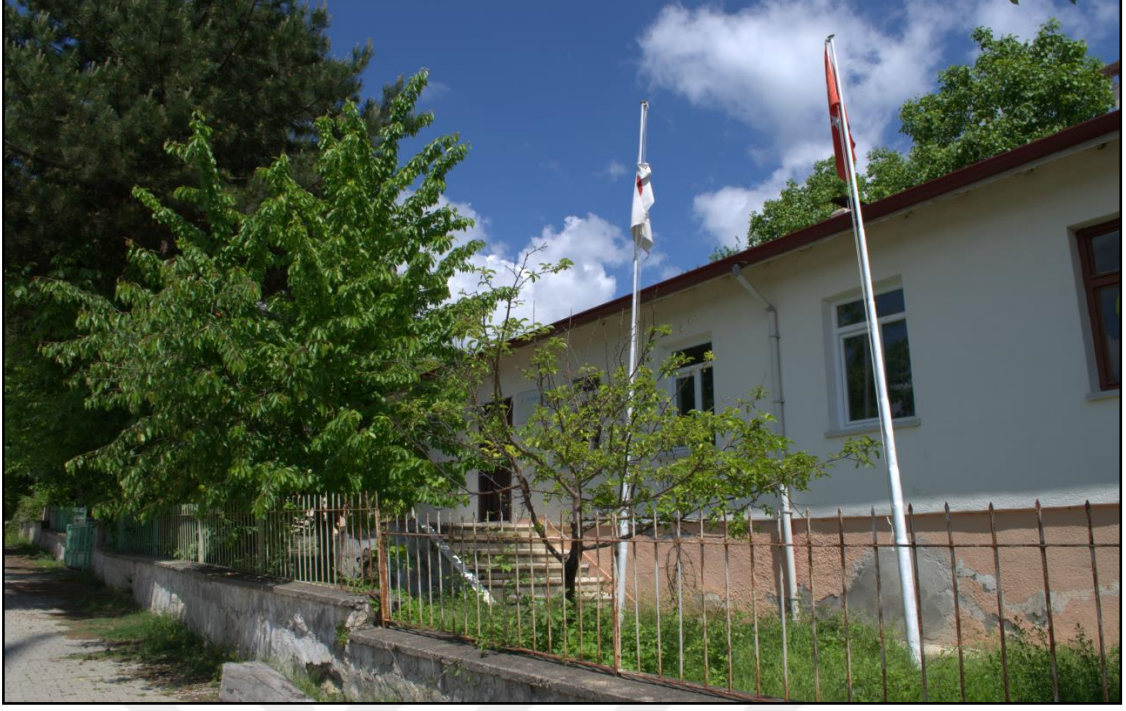
Fotoğraf 51. Araç İlçesi'nin uzak köylerinden biri olan Terke Köyü'nde kapatılmış bir sağlık ocağı
