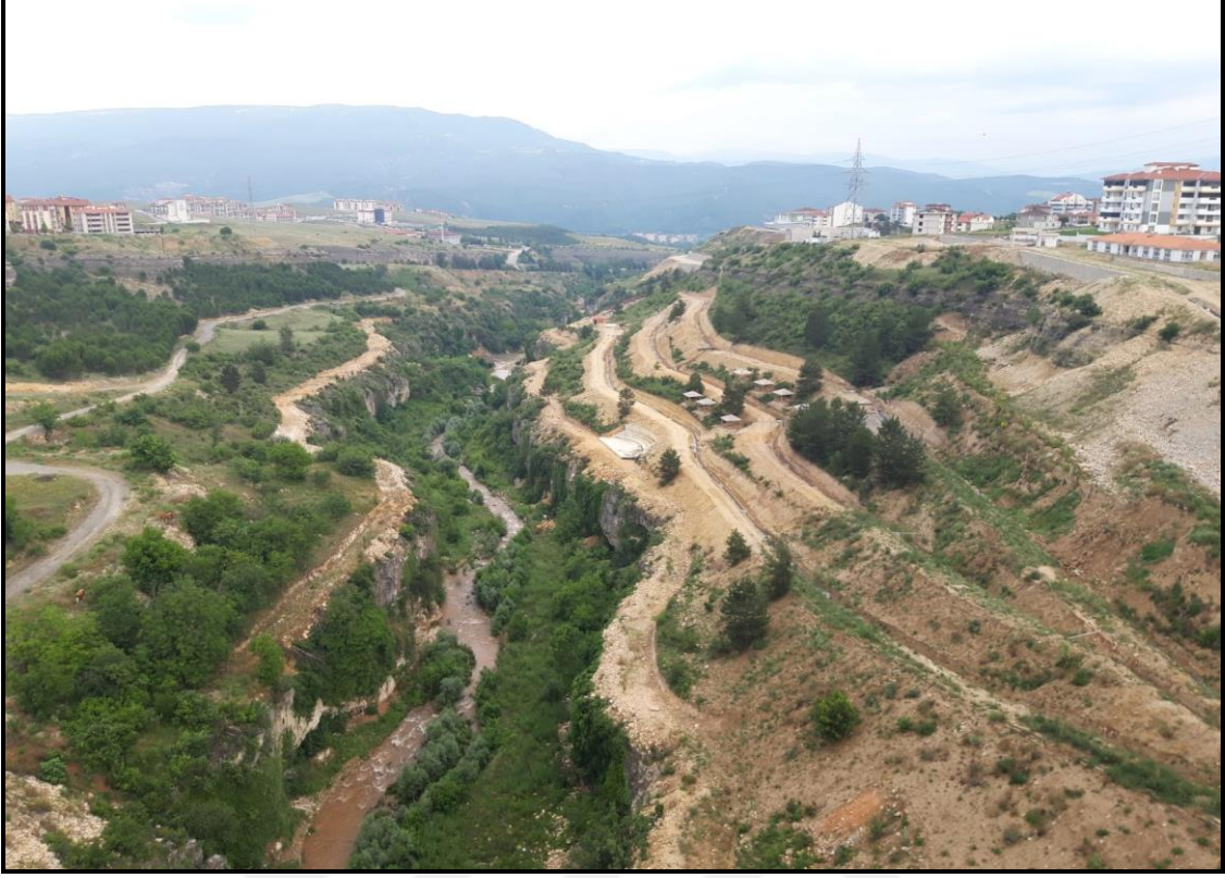
Fotoğraf 48. Bulak Kanyonu ve yakın çevresinde son yıllarda artış gösteren konut inşaatları ve kanyon içerisinde taraçalarla birlikte yapılan yol inşaatı. Bu inşaatlar kanyonun doğal güzelliğini bozmakta ve canlı yaşamını da etkilemektedir (Kanyon köprü üzerinden güneye doğru).
