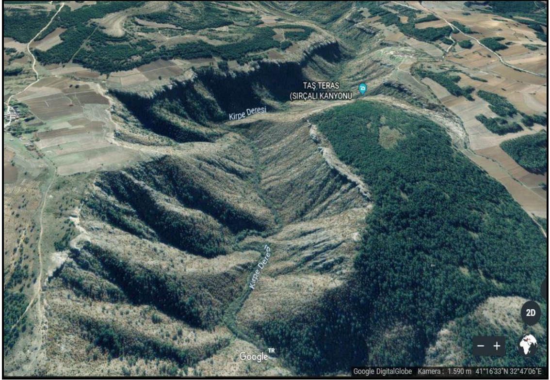
Görsel 3. Sırçalı Kanyonundan kuzeye doğru bir hava fotoğrafı (Google Earth görüntüsü).
