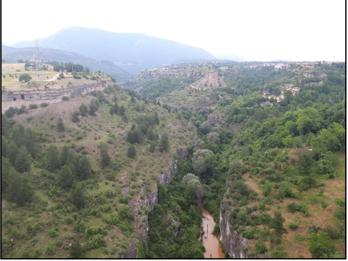
Fotoğraf 47. Bulak Kanyonu'nun, kanyon köprüsü üzerinden görünümü (güneyden kuzeye doğru).
