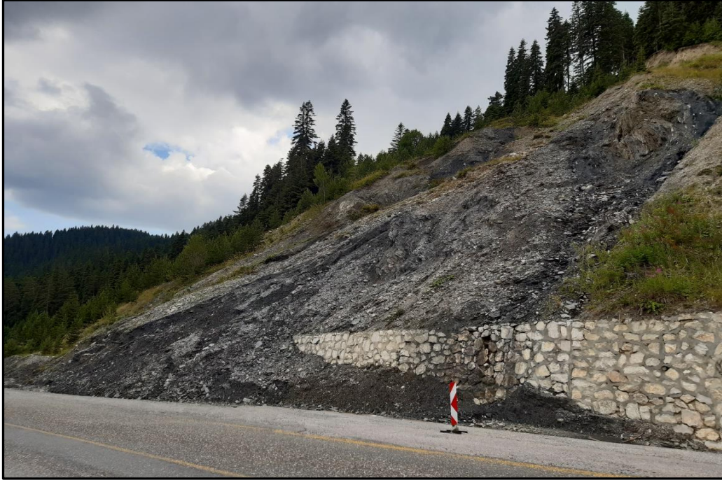
Fotoğraf 23: Ilgaz Dağı Milli Parkına Çıkan Yol Üzerinde Meydana Gelen Toprak Kayması
