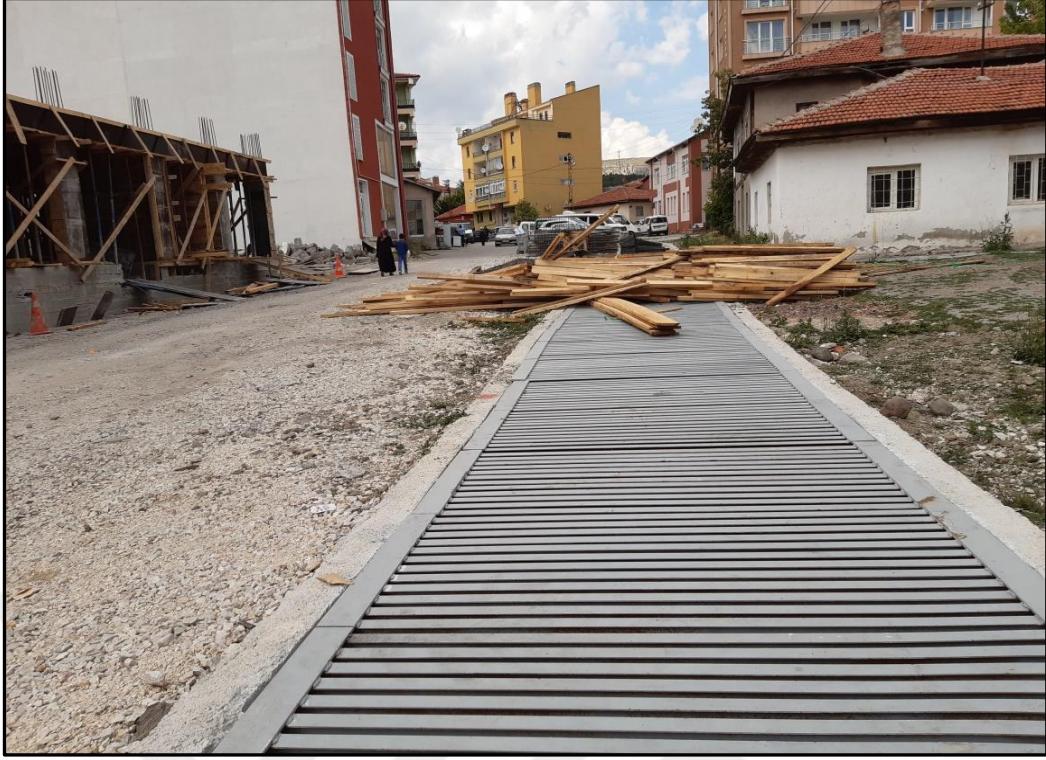
Fotoğraf 20: Kurşunlu İlçe Merkezinde Mandı Deresi Islah Çalışması Kapsamında Yapılan Kanallar
