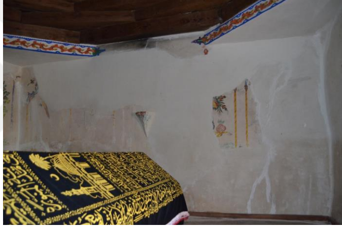
Resim 235. Şeyh Eylük Türbesi, Doğu Duvarının Günümüz Görüntüsü
