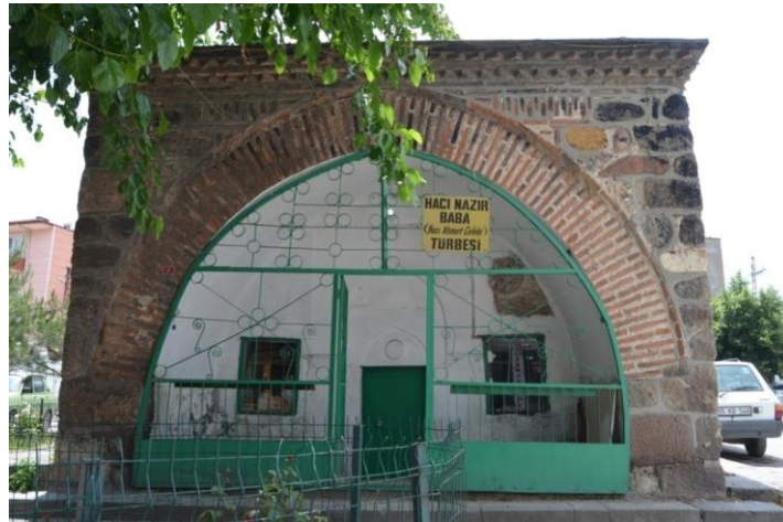
Resim 155. Hacı Nazır Baba Türbesi, Türbenin Kuzey Cephesi
