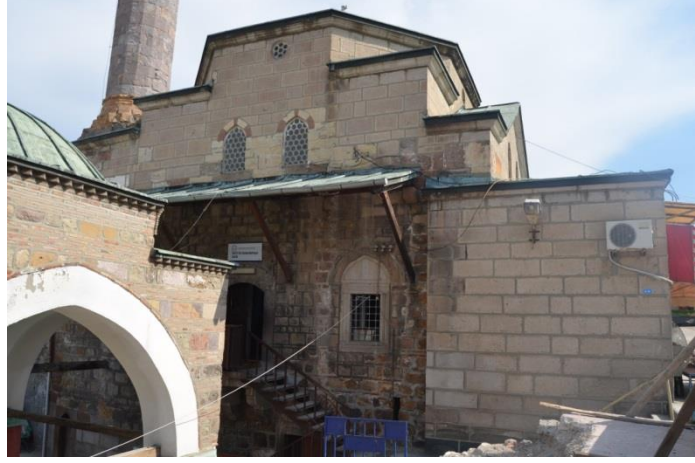
Resim 81. Taceddin İbrahim Camii, Caminin Kuzey Cephesi
