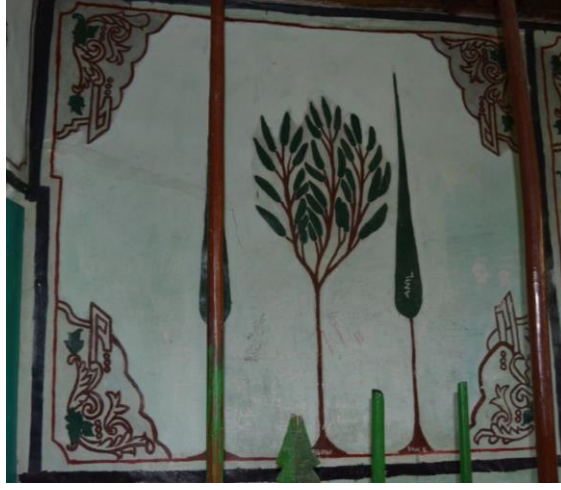
Resim 135. Pir Ali Bir Civan Türbesi, Doğu Duvardaki Ağaçlı Pano
