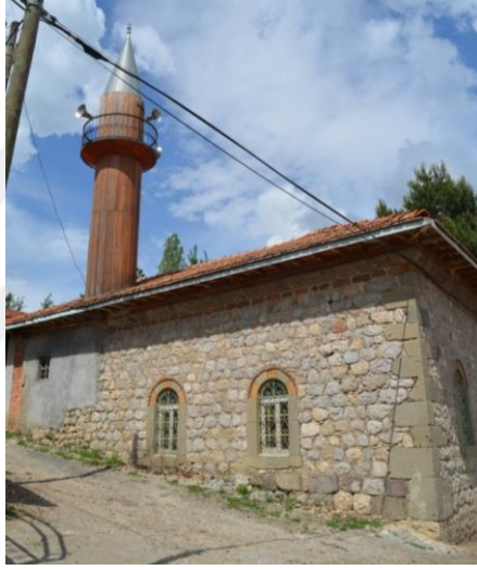
Resim 58. Kösele Köyü Camii, Caminin Batı Cephesi
