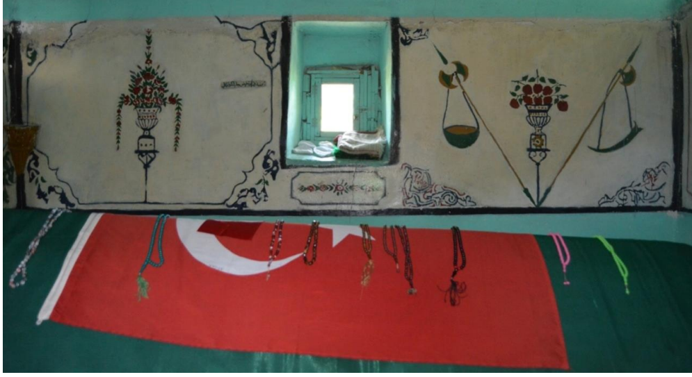
Resim 147. Rumi Hoca Türbesi, Kuzey Duvarı
