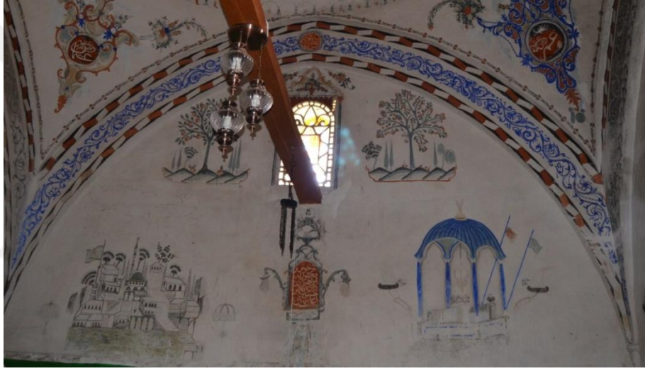
Resim 256. Şeyh Nusrettin Türbesi, Doğu Duvarı
