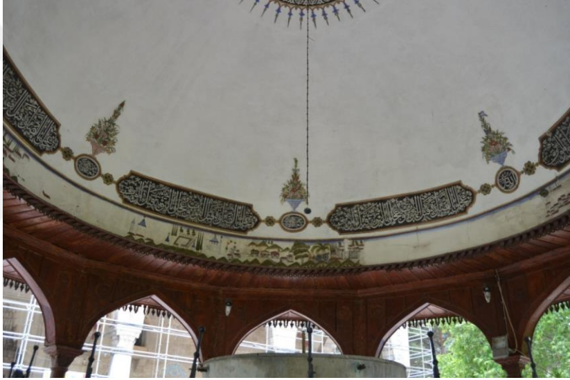
Resim 91. II. Beyazıt Külliyesi Camii Şadırvanı, Kubbede Yer Alan Duvar Resimleri
