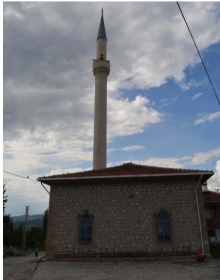
Resim 47. Çay Köyü Camii, Güney Cephesi
