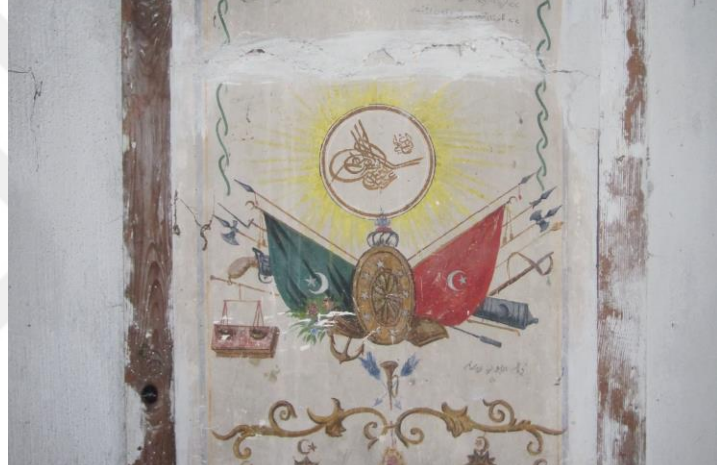
Resim 316. Kocaeli Derince Beş Divanlı Rıza Bey Konağı, Arma Tasviri Üzerinde Tuğra Tasviri (Çelik ve Kuyulu Ersoy, 2015)
