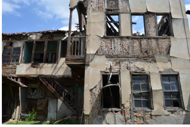
Resim 174. Özdarendeliler Konağı, Konağın Güney Cephesi
