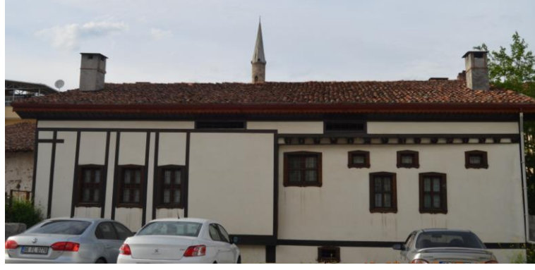
Resim 267. Madımağın Celal'in Evi, Evin Arka Cephesi
