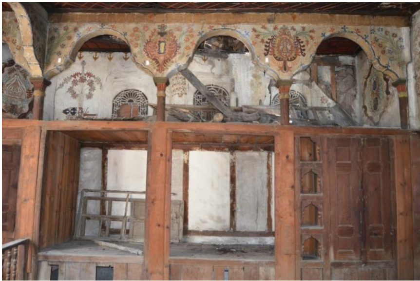
Resim 185. Özdarendeliler Konağı, Başodanın Güney Duvarı
