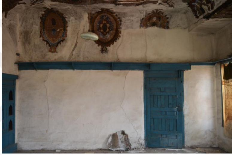
Resim 175. Özdarendeliler Konağı, Üst Kat Sofanın Kuzeydoğusundaki Odanın Batı Duvarı
