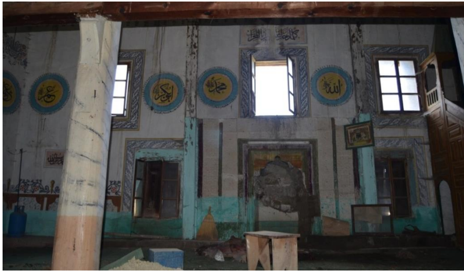
Resim 14. Kaleköyü Camii, Harimin Güney Duvarı
