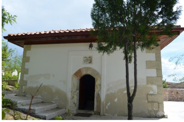
Resim 225. Şeyh Eylük Türbesi, Kuzey Cephesi
