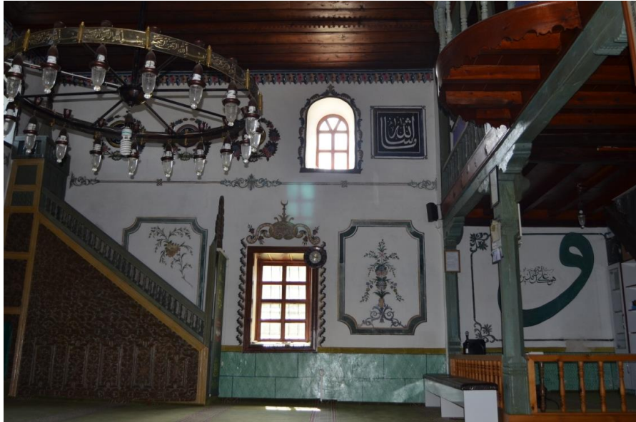
Resim 38. Aşağı Baraklı Camii, Batı Duvar
