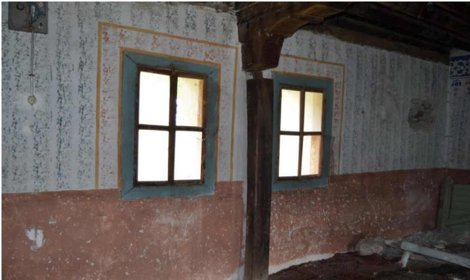
Resim 17. Kaleköyü Camii, Kuzey Duvarın Üst Kat Mahfil Kısmı
