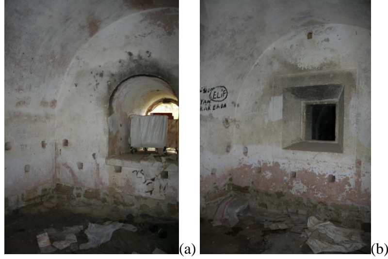
Şekil 5.13: (a) Z02 no'lu mekanda yer alan kemerli pencere açıklığı (b) Z02 no'lu mekânın Z03 no'lu mekân ile arasında yer alan havalandırma açıklığı.
