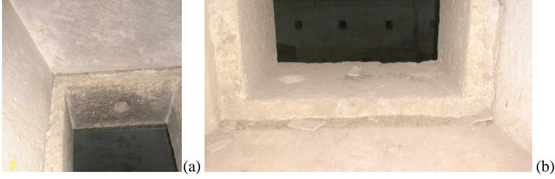
Şekil 5.8: (a) Havalandırma açıklığının tavanında yer alan dairesel havalandırma boşluğu (b) Açıklığın zemininde yer alan dairesel boşluk.
