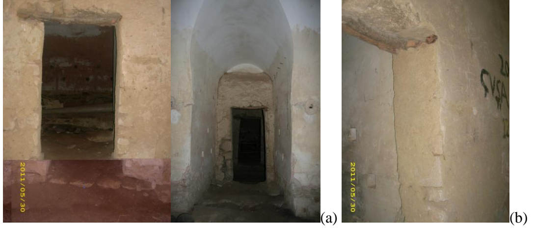
Şekil 5.32: (a)Z09 no'lu mekanın giriş kapısı (b) Kapı üzerinde yer alan ahşap lento detayı.
