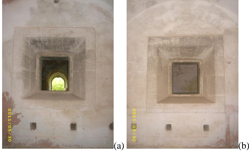
Şekil 5.34: Z09 no'lu mekanın, (a) Z07 no'lu cephane odası, (b) Z11 no'lu cephane sevkiyat koridoru ile arasında yer alan havalandırma açıklıkları.
