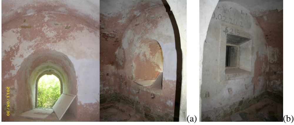
Şekil 5.26: (a)Z07 no'lu mekanda yer alan kemerli pencere açıklığı (b) Z07 no'lu mekanın Z08 no'lu mekan ile arasında yer alan havalandırma açıklığı.
