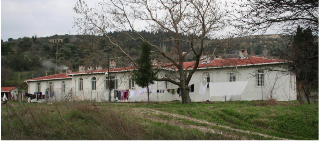
Şekil 5.70: Karargah binası güney cephesi görünüşü.
