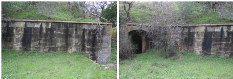
Şekil 5.47: Top yeri II, kendi içinde kırılarak iki duvar yüzeyinden oluşan Bonet III'ün bai duvarı ve cephane sevkiyat koridorundan top yerine açılankapı
