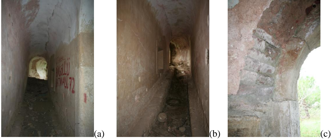
Şekil 5.40: Z11 no'lu mekanın, (a) top yeri II'ye, (b) top yeri I'e açılan cephane sevkiyat koridoru (c) top yeri I'e açılan koridorun tonozunda yer alan tuğla örgü detayı.
