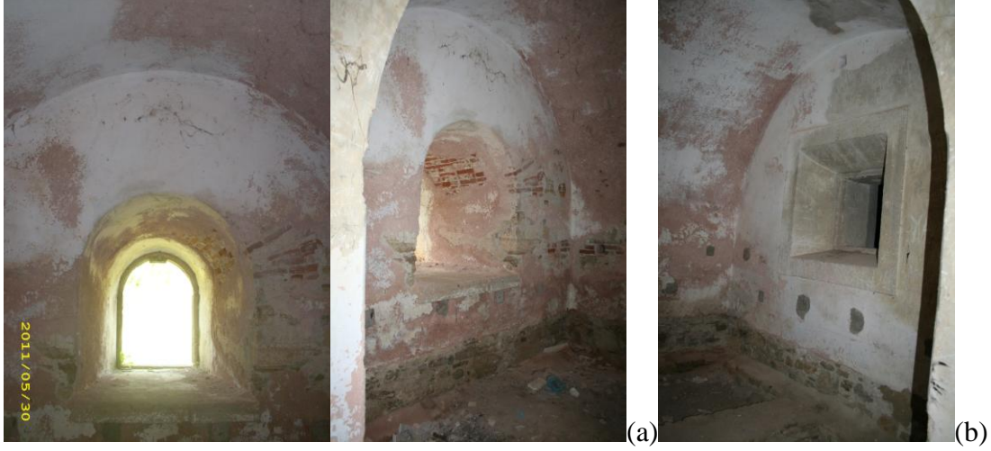
Şekil 5.30: (a)Z08 no'lu mekanda yer alan kemerli pencere açıklığı (b) Z09 no'lu mekan ile arasında yer alan havalandırma açıklığı.
