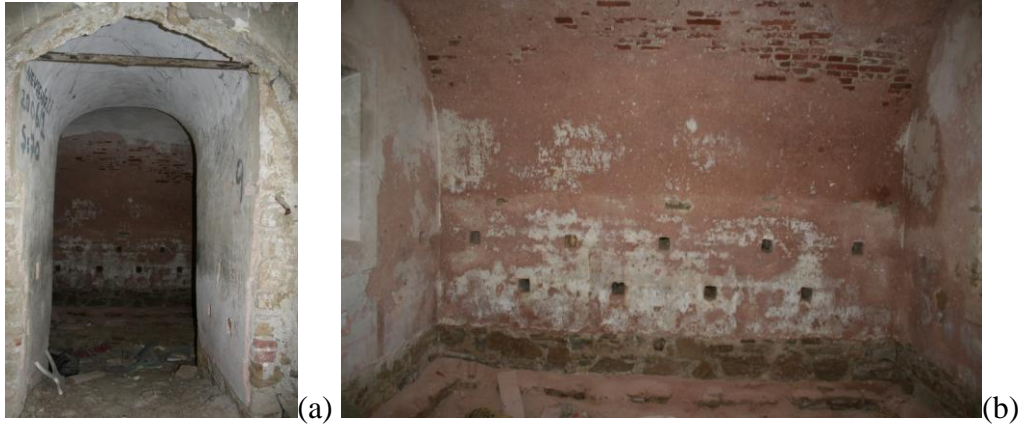
Şekil 5.25: (a)Z07 no'lu mekanın kapı açıklığı (b) Z07 no'lu cephaned odasının duvar sistemi.
