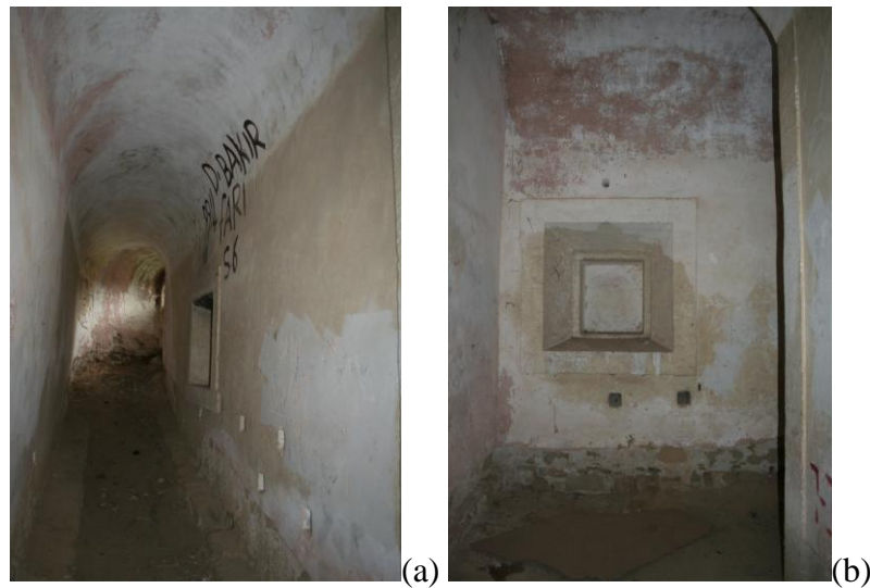
Şekil 5.17: (a)Z04 no'lu mekanın duvarında yer alan havalandırma nişi (b) Top yerine açılan cephane sevkiyat koridoru.
