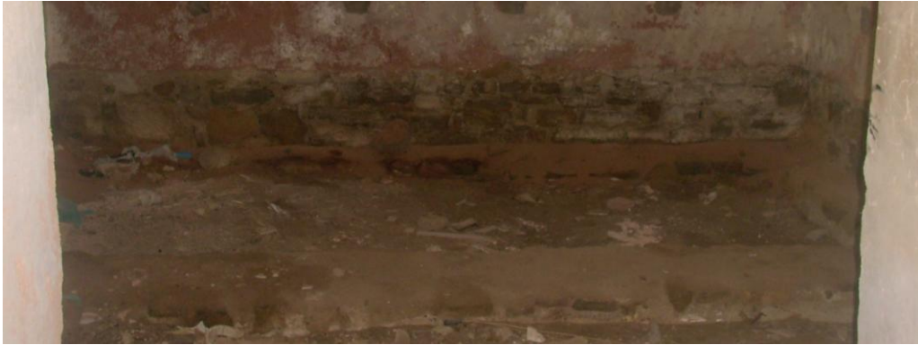
Şekil 5.31: Z08 no'lu mekanda döşemelerin oturduğu sekiler.
