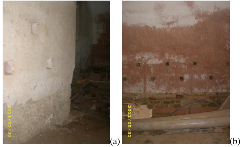
Şekil 5.33: (a)Z09 no'lu mekanın giriş sahanlığı (b) Z09 no'lu cephane odasının duvarlarında yer alan havalandırma boşlukları.
