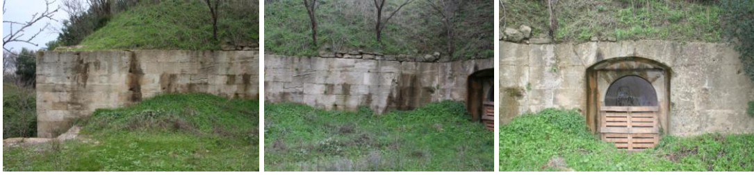
Şekil 5.21: Top Yeri I, kendi içinde kırılarak iki duvar yüzeyinden oluşan Bonet I'in batı duvarı ve cephane sevkiyat koridorundan top yerine açılan kapı.
