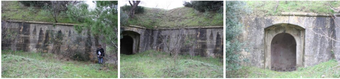
Şekil 5.22: Top Yeri I, kendi içinde kırılarak iki duvar yüzeyinden oluşan Bonet II'nin batı duvarı ve cephane sevkiyat koridorundan top yerine açılan kapı.
