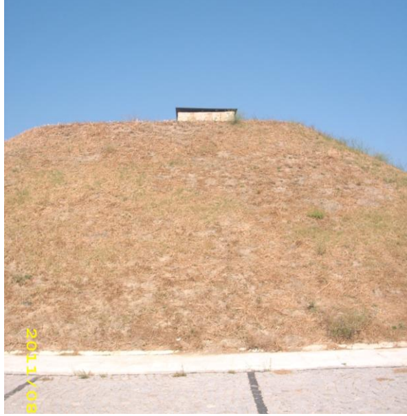
Şekil 5.59: Namazgah Tabyası, bonetler üzerinde yer alan havalandırma bacaları.
