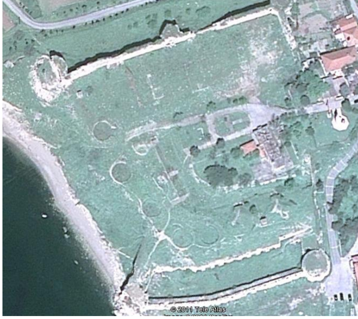
Şekil 4.16 : Seddülbahir Kalesi Tabyası (Google Earth, 2011).
