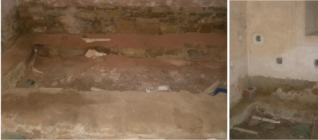
Şekil 5.39: Z10 no'lu mekanın döşemesinin oturduğu seki sistemi.
