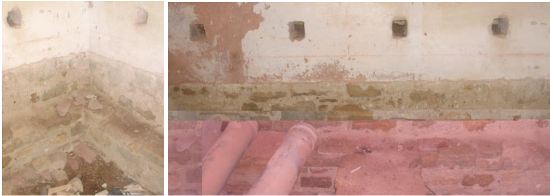
Şekil 5.35: Z09 no'lu mekan, döşemenin oturduğu seki sistemi.
