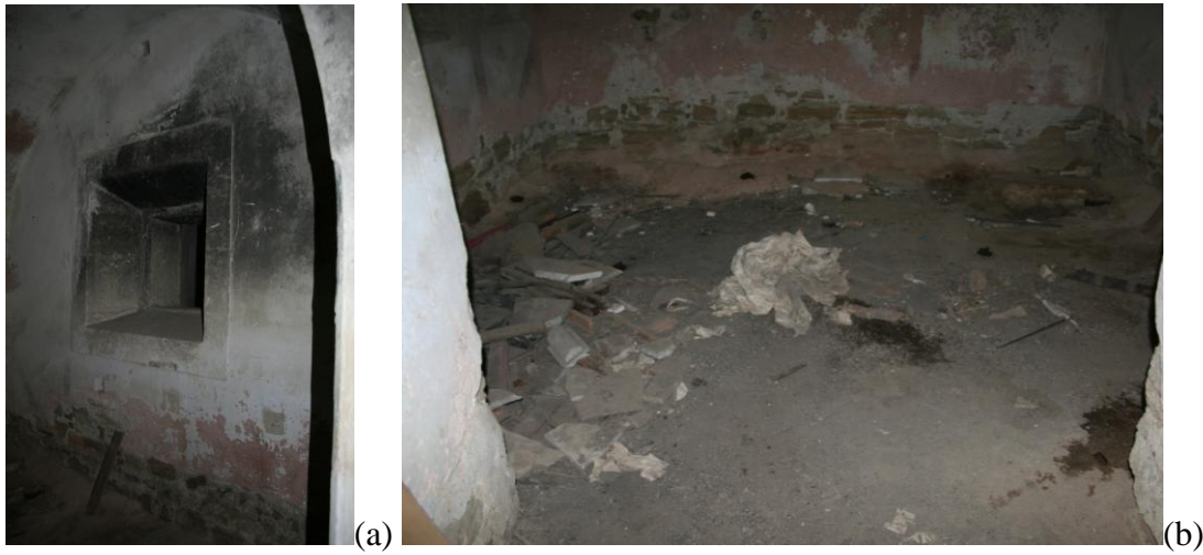
Şekil 5.16: (a) Z02 no'lu mekan ile arasında yer alan havalandırma açıklığı (b) duvar yüzeyinde okunan özgün döşeme kotu izi.
