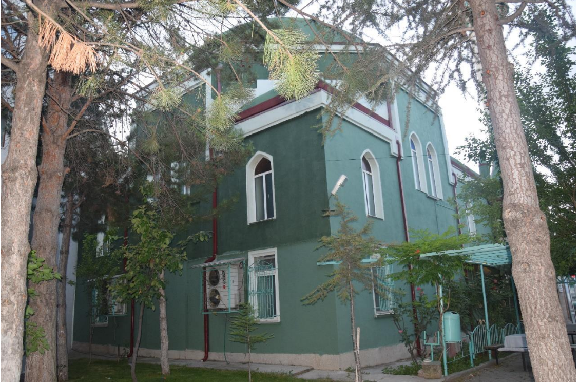
Fotoğraf 150: Eskişehir Şirintepe Cami, güneybatı cephe
