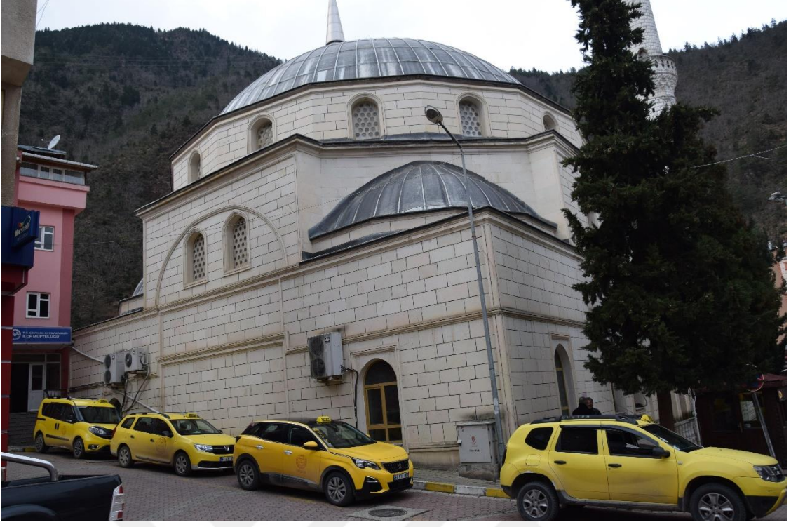
Fotoğraf 337: Çaykara Merkez Cami, güney cephe
