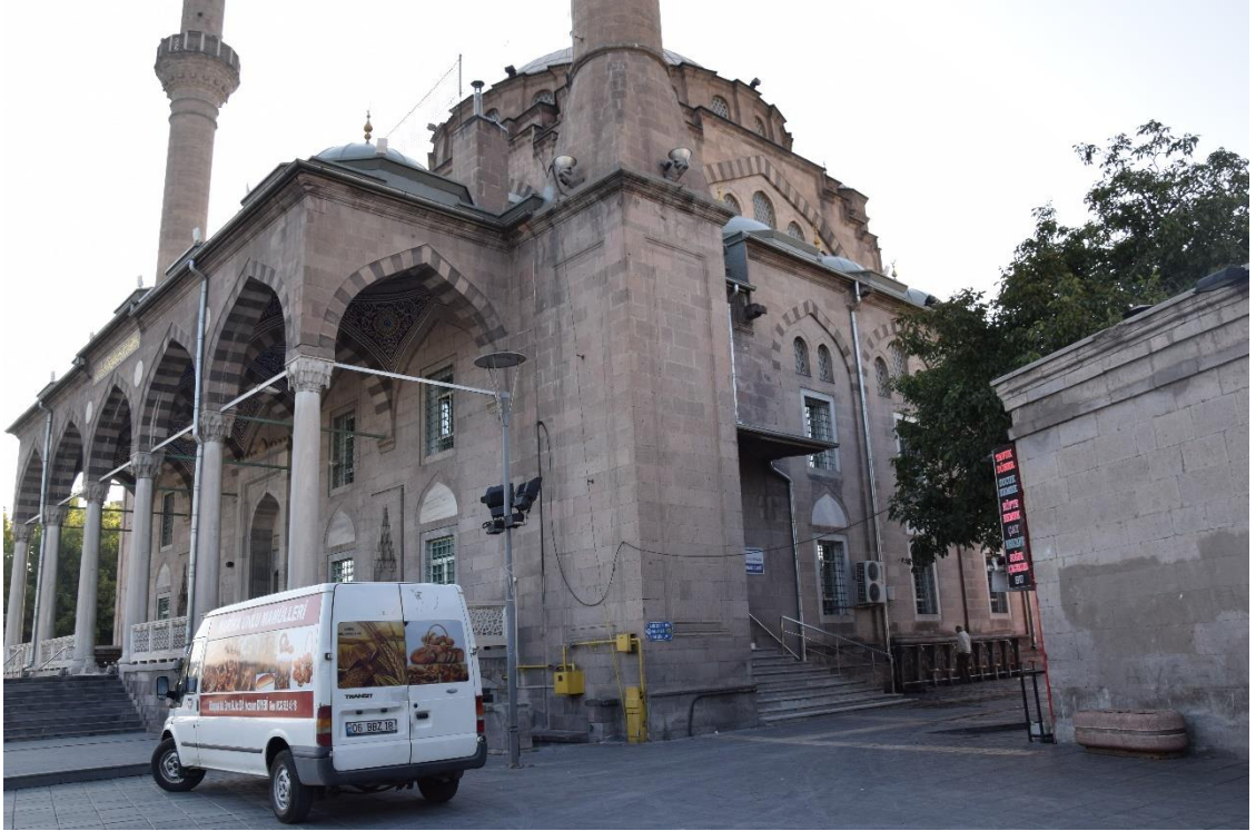
Fotoğraf 352: Kayseri Biringüz Cami, batı cephe
