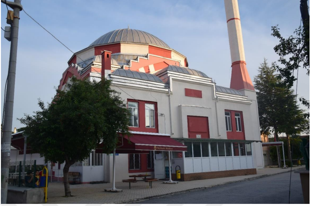
Fotoğraf 58: Eskişehir Sümer Mahallesi Cami, genel görünüş
