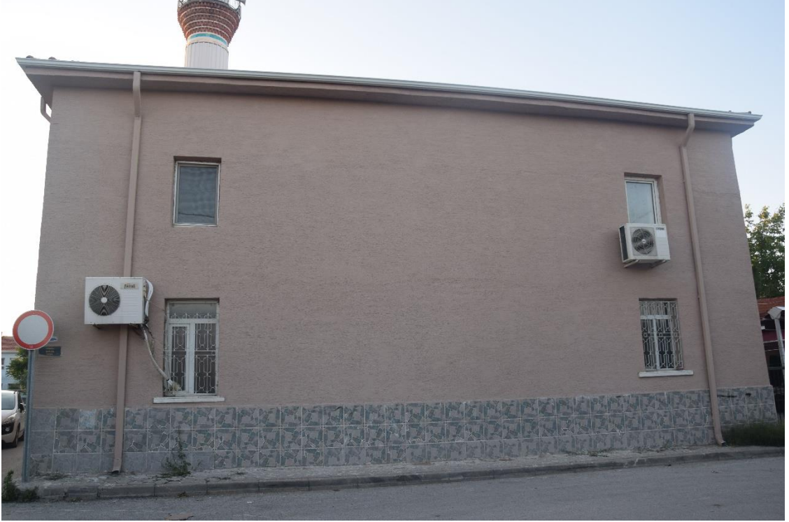
Fotoğraf 195: Eskişehir Gündoğmuş Cami, güney cephe
