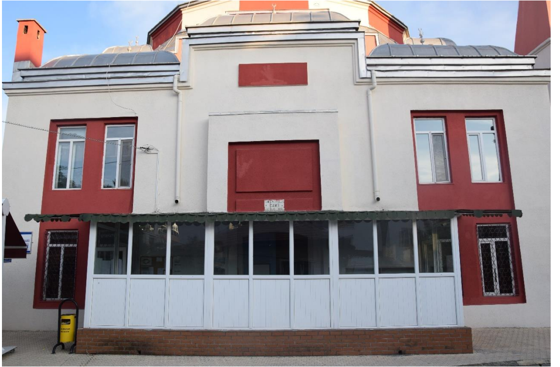
Fotoğraf 59: Eskişehir Sümer Mahallesi Cami, kuzey cephe
