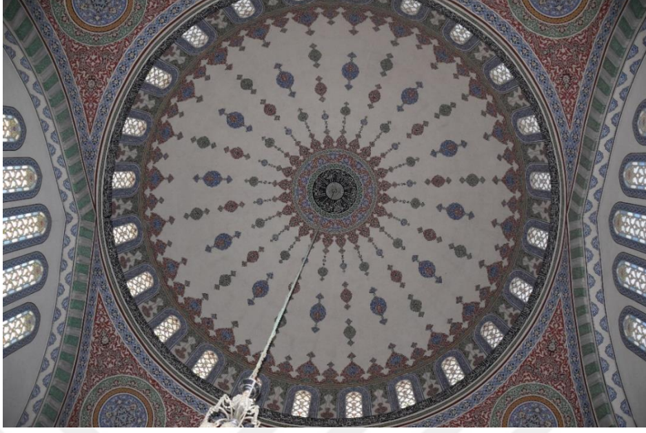
Fotoğraf 236: Eskişehir Reşadiye Cami, kubbe
