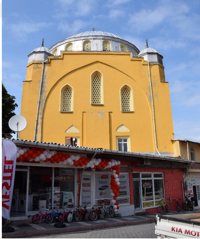
Fotoğraf 267: Domaniç Alaaddin Cami, güney cephe
