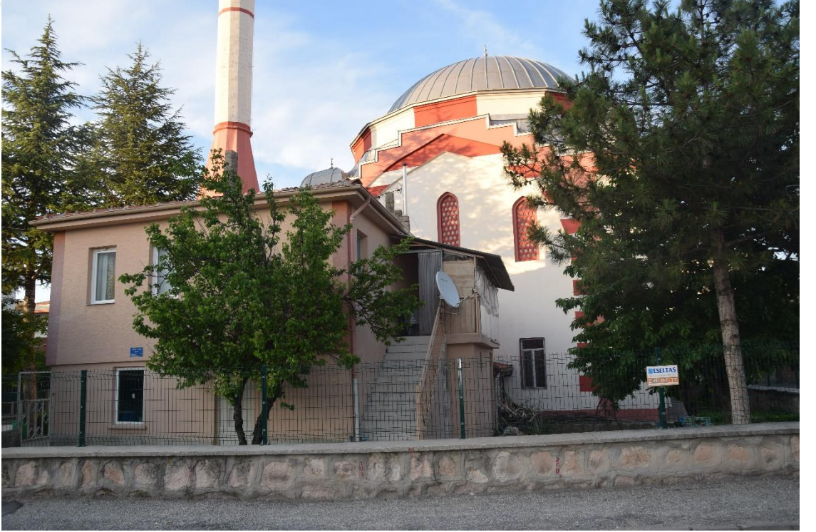
Fotoğraf 61: Eskişehir Sümer Mahallesi Cami, batı cephe
