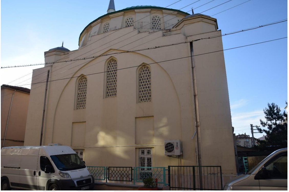
Fotoğraf 74: Eskişehir Gökmeşdan Cami, güney cephe
