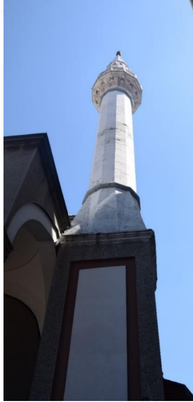
Fotoğraf 164: Bozüyük Kasımpaşa Mahallesi Orta Cami, minare
