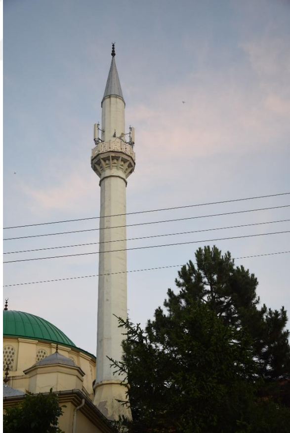
Fotoğraf 81: Eskişehir Gökmeşdan Cami, minare
