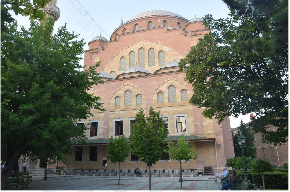
Fotoğraf 230: Eskişehir Reşadiye Cami, batı cephe
