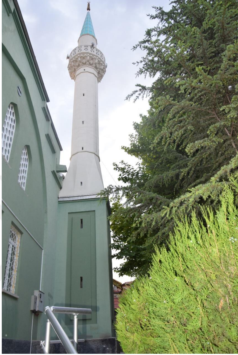
Fotoğraf 91: Eskişehir Orhangazi Cami, minare
