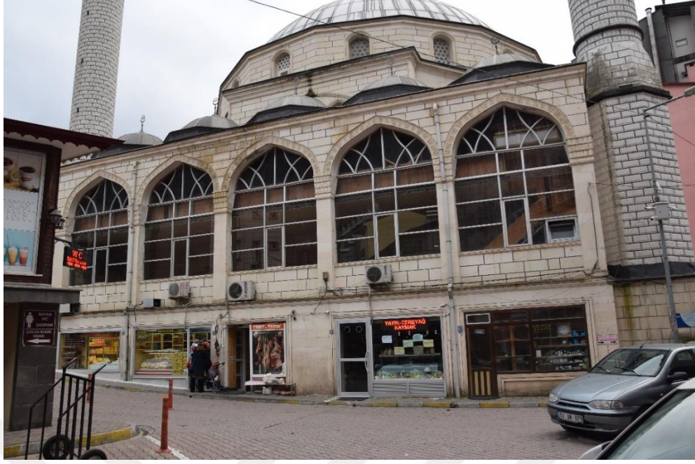
Fotoğraf 333: Çaykara Merkez Cami, kuzey cephe
