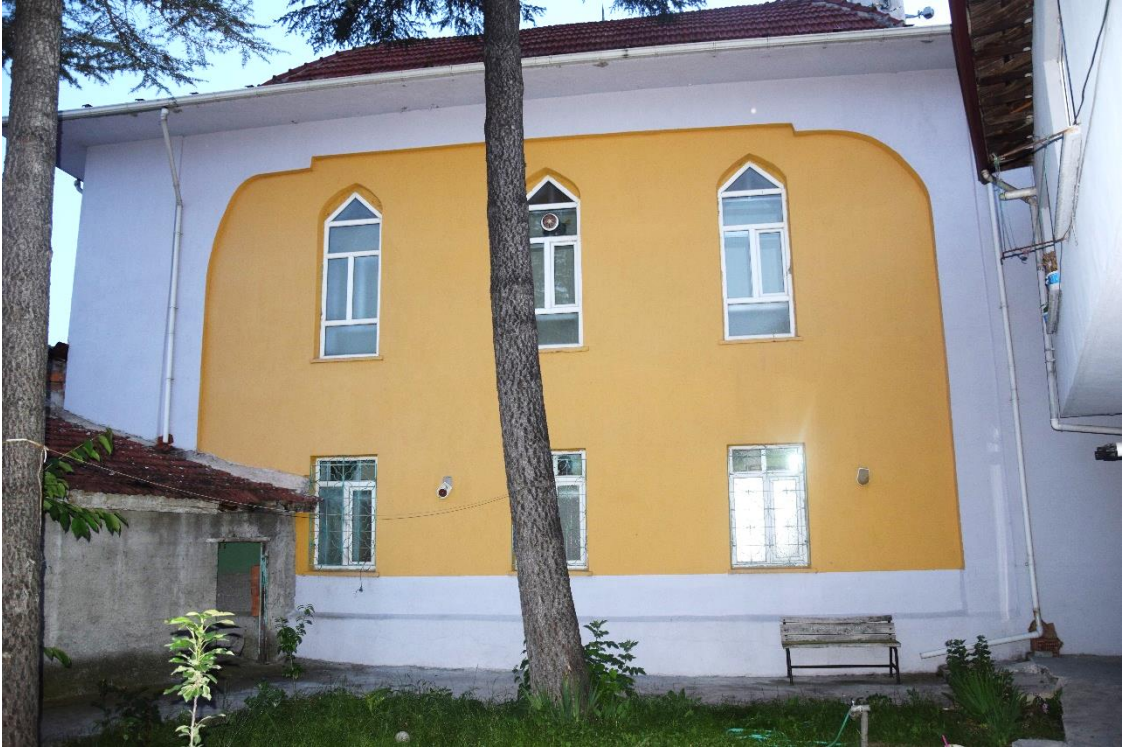
Fotoğraf 189: Eskişehir Esentepe Ulu Cami, doğu cephe
