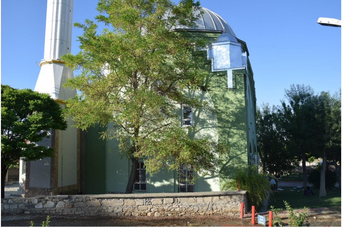
Fotoğraf 311: Ilgın Kaplıca Cami, batı cephe
