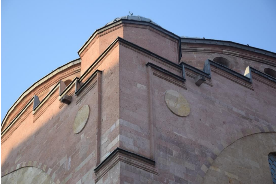
Fotoğraf 233: Eskişehir Reşadiye Cami, korniş tasarımı
