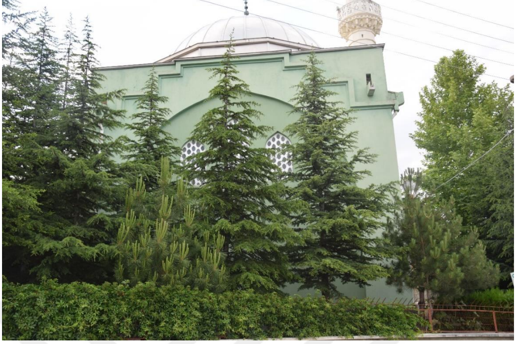
Fotoğraf 85: Eskişehir Orhangazi Cami, güney cephe
