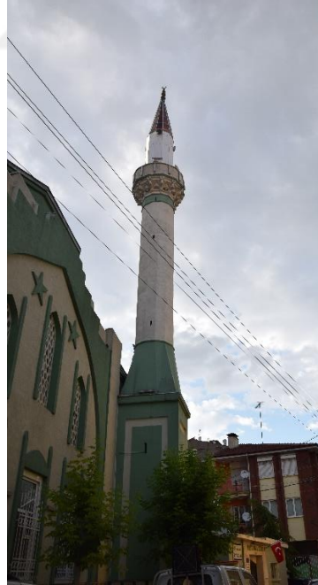
Fotoğraf 102: Eskişehir Seyit Hoca Cami, minare
