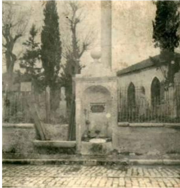
ekil 4.132 : Bahçe Duvarı, Dışarıdan Cami ve Çeşmenin Görünümü (Encümen Arşivi, tarihsiz).
