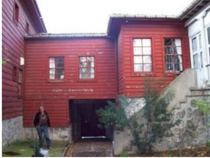
ekil 4.158 : Orta Bahçeden Giriş Kapısının Görünümü (KTVKK Arşivi, tarihsiz).
