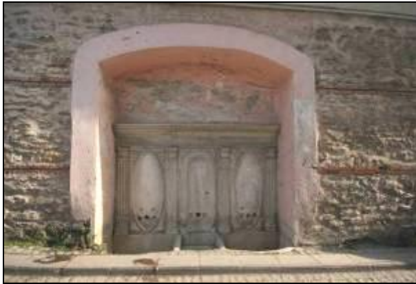
ekil 4.189 : Bahçe Duvar, Üzerinde Yeralan Çe me (2008).
