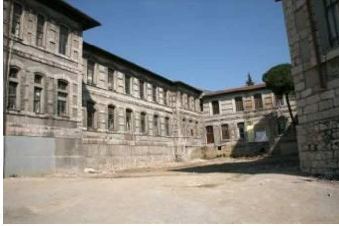
ekil 4.331 : Yapı,ın Güney Yönünden Görünüşü (2009).
