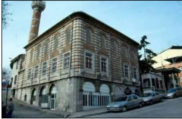
ekil 4.38 : Bodrum Dükkanlar, ve Mihrap Cephesi (2006).
