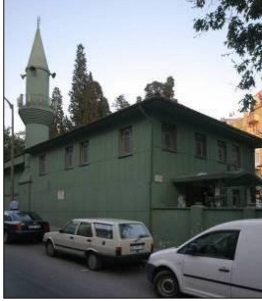
ekil 4.49 : Caminin Yoldan Görünü ü (2008).
