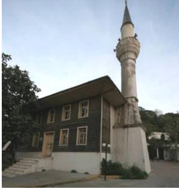
ekil 4.86 : Caminin Giri Cephesi Görünü ü (2007).
