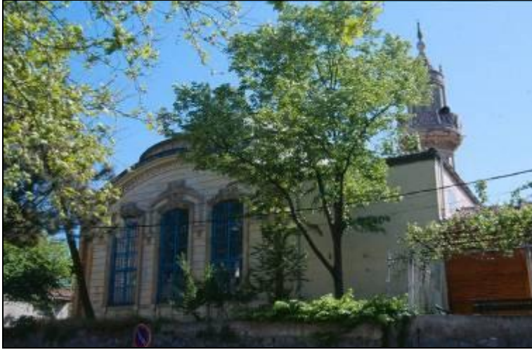
ekil 4.83 : Cevri Kalfa Camisinin Yoldan Görünü ü (2008).
