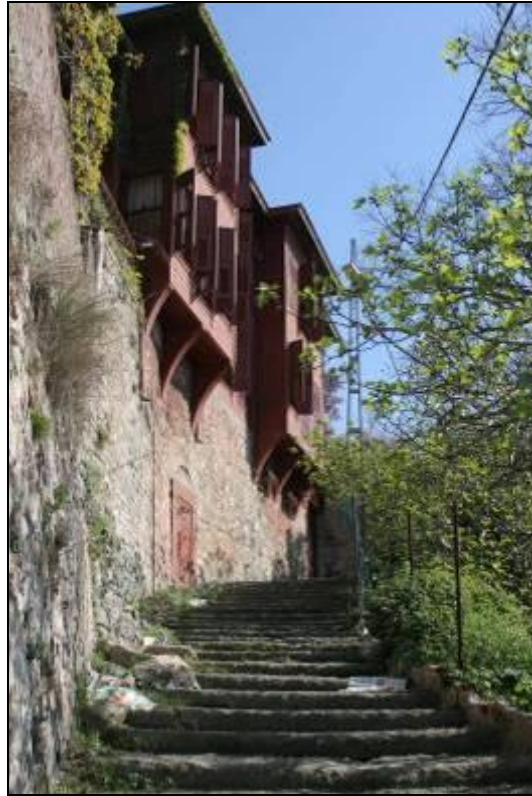
ekil 4.380 : Merdivenli Sokaktan Harem Bölümü (2007).
