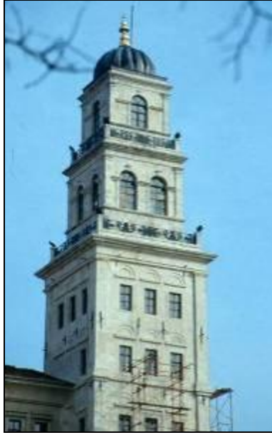
ekil 4.322 : Kulesi'nin Kulelerinden Detay (2006).
