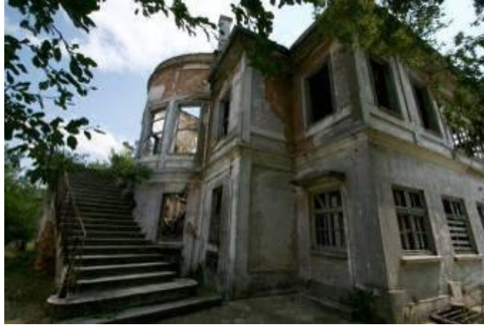
ekil 4.362 : Yapı, D, Görünüü (2008).
