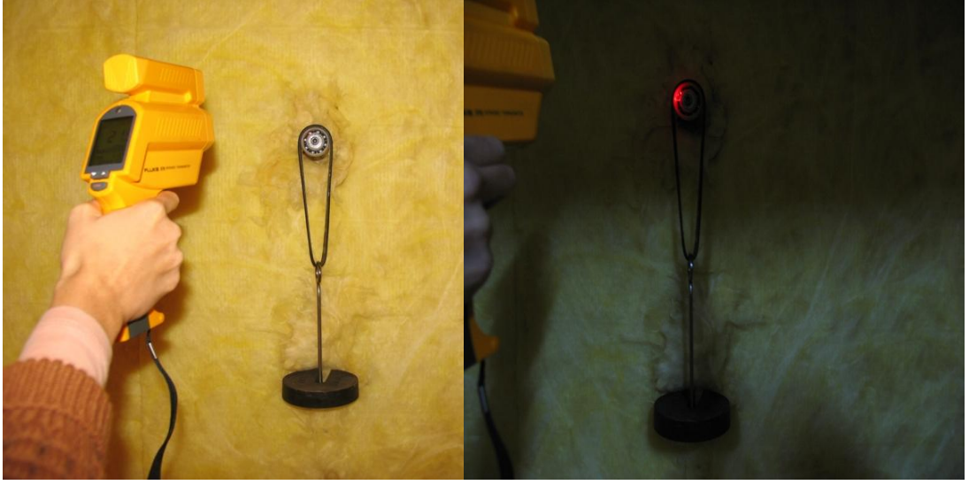
Şekil 6.6 : FLUKE marka kızılötesi termometre ile sıcaklık ölçümü.
