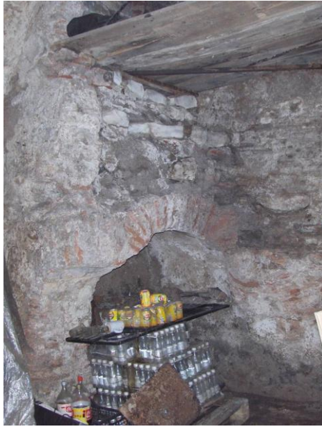
Şekil D.40 : 44 numaralı kârgir yapının bodrum katındaki kemer.
