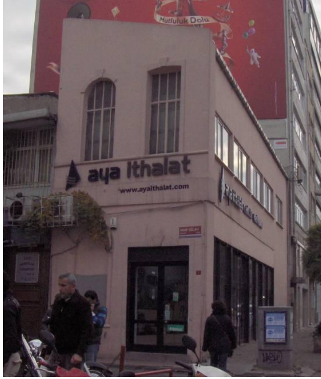
Şekil A.13 : Kemeraltı Caddesi'ni genişletme çalışmalarıyla ortadan bölünen bina ve iki cephesinde farklı pencereler.
