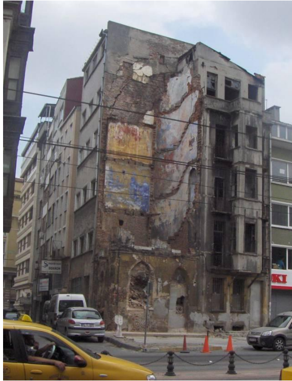
Şekil D.2 : 3 ve 4 numaralı tescilli yapıların (120 ada 8 ve 9 parseller) fotoğrafı.
