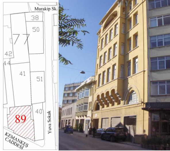
Şekil 3.170 : Env. 89'un konumu ve mevcut durum fotoğrafı.
