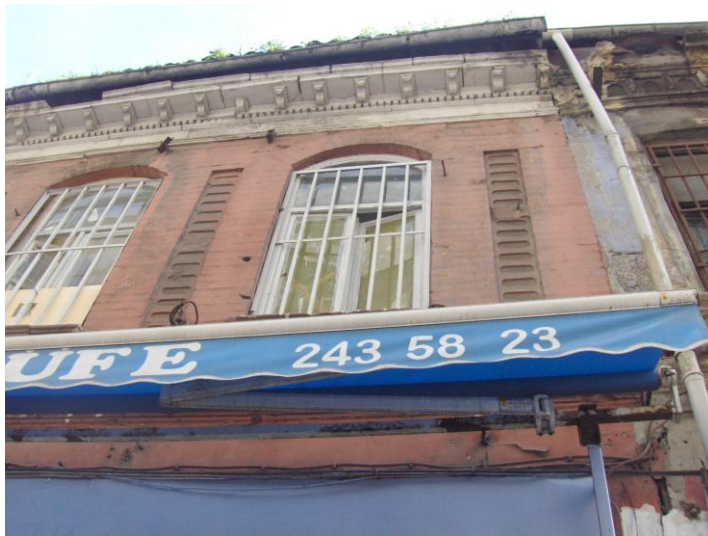
Şekil D.52 : 59 numaralı yapılardan 72 ada 13 parseldeki tescilli yapı.
