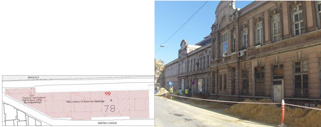
Şekil 3.189 : Env. 99'un konumu ve mevcut durum fotoğrafı.
