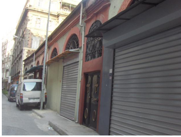
Şekil D.22 : 35 numaralı (82 ada 7, 8, 14 parsellerdeki) Hoca Tahsin Sokağı üzerindeki Aya Nikola Türk-Ortodoks Kilisesi dükânları ve kapısı.
