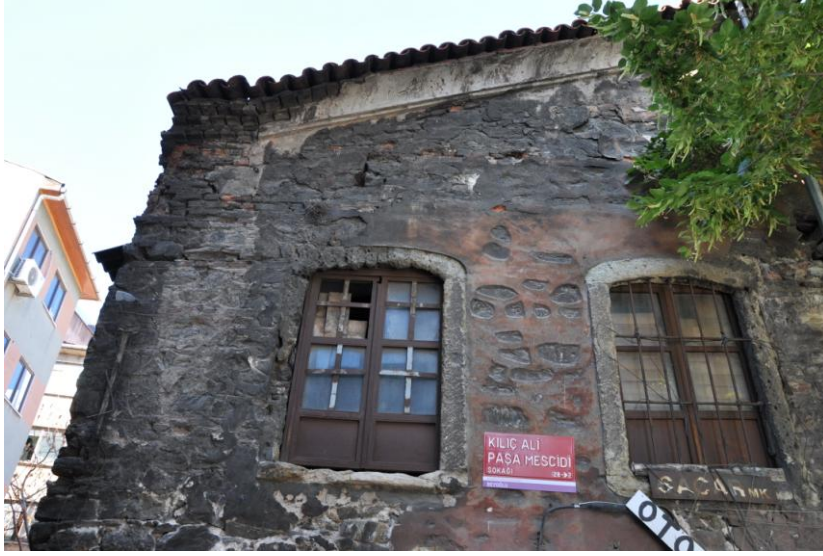
Şekil D.88 : 95 numaralı (68 ada 7 parseldeki) tescilli yapıdan detay.
