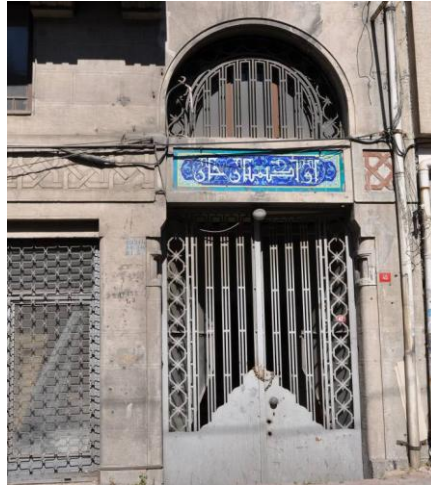
Şekil D.70 : 79 numaralı Hovagimyan Han'ın giriş kapısından detay. Fotoğrafın sağında sıvası dökülmüş ve tuğlası açığa çıkmış, solunda sıvalı süslemeler.
