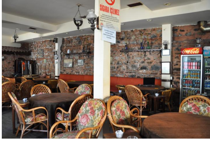
Şekil D.85 : 90 numaralı tescilli yapının içine inşa edilmiş betonarme kolon-kiriş sistemi.
