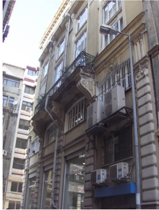
Şekil D.14 : 25 numaralı (84 ada 2 parseldeki) tescilli yapı.
