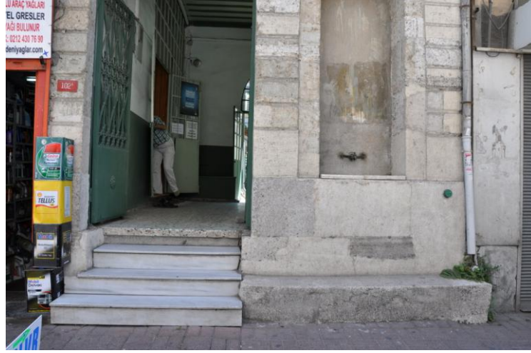
Şekil D.48 : 57 numaralı Bayezid-i Cedid Camii'ne giriş kapısına çıkan dört basamak ve sağda eski çeşmenin yeri.
