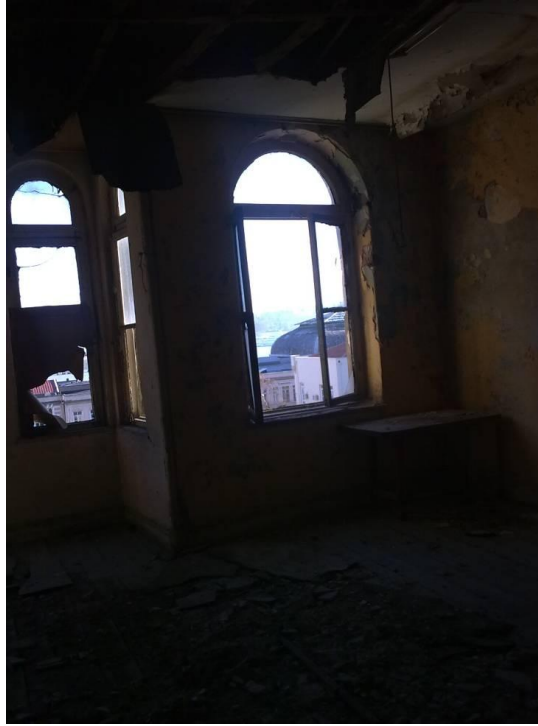
Şekil D.61 : 64 numaralı yapının harap iç mekânı.
