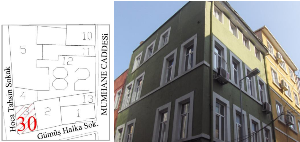
Şekil 3.68 : Env. 30'un konumu ve mevcut durum fotoğrafı.
