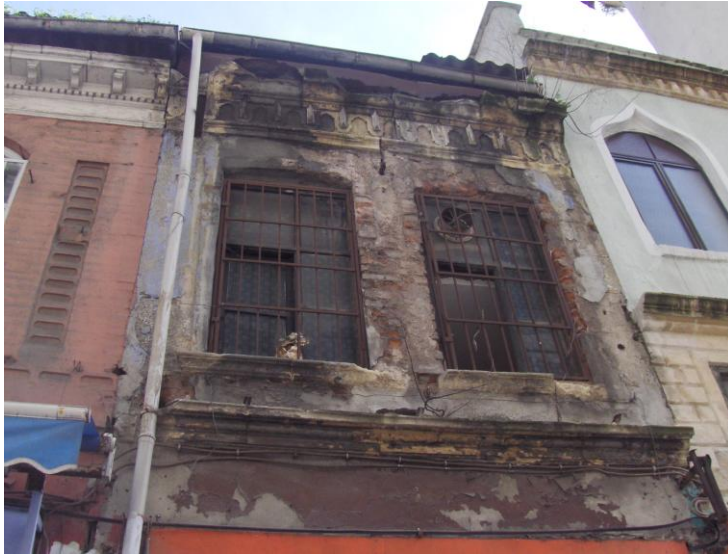
Şekil D.51 : 59 numaralı yapılardan 72 ada 12 parseldeki tescilli yapı.
