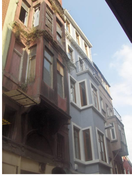
Şekil D.44 : 51 (soldaki) ve 52 (sağdaki) numaralı (74 ada 5 ve 4 parsellerdeki) tescilli yapılar.
