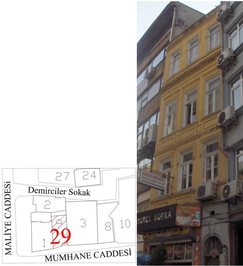
Şekil 3.65 : Env. 29'un konumu ve mevcut durum fotoğrafı.
