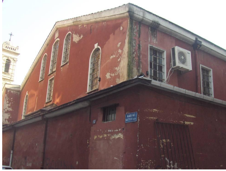
Şekil D.53 : 61 numaralı Merkez Meryem Ana Kilisesi'nin Kara Ali Kaptan Sokağı cephesi.
