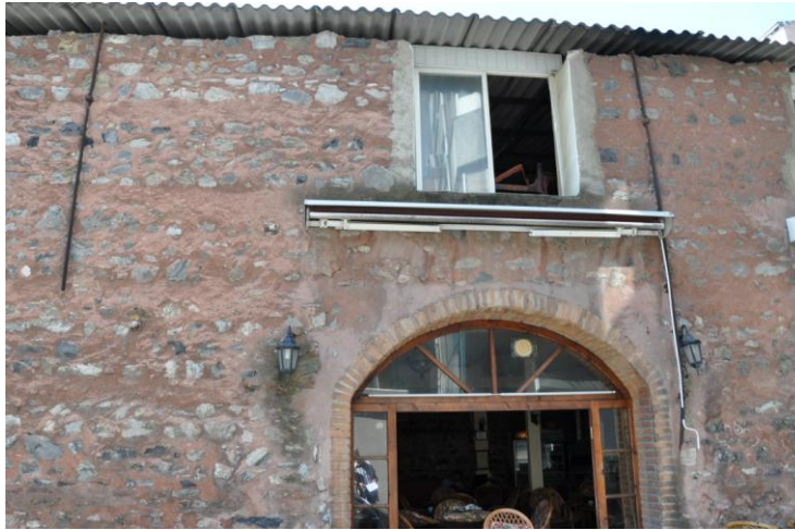
Şekil D.84 : 90 numaralı (77 ada 51 parseldeki) tescilli yapı.
