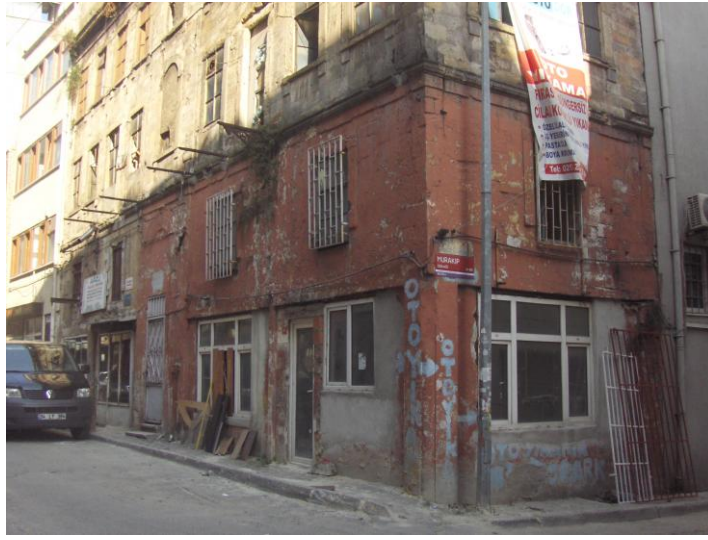
Şekil D.86 : 91 numaralı (68 ada 16 parseldeki) tescilli yapı.
