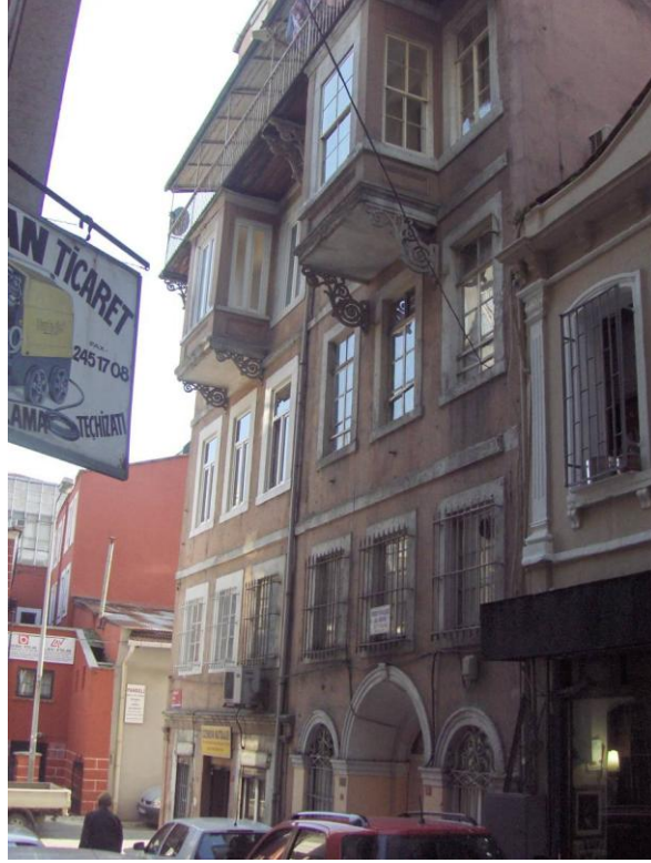
Şekil D.10 : 18 numaralı (86 ada 21 parseldeki) tescilli yapı.
