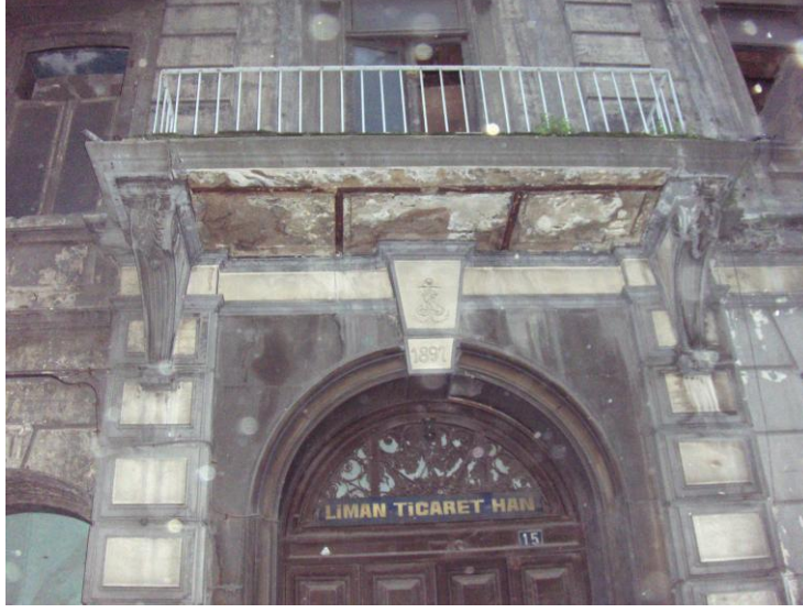
Şekil D.66 : Liman Han'ın giriş kapısı üzerinde binanın yapım tarihi ve gemici çıpası.
