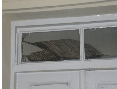
Şekil D.28 : Aya Andrea Rus Kilisesi üst katındaki konaklama birimlerinin tavanındaki bağdadi çıtalar.
