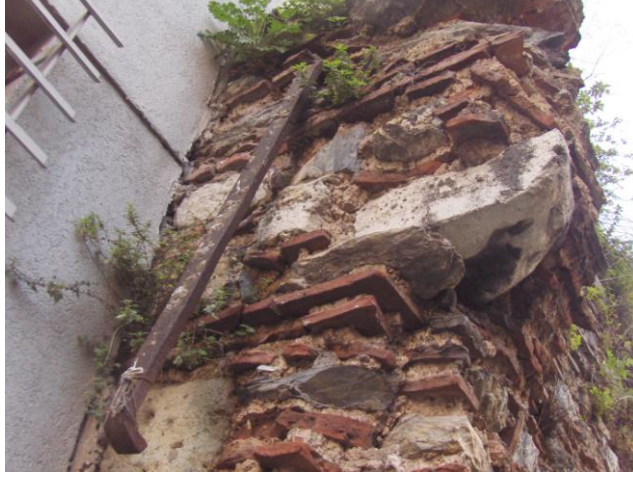
Şekil D.82 : 87 numaralı (77 ada 34 parseldeki) kalıntının güneydoğu duvarından çekilen bir detay.
