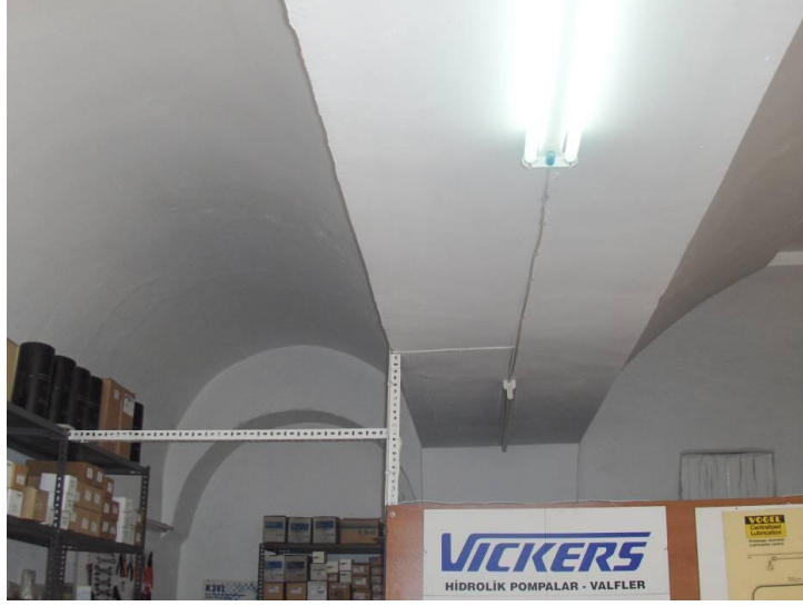
Şekil D.7 : 8 numaralı Vekilharç Sokağı üzerindeki dükkânın beşik tonoz (solda) ve tekne tonozdan (sağda) oluşmuş tuğla duvarlı iç mekânı.
