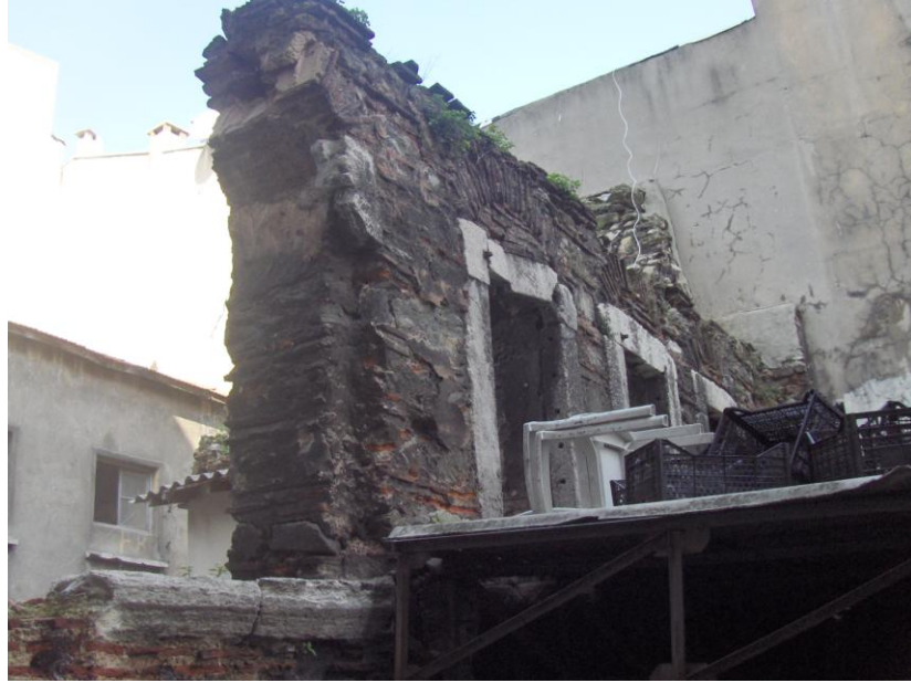
Şekil D.81 : 87 numaralı (77 ada 34 parseldeki) kalıntının bahçeye bakan (güneydoğu) duvarı.
