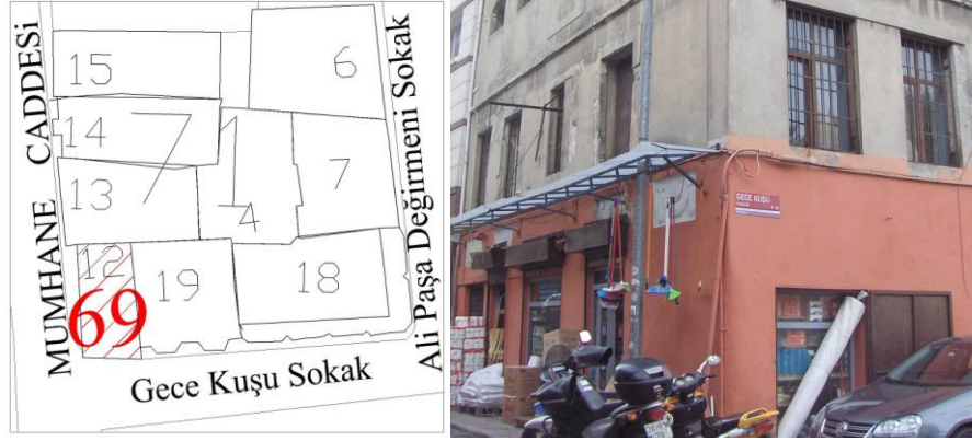
Şekil 3.137 : Env. 69'un konumu ve mevcut durum fotoğrafı.
