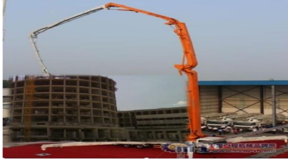
Şekil 9.5 : Yüksek katlı yapıların yapım aşaması ve betonun dökülmesi.
