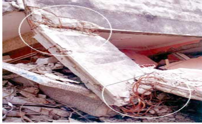
Şekil 10.10 : Hatalı perde tasarımı [53].
