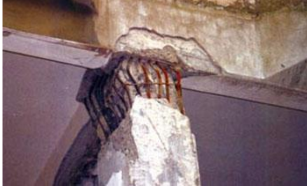
Şekil 10.5 : Etriye sıkılaştırılmasının yetersiz kalması [57].
