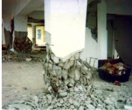
Şekil 10.7 : Etriye sıkılaştırılmasının yetersiz kalması [57].
