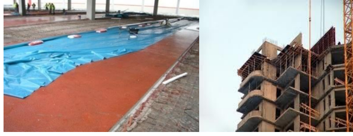
Şekil 9.3 : Yüksek katlı yapıların yapım aşaması ve betonun prizini alması
