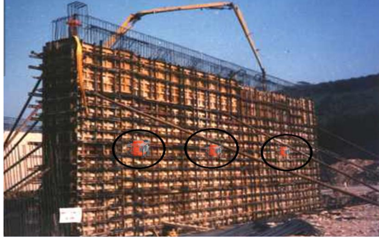
Şekil 10.2 : Kalıp dışında betonun yerleşmesi için vibratörler.
