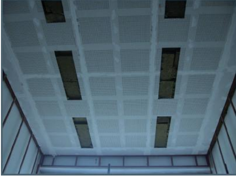
Şekil 5.6 : Asma tavana döşenen akustik alçı levhalar.
