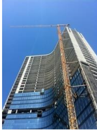
Şekil 6.2: Risk Değerlendirmesinin yapıldığı kule vinç.
