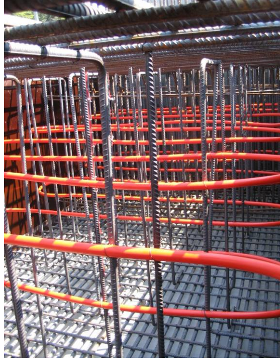
Şekil 2.13 : Döküm sonrası soğutma sistemi (soğutma boruları).
