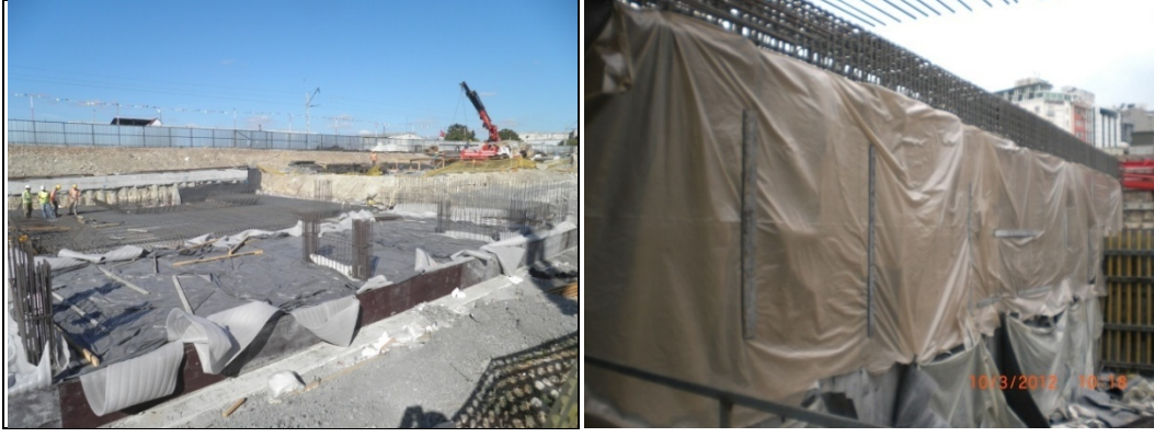
Şekil 2.12 : Beton yüzeylerin ısı örtüleri (sol) ve naylon (sağ) ile kürlenmesi.
