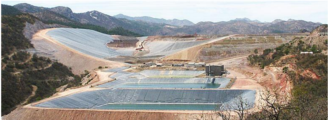
Şekil 2.10 : Bakır cevherine yığın liçi yapan bir tesisin görünümü [24].
