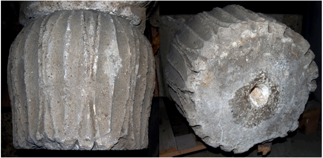
Şekil 4.56 : Yaprak dizili sütun elemanının(a) mevcut durumu ve (b) alt yüzü (M. Arseven, 2012).
