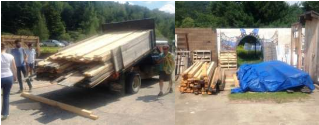
Şekil 4.22 : Malzemelerin kampüse gelişi ve boyutlarına göre istiflenmesi.
