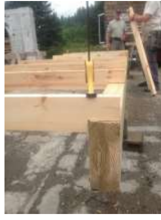
Şekil 4.24 : Ahşabın işlenme aşamaları ve taban kirişlerinin oluşturulması.
