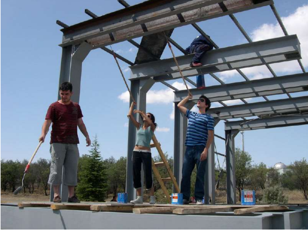
Şekil 3.3 : ODTÜ'lü öğrenciler metro durağı projesi yapımında çalışırken (Url-1).
