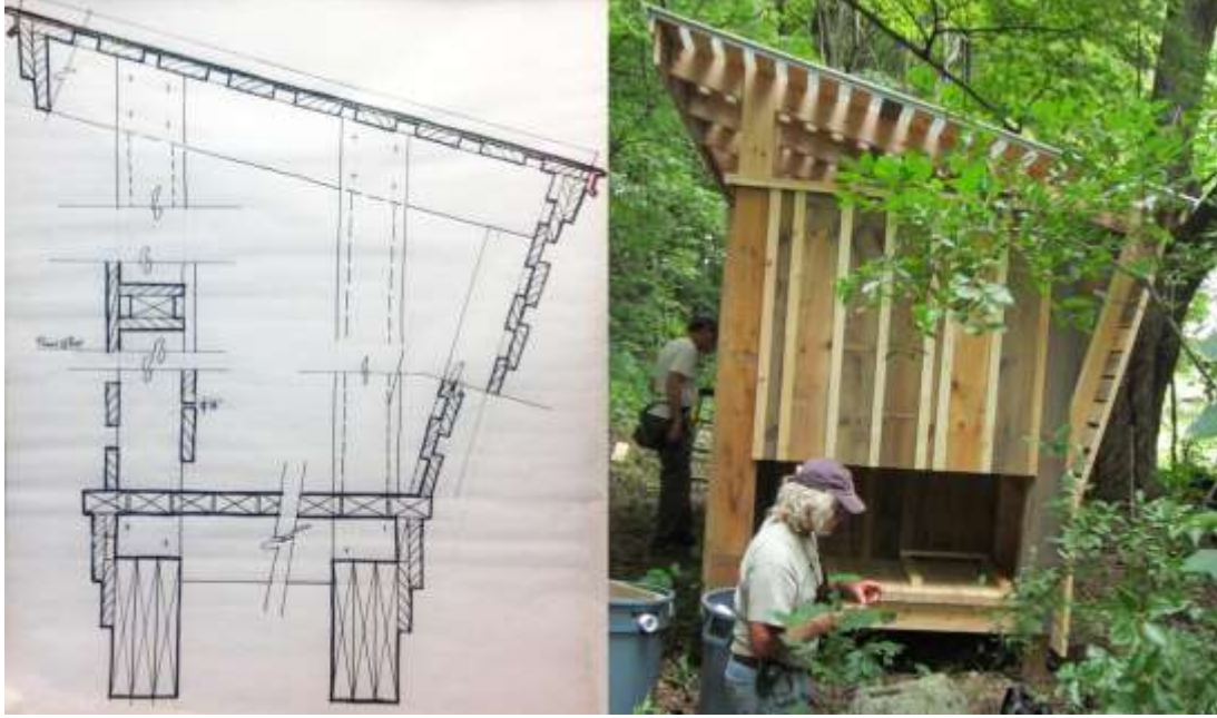
Şekil 4.25 : Kompost tuvalet kesit çizimi ve uygulaması.
