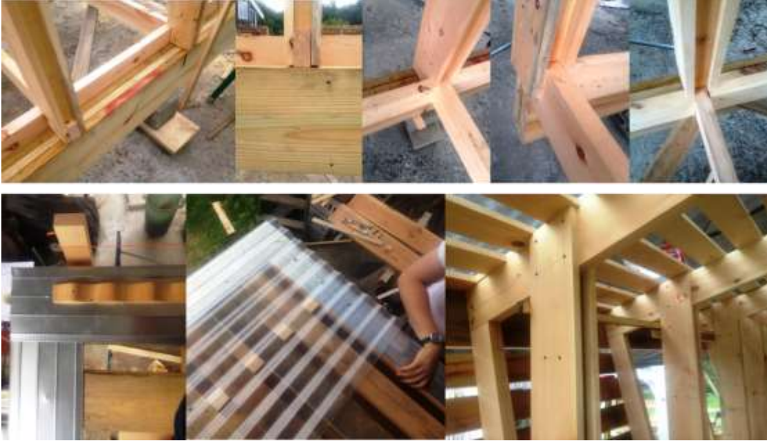
Şekil 4.19 : Birleşim detayları.
