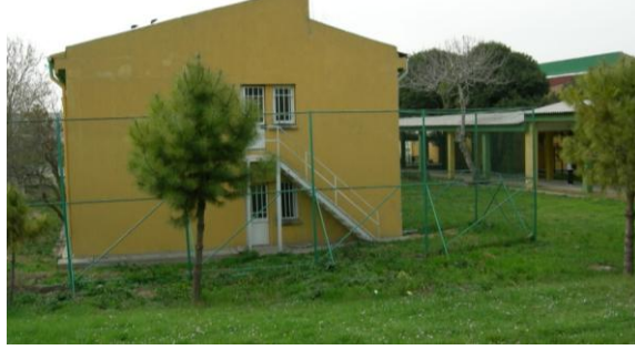
Şekil 4.16 : BRSHH - K Blok - Dış Mekan.
