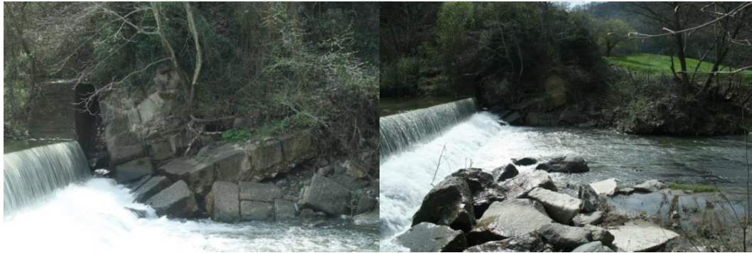
Şekil 5.142 : Söz konusu güzergâh üzerinde, Şekil 5.141'deki haritada 3 numaralı noktada tespit edilen köprü kalıntısı.
