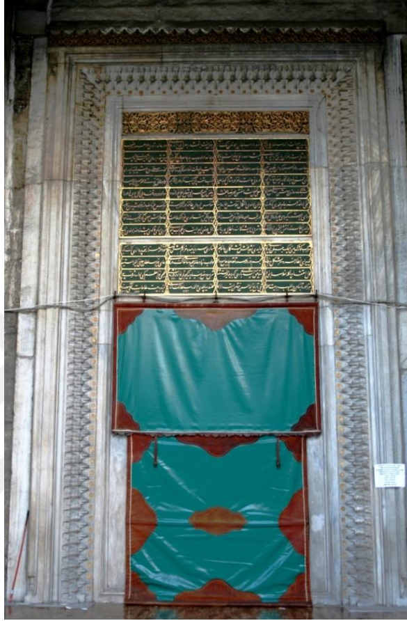
Şekil 5.189 : Caminin cümle kapısı.
