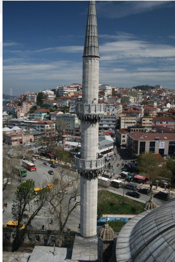
Şekil 5.186 : Caminin kuzeydoğudaki minaresi.
