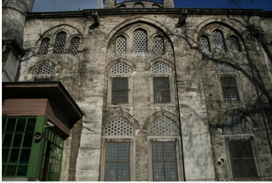
Şekil 5.180 : Caminin güneybatı cephesi.
