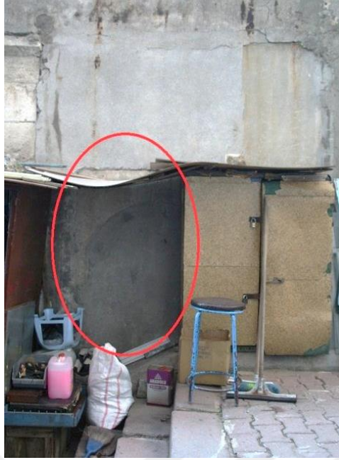
Şekil 5.91 : Galata Yeni Cami avlusunun doğu duvarındaki tali kapının izi.
