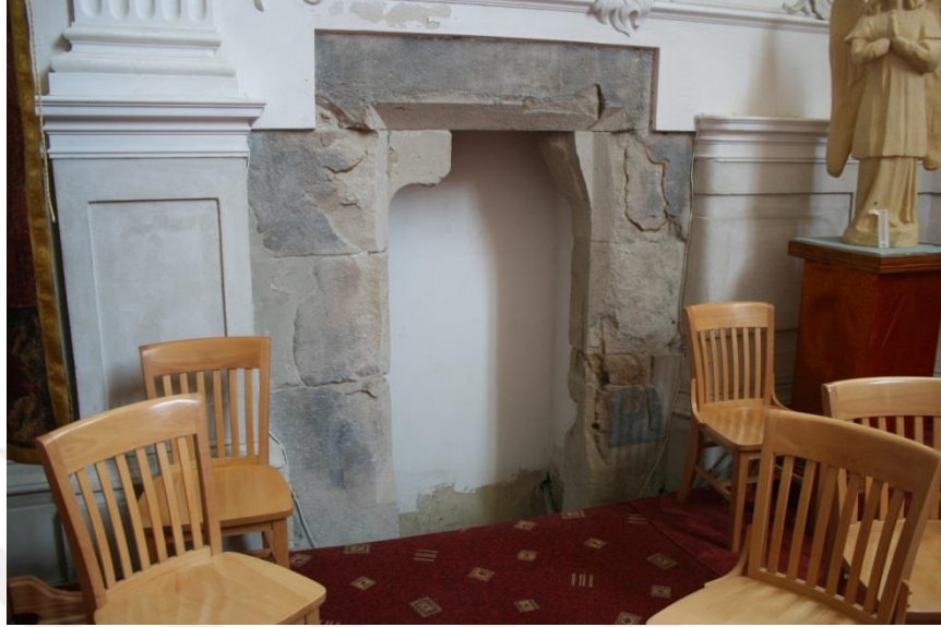
Şekil 5.20 : Koro bölümünün kuzey duvarında ve apsise yakın konumda yer alan sonradan kapatılmış kapı.
