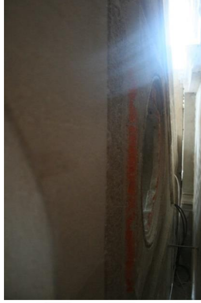
Şekil 5.26 : Minberin duvara dönük taraftaki aynalıği üzerinde görülen kırmızı renkli özgün boya kalıntıları.
