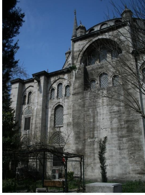
Şekil 5.183 : Caminin haziresinden kible cephesine bakış.
