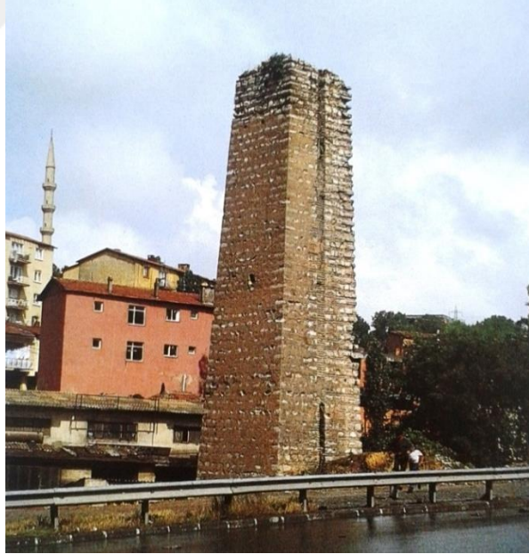
Şekil 5.127 : Piyalepaşa Bulvarı üzerinde yer alan ve Kâzım Çeçen’in “Kasımpaşa’da Taksim suyuna ait olmayan su terazisi” dediği Gülnuş Sultan’ın Galata su yollarına ait olabilecek su terazisi, (Çeçen, 1991b, s.86).
