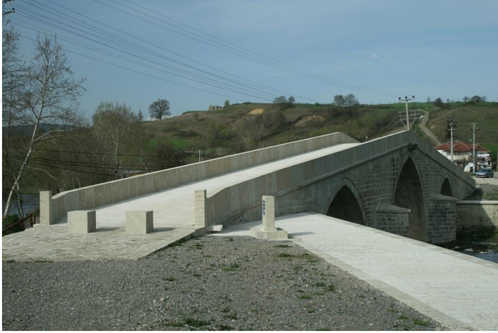
Şekil 5.146 : Güneybatı yönünden köprü ve tempan duvarları.
