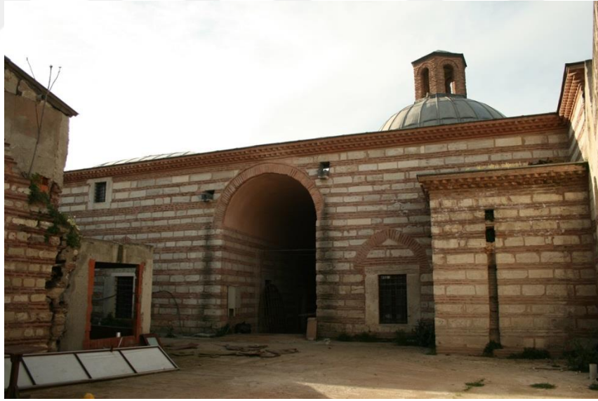
Şekil 5.244 : İmaret avlusundan imaretin giriş cephesine bakış. Sağda mutfaklar, solda fırın yer almaktadır.
