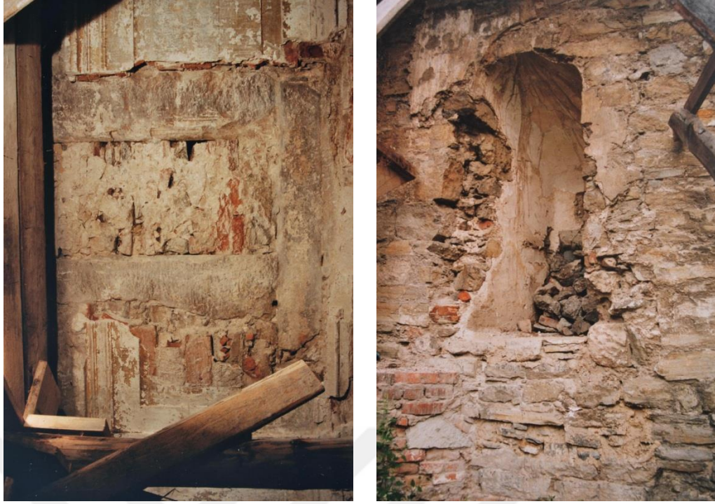
Şekil 5.23 : 2001 yılındaki restorasyonda apsis güneydoğu duvarının içten (solda) ve dıştan (sağda) görünümü, (Fotoğraflar: K. Jurków ve J. Smaza).
