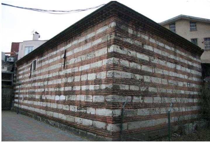
Şekil 5.232 : Külliye'nin güney köşesinde yer alan sarnıç.
