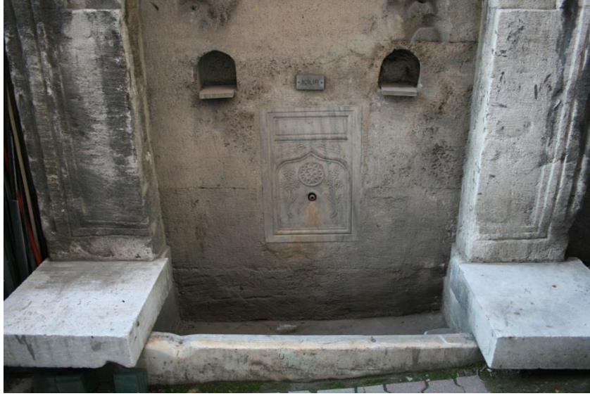
Şekil 5.131 : Çeşmenin teknesiyle oturma sekilerini gösteren detay.
