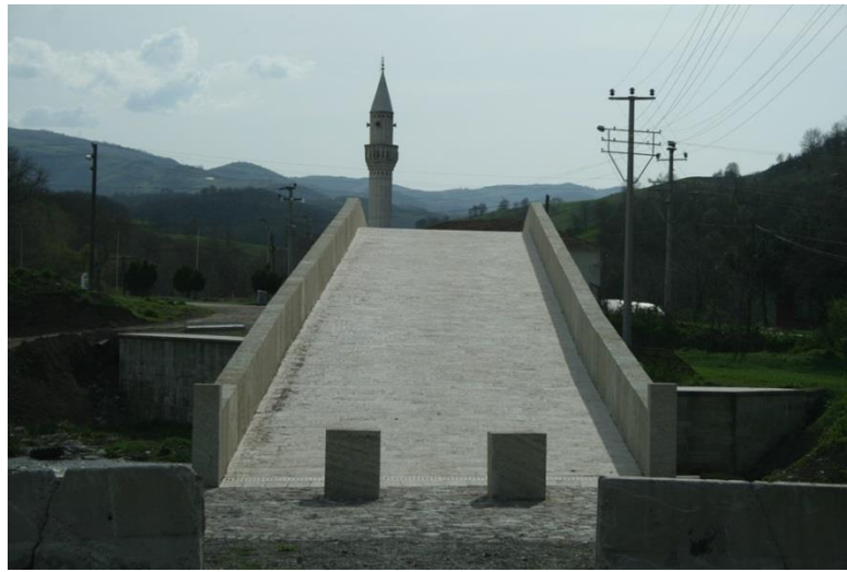
Şekil 5.149 : 2012 restorasyonu sonrasında yenilenen köprü döşeme taşları ve korkulukları.
