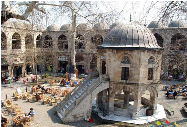
Şekil 5.35 : Bursa’da Kozahan avlusundaki şadırvanın üzerindeki mescit, Gülnuş Sultan’ın Mekke’deki darüşşifasının avlusundaki şadırvanın üzerine inşa edilen cüzhan odasının görünüşü hakkında fikir verebilir, (Url-4).
