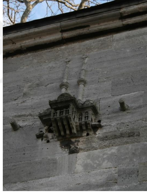
Şekil 5.184 : İç avlu kuzeybatı cephesinin sol tarafındaki büyük kuş evi.
