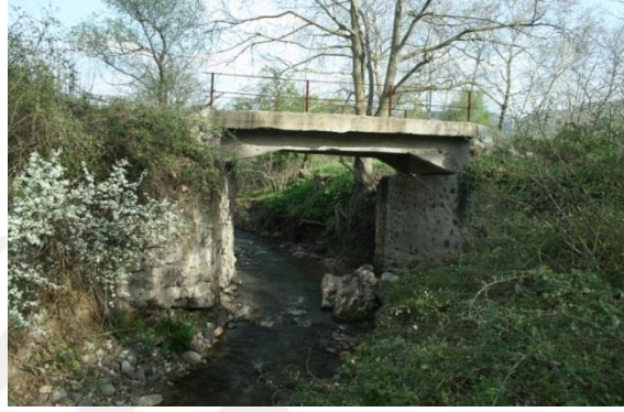
Şekil 5.143 : Söz konusu güzergâh üzerinde, Şekil 5.141'deki haritada 6 numaralı noktada tespit edilen köprü kalıntısı üzerine inşa edilen beton köprü.
