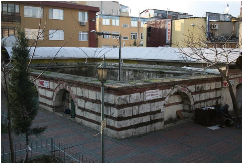
Őekil 5.235 : Tuvaletlerin bitiřindeki yangın havuzu.
