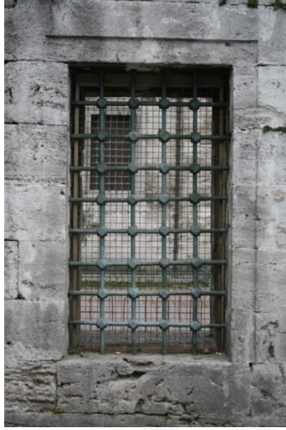
Şekil 5.173 : Külliye'nin dış avlu pencerelerinden biri.
