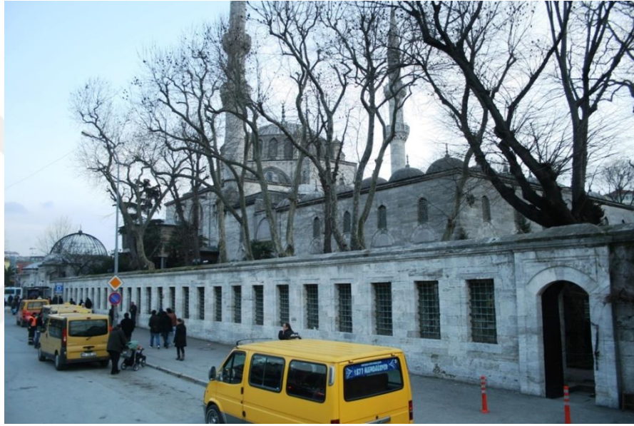
Şekil 5.172 : Üsküdar Meydanı'na bakan kuzeydoğu yöndeki dış avlu duvarları ve arasta kapısı.
