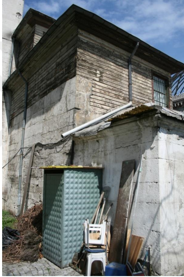
Şekil 5.209 : Hünkâr kasrının hazireden görünüşü. Ön plandaki yapı, türbedar odasıdır.
