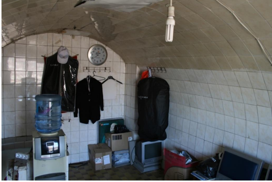
Şekil 5.239 : Külliye'deki dükkân sıralarında yer alan beşik tonozla örtülü altı dükkândan birinin içten görünümü.
