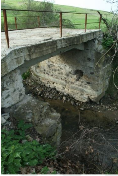
Şekil 5.143 : Söz konusu güzergâh üzerinde, Şekil 5.141'deki haritada 6 numaralı noktada tespit edilen köprü kalıntısı üzerine inşa edilen beton köprü.
