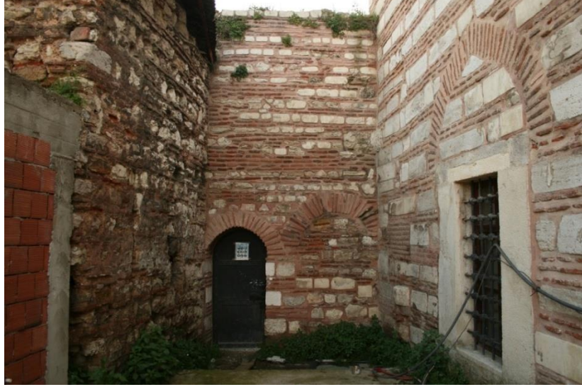
Şekil 5.245 : Avlunun güneybatı köşesinde sonradan açıldığı düşünülen kapı, solda külliye'nin dükkânlarından biri olduğu düşünülen yapının duvarları, sağda imaretin fırını.
