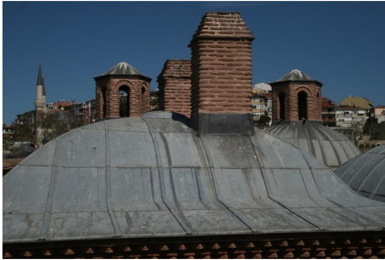
Şekil 5.247: İmaretin üst örtüsünün dıştan görünümü. Ön planda fırının bacaları, arka planda mutfağın fenerli kubbeleri.
