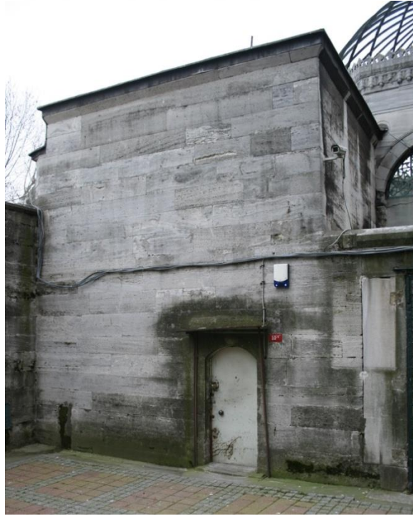
Şekil 5.216 : Sebilin girişi ve dış avluya bakan sağır duvarları.
