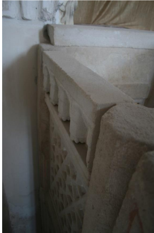
řekil 5.30 : Minberin gnmze ulařmayan baldaken blmndeki mukarnas paraların kullanıldıđı korkuluk blm.
