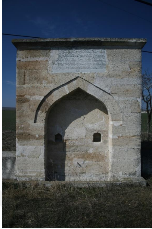
Şekil 5.56 : Çeşmenin cepheden görünüşü.
