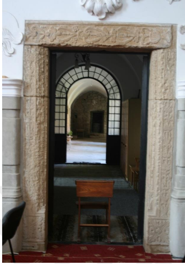
Şekil 5.21 : Koro bölümünün güney duvarında yer alan manastıra geçiş kapısı.
