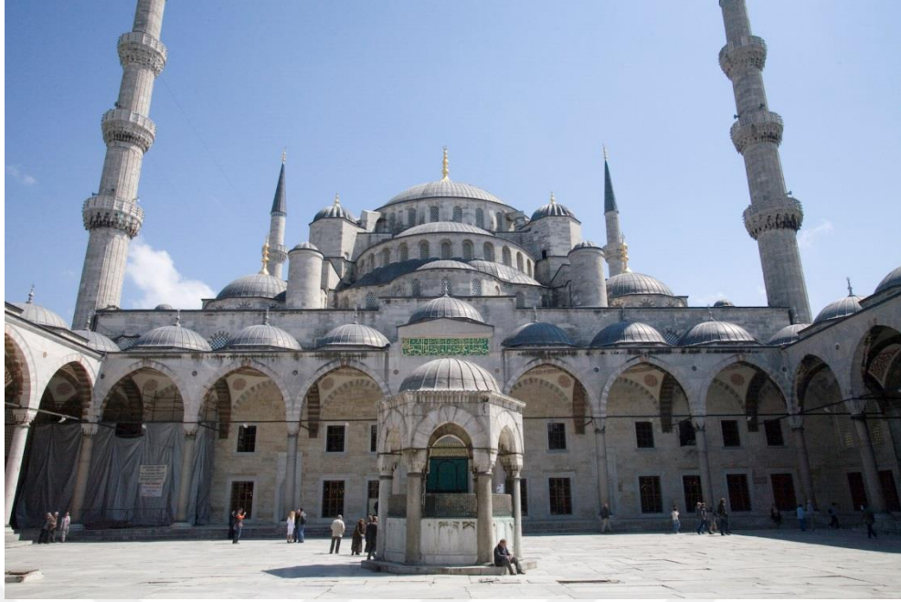
Şekil 2.4 : Sultanahmet Camisi şadırvan avlusu.
