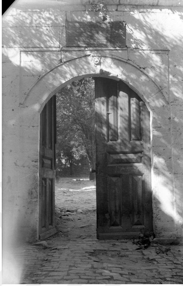
Şekil 5.85 : Galata Yeni Cami yıkılmadan önce çekilen bir fotoğrafta, avlunun güneydeki ana giriş kapısı ve üzerinde yer alan kitabe, (İstanbul Arkeoloji Müzeleri Encümen Arşivi).
