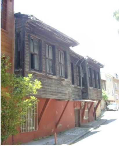
Şekil A.3. 74.:Payandalı çıkma, E.No:225
