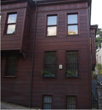
Şekil A.3. 84.:Demir korkuluk E.No:275
