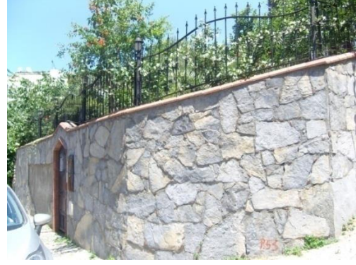
Şekil A.3. 13.:Bahçe Duvarı, E.No:217
