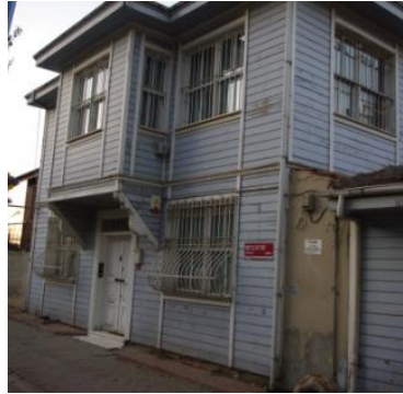
Şekil A.3. 85.:Demir korkuluk E.No:358
