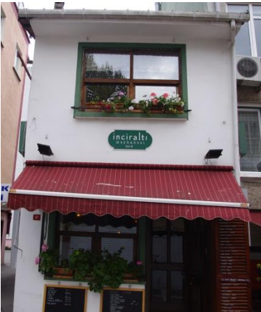
Şekil A.3. 96.:Kagir yapı, E. No:26
