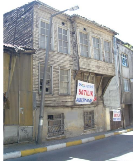
Şekil A.3. 75.:Payandalı çıkma, E.No:421
