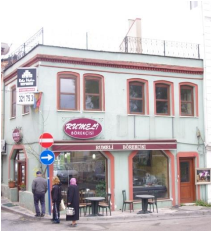
Şekil A.3. 76.:Yığma Yapı, E.No:100
