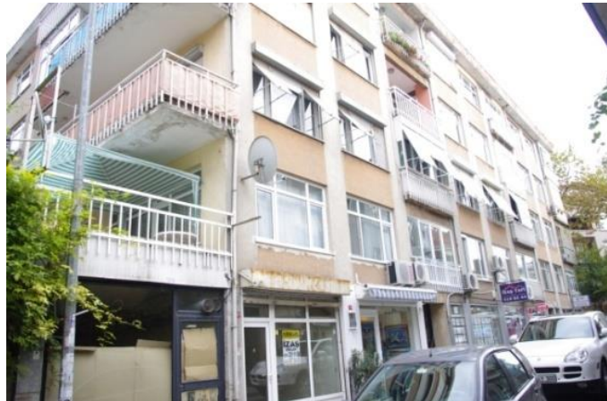
Şekil A.3. 97.:Betonarme yapı, E. No:107
