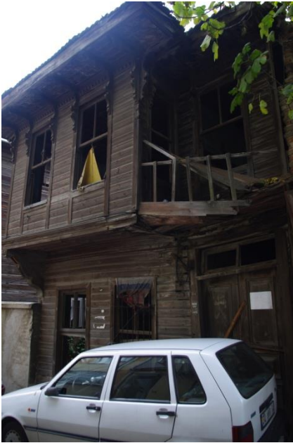
Şekil A.3. 78.:Ahşap yapı, E.No:193
