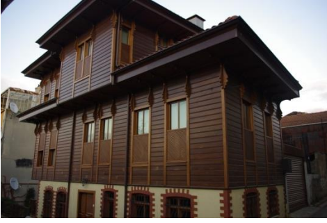
Şekil A.3. 82.:Basık k.li pencere, E.No:327
