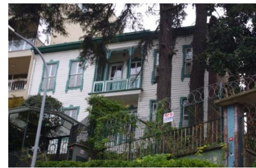
Şekil A.3. 91.:Balkon, E.No: 349
