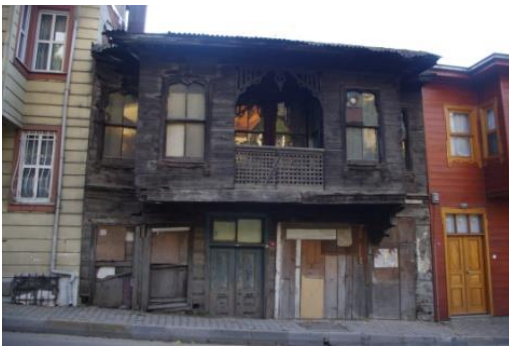
Şekil A.3. 90.:Balkon, E.No: 380
