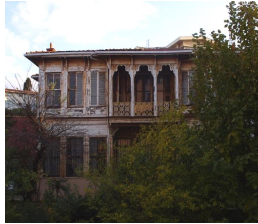
Şekil A.3. 77.:Ahşap yapı, E.No:193
