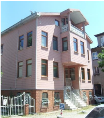
Şekil A.3. 68.:Balkon çıkma, E.No:96
