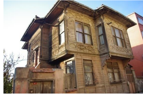
Şekil A.3. 89.:Ahşap payanda, E.No:86
