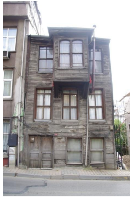
Şekil A.3. 67.:Ortadan çıkma, E.No:425
