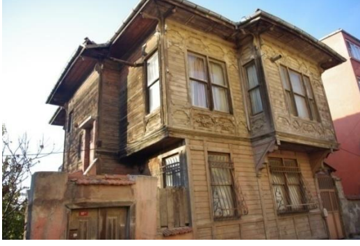
Şekil A.3. 98.:Ahşap yapı, E. No:86
