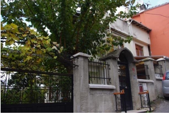
Şekil A.3. 12.:Bahçe Kapısı, E.No:483
