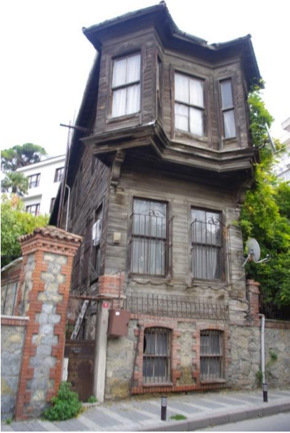
Şekil A.3. 72.:Üçüzlü çıkma, E.No:108
