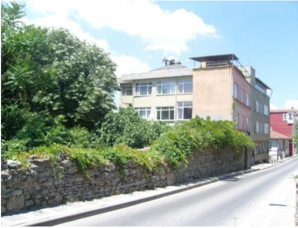
Şekil A.3. 14.:Bahçe Duvarı
