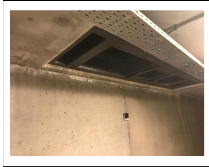
Şekil 49. İnterfiks Malzeme Kullanılan Duvar
