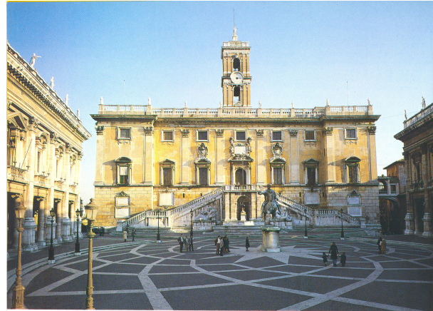
Figure 2.6. Piazza del Campidoglio General View (Source: Progetti 2000)
