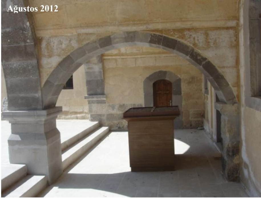
Şekil 4.266 : Aya Nikola Manasırı, dış narteksi, 3 no'lu kilise önünden kuzeye doğru bakış, kemer ve tonoz yüzeylerinde çiçeklenmeler.
