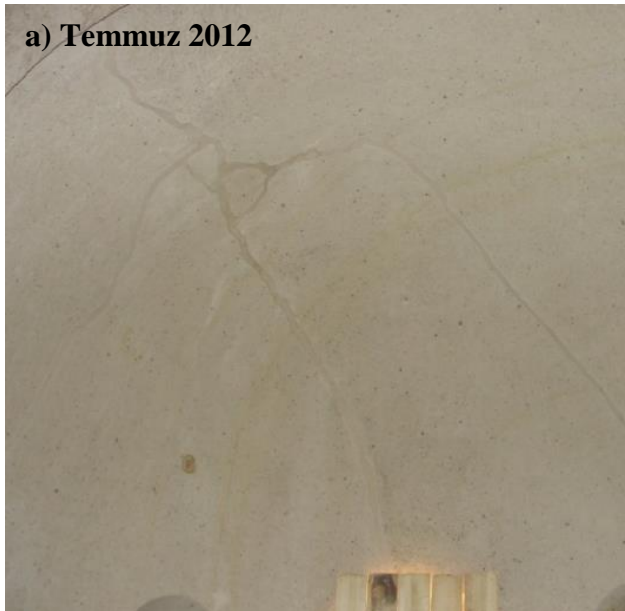
Şekil 4.185 : a) Apsis tavanında doldurulmuş çatlaklar. b) Şapel içerisindeki özgün boyalı nişler ve yüzey kirlilikleri.
