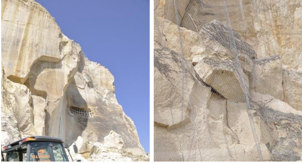
Şekil 3.42 : Ürgüp Kadıkalesi yamaçağı-perdeli ağ- uygulaması.
