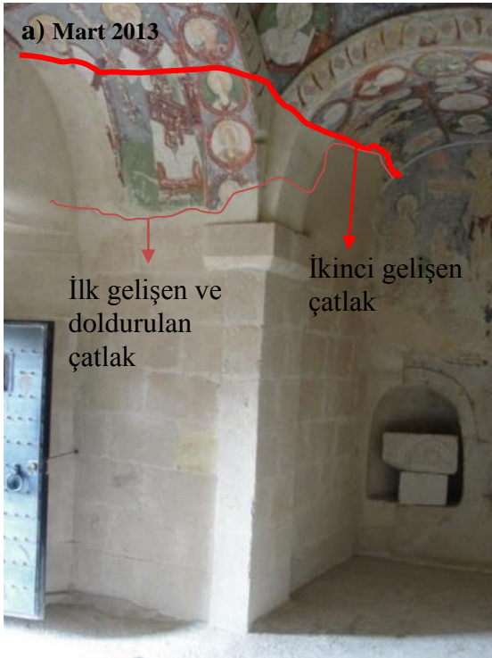
Şekil 4.88 : a) El Nazar Kilisesi 1997-98 onarımı ile örülen duvar ve yeni gelişen çatlak. b) Kuzey yan apsis.
