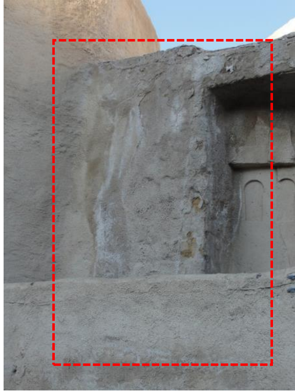
Şekil 4.36 : Elmalı Kilise girişi, Aralık 2013'te sıvanan bölümler ve çiçeklenmeler.
