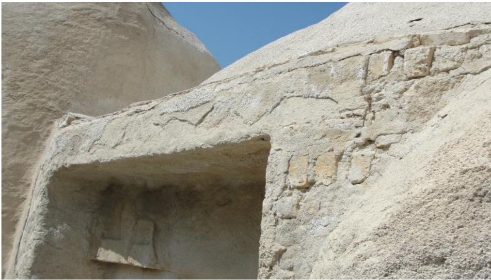
Şekil 4.31 : Elmalı Kilise girişine restorasyon sırasında inşa edilen saçağın mevcut durumu.
