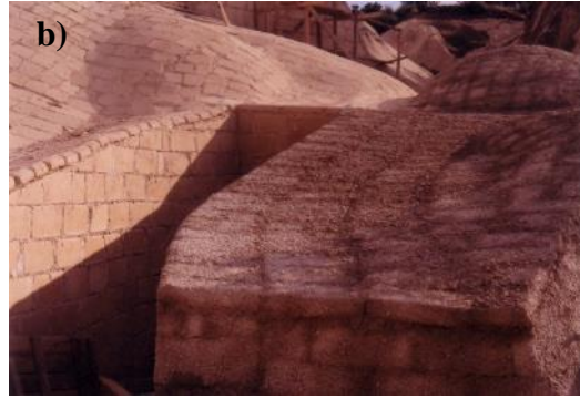
Şekil 3.31 : a) Elmalı-Barbara Kiliseleri üst örtü yüzey kaplama uygulama aşaması. b) Elmalı-Barbara Kiliseleri püskürtme sıva öncesi.
