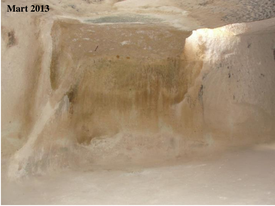
Şekil 4.238 : Aya Nikola Manastırı, 3 no'lu kilise apsisinin arkasındaki odanın doğu tarafı, onarılan kısım, nem ve neme bağlı küflenme.
