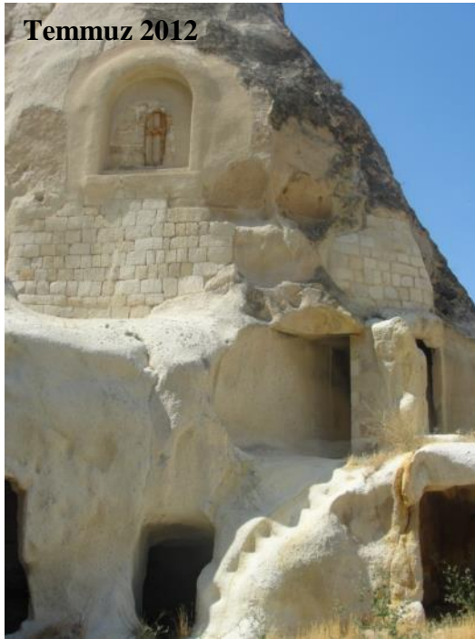
Şekil 4.181 : Kaya kütlesinin güneydoğu köşesindeki mekânların mevcut durumu ve oyulan kısımlara örülmüş destek duvarları.
