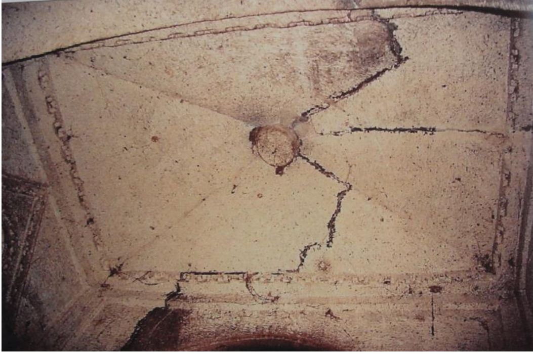
Şekil 4.170 : Kilise naosunun doğu tarafı, bemanın çapraz tonozlu tavanı, onarım öncesi (NKK Arşivi).
