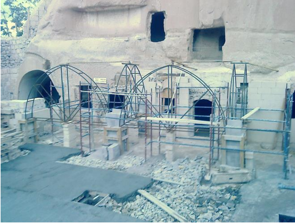
Şekil 4.259 : Aya Nikola Manastırı, dış narteks iskelesi ve avlu zemininin düzenlenmesi (F. Sağcan)
