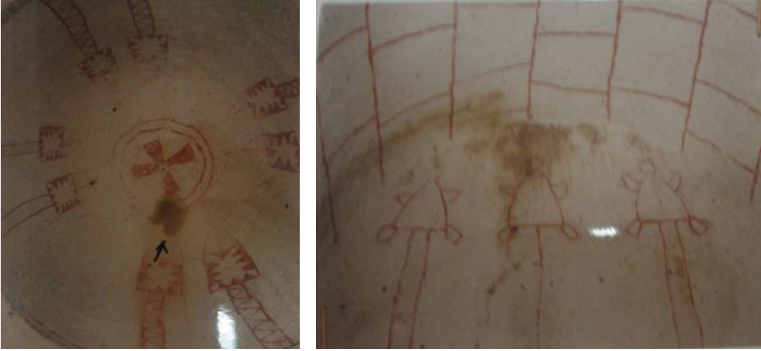
Şekil 4.24 : Azize Barbara Kilisesi üst örtüsünde meydana gelen incelmeye bağlı nemlenmeler (NKK Arşivi).
