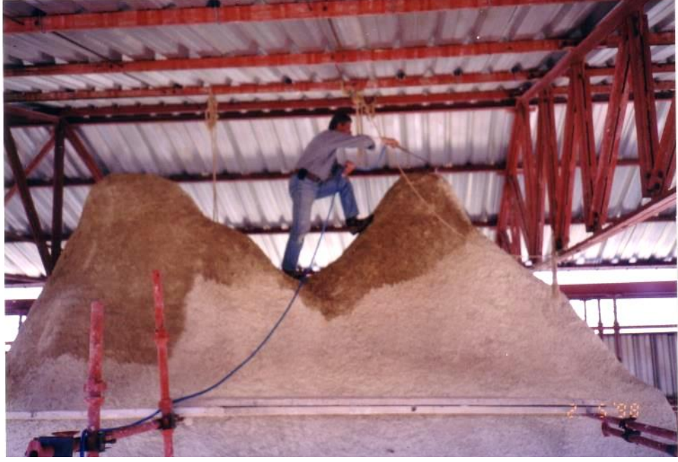
Şekil 4.101 : Hidrolik kireç harçlı sıva üzerine etil silikat uygulaması (R. İşler).
