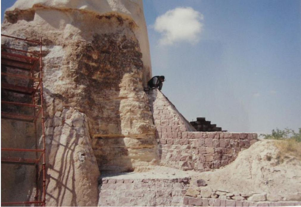
Şekil 4.96 : El Nazar Kilisesi batı cephesi destek duvarı (R. İşler).
