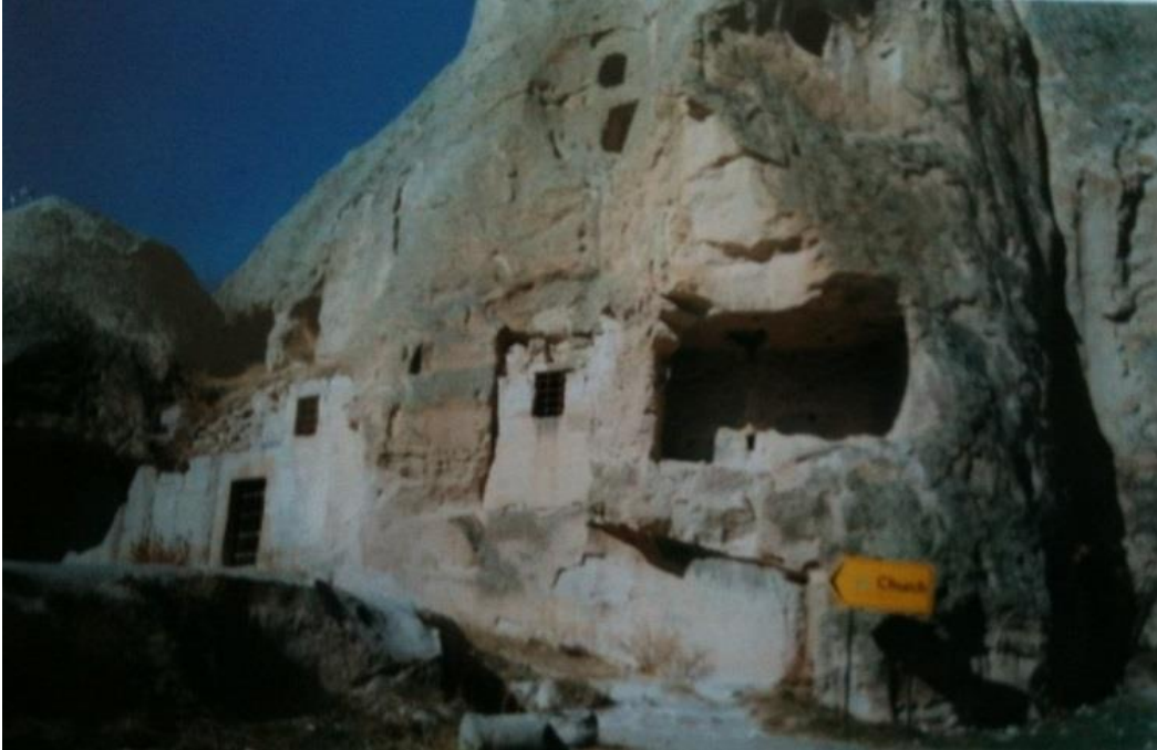
Şekil 4.48 : Archangelios Kilise girişi onarım öncesi (27.11.1996, İ. Karabıyık, NKK Arşivi).
