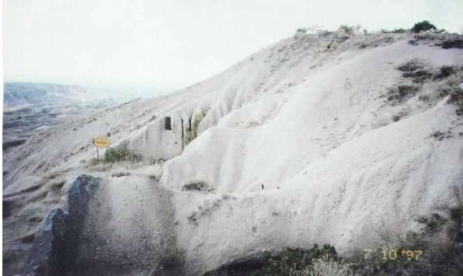
Şekil 4.105 : Sarıca Kilise doğu cephesi onarım öncesi (NKK Arşivi).
