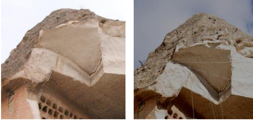
Şekil 3.25 : Göreme pafta no:3 Parsel no: 228’de kayıtlı peribacası.
