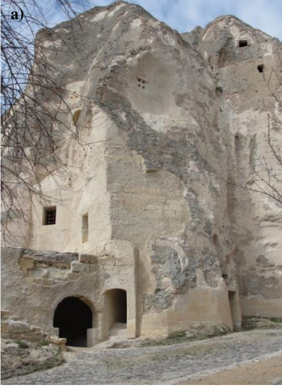
Şekil 4.55 : a) Ayazmaya onarım sırasında inşa edilmiş ikinci giriş ve doldurulan oyuklar. b) Kesme taş ile doldurulan oyuklar.
