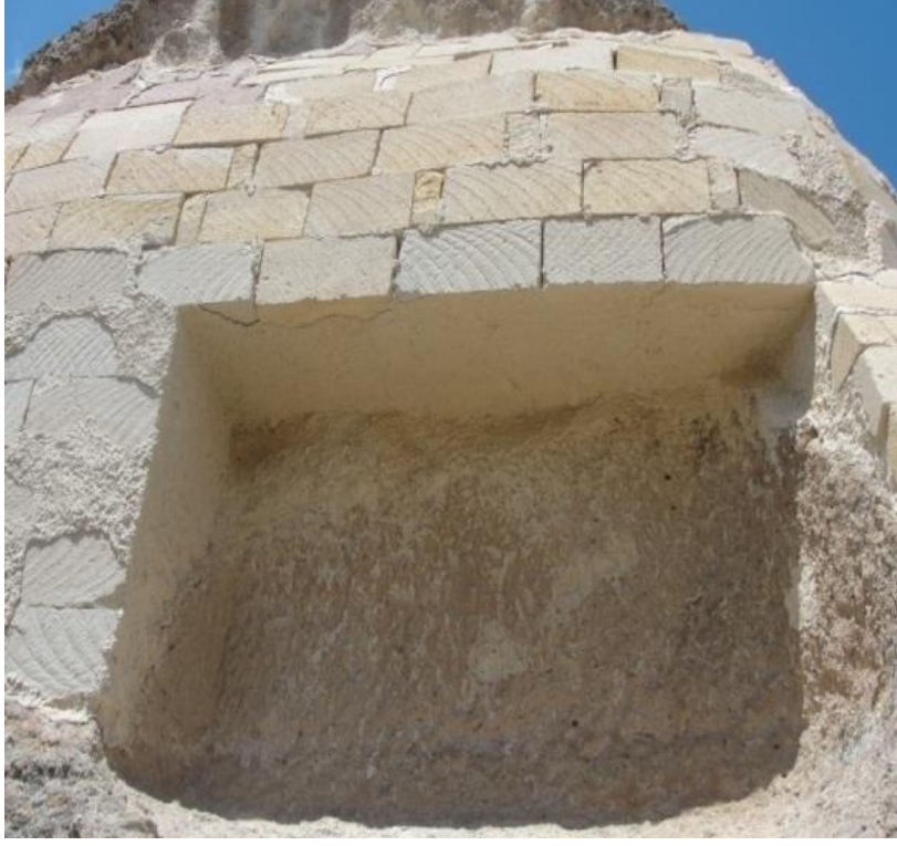
Şekil 4.63 : Bir kısmı oldurulmuş derin oyuk.
