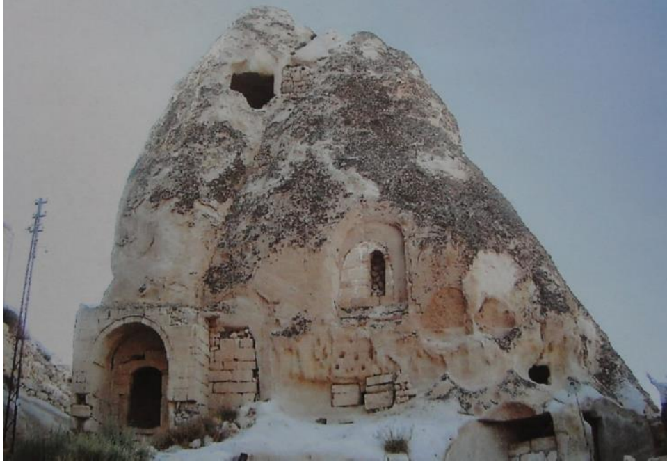
Şekil 4.156 : Kayakapı Kilisesi güney cephesi onarım öncesi (NKK Arşivi).
