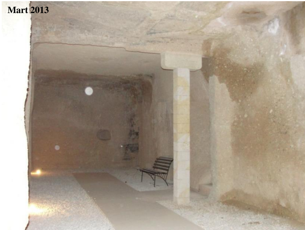
Şekil 4.132 : Sarıca Kilise trapeza bölümü, batıdan doğuya bakış, mevcut durum ve duvar yüzeylerindeki nemlilikler.
