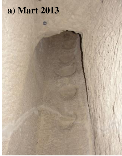
Şekil 4.194 : a) Tiraz adı verilen düşey merdiven. b) 2. kat güvercinlik mekânı batı bölümünün güney duvarı.
