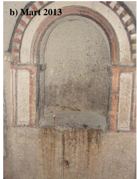
Şekil 4.185 : a) Apsis tavanında doldurulmuş çatlaklar. b) Şapel içerisindeki özgün boyalı nişler ve yüzey kirlilikleri.
