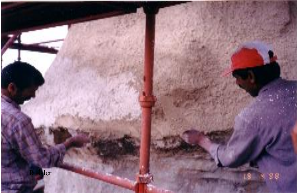
Şekil 4.100 : El Nazar Kilisesi hidrolik kireç harçlı sıva uygulaması (R. İşler).
