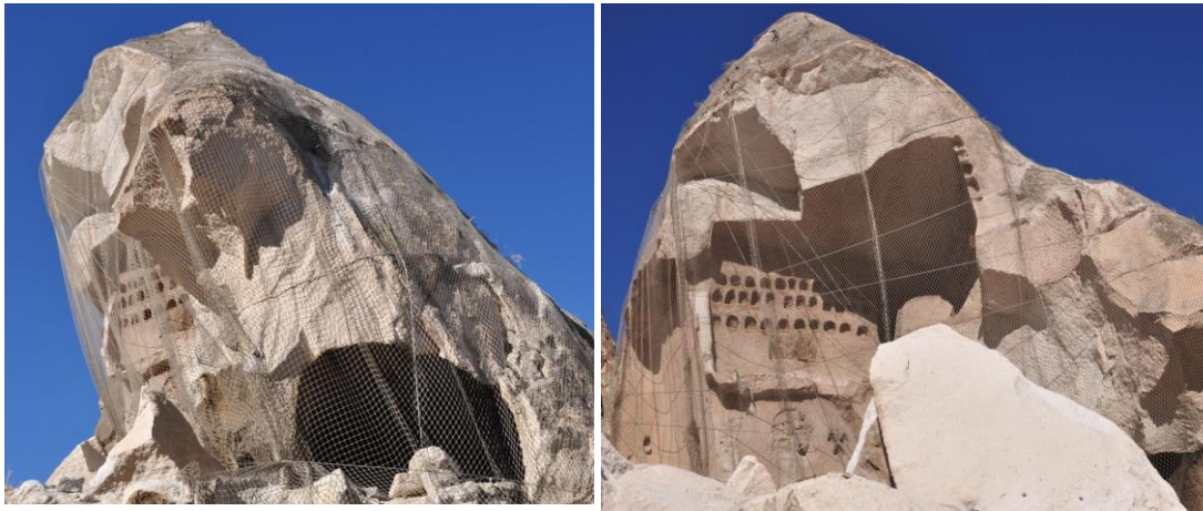
Şekil 3.41 : Göreme pafta no:3 Parsel No: 228’de kayıtlı peribacası, yamaç örtüleme örneği (Melikoğlu 2011-Kuzey Endüstriyel Dağcılık).
