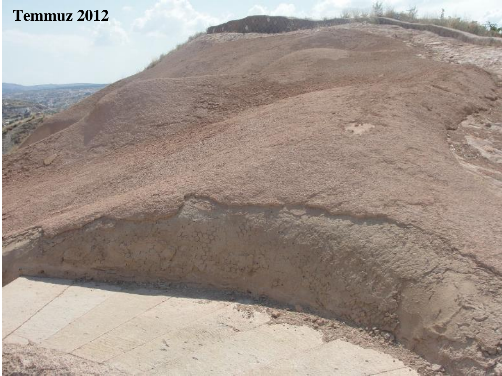
Şekil 4.138 : Sarıca Kilise üst örtüsü bozuşan sıva tabakaları.
