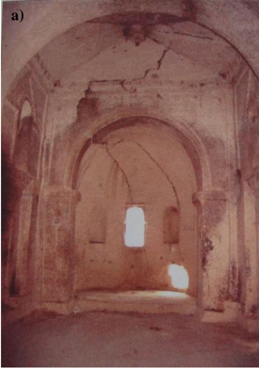
Şekil 4.164 : Kayakapı Kilisesi apsisi ve naosun çapraz tonozlu doğu tarafı. a) Onarım öncesi (NKK Arşivi). b) Mevcut durum.
