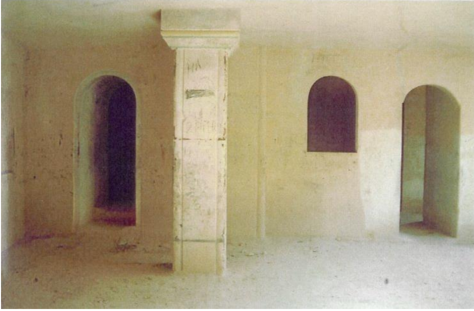
Şekil 4.226 : Aya Nikola Manastırı, 3 no'lu kilisenin naosundan güney duvarına ve 4 no'lu kiliseye bakış, onarım öncesi (NKK Arşivi).
