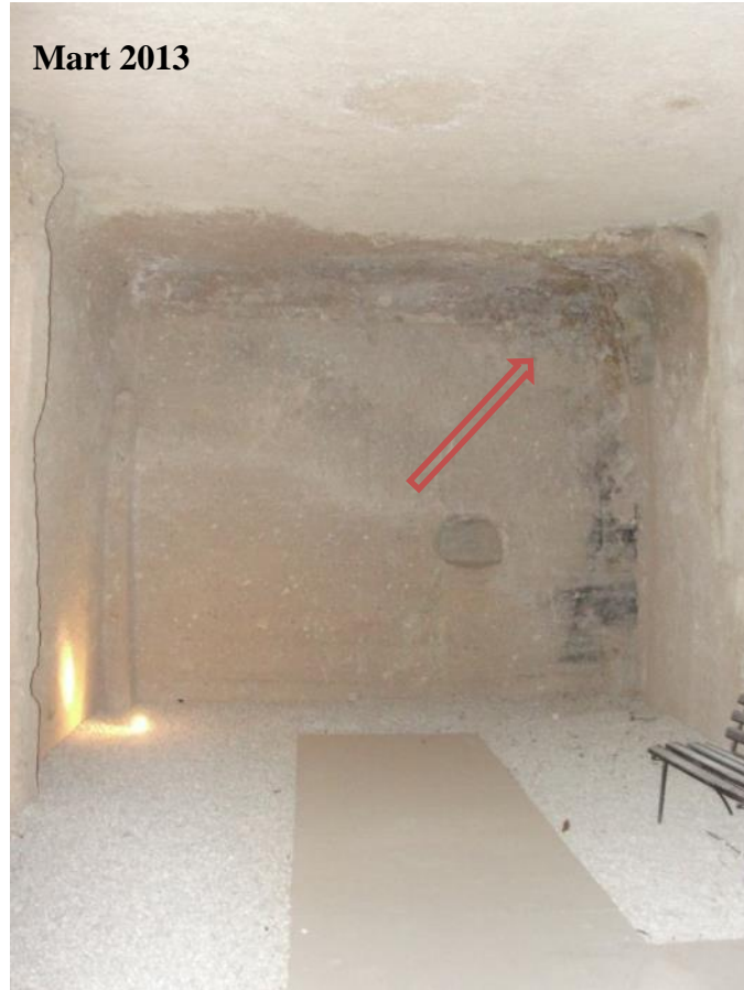
Şekil 4.134 : Sarıca Kilise trapeza bölümü, batıdan doğuya bakış, duvar yüzeylerinde nem ve neme bağlı küflenmeler.
