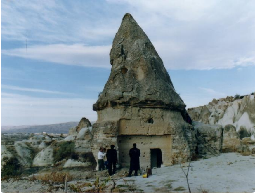
Şekil 4.80 : El Nazar Kilisesi güney cephesi onarım öncesi (R. İşler).
