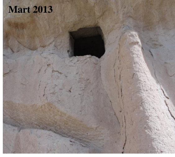
Şekil 4.246 : Aya Nikola Manastırı, kiliselerin üst kotunda bulunan oda ve güvercinliklerin açıklıkları, dış narteks üst kaplaması (sol), yaprak yaprak dökülme, yüzeyde kavlamalar (sağ).
