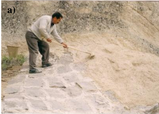
Şekil 3.32 : a) Kılıçlar Kilisesi üst örtü taş üstüne sıva uygulanırken (R. İşler). b) Kılıçlar Kilisesi sıva uygulaması bitiş aşaması (R. İşler).
