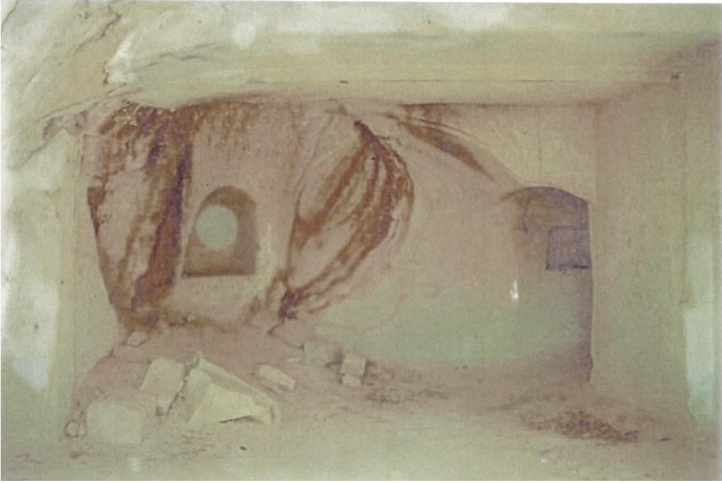
Şekil 4.214 : Aya Nikola Manastırı, 1 no'lu kilisenin doğu tarafına bakış, onarım öncesi (NKK Arşivi).
