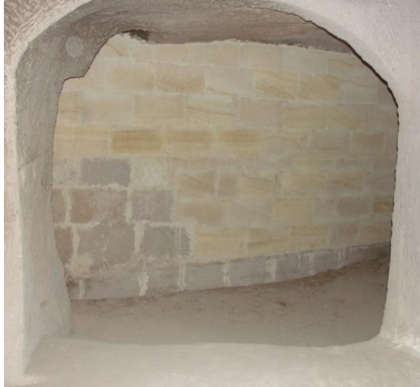
Şekil 4.62 : Archangelios Kilisesi içerden örülmüş duvar.
