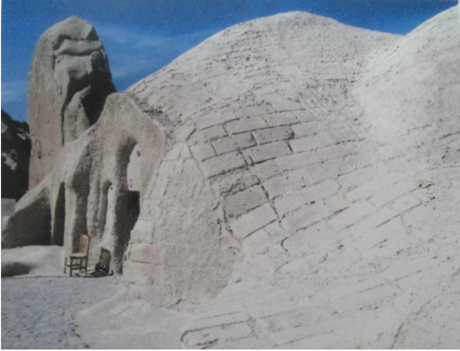
Şekil 4.27 : Elmalı-Barbara Kiliseleri onarımdan kısa bir süre sonra prizini almayıp dökülen sıva tabakası (NMM Arşivi).
