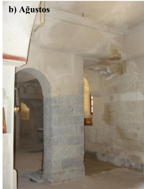
Şekil 4.251 : Aya Nikola Manastırı, 2 no'lu kilise giriş bölümünde nem ve çiçeklenmenin olduğu yüzeyler, a) onarım öncesinde sağlam olan (NKK Arşivi). b) Mevcut durumda bütünlenmiş olan paye.
