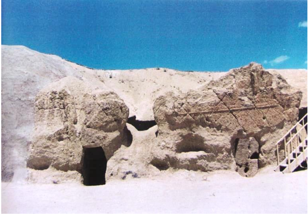
Şekil 4.129 : Sarıca Kilise güney cephesi, trapeza bölümü, onarım öncesi (NKK Arşivi).
