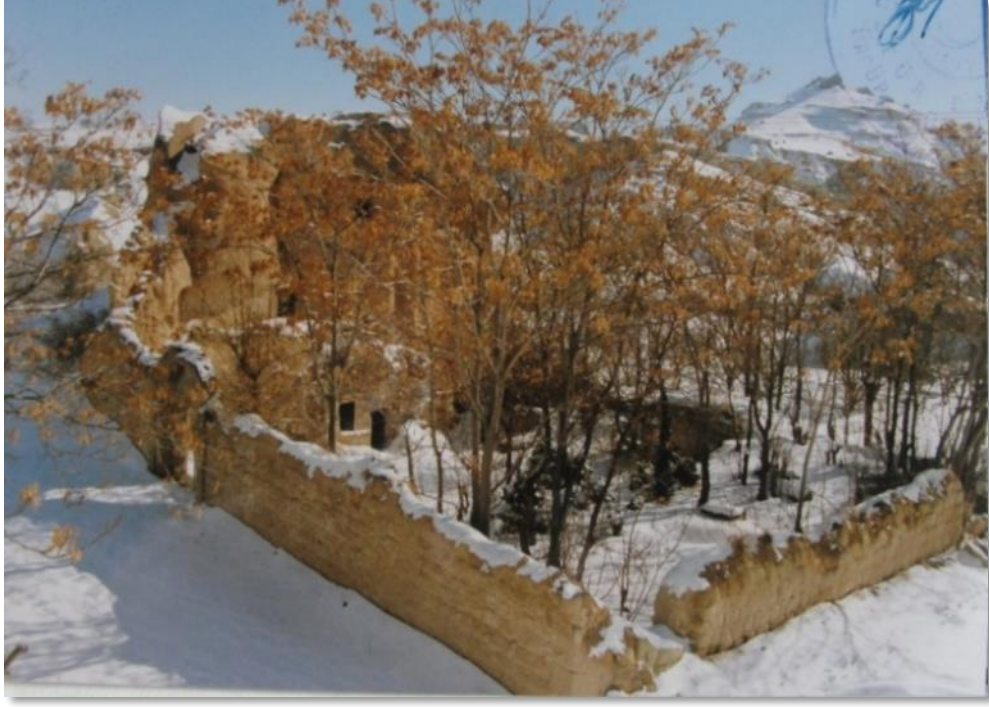
Şekil 4.206 : Aya Nikola Manastırı ve avlusunun kuzeybatıdan görünüşü, onarım öncesi (NKK Arşivi).
