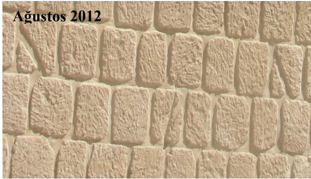
Şekil 4.261 : Aya Nikola Manastırı, kuzey avlu duvarlarında işçiliğe bağlı uygulama hatası, iki farklı malzemenin farklı aşınımından kaynaklanan taş bloklarda kopmalar.
