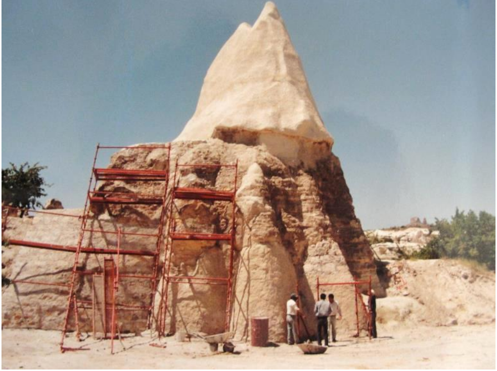
Şekil 4.97 : El Nazar Kilisesi kuzey cephesi destek duvarları (R. İşler).
