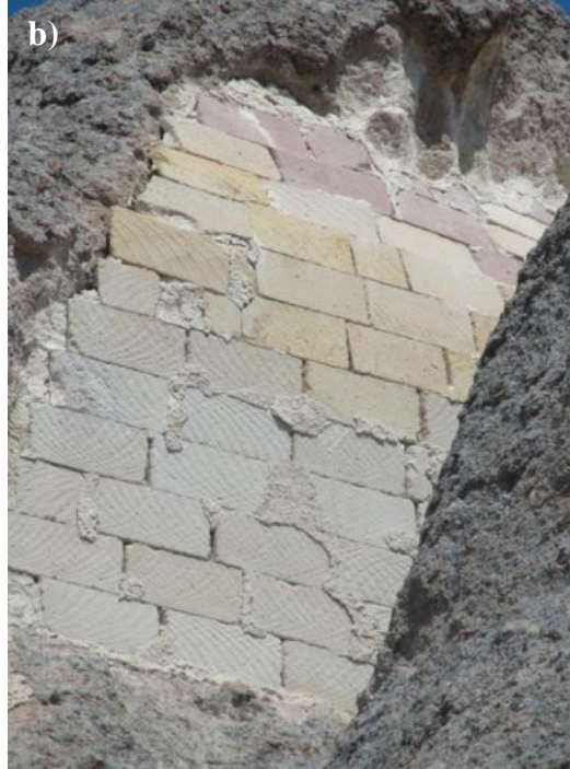
Şekil 4.64 : a) Gelişi güzel doldurulmuş oyuk. b) Sıva dökülmesi, farklı renk ve dayanıma sahip kesme taş bloklar.
