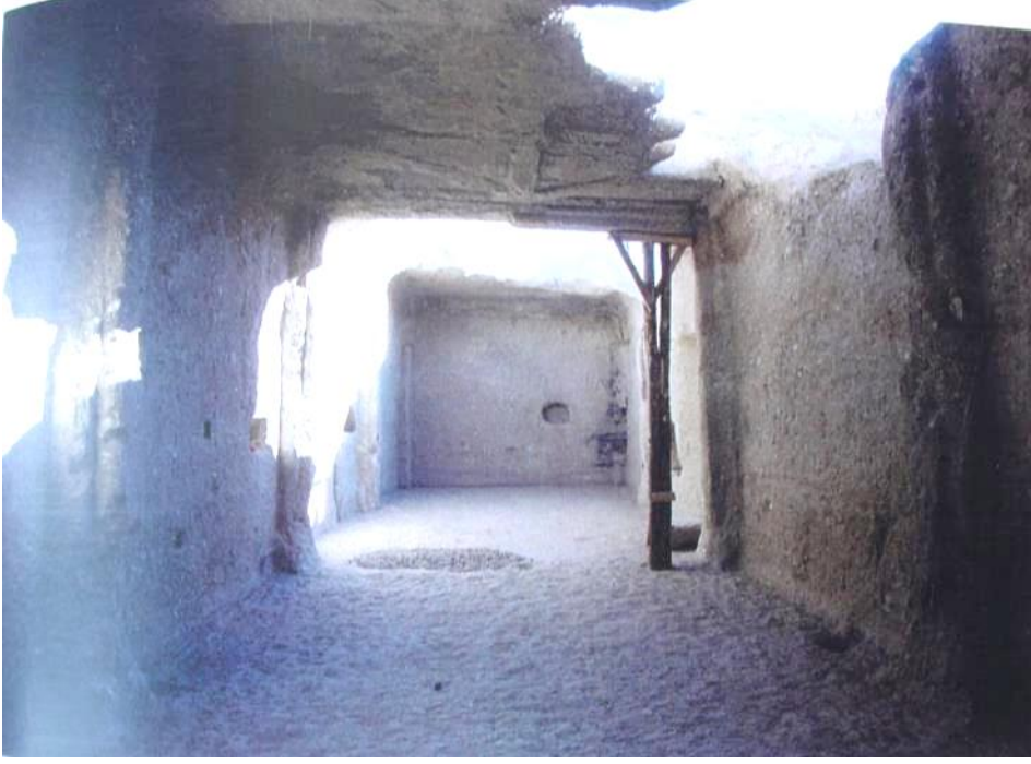
Şekil 4.123 : Sarıca Kilise doğu mekânı batıdan doğuya bakış onarım öncesi (NKK Arşivi).
