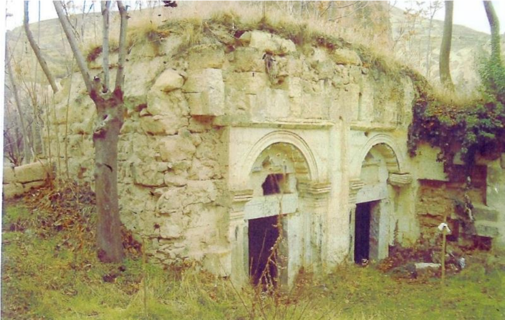
Şekil 4.209 : Aya Nikola Manastırı, avlu odalarının kuzeydoğu görünüşü, onarım öncesi (NKK Arşivi).
