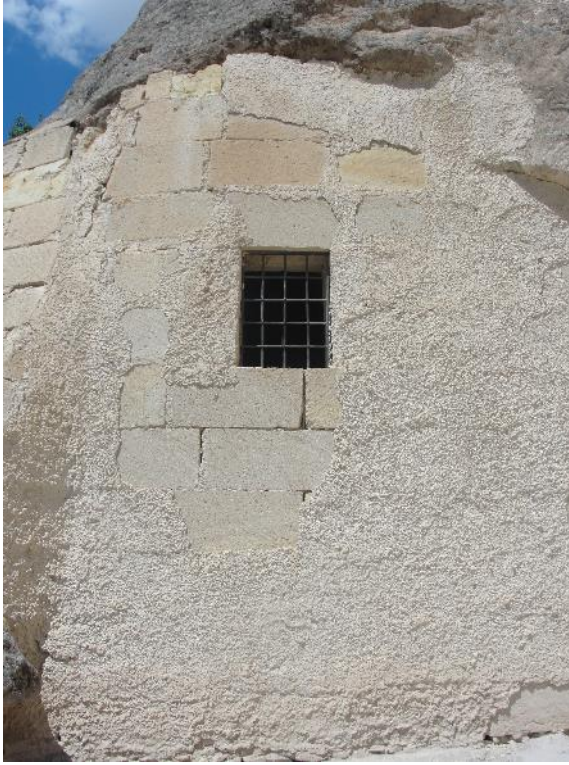
Şekil 4.66 : Farklı kalınlıklardaki imitasyon sıva tabakaları.
