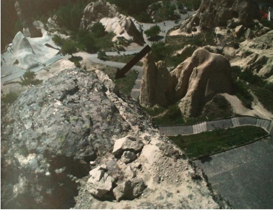
Şekil 4.278 : Çarıklı Kilise'nin oyulduğu kayanın üzerindeki gevşek kaya blokları (NKK Arşivi).
