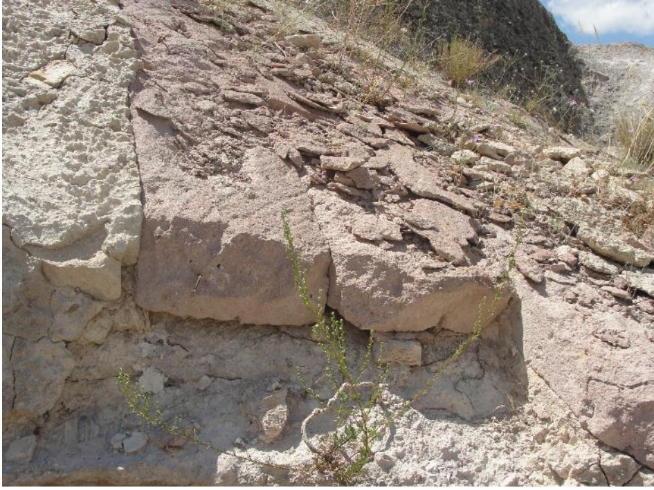
Şekil 4.69 : Kaplama olarak kullanılan ve bozuşan taş bloklar.
