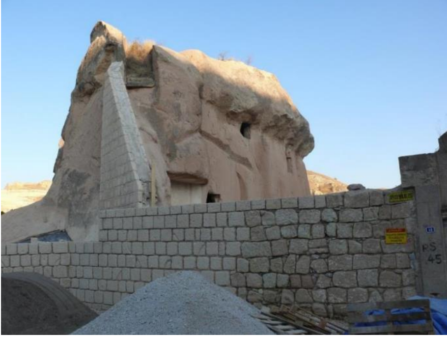
Şekil 4.262 : Aya Nikola Manastırı, kuzey avlu duvarlarında yeniden yapım (F. Sağcan).
