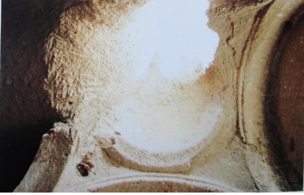
Şekil 4.110 : Narteks doğu bölümünün yıkılan kubbe biçimindeki üst örtüsü (NKK Arşivi).
