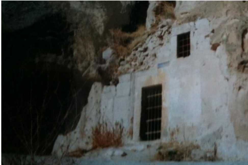
Şekil 4.50 : Archangelios Kilise girişi onarım öncesi (NKK Arşivi).
