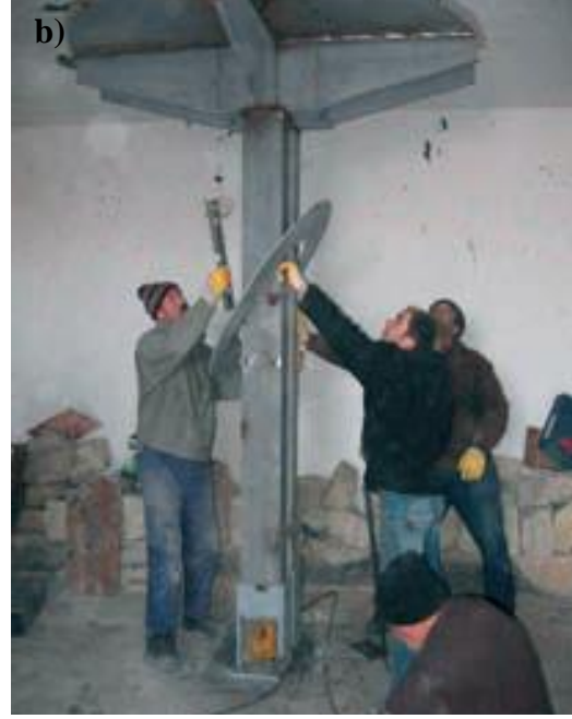
Şekil 4.186 : a) Ön yüklemeli kolon için yüzeyin hazırlanışı (Kabaoğlu 2009). b) Ön yüklemeli kolonun yerleştirilmesi (Kabaoğlu 2009).
