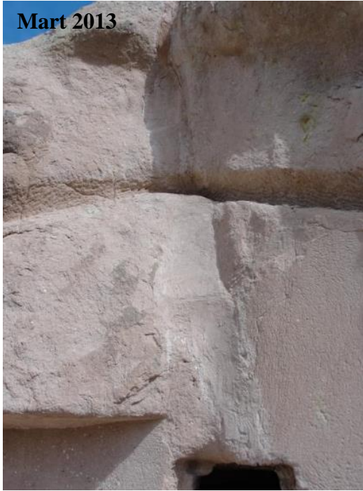
Şekil 4.247 : Aya Nikola Manastırı, batı cephesindeki doldurulmuş yarık ve çatlaklar.
