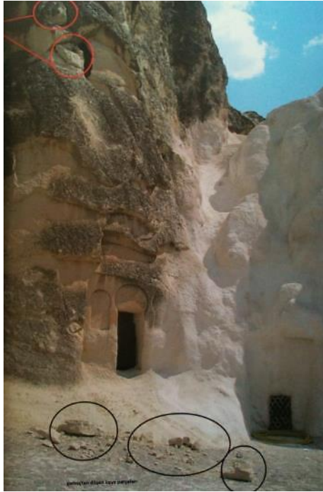
Şekil 4.281 : Çarıklı Kilise, düşen ve düşme tehlikesi gösteren kaya blokları (NKK Arşivi).
