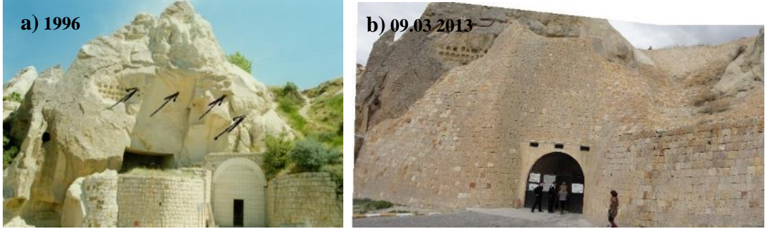
Şekil 3.21 : Tokalı Kilise girişine inşa edilen istinat duvarı. a) Onarım öncesi (NKK Arşivi). b) Mevcut durum.
