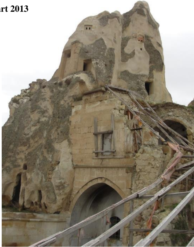
Şekil 4.153 : Kuzey cephesi, kilise bitişiğindeki iki katlı yığma yapının mevcut durumu
