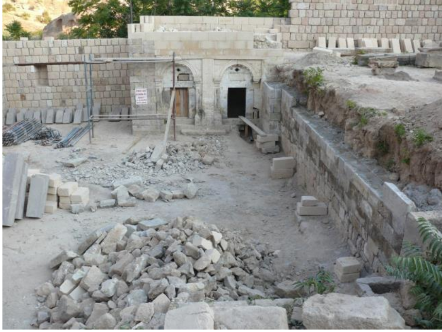
Şekil 4.256 : Aya Nikola Manastırı, avludaki yeniden yapım çalışmaları (F. Sağcan).
