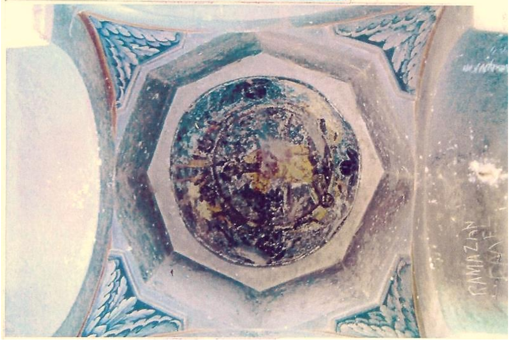
Şekil 4.244 : Aya Nikola Manastırı, 4 no'lu kilisenin sekizgen kasnaklı naosun kaya oyma kubbesi, onarım öncesi (NKK Arşivi).
