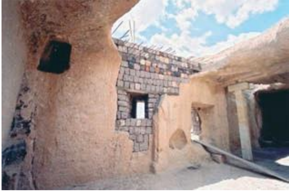
Şekil 4.149 : Sarıca Kilise doğu mekanı kaya cidarının bütünlenmesi (Kabaoğlu 2009).
