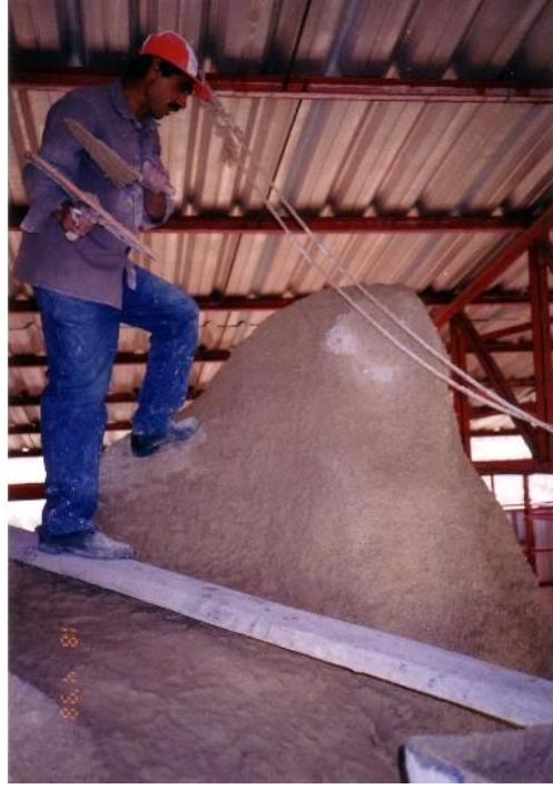
Şekil 4.99 : El Nazar Kilisesi hidrolik kireç harçlı sıva uygulaması (R. İşler).
