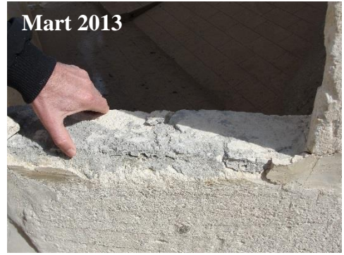
Şekil 4.261 : Aya Nikola Manastırı, kuzey avlu duvarlarında işçiliğe bağlı uygulama hatası, iki farklı malzemenin farklı aşınımından kaynaklanan taş bloklarda kopmalar.
