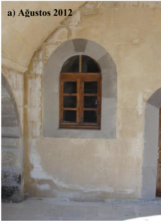
Şekil 4.267 : Aya Nikola Manasırı dış narteksi, a) Duvar yüzeylerinde nem ve çiçeklenmeler. b) Dış narteks tonoz kemerlerinde gelişen çatlaklar.
