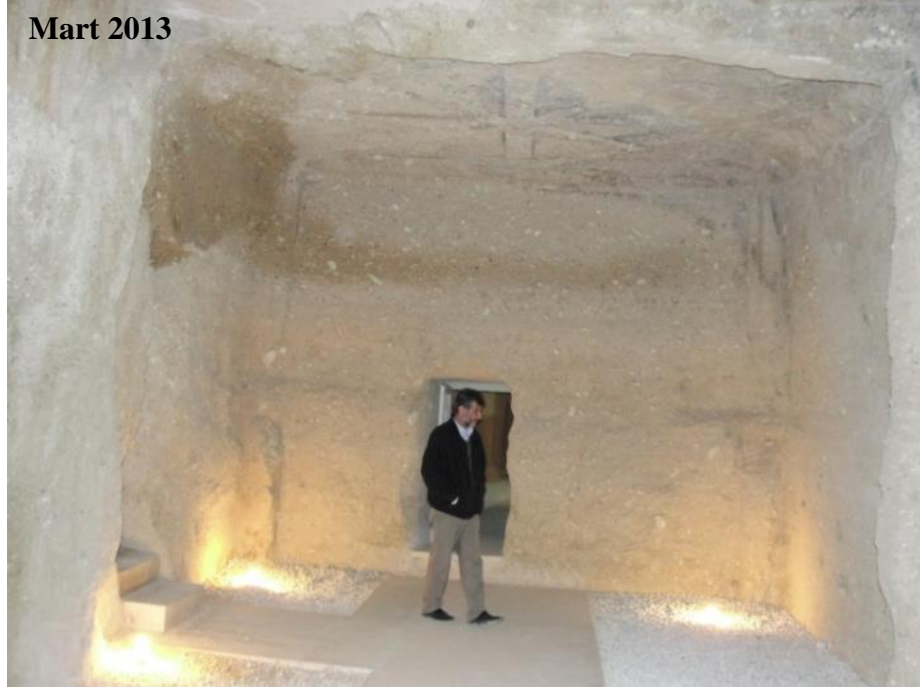
Şekil 4.133 : Sarıca Kilise trapeza bölümü, doğudan batıya bakış, mevcut durum ve duvar yüzeylerindeki nemlilikler.
