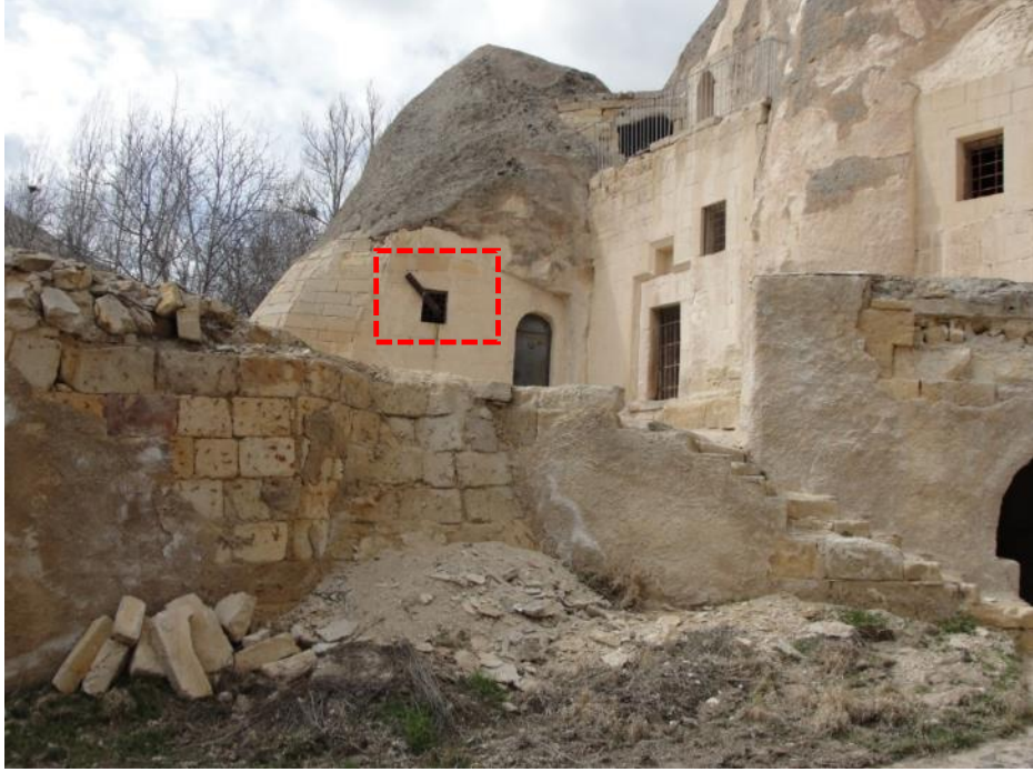
Şekil 4.57 : Önde yapısal bozulmalar, arkada kilise penceresinden dışarı çıkan soba borusu.
