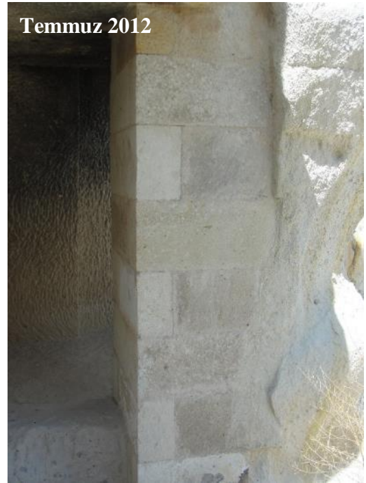
Şekil 4.181 : Kaya kütlesinin güneydoğu köşesindeki mekânların mevcut durumu ve oyulan kısımlara örülmüş destek duvarları.
