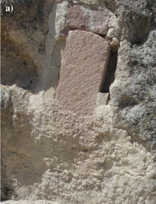
Şekil 4.64 : a) Gelişi güzel doldurulmuş oyuk. b) Sıva dökülmesi, farklı renk ve dayanıma sahip kesme taş bloklar.
