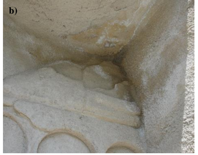
Şekil 4.34 : a) Azize Barbara Kilisesi güney cephesi dökülen sıva tabakası. b) Elmalı Kilise Temmuz 2013 itibariyle çiçeklenme ve nemlenmeler.
