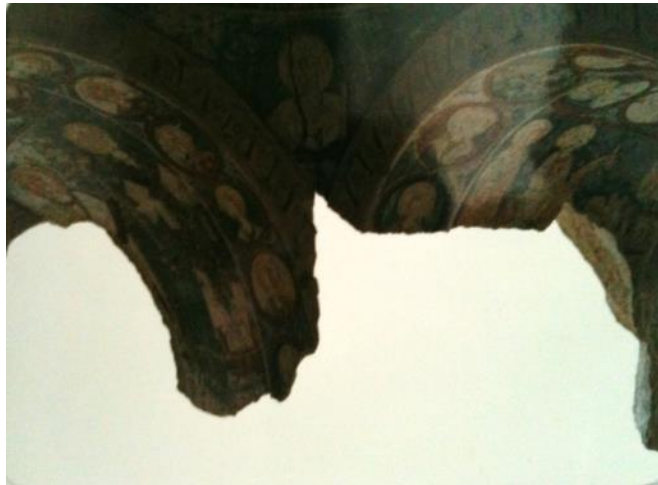
Şekil 4.78 : El Nazar Kilisesi kuzeybatı cephesi yıkılan kaya cidarı içerden(NKK Arşivi).
