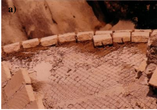
Şekil 3.31 : a) Elmalı-Barbara Kiliseleri üst örtü yüzey kaplama uygulama aşaması. b) Elmalı-Barbara Kiliseleri püskürtme sıva öncesi.
