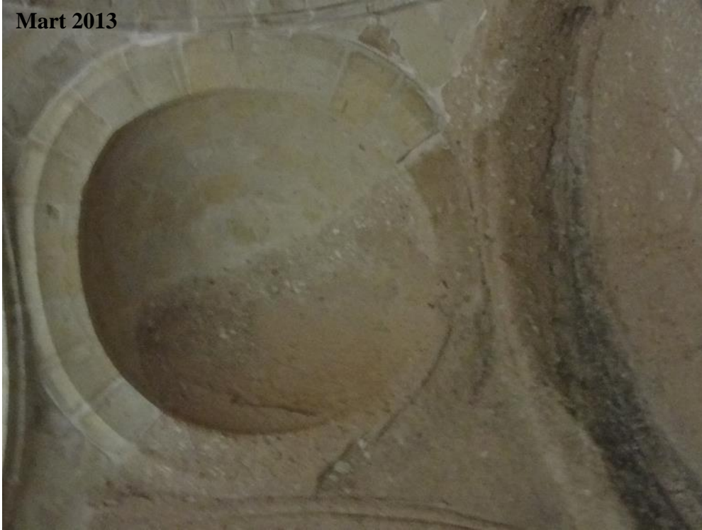
Şekil 4.111 : Sarıca Kilise narteks doğu bölümünün bütünlenen kubbesi.
