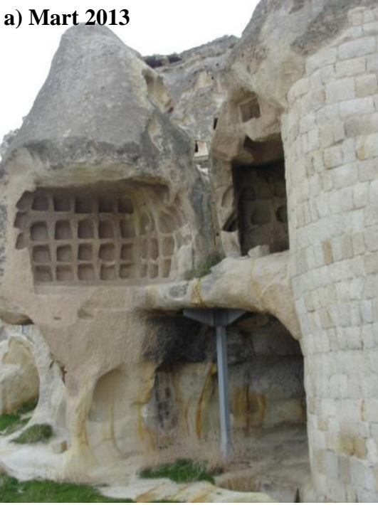
Şekil 4.162 : a) Kilisenin doğu cephesinde ki ve b) güney cephesindeki kayadamda sağlamlaştırma uygulamaları.
