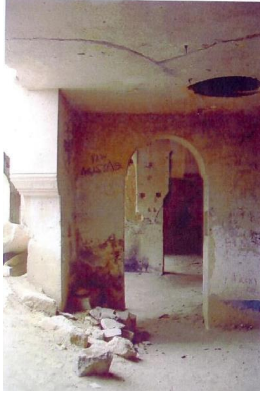
Şekil 4.230 : Aya Nikola Manastırı, 3 no'lu kilisenin naosundan doğuya doğru bakış, onarım öncesi (NKK Arşivi).
