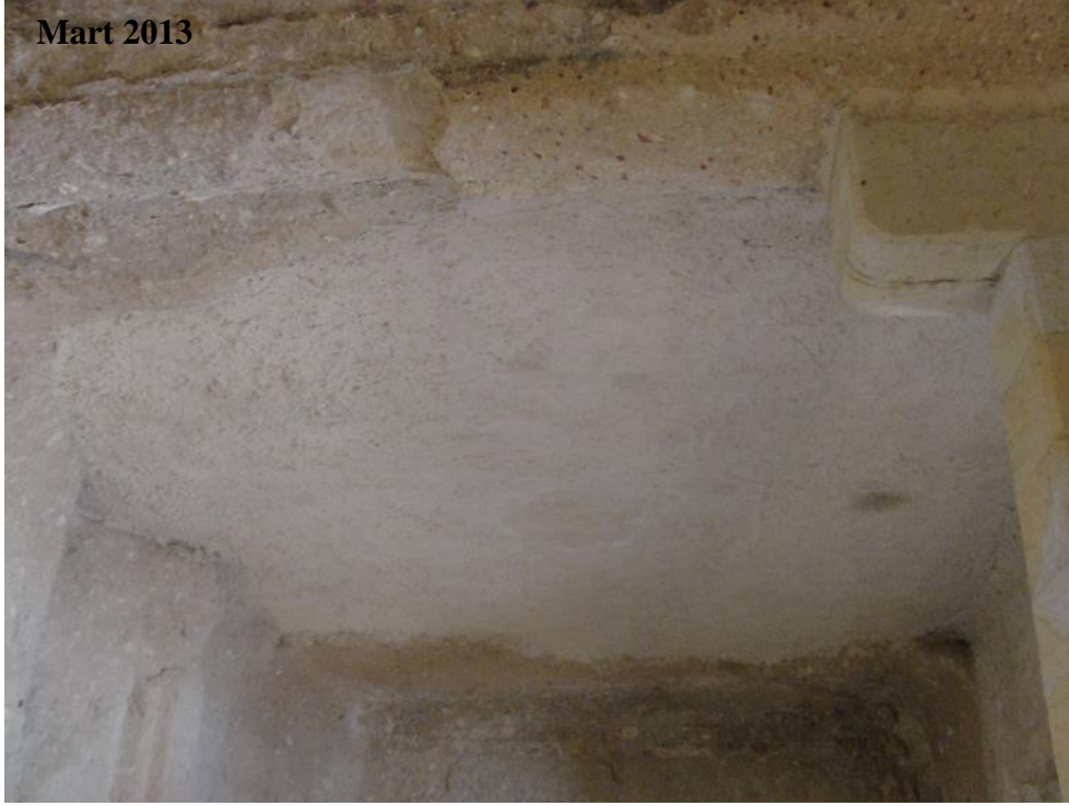
Şekil 4.139 : Sarıca Kilise trapezası bütünlenen ve sıvanan üst örtü.
