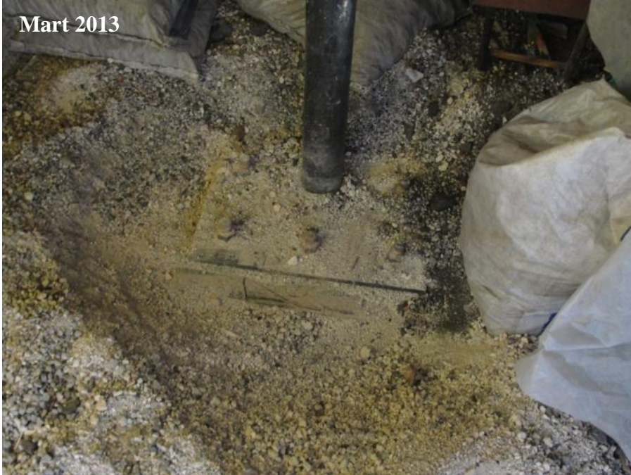
Şekil 4.94 : Tekil taşıyıcının temel kısmı.
