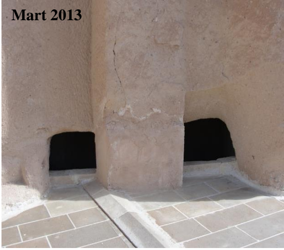
Şekil 4.246 : Aya Nikola Manastırı, kiliselerin üst kotunda bulunan oda ve güvercinliklerin açıklıkları, dış narteks üst kaplaması (sol), yaprak yaprak dökülme, yüzeyde kavlamalar (sağ).
