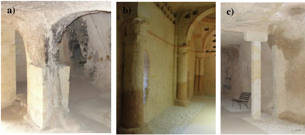
Şekil 3.24 : a) Cemil-Keşlik Manastır yemekhanesi. b) Ürgüp-Sarıca Kilise onarılmış duvar payeleri. c)Ürgüp-Sarıca Kilise onarım sırasında örülmüş taş destek.
