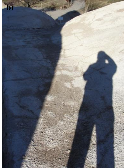
Şekil 4.41 : a) Elmali Kilise istinat duvarının güney tarafı. b) Elmali-Barbara Kiliseleri üst örtüsü ve sıvada tabakasındaki çatlaklar.
