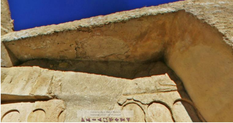
Şekil 4.29 : Elmalı Kilise girişine restorasyon sırasında inşa edilen saçak (Url-10).
