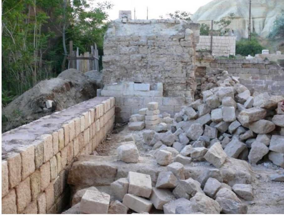
Şekil 4.260 : Aya Nikola Manastırı, güney avlu duvarları ve avlu odalarının yeniden yapımı (F. Sağcan).
