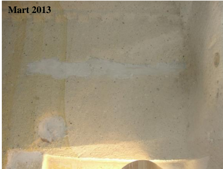
Şekil 4.179 : Girişin üzerindeki dolgu yapılan oyuklar.
