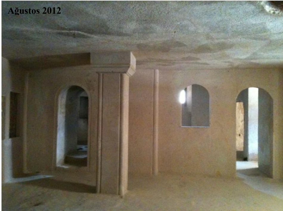
Şekil 4.227 : Aya Nikola Manastırı, 3 no'lu kilisenin naosundan güney duvarına ve 4 no'lu kiliseye bakış, mevcut durum.
