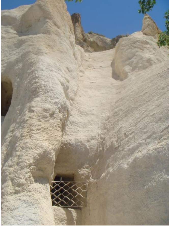
Şekil 4.7 : Azize Catherina Kilisesi güney cephesi kapatılan ikinci kat girişi ve yüzey kaplaması yapılan üst kısım.
