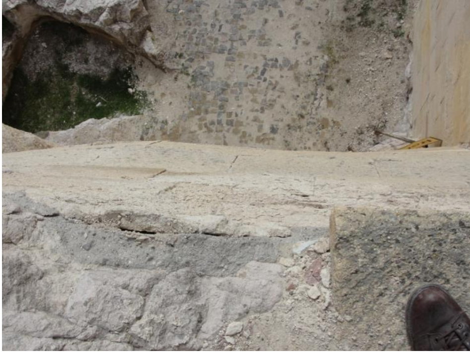
Şekil 4.54 : Manastır yemekhane girişine inşa edilen duvar üstten bakış.
