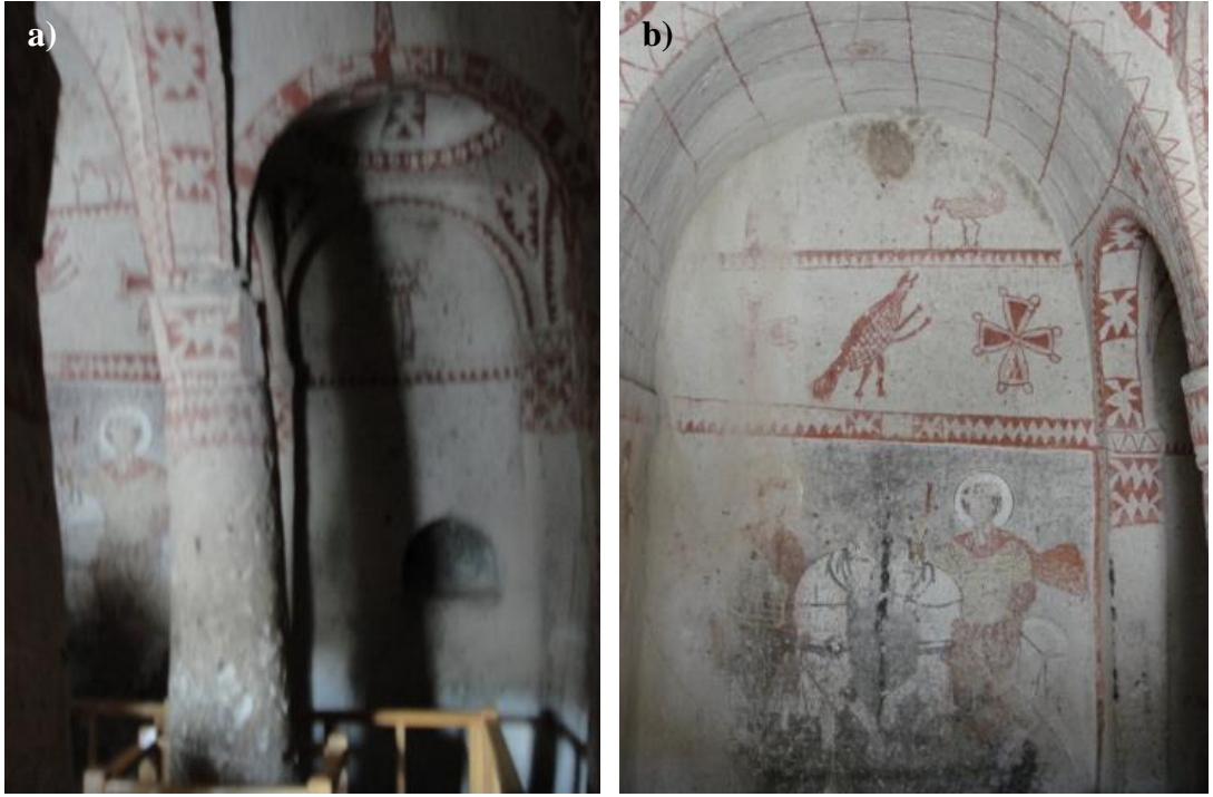
Şekil 4.25 : a) Azize Barbara Kilisesi sütunda kayma. b) Kuzey haç kolunda fresklerde sızıntıya bağlı renk bozulmaları.
