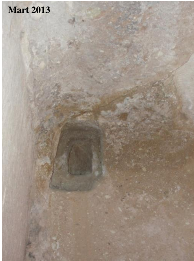
Şekil 4.140 : Sarıca Kilise trapeza bölümü neme bağlı tozuma ve küflenmeler.
