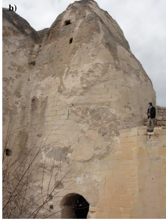
Şekil 4.55 : a) Ayazmaya onarım sırasında inşa edilmiş ikinci giriş ve doldurulan oyuklar. b) Kesme taş ile doldurulan oyuklar.
