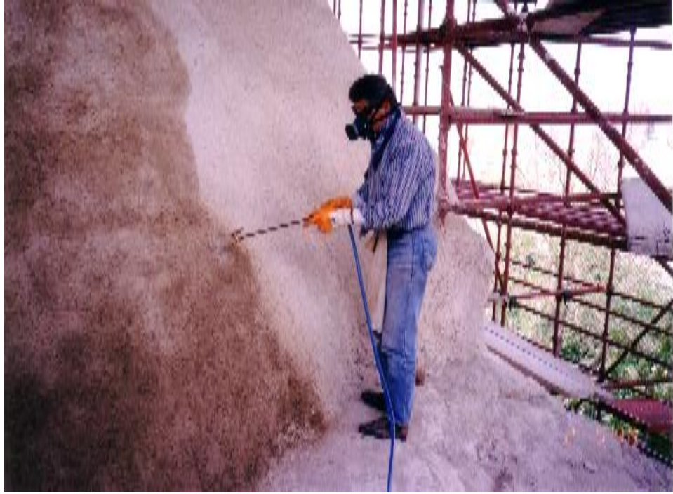
Şekil 4.102 : Hidrolik kireç harçlı sıva üzerine etil silikat uygulaması (R. İşler).
