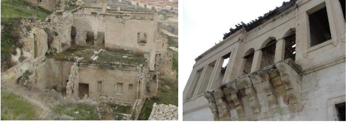
Şekil 2.5 : Kayakapı mah. yapım sistemi ve malzeme kullanımını gösteren geleneksel konut.
