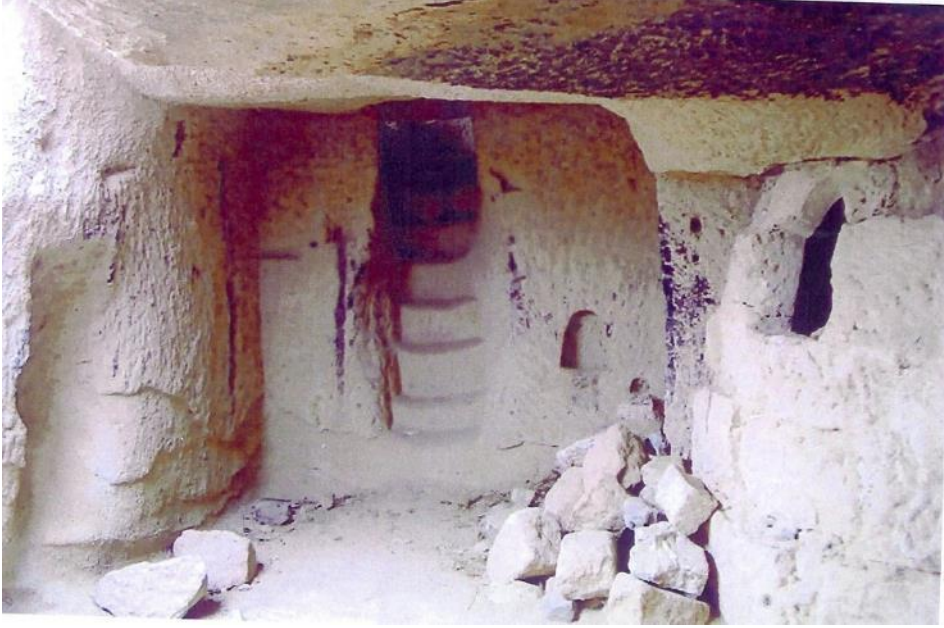
Şekil 4.234 : Aya Nikola Manastırı, 3 no'lu kilise apsisinin arkasındaki odanın güney tarafı, onarım öncesi (NKK Arşivi).
