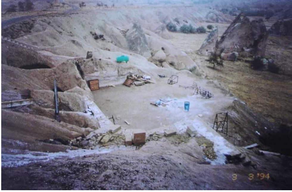
Şekil 4.125 : Sarıca Kilise üst örtüsü ve terası onarım sırası (NKK Arşivi).
