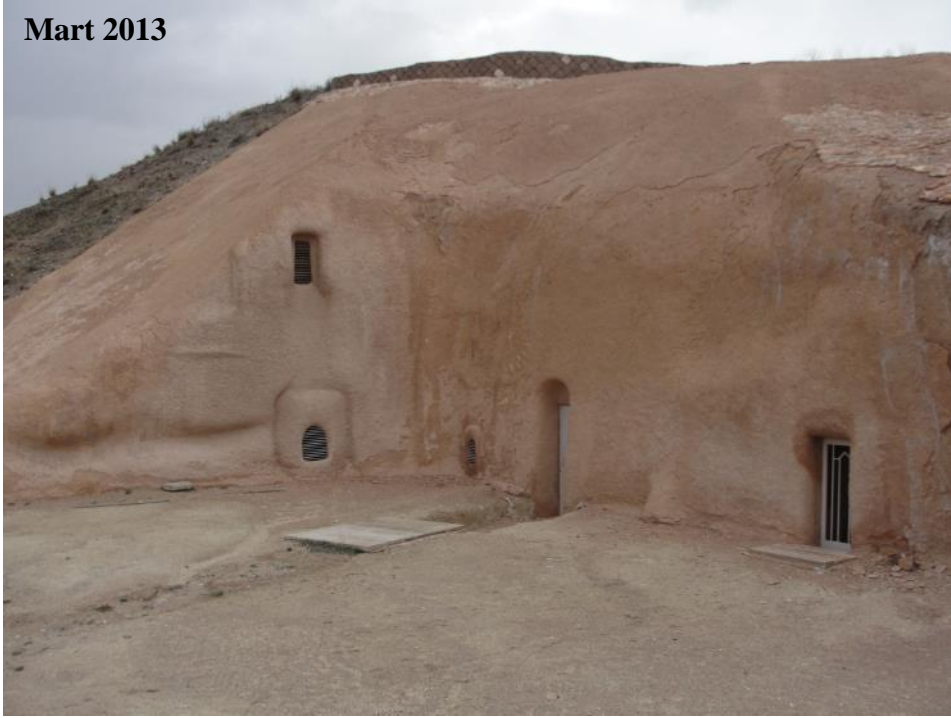
Şekil 4.128 : Sarıca Kilise güney cephesi, kilise ve narteks mekânlarının mevcut durumu.
