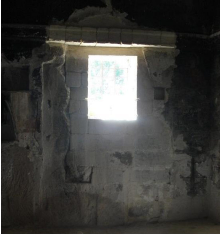
Şekil 4.67 : Archangelios Kilisesi onarım sırasında örülmüş duvar.
