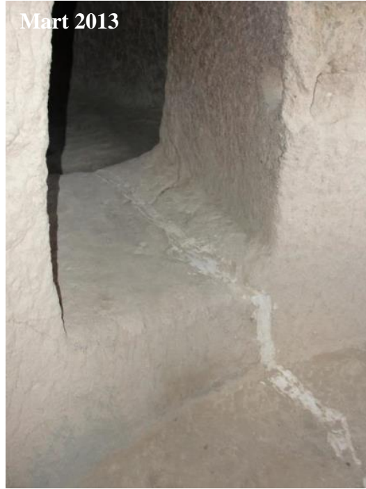
Şekil 4.247 : Aya Nikola Manastırı, batı cephesindeki doldurulmuş yarık ve çatlaklar.
