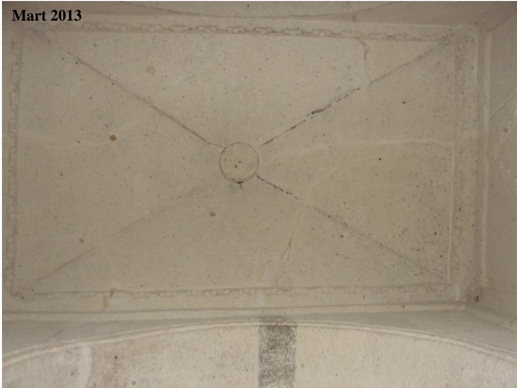
Şekil 4.171 : Kilise naosunun doğu tarafı, bemanın çapraz tonozlu tavanı.
