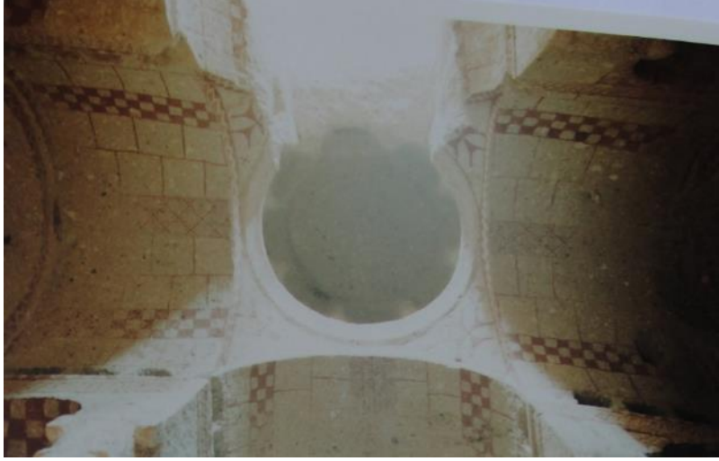
Şekil 4.114 : Sarıca Kilise naos tavanı merkezi kubbe; kuzey, güney, batı beşik tonozları ve bozulmuş olan doğu tonozu (NKK Arşivi).
