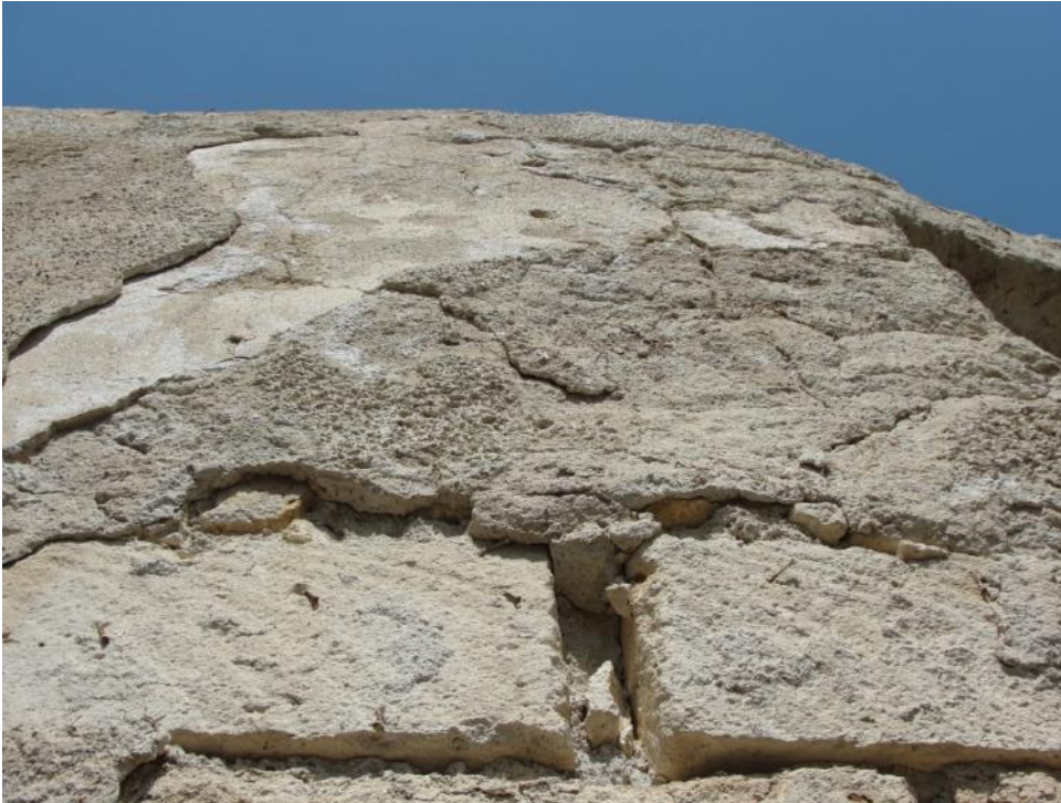
Şekil 4.33 : Elmalı Kilise girişindeki sıva tabakaları, boşalan derzler ve tuzlanmalar.
