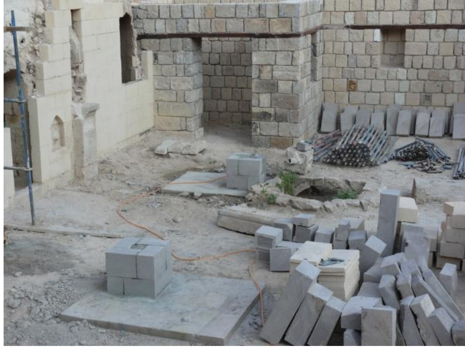
Şekil 4.257 : Aya Nikola Manastırı, avludaki yeniden yapım çalışmaları (F. Sağcan).
