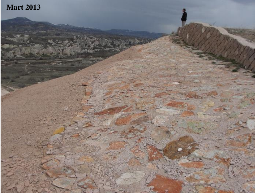
Şekil 4.135 : Sarıca Kilise üst örtüsü ve betonarme askı ve drenaj duvarı.
