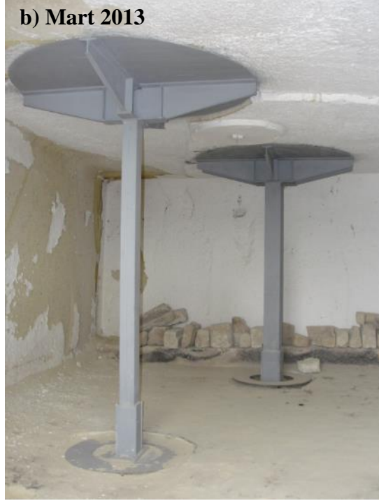
Şekil 4.162 : a) Kilisenin doğu cephesinde ki ve b) güney cephesindeki kayadamda sağlamlaştırma uygulamaları.
