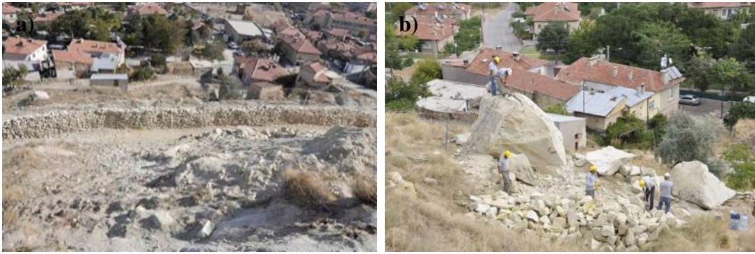
Şekil 3.40 : a) Kadıkalesi taş sepeti biçiminde inşa edilmiş bariyer. b) Düşürülen blokların parçalanıp hafriye edilmesi.
