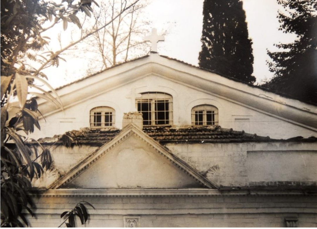
Şekil C.1 : Yapıya sonradan eklenen narteks, 1990.
