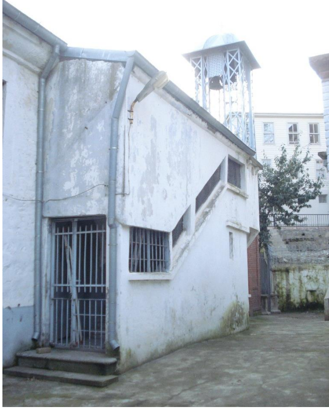
Şekil B.93: Kuzey cephesinde yapıya sonradan eklenen betonarme merdiven.
