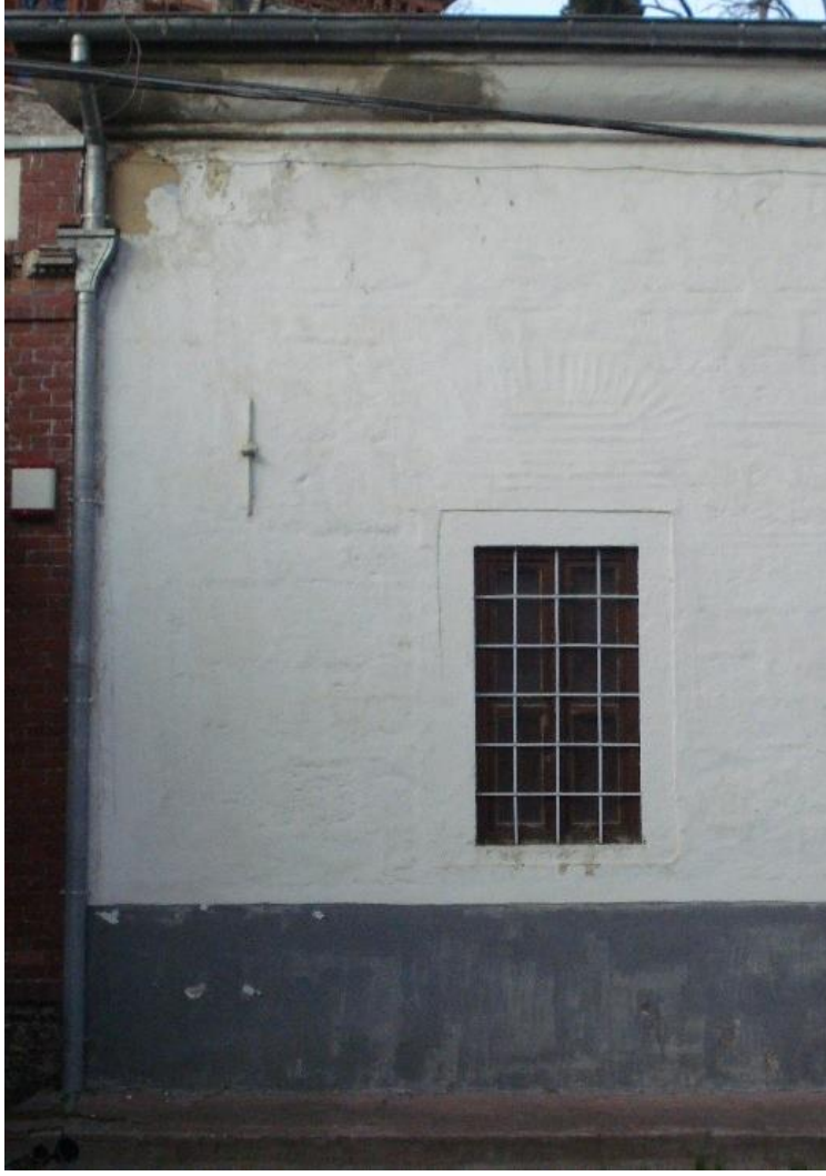
Şekil B.87: Güney cephesi gergi kılıcının konumu.
