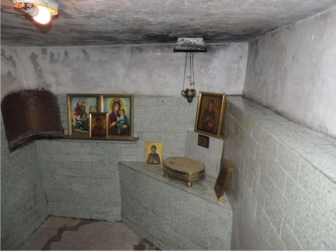
Şekil B.38: Ayazmanın seramik kaplı duvarları.
