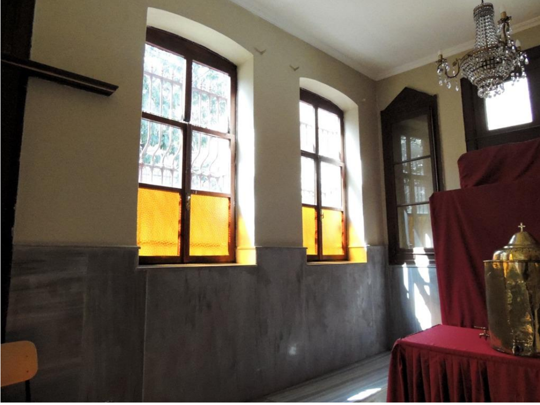
Şekil B.25: Narteks batı cephesinde bulunan basık kemerli P1 pencereleri.
