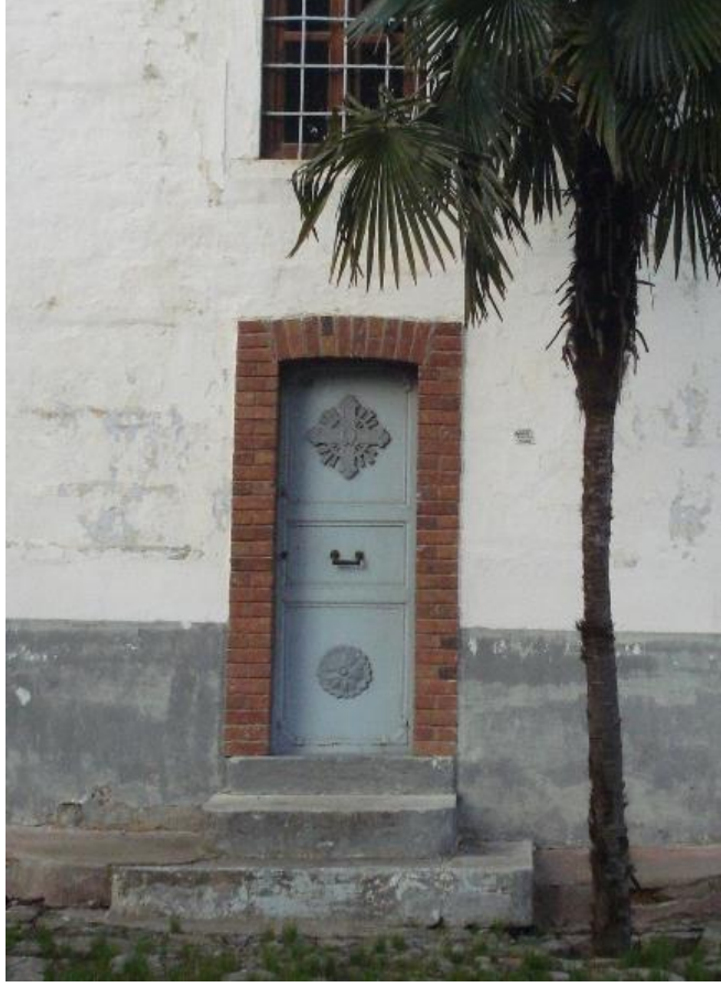
Şekil B.91: Güney cephesi bemaya giriş kapısı.
