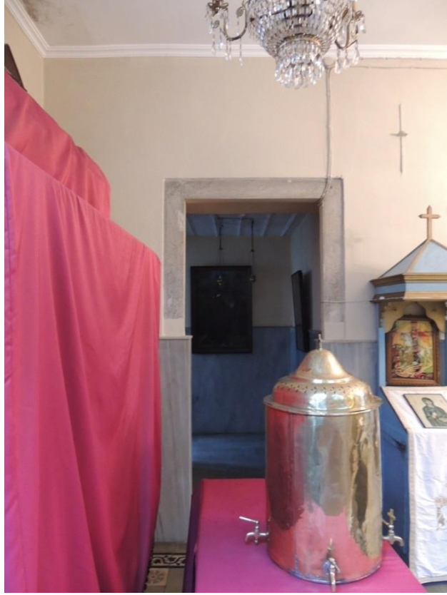
Şekil B.139: Narteksten Z07 mahalline geçilirken pencereden kapıya dönüştürülen açıklık.
