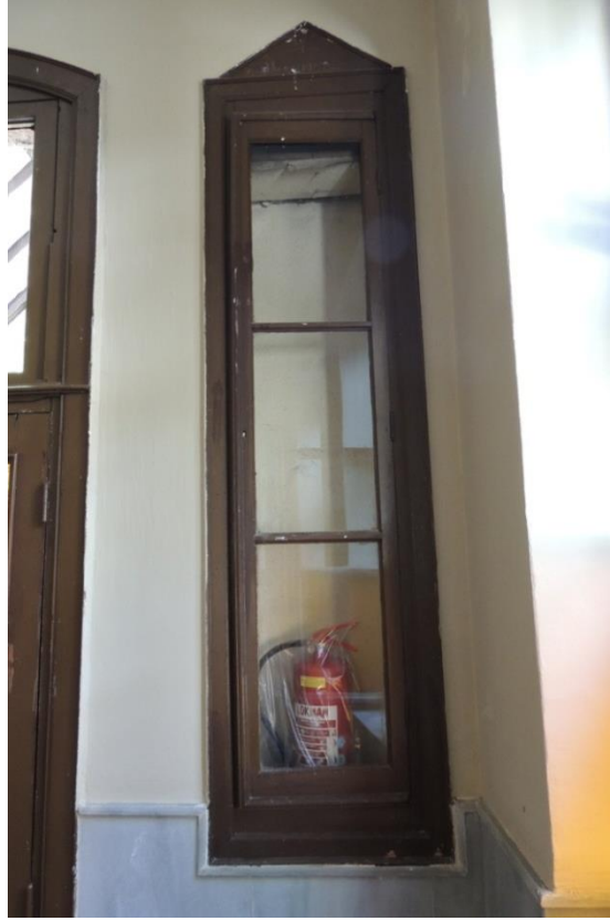
Şekil B.28: Narteks güney cephesi nişi.
