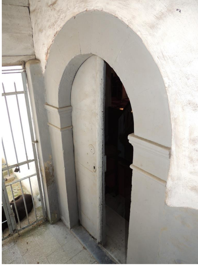
Şekil B.99: Kuzey cephesine açılan galeriye çıkış kapısı.
