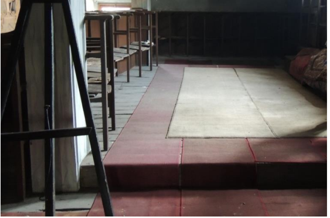
Şekil B.81: Galeri katı döşemesi yan ve orta nefler arasındaki kot farkları.
