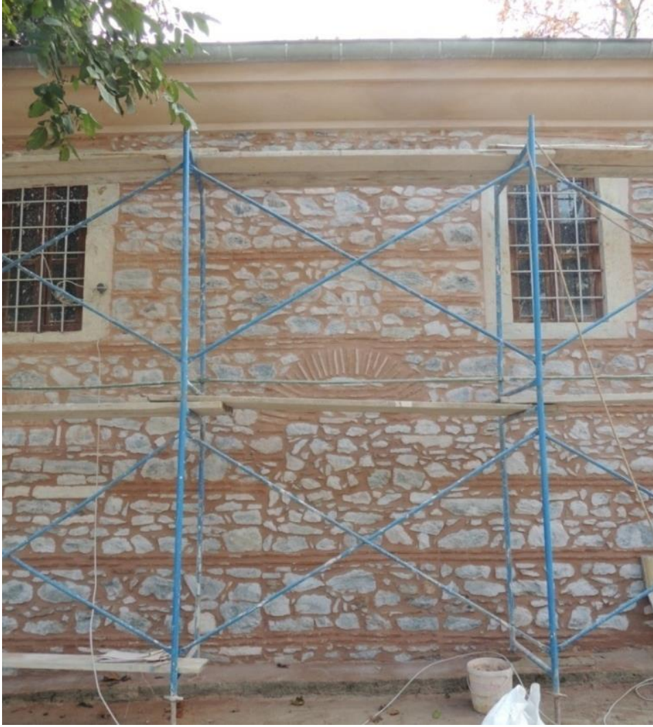
Şekil 5.2 : Kuzey cephedeki kapı kemer izi.
