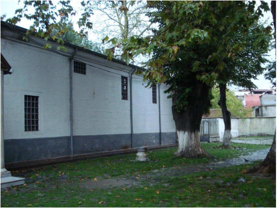
Şekil B.82: Güney cephesi batı tarafından görünümü.
