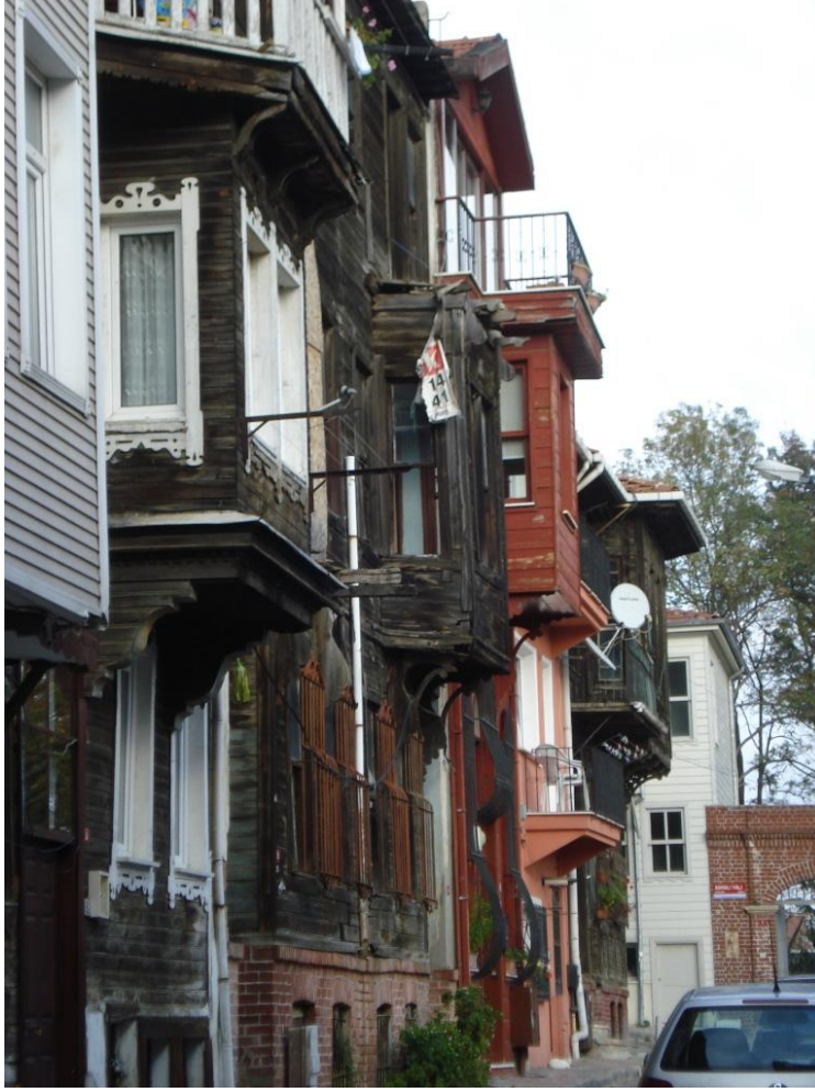
Şekil B.1: Mektep Sokağı batıdan doğuya bakış.
