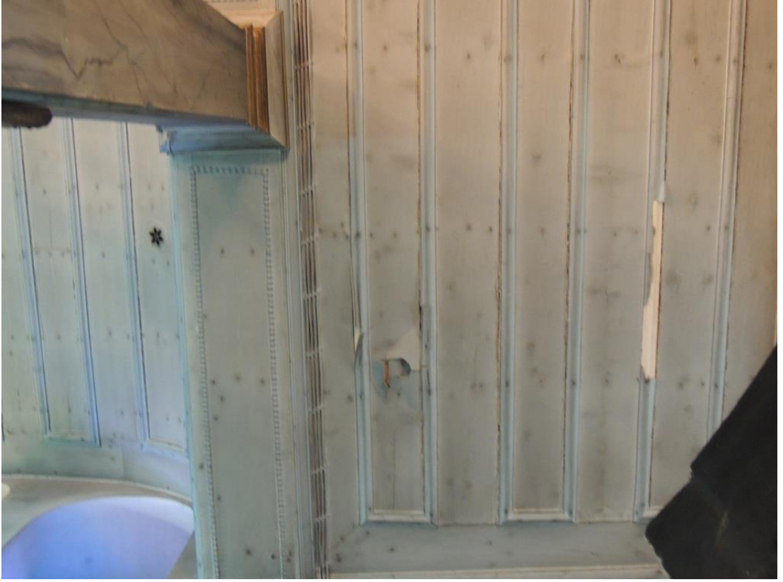
Şekil B.131: Yan neflerin düz, ahşap çıtalı tavan kaplaması.
