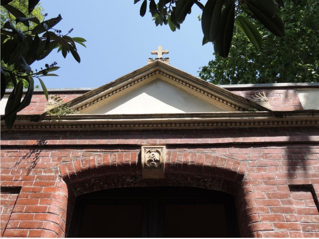
Şekil B.107: Batı cephesi kapı üzerindeki üçgen alınlık.
