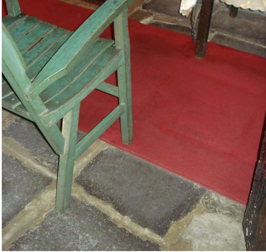
Şekil B.69: Bemanın güney yan nefi hizasındaki taş döşeme kaplaması.
