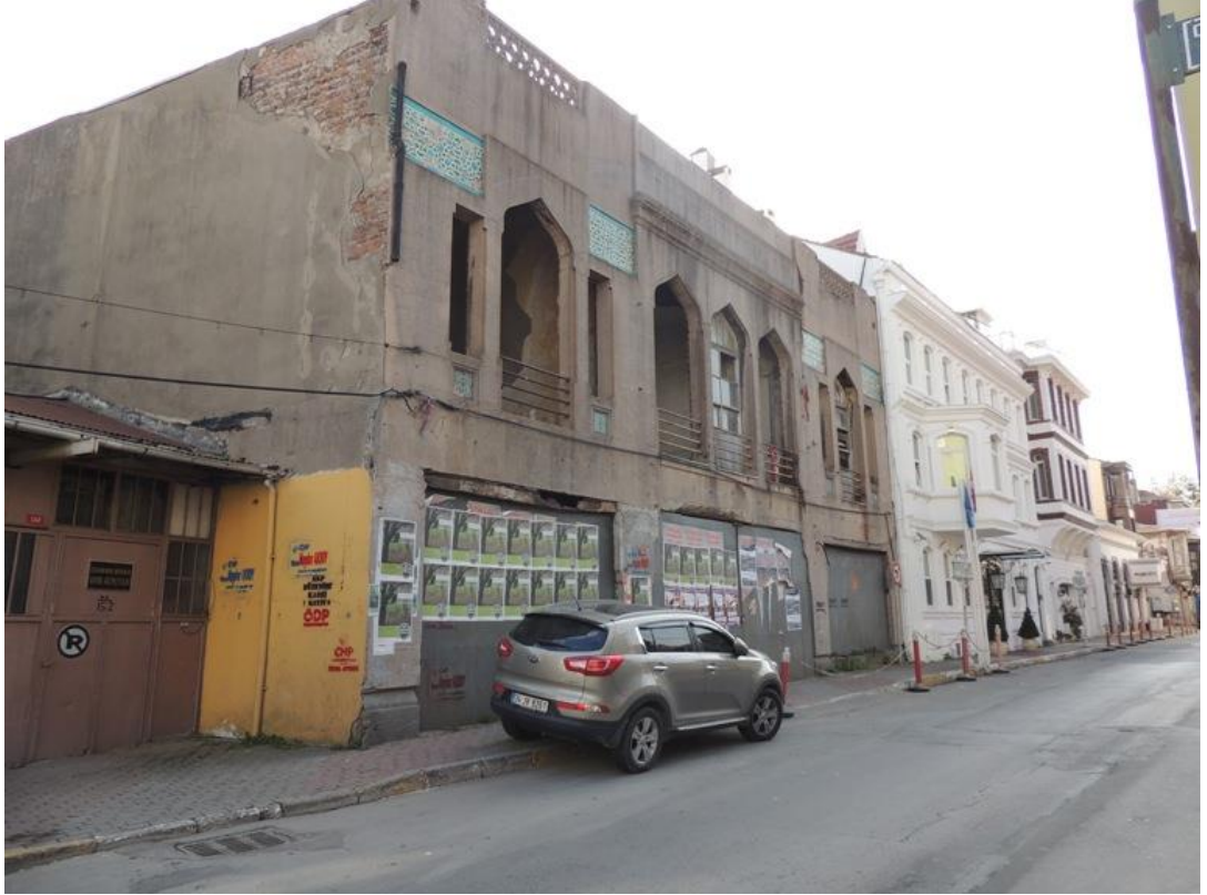
Şekil A.14 : Büyükdere İskelesi günümüzdeki durumu.
