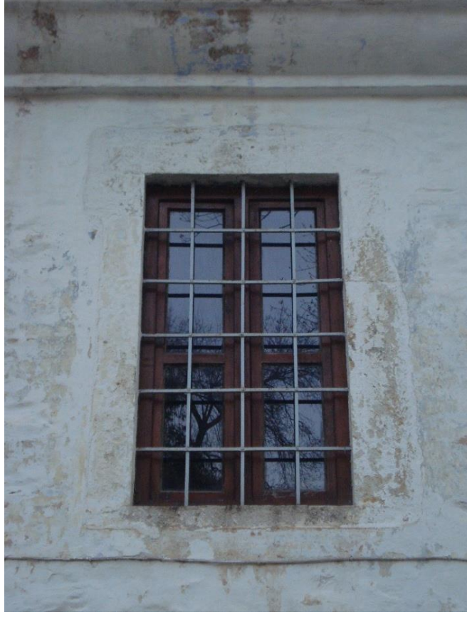
Şekil B.97: Kuzey cephesi ahşap pencerelerinden.
