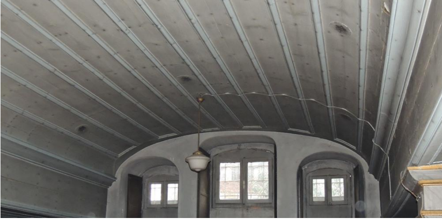
Şekil B.128: Orta nefin ahşap tonozu.
