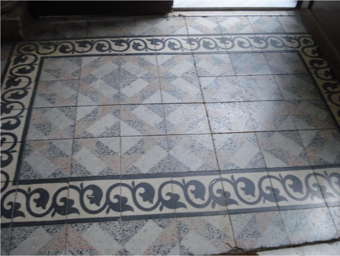
Şekil B.125: Z01 giriş mahalli döşeme kaplaması.
