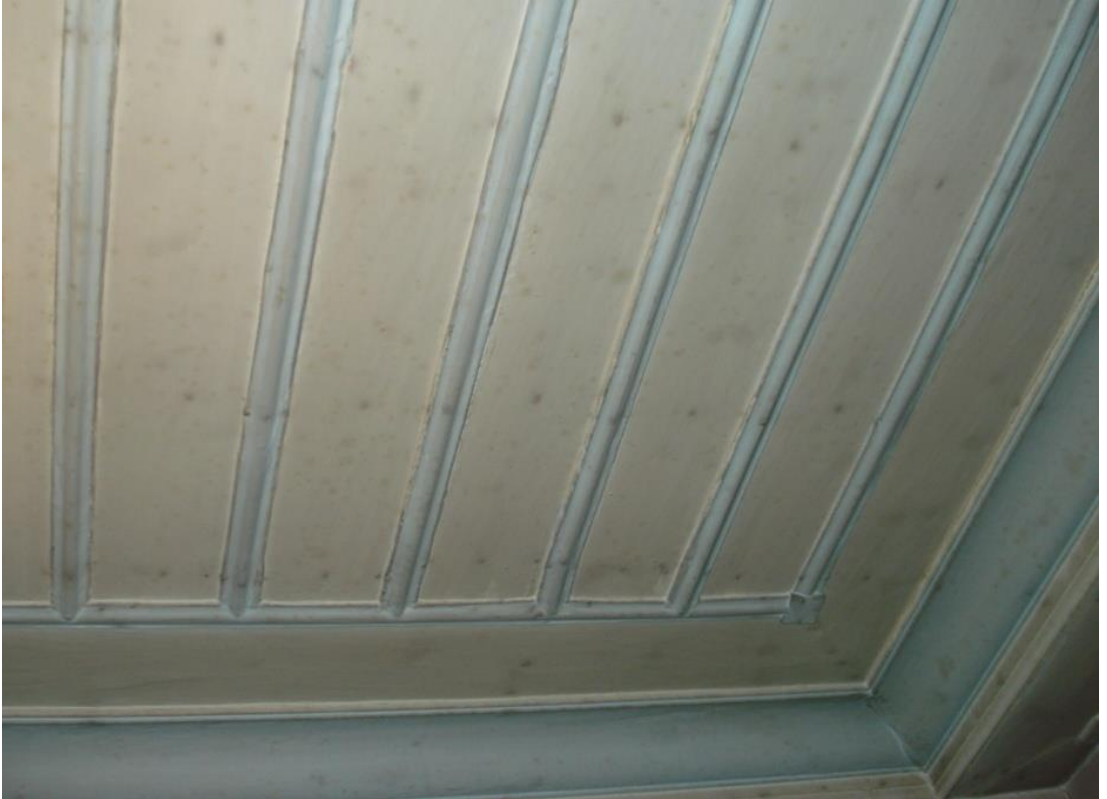
Şekil B.132: Galeri döşemesi altı ahşap tavan kaplaması.
