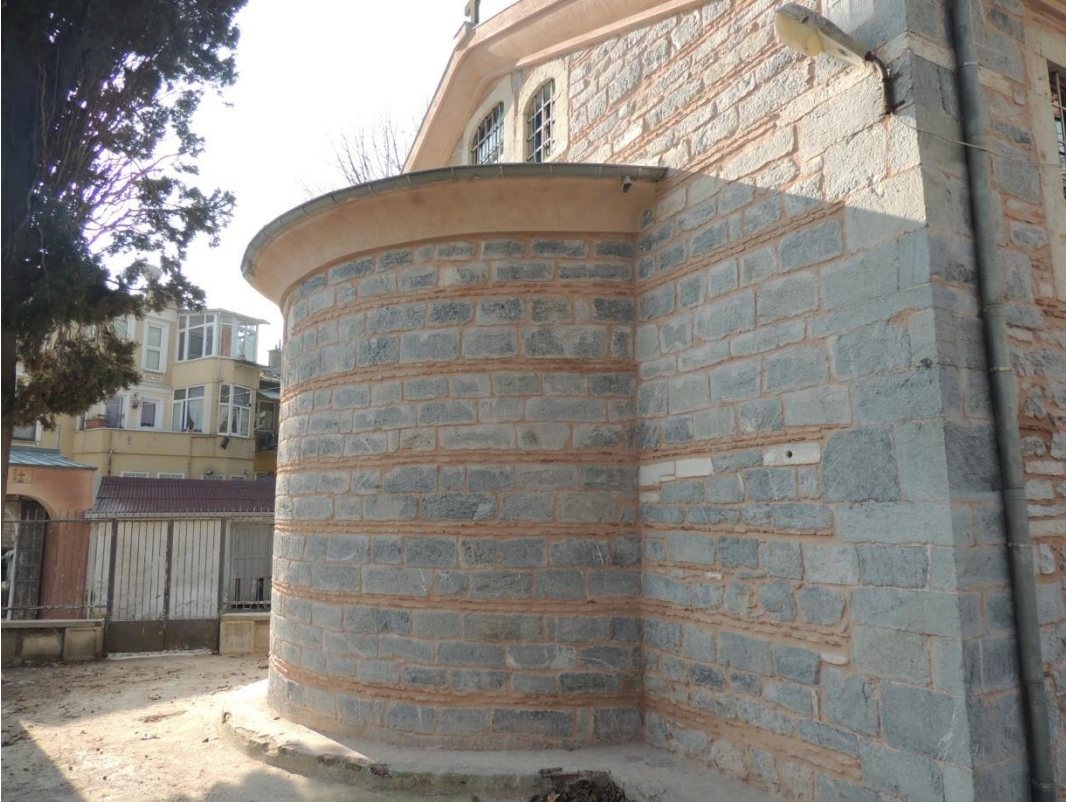
Şekil B.112: Sıva raspaı sonrası apsis.
