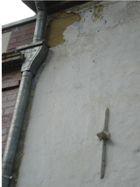
Şekil B.88: Güney cephesi gergi kılıcı.
