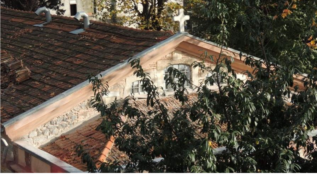
Şekil B.115: Sıva raspası sonrası batı cephesi.
