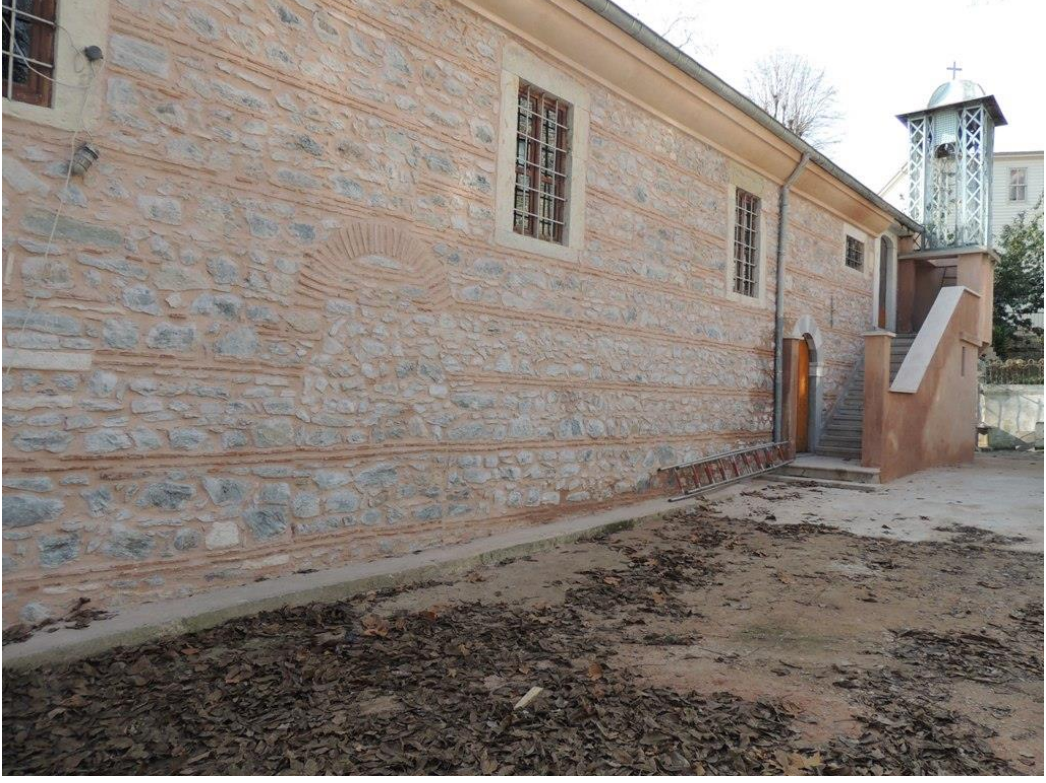
Şekil B.113: Sıva raspası sonrası kuzey cephesi.
