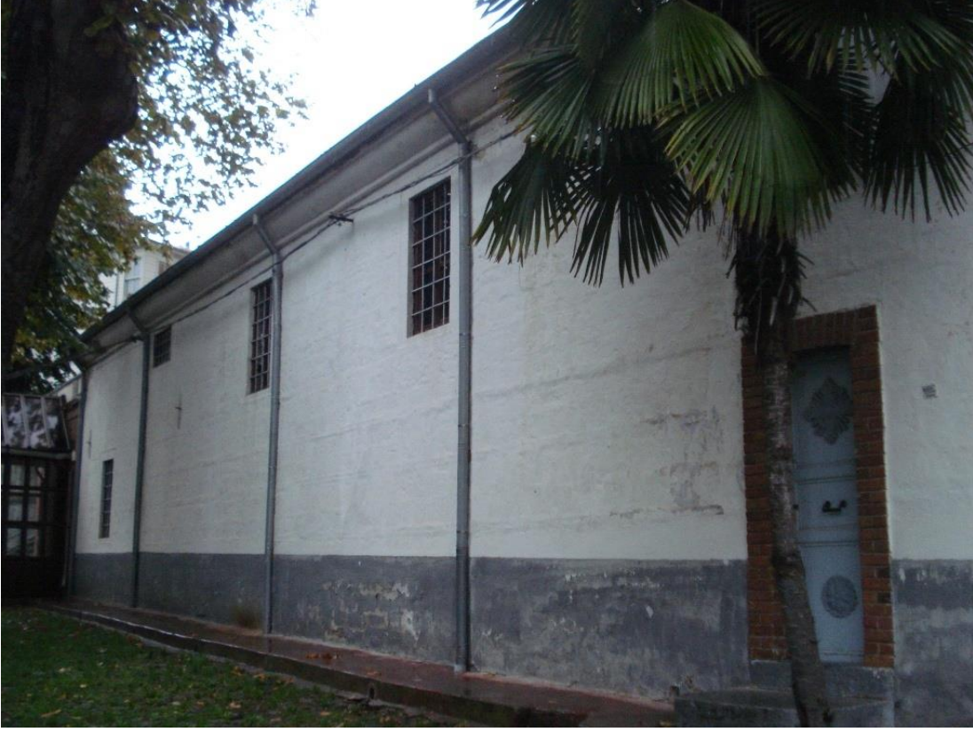
Şekil B.83: Güney cephesi doğu tarafından görünümü.
