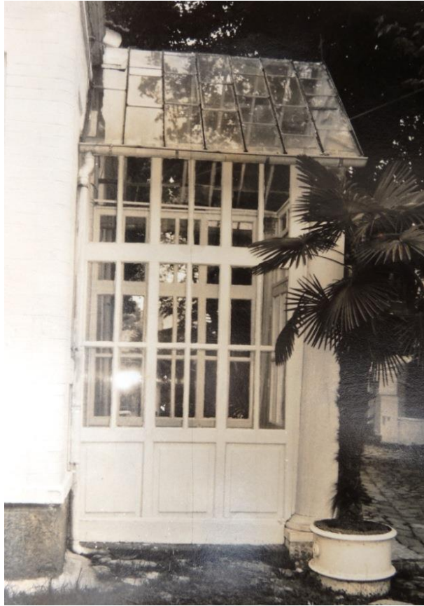
Şekil C.6 : Z01 giriş mekanı ahşap strüktürü.
