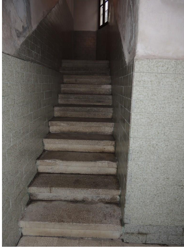
Şekil B.35: Ayazmaya (B01) inen Z08 mahallindeki basamakların kaplaması.
