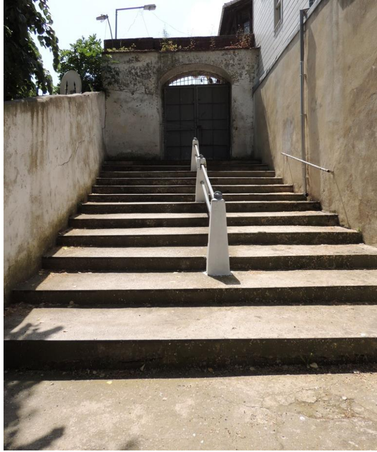
Şekil B.136: Bahçe merdivenleri 2. Kolu.
