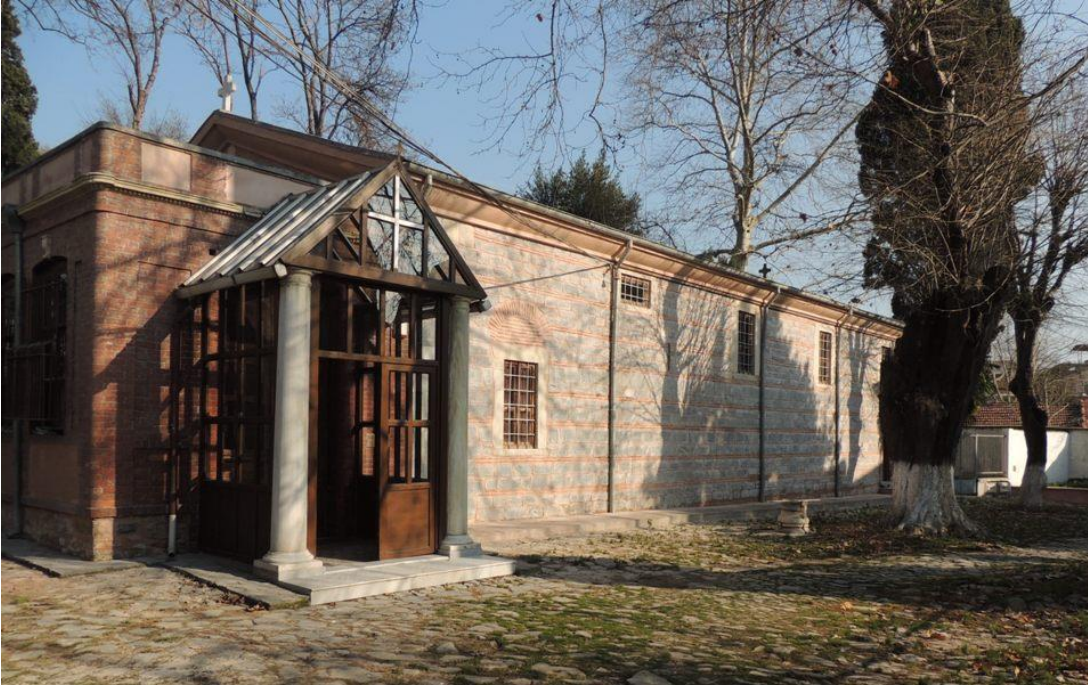
Şekil B.108: Sıva raspası sonrası güney cephesi genel görünümü.
