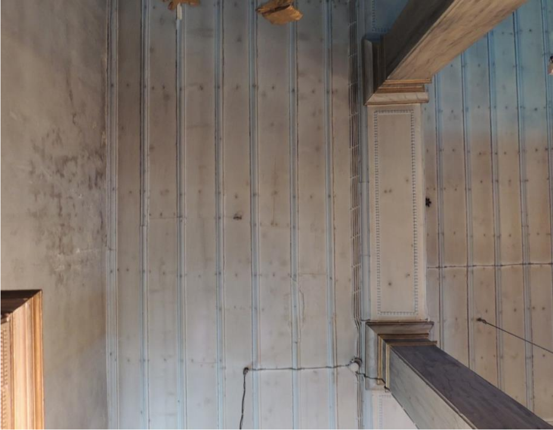
Şekil B.51: Naos mekanın ahşap çitalı tavan kaplamaları.
