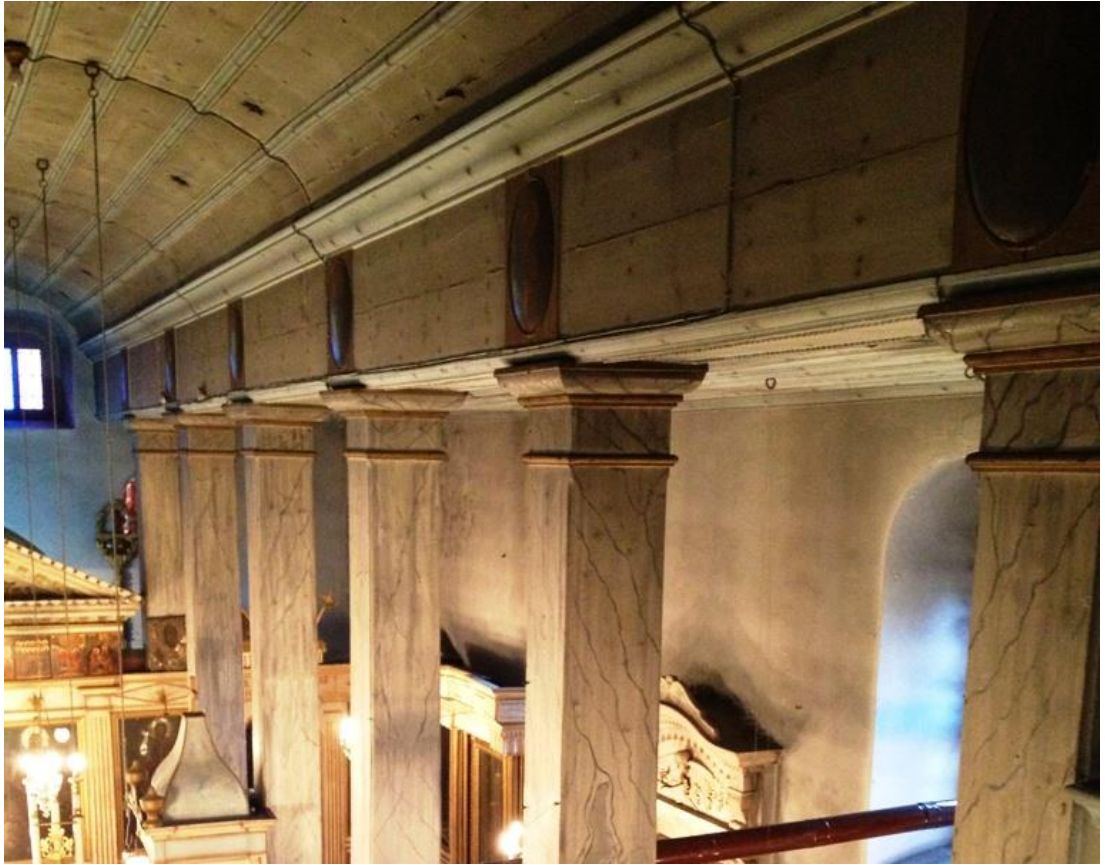
Şekil B.49: Ahşap ana kirişlerin arşitrav görüntüsü verilmiş hali.
