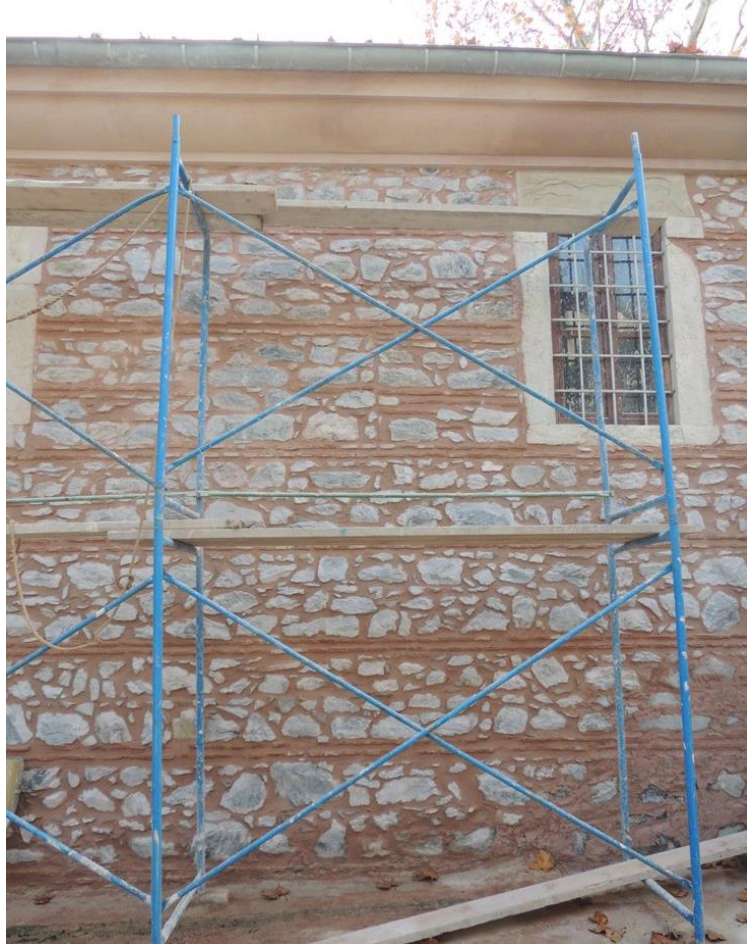
Şekil B.114: Kuzey cephesi tuğla-taş almasıklı düzeni.
