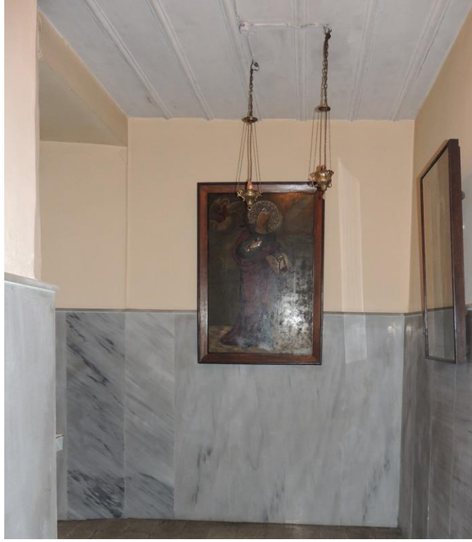
Şekil B.137: Z07 mahallinden dolayı sürekliliği bozulan tavan kaplaması.
