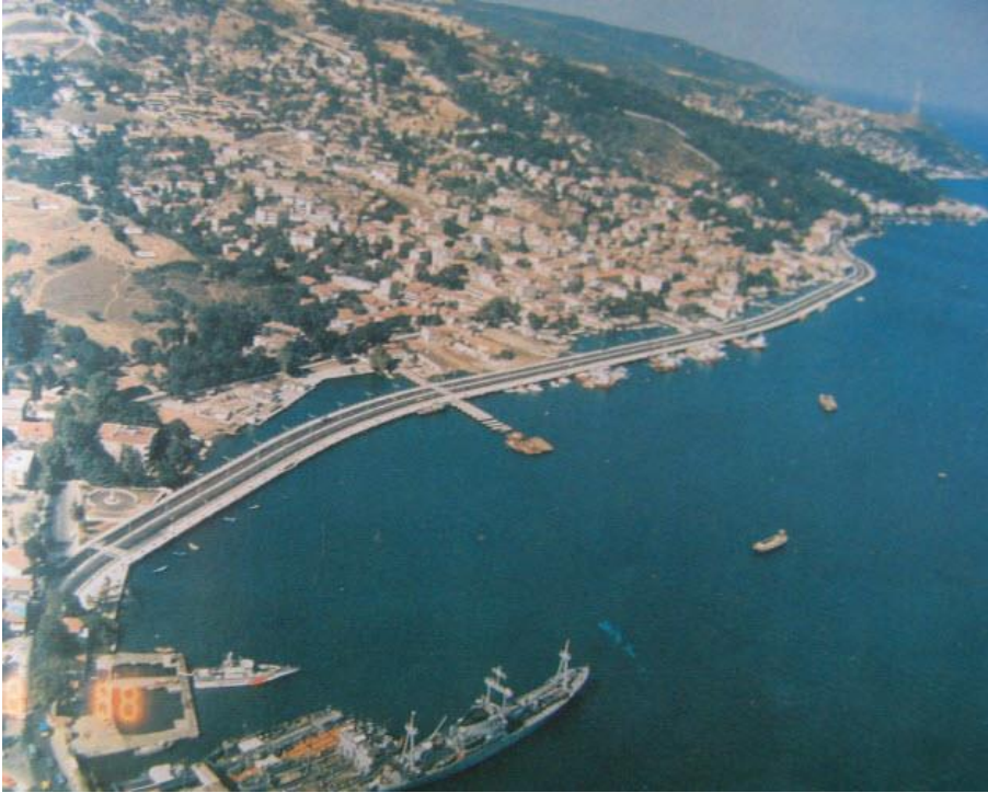
Şekil 2.3 : Kazıklı yolun yapımından sonra Büyükdere koyu 1 .
