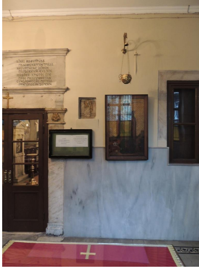
Şekil B.117: Narteksin mermer levha kaplı üzeri sıvalı duvarları.
