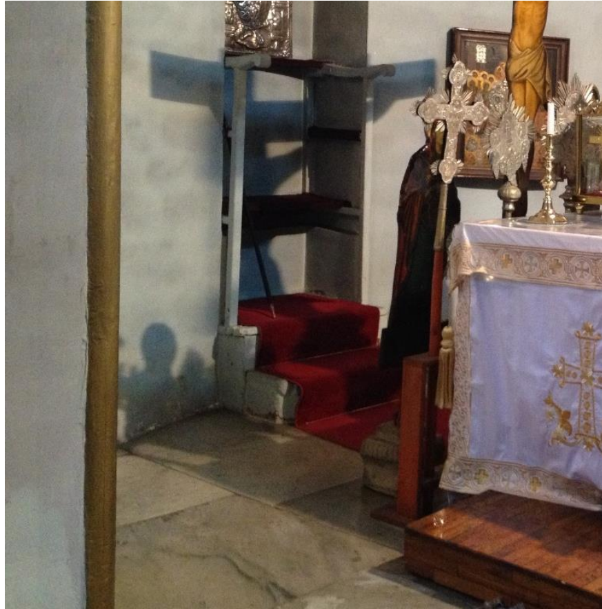
Şekil B.70: Bemanın mermer döşeme kaplaması.
