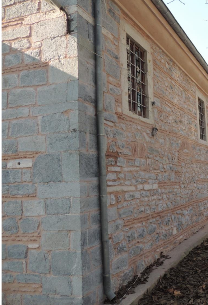
Şekil B.116: Köşelerde kullanılan kaba yonu taşlar.
