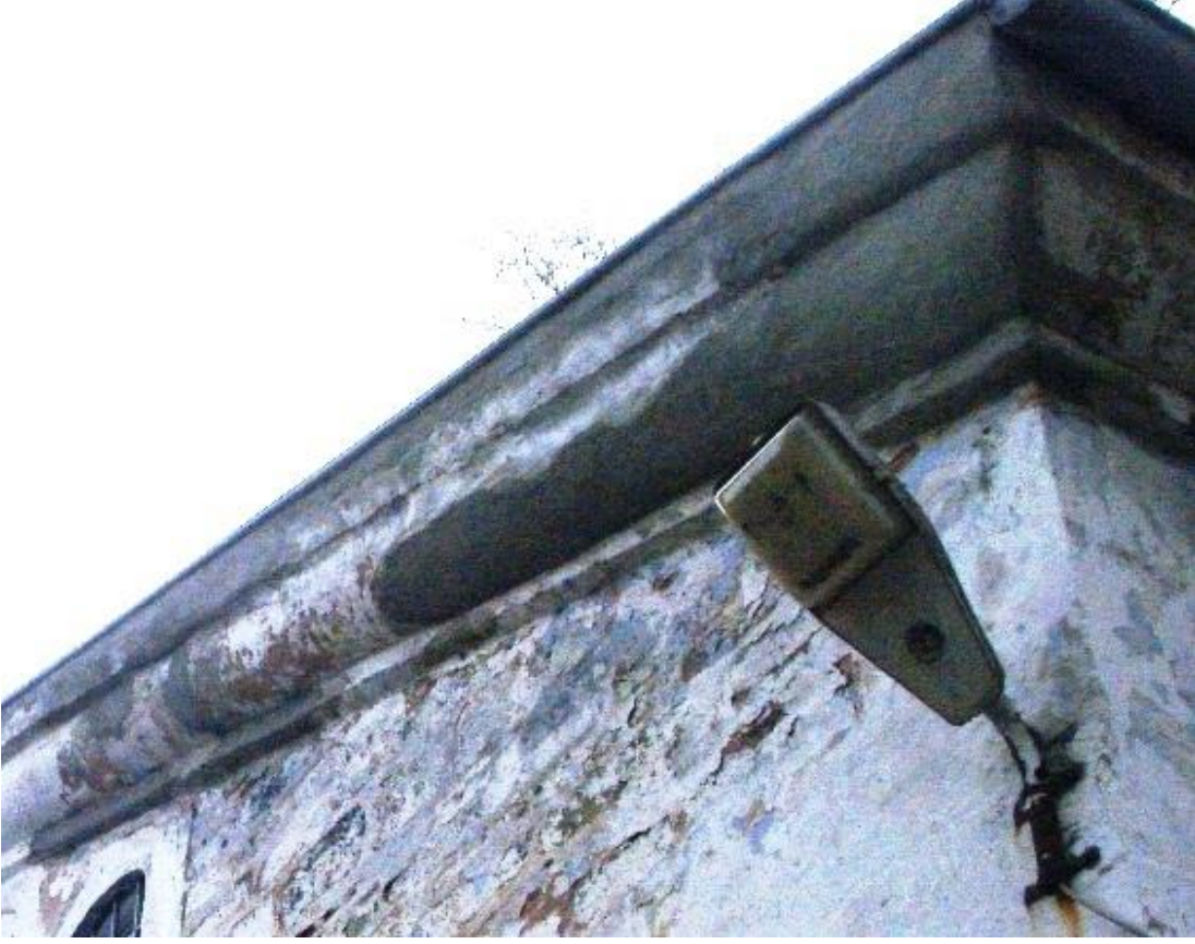
Şekil B.141: Çimento esaslı sıva kullanımının saçak silmesinin bozması.
