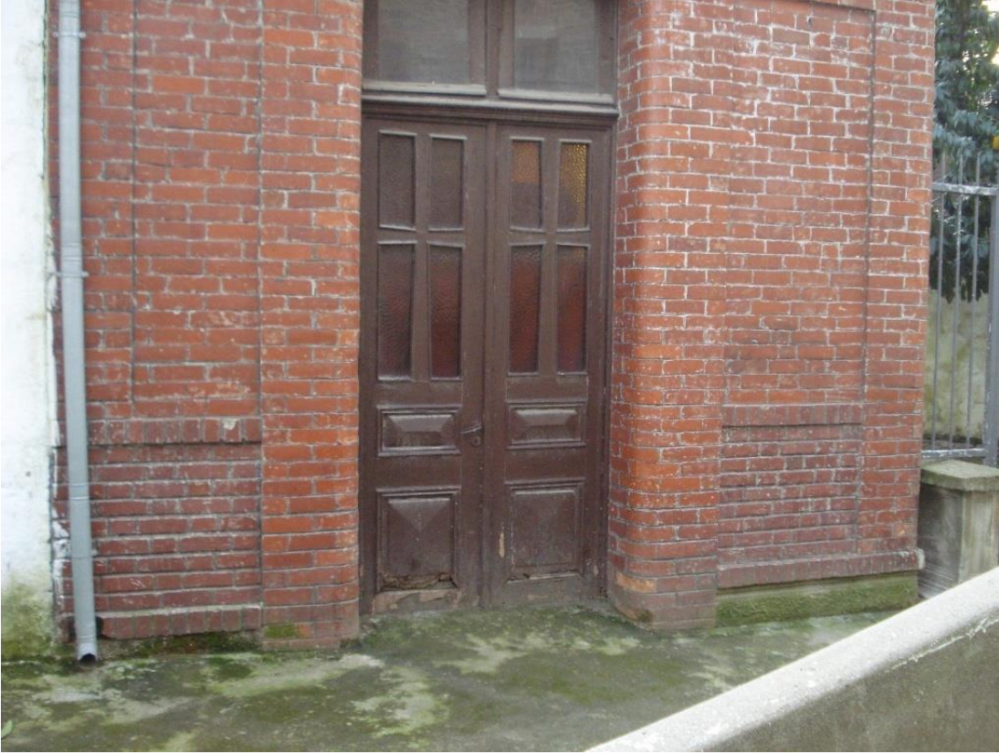
Şekil B.96: Narteksin kuzey cephesine açılan ahşap kapısı.
