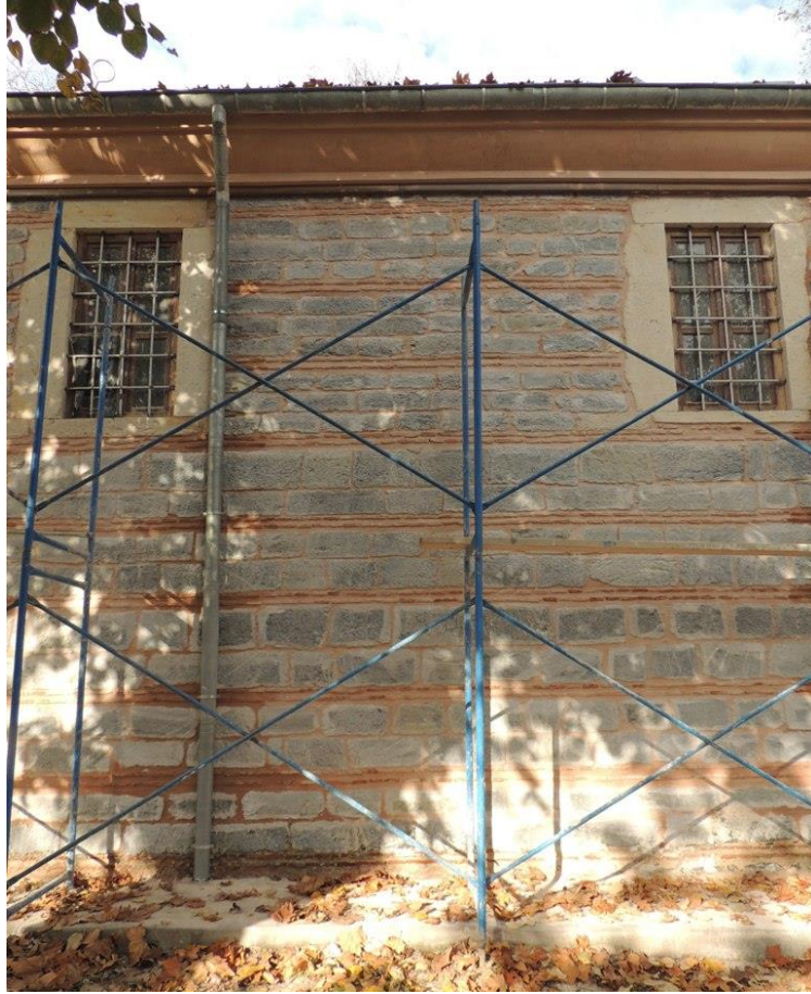
Şekil B.110: Güney cephesi tuğla-taş almasıklık düzeni.
