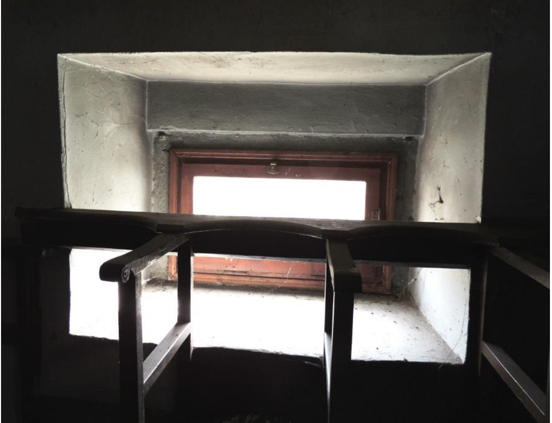
Şekil B.57: Galeri katı güney duvarı düz atkılı yatay pencere.
