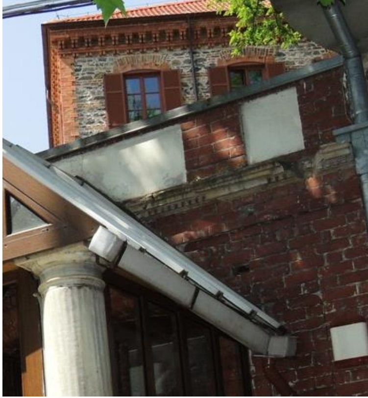
Şekil B.147: Taş silmelerde görülen parça kopmaları.
