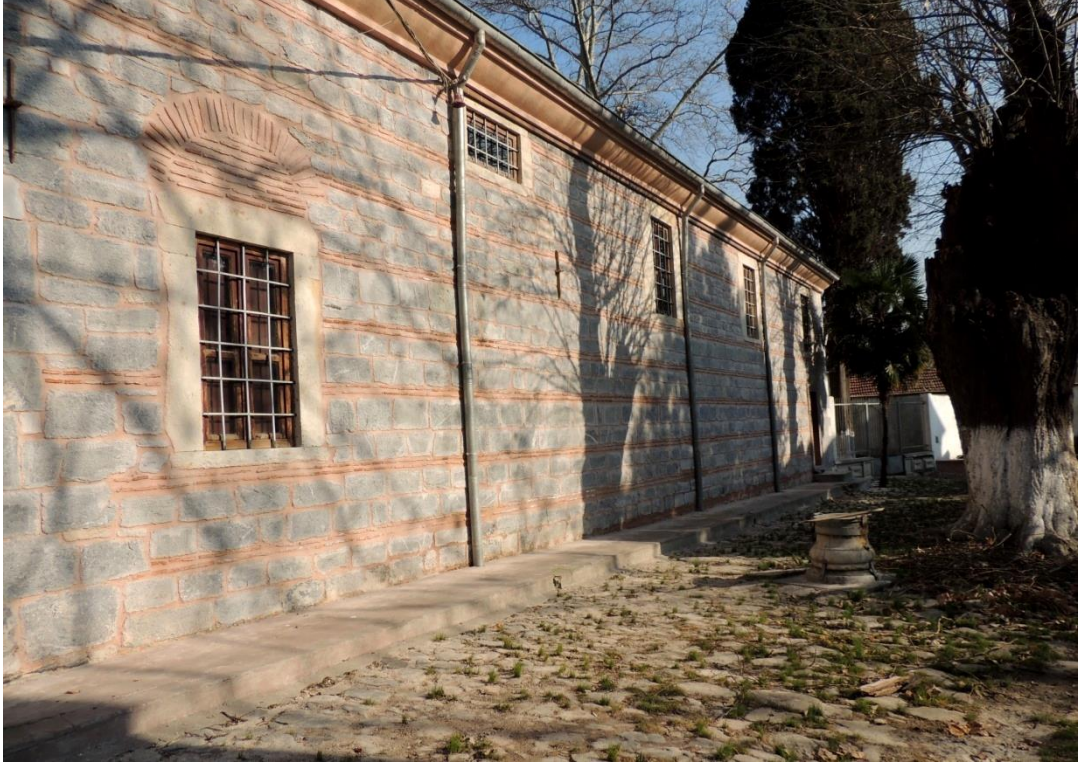
Şekil B.109: Sıva raspası sonrası güney cephesi.
