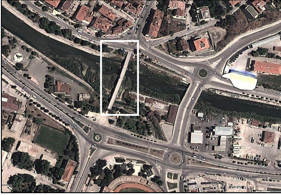
Şekil 5.597: Yeşilırmak Köprüsü konumu gmap uydu fotoğrafından işlenerek. (Bilgen, 2013).
