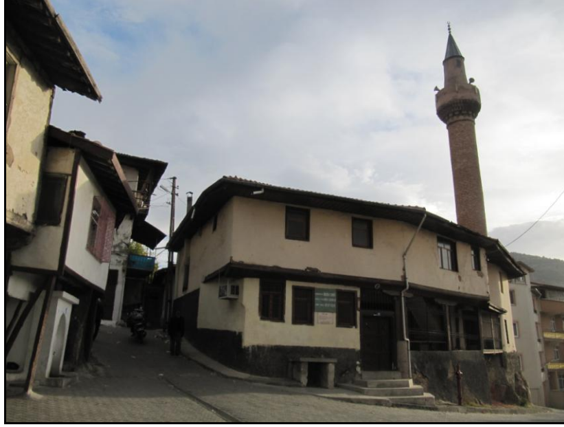
Şekil 5.180: Kaya Camii kuzeydoğu cephesi, (Bilgen, 2013).
