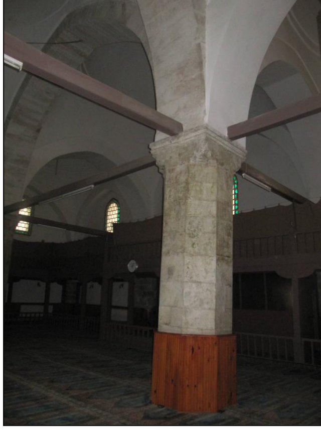
Şekil 5.113: Takyeciler camii iç mekan fil paye, (Bilgen, 2013).
