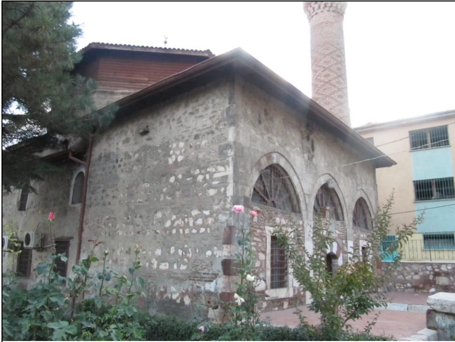
Şekil 5.48: Alaca Mescit kuzeydoğu cephesi, (Bilgen, 2013).
