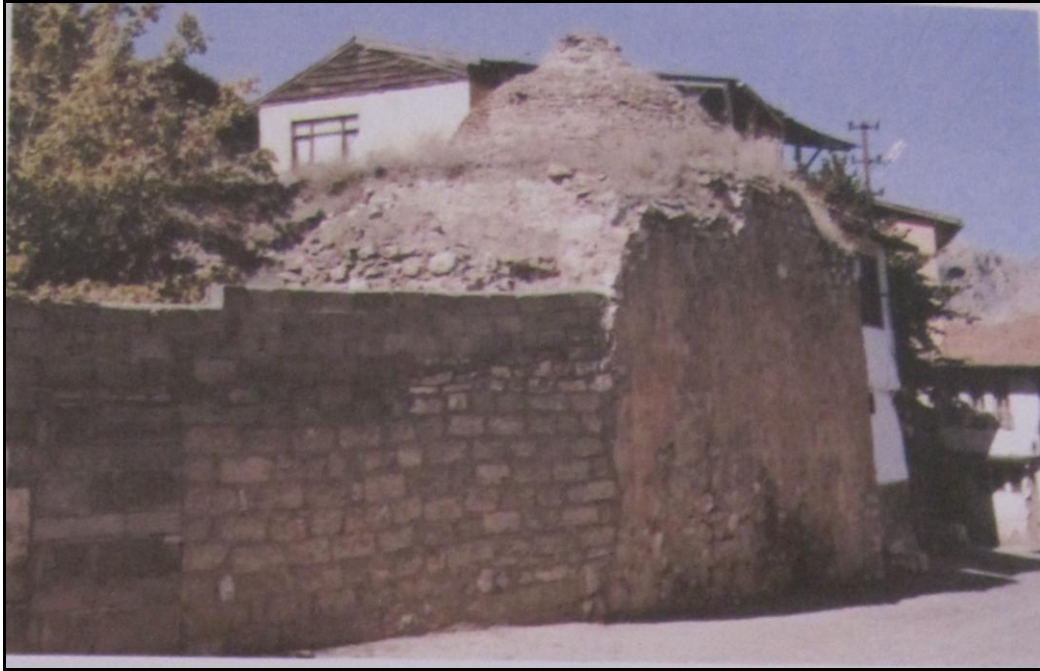
Şekil 5.488: Horu Hamamı güney cephesi, (Gündoėdu vd., 2006).
