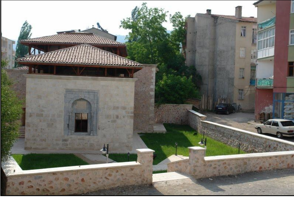
Şekil 5.350: Abdulmuttalip Tekke ve Zaviyesi batı cephesi, (İsaktaş, 2010).
