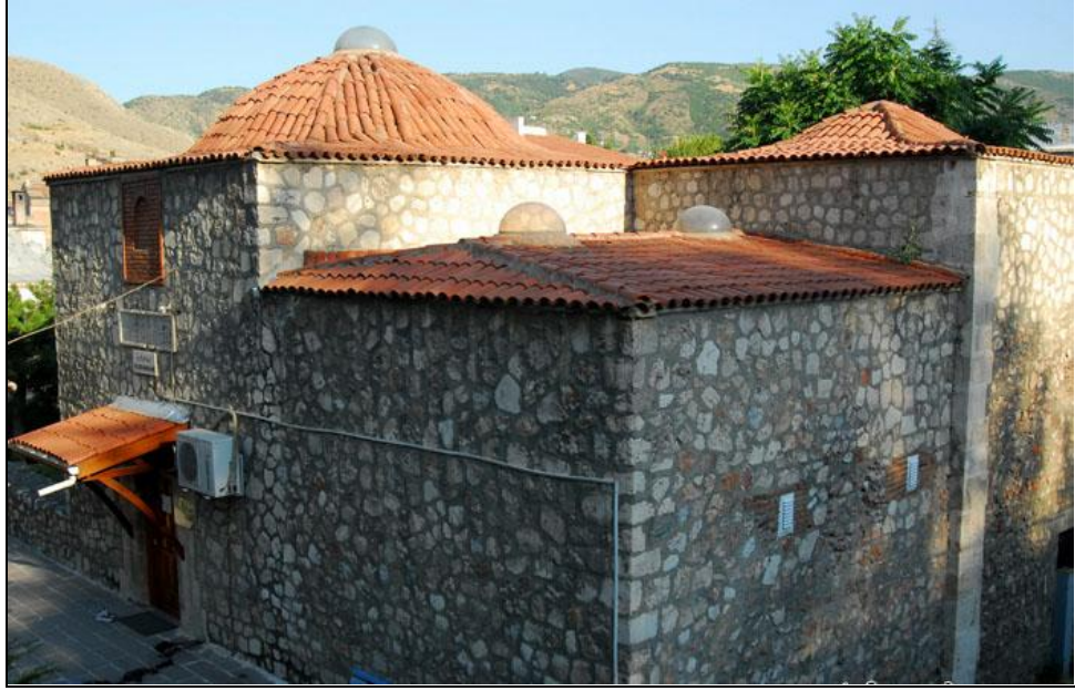
Şekil 5.32: Vezir Ahmet Paşa Mescidi ve Türbesi kuzeybatı cephesi. (Cambaz, 2011).
