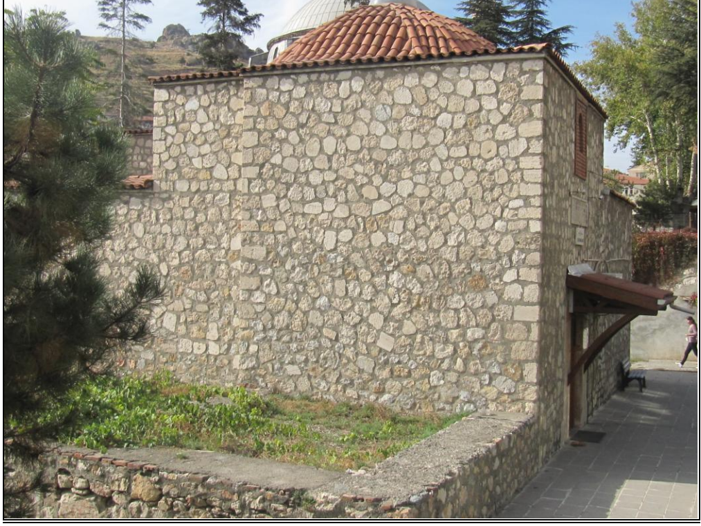
Şekil 5.34: Vezir Ahmet Paşa Mescidi ve Türbesi kuzeydoğu cephesi. (Bilgen, 2013).
