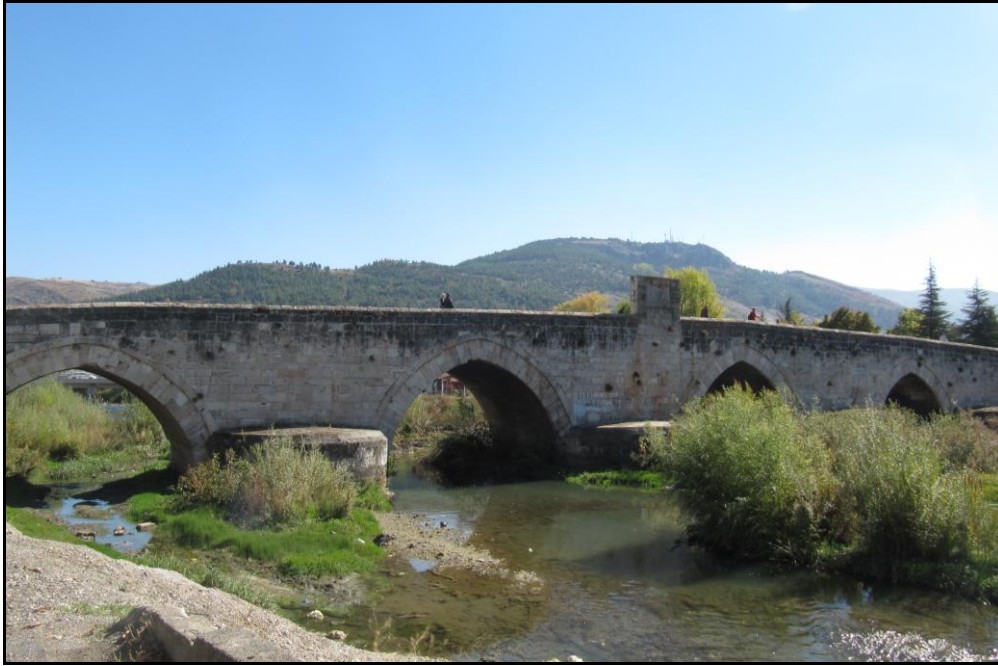
Şekil 5.600: Yeşilirmak Köprüsü, (Bilgen, 2013).
