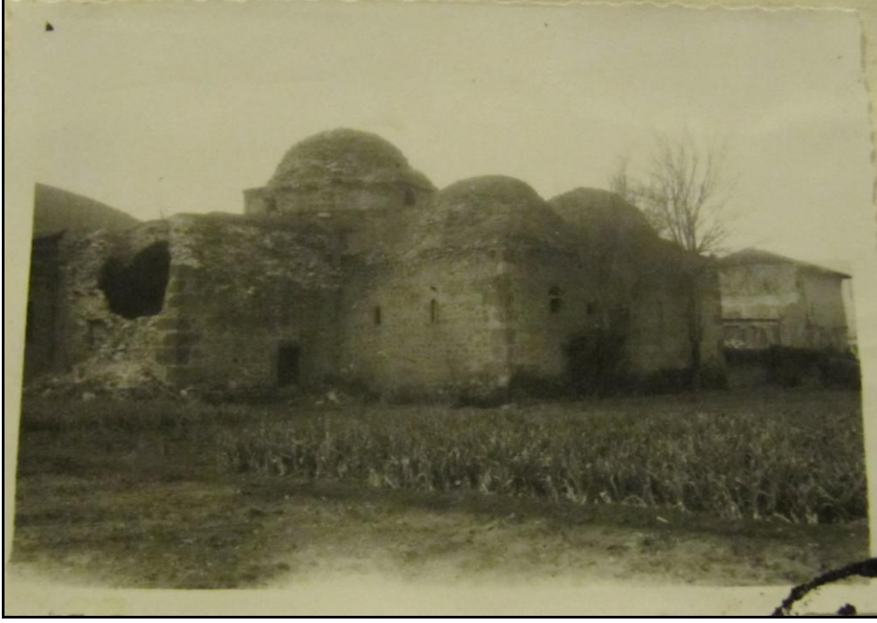
Şekil 5.301: Pir Ahmet Bey Türbesi güney cephesi hasarı 1945. (Savuran, 1931-1955).
