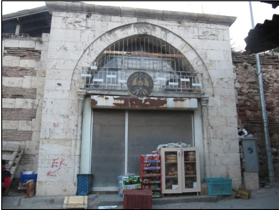
Şekil 5.572: Paşa Han kapısı, (Bilgen, 2013).
