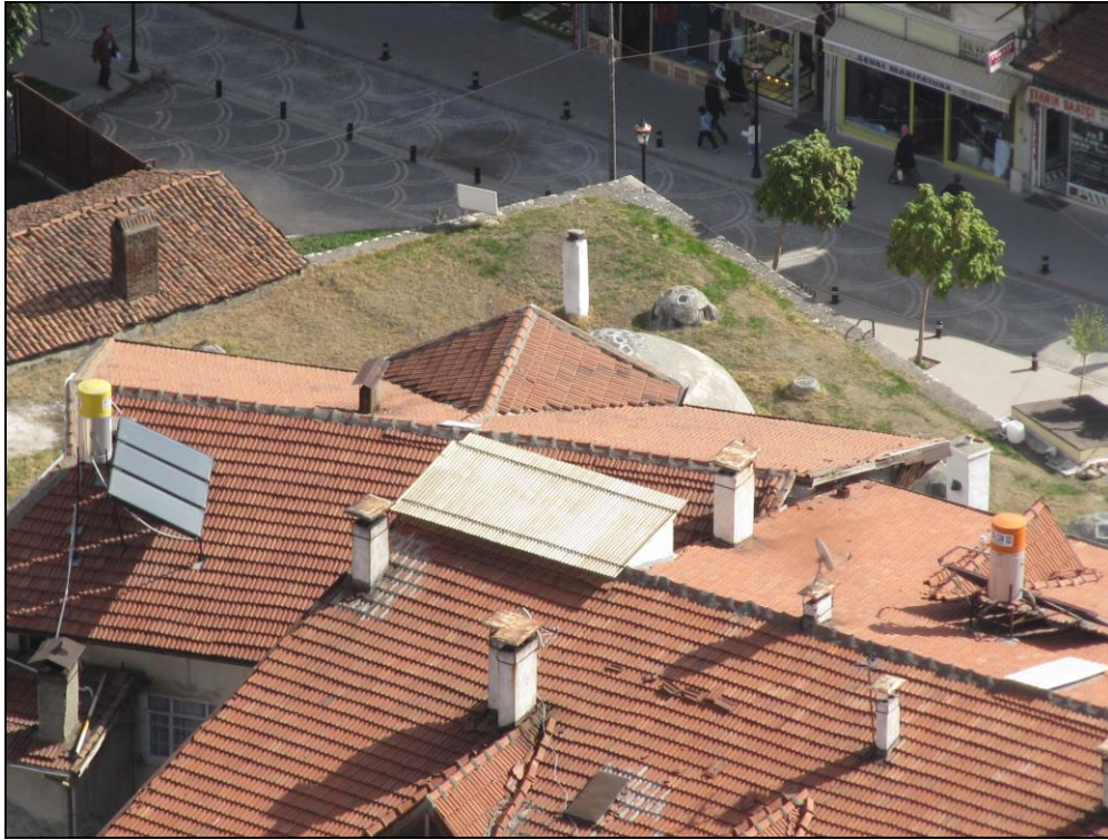
Şekil 5.443: Pervane Hamamı, (Bilgen, 2012).
