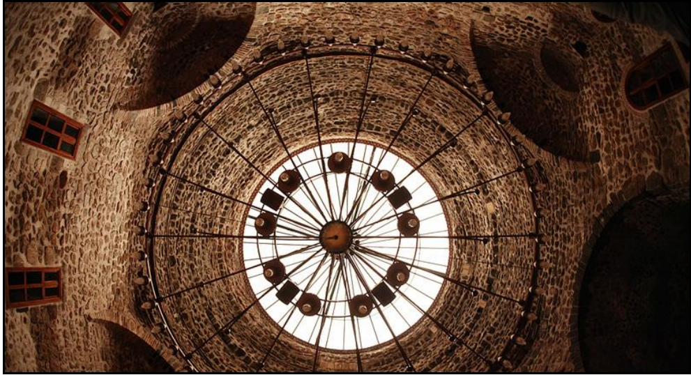
Şekil 5.382: Çukur Medrese -Yağıbasan Medresesi kubbesi, (Erdem, 2011).
