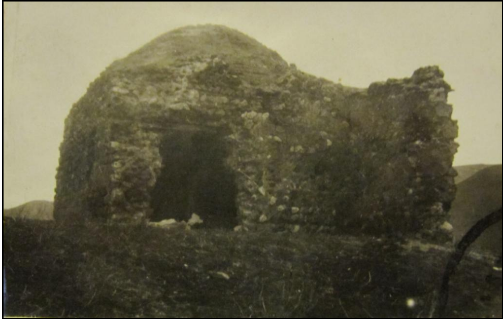
Şekil 5.206: Kümbet Tepe'de yer alan mescit harabesi 1945 batı cephesi. (Savuran, 1931-1955).
