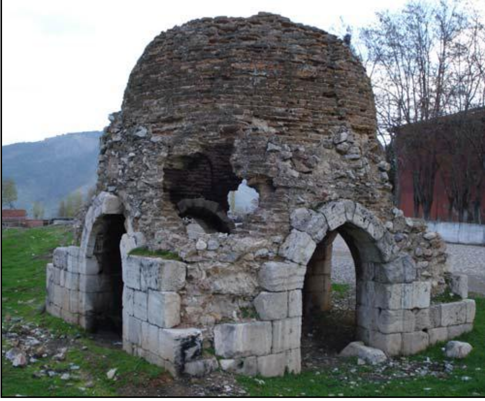
Şekil 5.274 : Erenler Türbesi restorasyondan önceki durum, (Akın, 2007).
