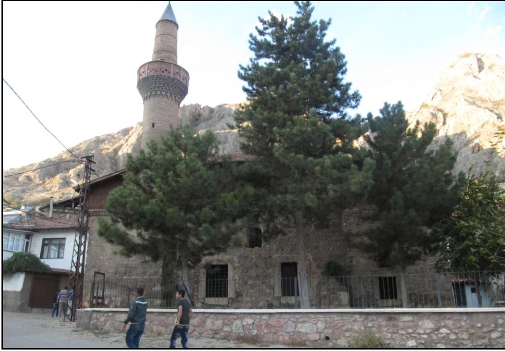
Őekil 5.124: Gdk Minare gney cephesi, (Bilgen, 2013).
