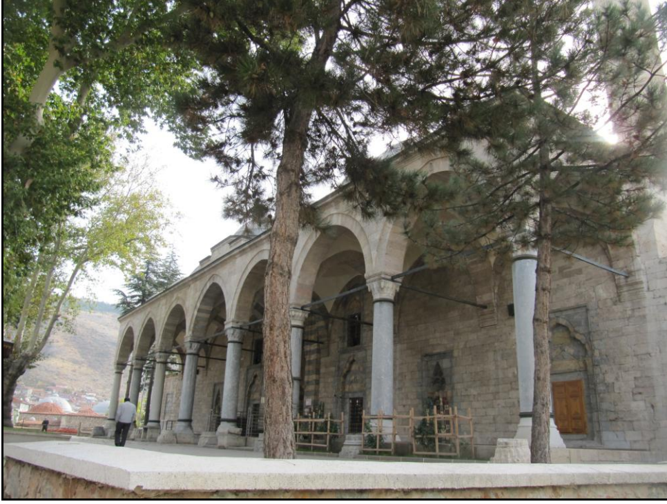
Şekil 5.162: Ali Paşa Camii kuzey cephesi, (Bilgen, 2013).
