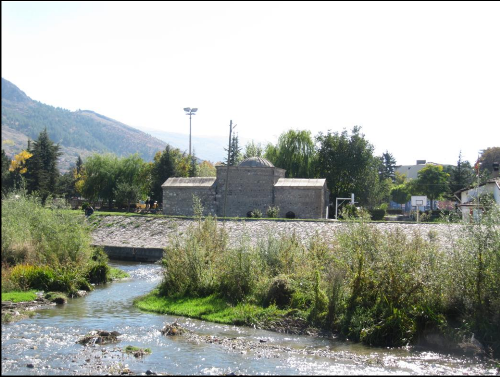
Şekil 5.256: Şeyh Meknun Türbesi kuzeydoğu cephesi, (Bilgen, 2013).
