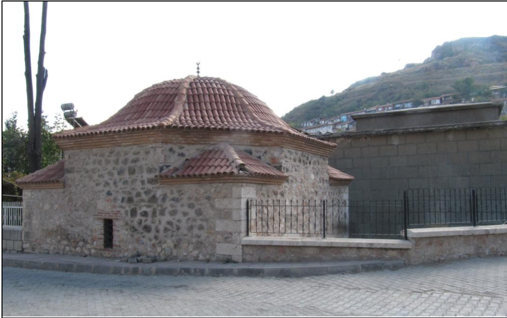
Şekil 5.68: Hacı Turhan Mescidi kuzeybatı cephesi, (Bilgen, 2012).
