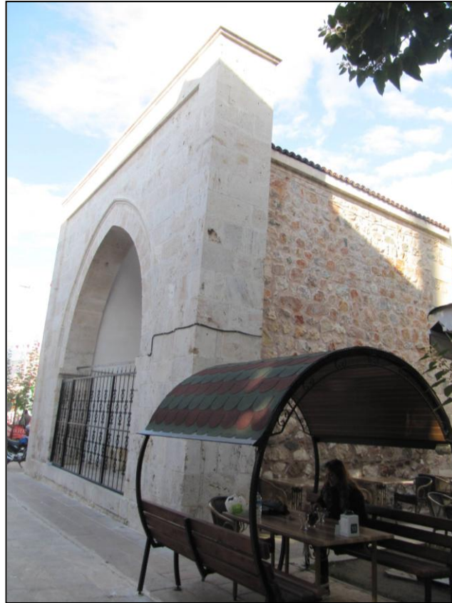
Şekil 5.307: Pir Ahmet Bey Türbesi güneydoğu cephesi, (Bilgen, 2013).
