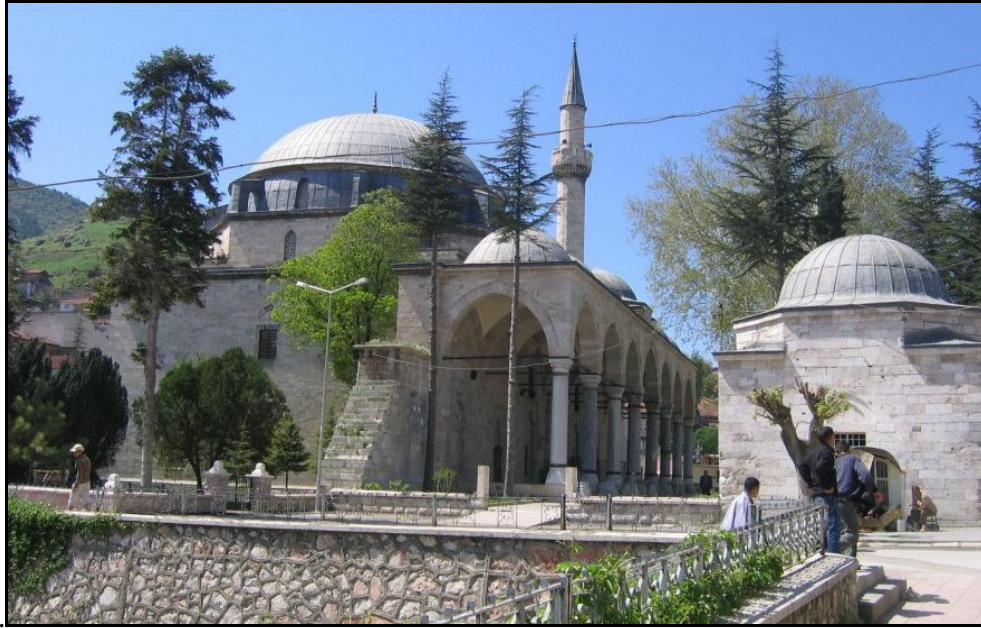
Şekil 5.163 : Ali Paşa Camii kuzeydoğu cephesi, (Umut, 2008).
