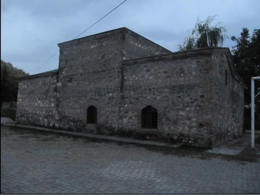
Şekil 5.255 : Şeyh Meknun Türbesi kuzeybatı cephesi, (Bilgen, 2013).
