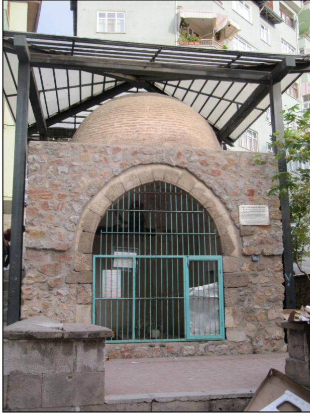
Şekil 5.261: Murat (Sevdekâr) Türbesi batı cephesi, (Bilgen, 2013).
