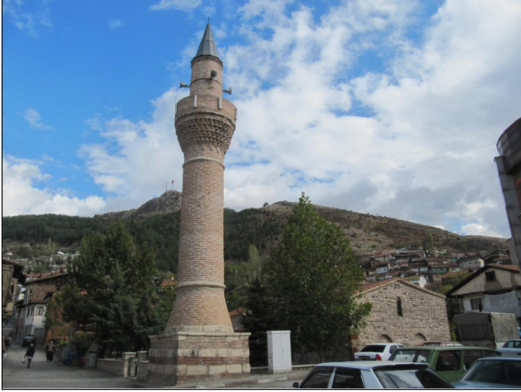
Şekil 5.58: Hamza Bey Mescidi batı cephesi, (Bilgen, 2013).
