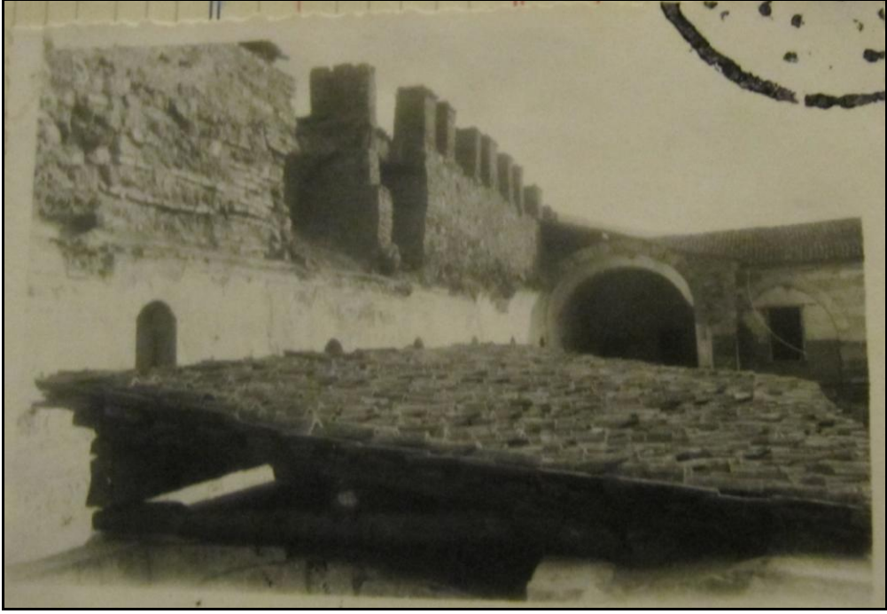
Şekil 5.542: Voyvoda Han (Taşhan), yıkık koridor genel görünüş 1945. (Savuran, 1931-1955).
