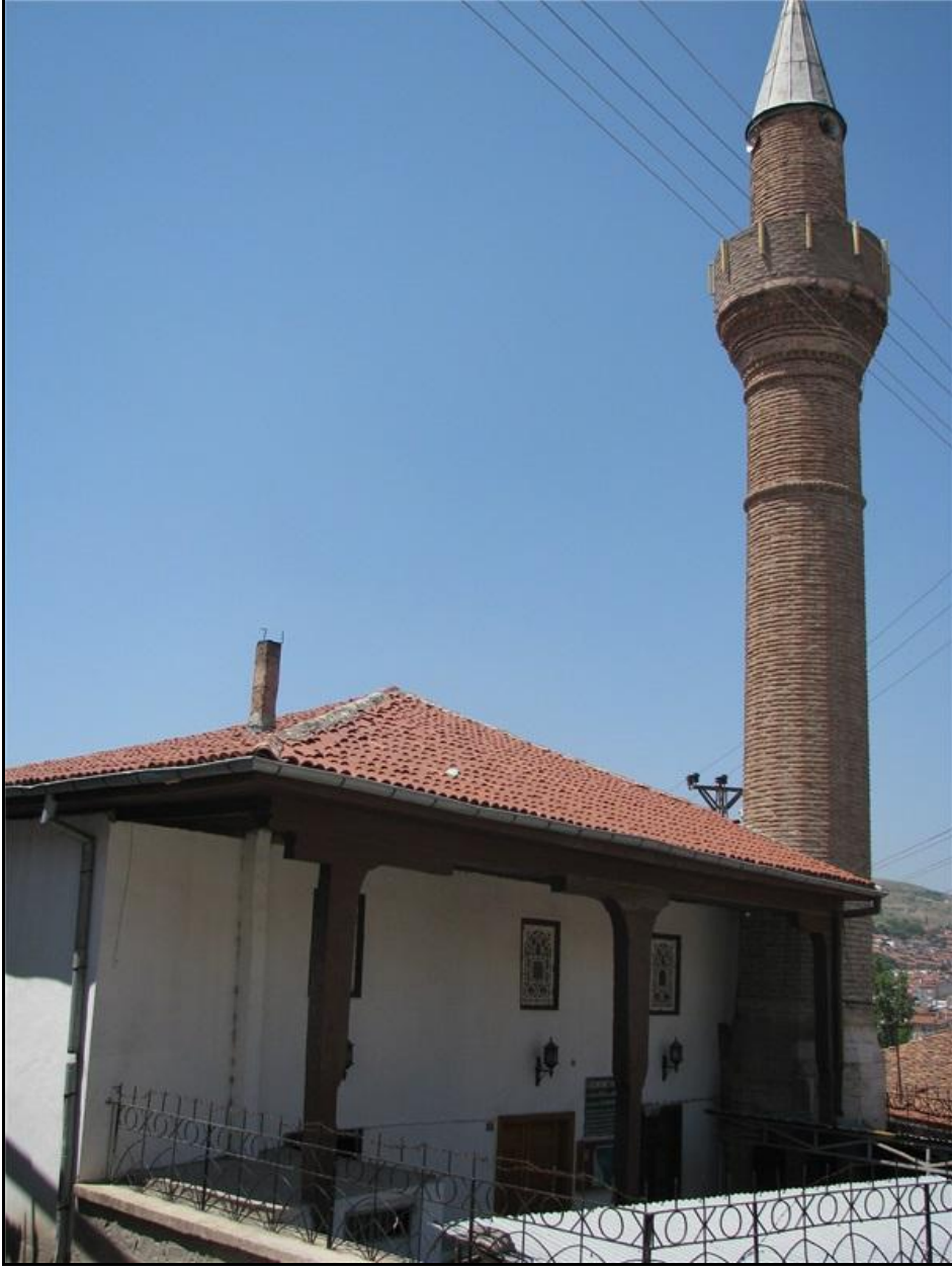
Şekil 5.199 : Genç Mehmet Paşa (Örtmeliönü) Camii kuzey cephesi. (Kültür Bakanlığı, 2013).
