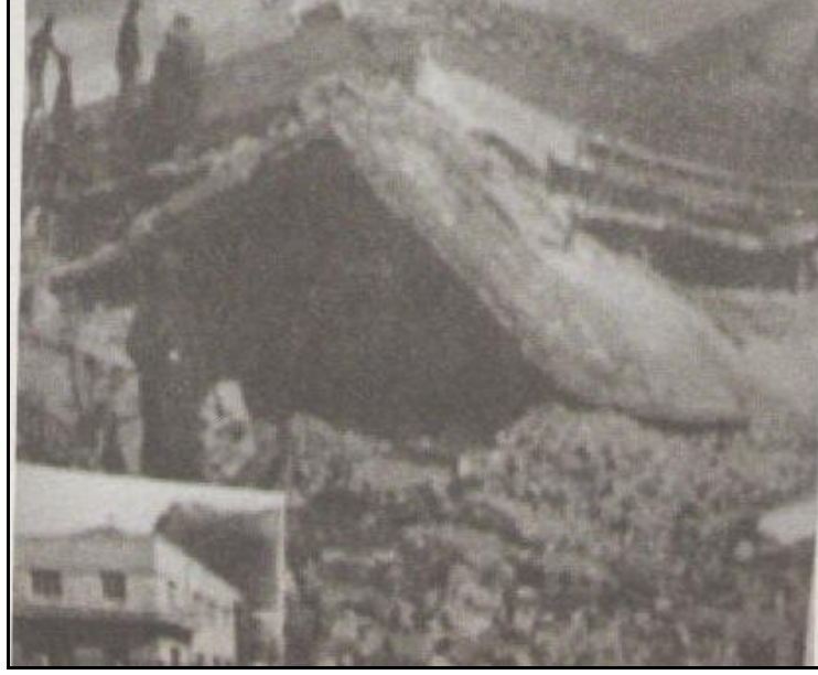
Şekil 2.1: Depremde yıkılan Tokat Halkevi Binası- Sol altta yıkılmadan önceki hali 2 , (Devlet Arşivleri Genel Müdürlüğü Başbakanlık T.C Arşivi).
