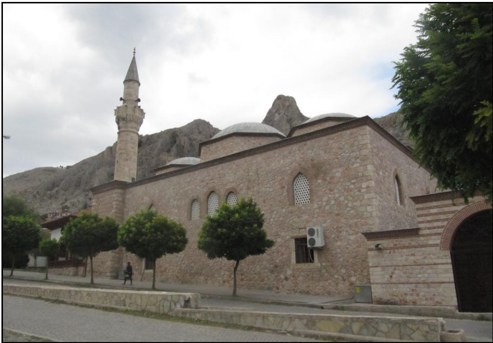
Şekil 5.112 : Takıyeciler camii güneydoğu cephesi, (Bilgen, 2013).
