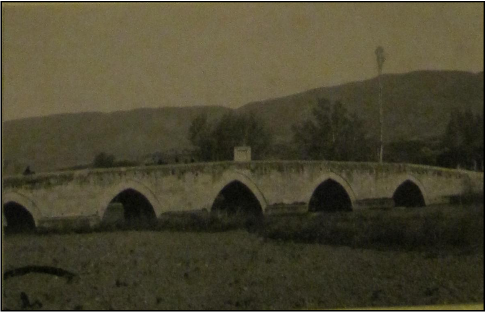
Şekil 5.596: Yeşilırmak Köprüsü mecra tarafı 1945 , (Savuran, 1931-1955).
