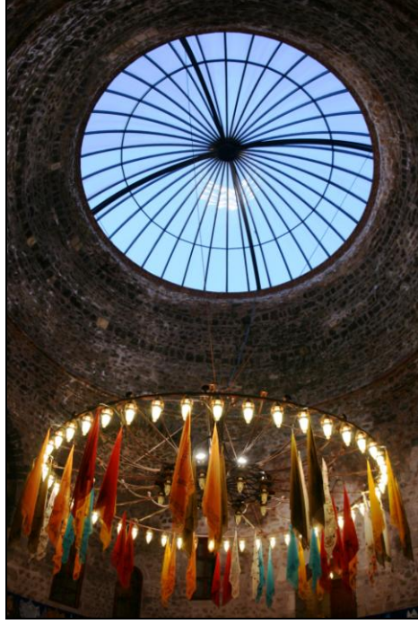
Şekil 5.381: Çukur Medrese -Yağıbasan Medresesi kubbe kapatıldıktan sonra. (Erdem, 2013).
