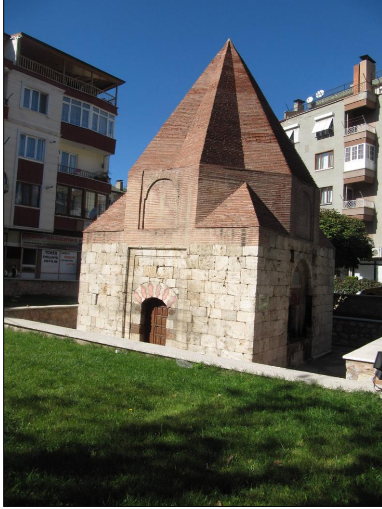
Şekil 5.292: Nureddin Bin Sentimur Türbesi kuzeydoğu cephesi, (Bilgen, 2013).
