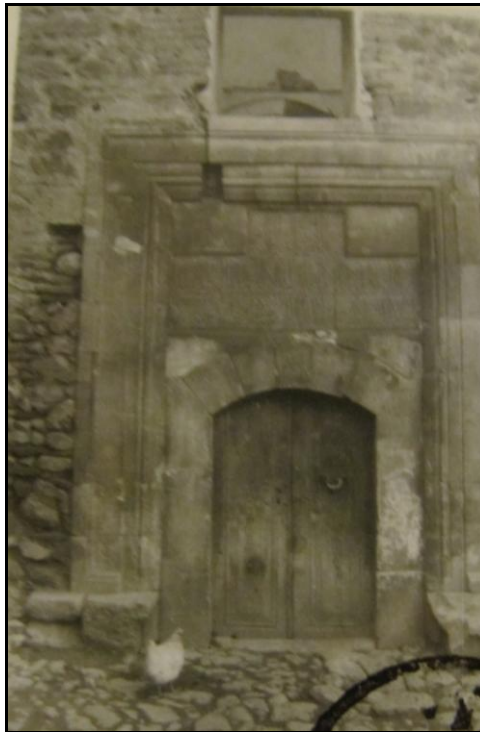
Şekil 5.347: Abdülmüttalip Tekke ve Zaviyesi arka cephesi, (Savuran, 1931-1955).
