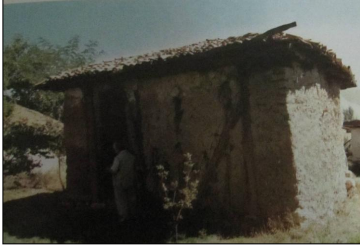
Şekil 5.296: Acepşir Türbesi batı cephesi, (Gündoğdu vd., 2006).
