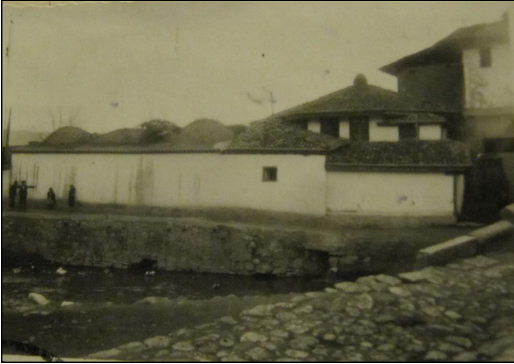
Şekil 5.484: Küçük (Çekenli) Hamamı batı cephesi 1945, (Savuran, 1931-1955).
