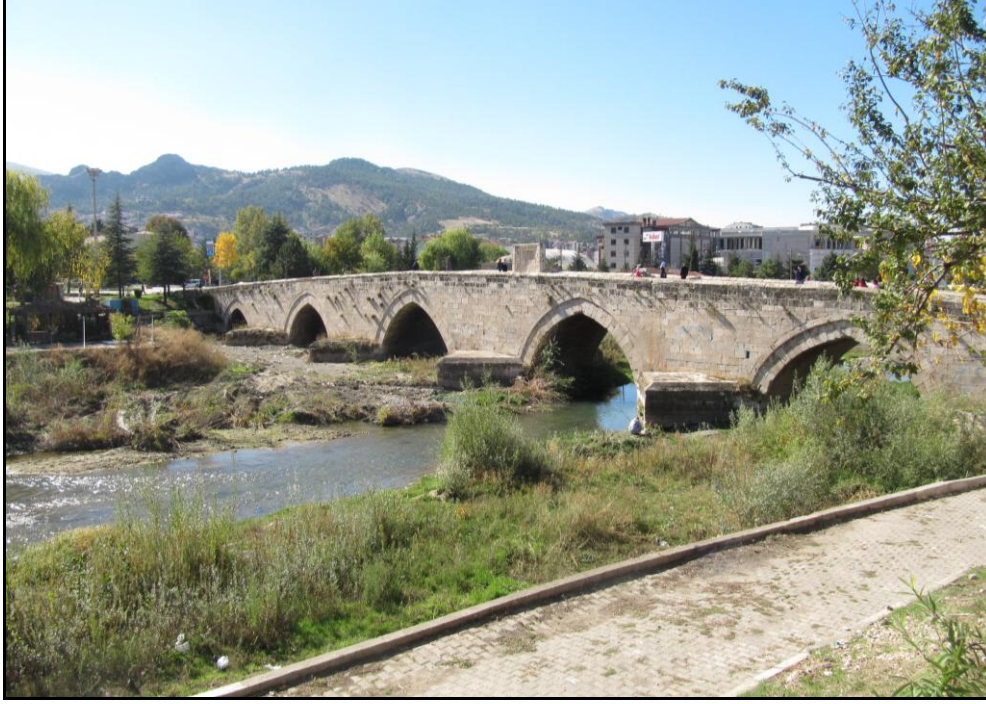
Şekil 5.599: Yeşilirmak Köprüsü, (Bilgen, 2013).
