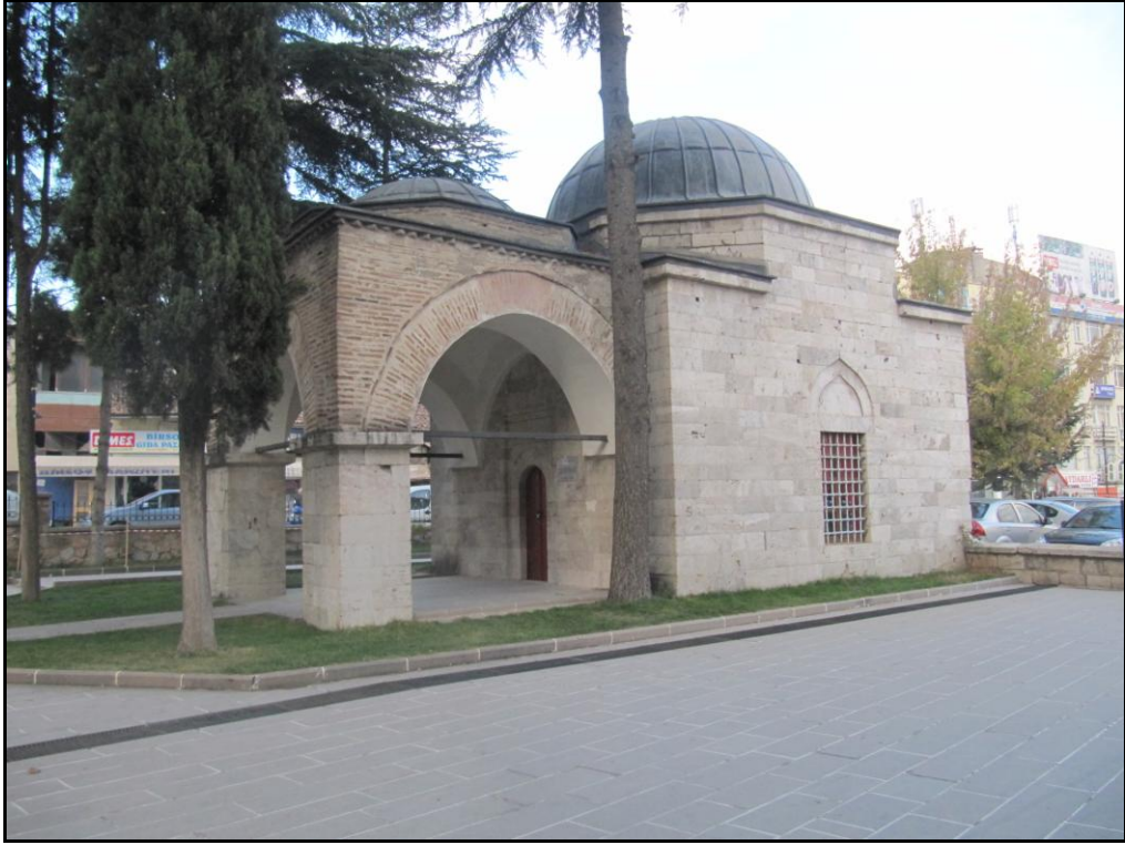
Şekil 5.317 : Ali Paşa Türbesi güneybatı cephesi, (Bilgen, 2013)
