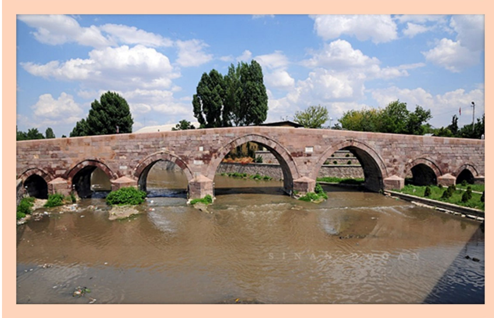
Şekil 7.25 Semte de adını veren Akköprü andezit kesme taştan yapılmış bir kemer köprüdür ve 7 gözlüdür (aqueduct: suaşıtı). Selçuk mimarisinin en güzel eserlerindedir (I.Alaeddin Keykubat, 1222). Ankamall alışveriş merkezinin karşısında bulunur ve
